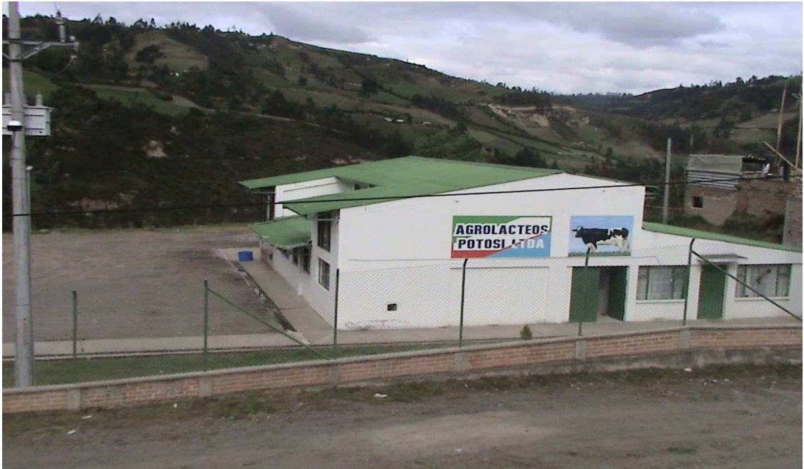
Figura 2. Instalaciones de la Empresa Agrolácteos Potosí.
