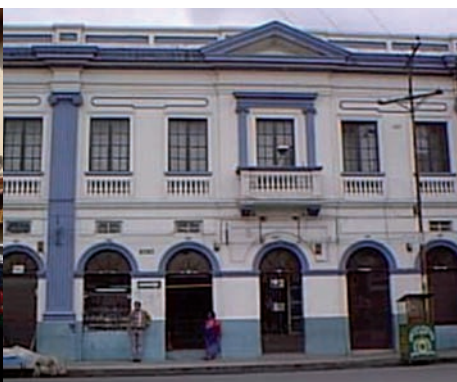
Figura 250//Fotografía de fachada sobre la calle 18 entre carreras 21 y 21B//
