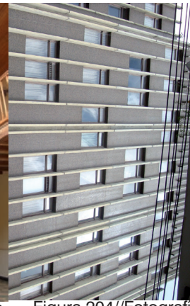
Figura 204//Fotografía-Fachada Edificio ubicado en la cra 24 entre calles 17 y 18//
