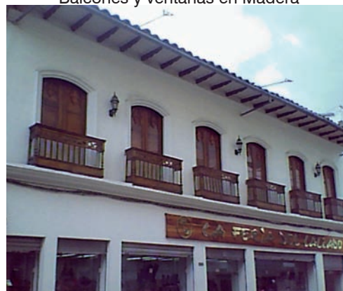
Figura 226//Fotografía de fachada sobre la Calle 18 entre carreras 22 y 23//
