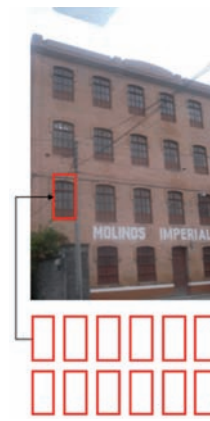
Figura 193//Vanos en Fachada//
