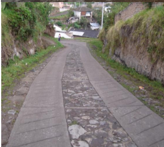
Vía adecuada para tránsito vehicular que se conecta con Pasto.
