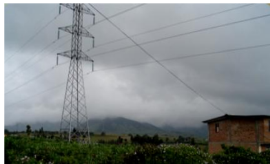
Redes eléctricas del sistema regional que atraviesan Buesaquillo
