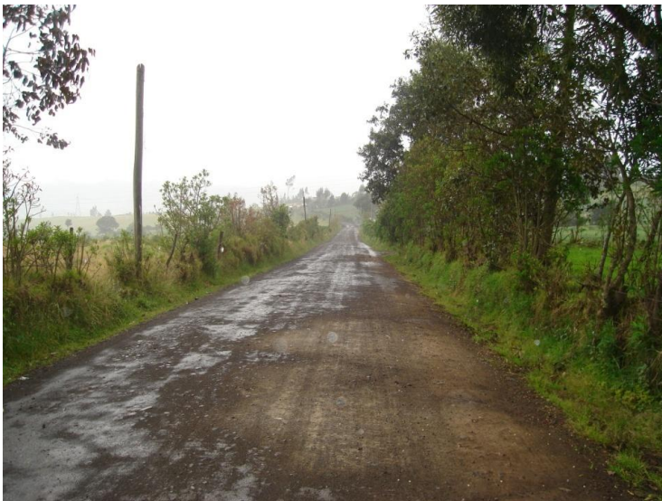
Vía conectora con la ciudad de Pasto.
