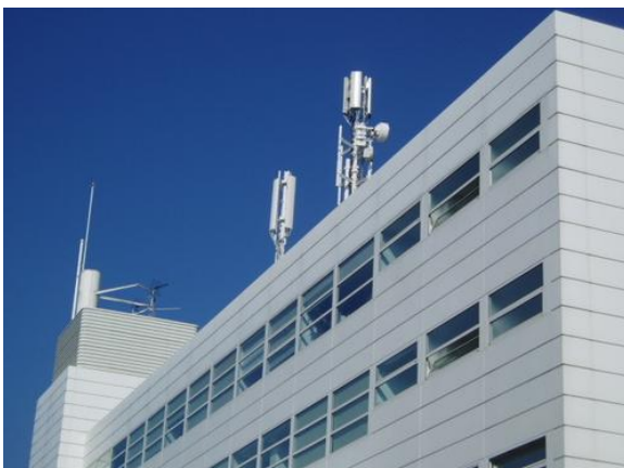
Fig 36. Fuente: Internet Fachada lateral del centro de servicios
