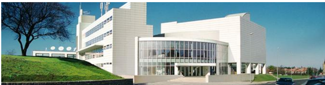
Fig 32. Edificio principal y centro de servicios. Fuente: PT San Sebastián.
