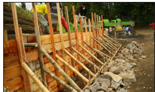
Imagen 13. Encofrado de muro
