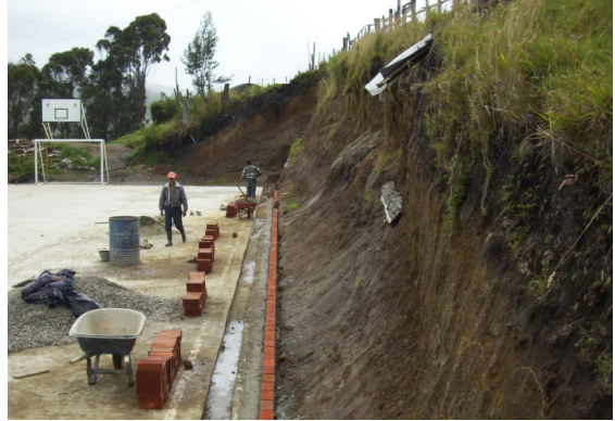
Imagen 157. Perfilado talud graderías
