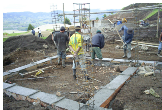
Imagen 25. Vigas de amarre
