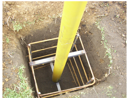
Imagen 159. Canastilla de refuerzo Y tubería de cerramiento
