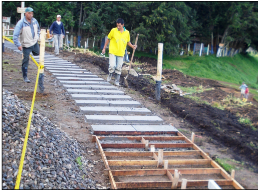
Imagen 52. Construcción de losetas
