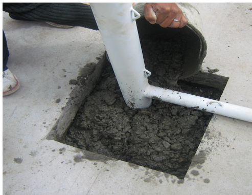
Imagen 92. Dados de anclaje pórticos
