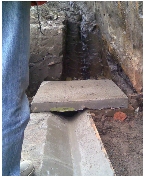
Imagen 148. Descarga de cuneta a caja
