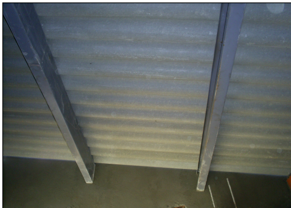
Imagen 37. Estructura de cubierta
