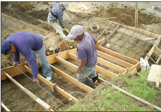
Imagen 20. Construcción gradas en concreto reforzado
