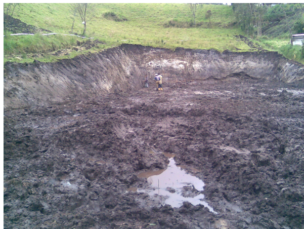
Imagen 135. Excavación mecánica terminada y afloramiento de aguas
