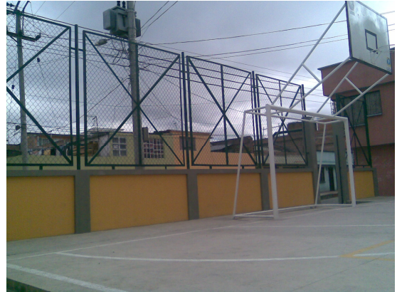
Imagen 122. Muro de protección
