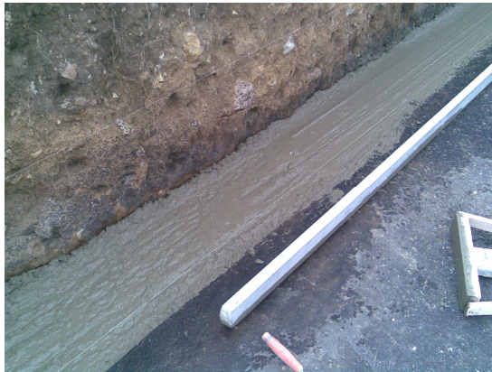
Imagen 87. Fundición de cunetas
