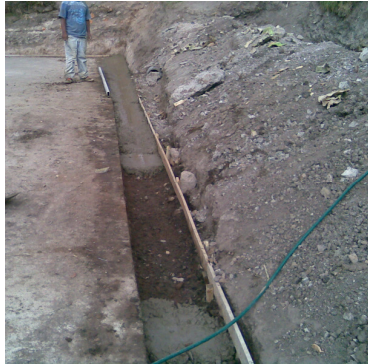
Imagen 106. Fundición de cunetas
