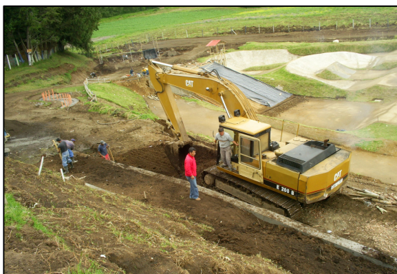
Imagen 4. Excavación adecuación vías
