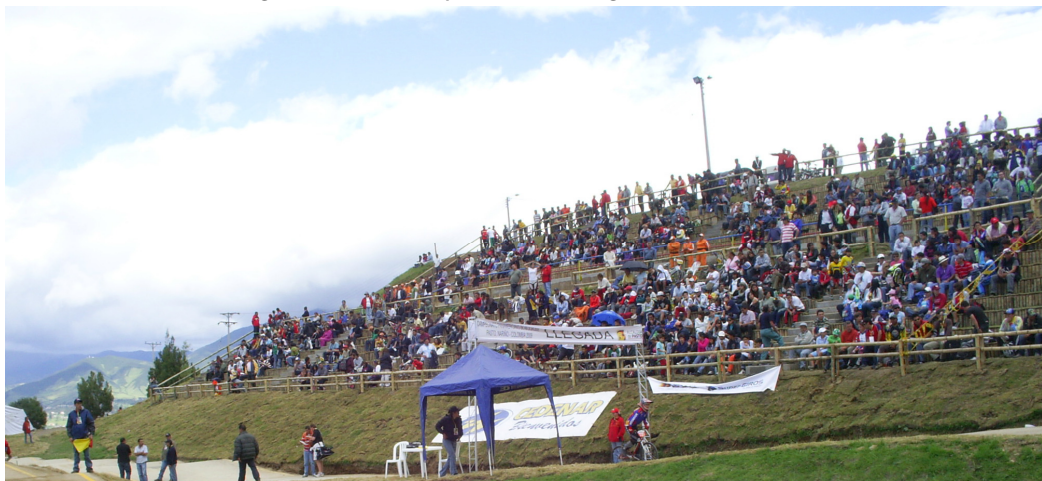
Imagen 54. Vista panorámica graderías terminadas
