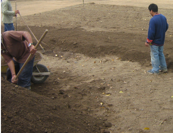
Imagen 77. Extendido de material
