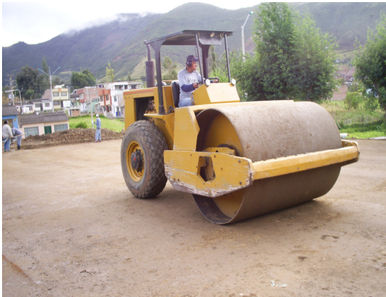
Imagen 79. Compactación en varias pasadas
