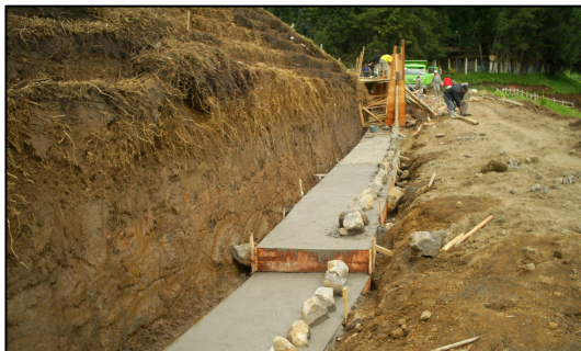
Imagen 12. Construcción de zarpa
