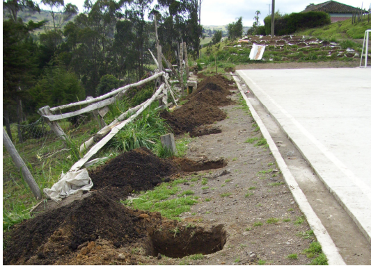
Imagen 156. Excavación de dados
