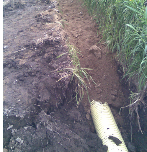
Imagen 139. Descole en 8" PVC estructurada
