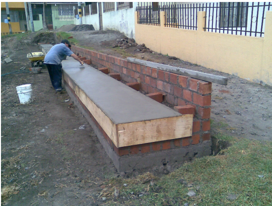
Imagen 110. Gradería: cimentación, mampostería y losetas
