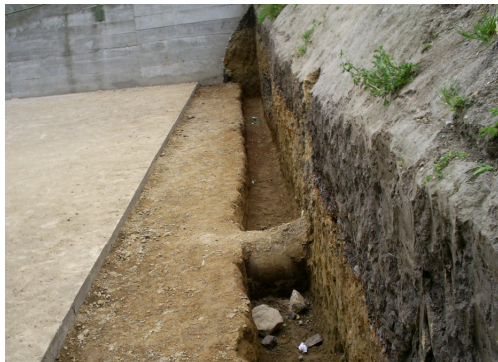
Imagen 115. Excavaciones para muro
