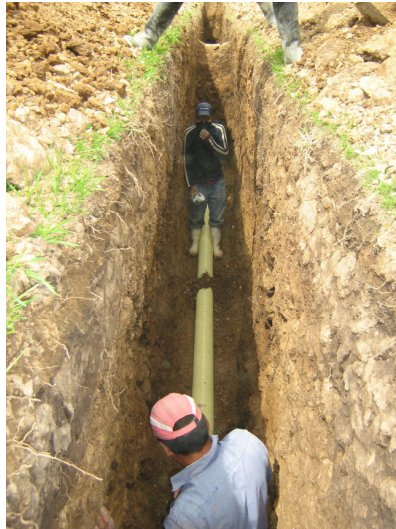
Imagen 68. Instalación tubería estructurada 6" (descoles)
