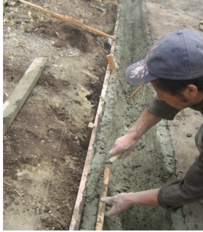
Imagen 147. Fundición de cunetas
