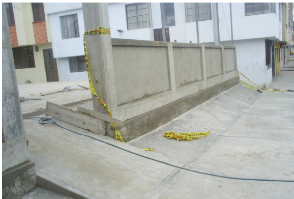
Imagen 123. Muro de protección
