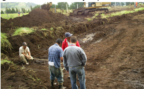
Imagen 1. Localización y replanteo de obras
