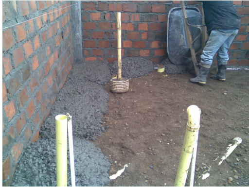
Imagen 32. Fundición de piso
