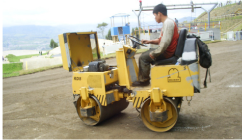
Imagen 10. Compactación vías peatonales con benitín
