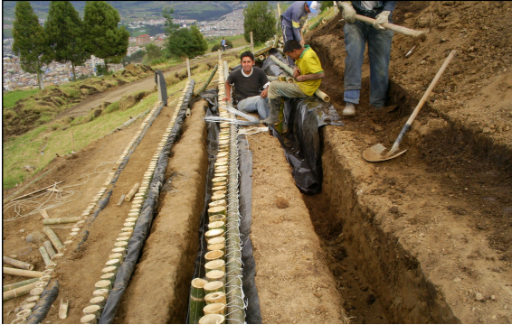
Imagen 18. Perfilado y colocación de tableros
