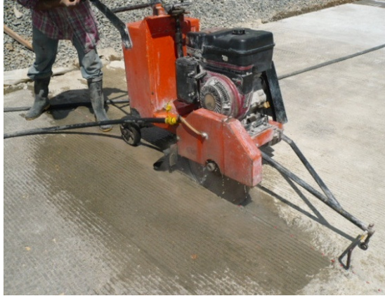
Imagen 150. Corte de juntas transversales
