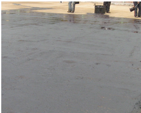
Imagen 82. Imprimación con emulsión asfáltica
