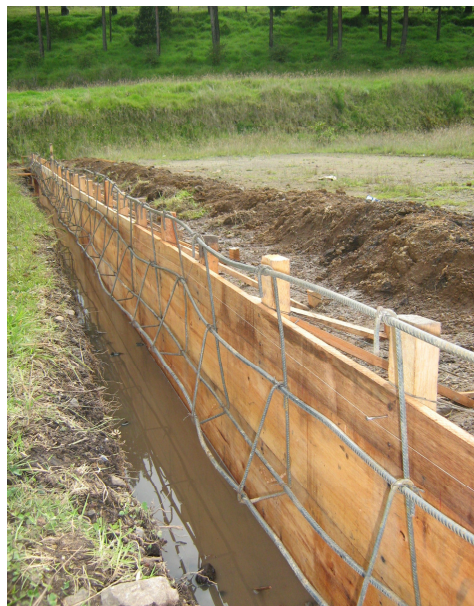
Imagen 72. Refuerzo y encofrado sardineles
