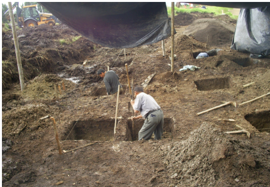
Imagen 2. Excavación cimentaciones batería sanitaria
