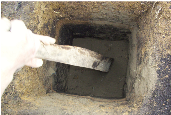
Imagen 158. Solado en suelo-cemento
