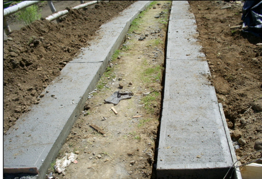
Imagen 48. Placa huella terminada
