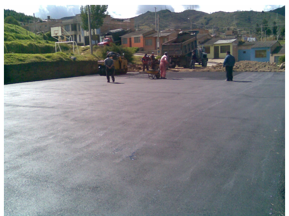
Imagen 86. Carpeta asfáltica terminada
