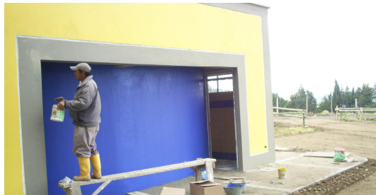
Imagen 41. Aplicación de pintura
