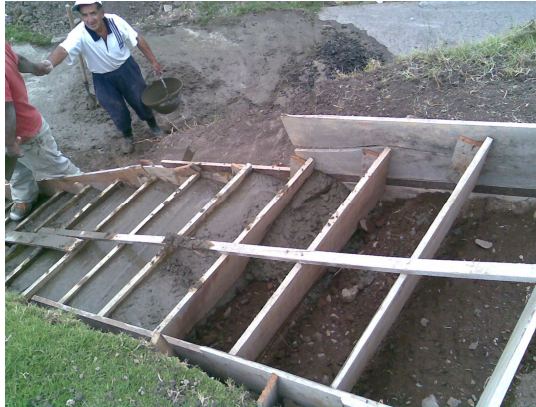
Imagen 112. Construcción de gradas
