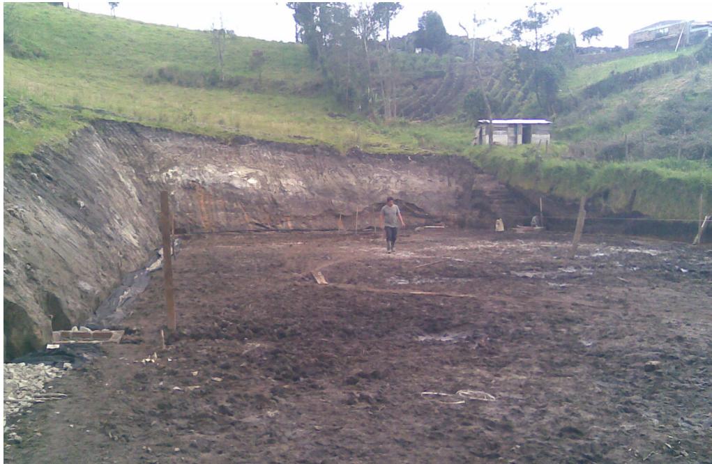
140. Área de trabajo drenada por sistema de filtración
