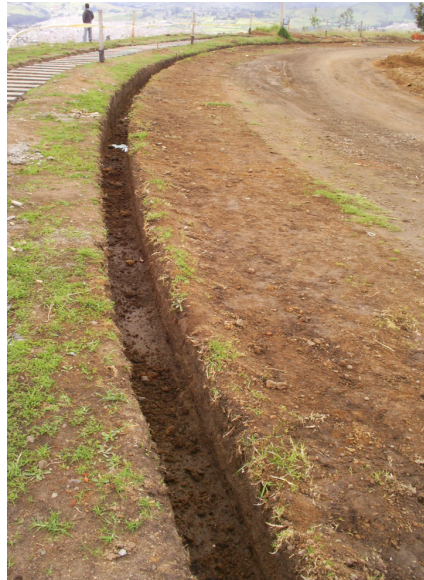
Imagen 61. Excavación para sardineles de confinamiento
