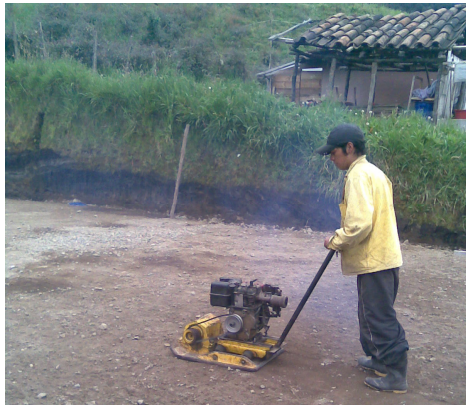
Imagen 141. Compactación con rana
