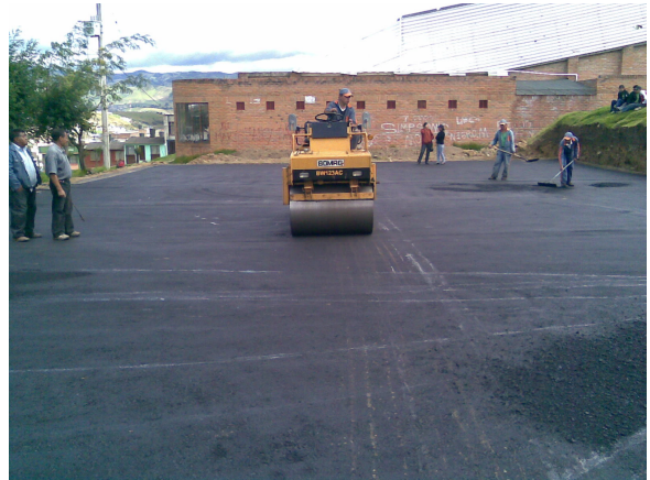
Imagen 84. Compactación de la carpeta asfáltica
