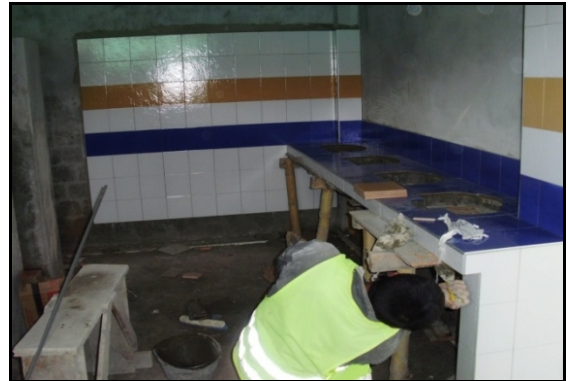
Figura 32. Enchape batería sanitaria
