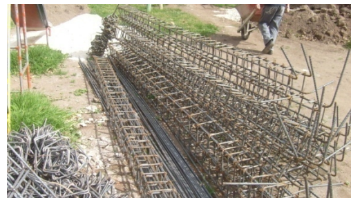
Figura 67. Armado del acero de refuerzo
