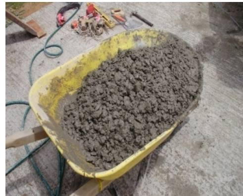
Figura 4. Concreto para columnas
