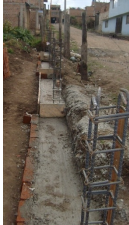
Figura 57. Viga de cimentación
