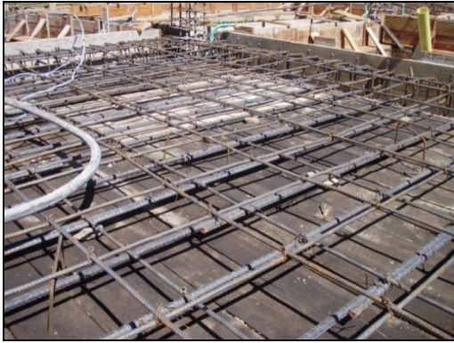
Figura 9. Refuerzo losa maciza
