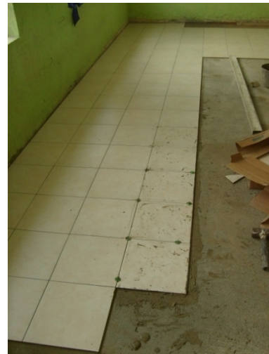
Figura 75. Instalación de cerámica
