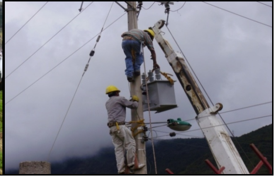
Figura 45. Instalación de transformador
