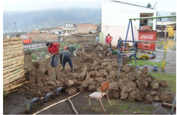
Figura 65. Demolición de tapia
