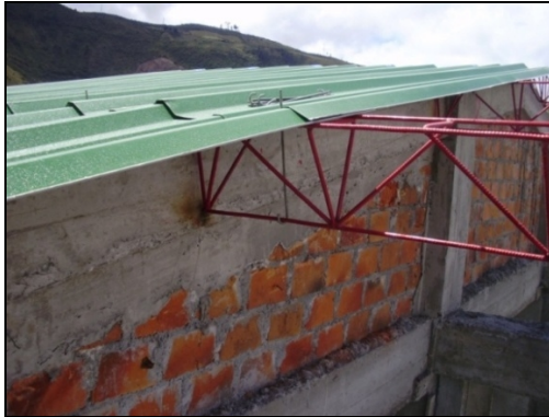
Figura 27 Remate teja termoacústica y cercha
