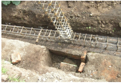
Figura 68. Refuerzo de viga de cimentación
