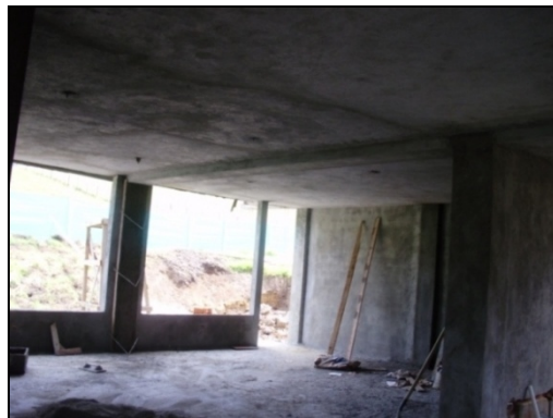
Figura 19. Pañete muros y losas
