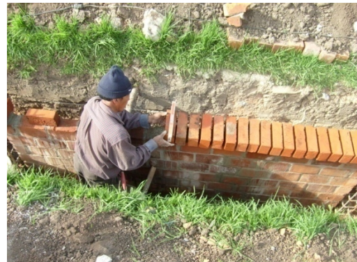
Figura 60. Construcción de alfajía
