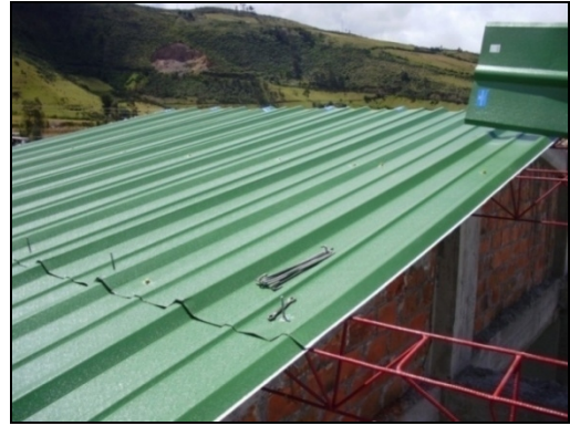
Figura 26. Instalación de teja termoacústica
