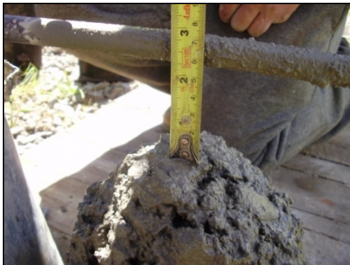
Figura 11. Prueba de Slump para vigas aéreas
