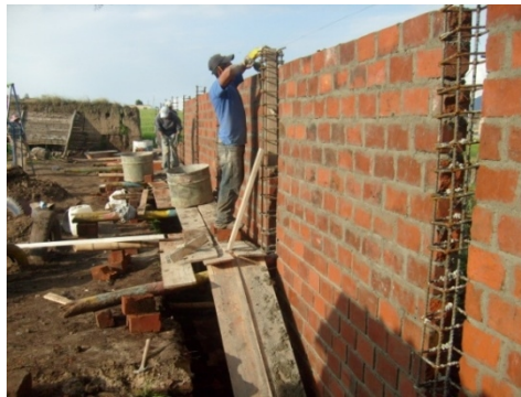
Figura 70. Pega de mampostería
