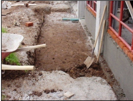
Figura 21. Excavación para andenes
