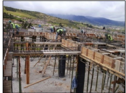
Figura 8. Refuerzo vigas aéreas
