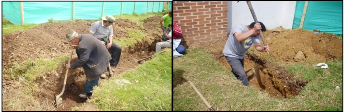
Figura 41. Trabajo comunitario jornada de 5 de Septiembre. Excavación de filtro
