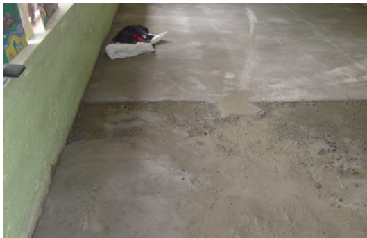
Figura 74. Aplicación de mortero de nivelación
