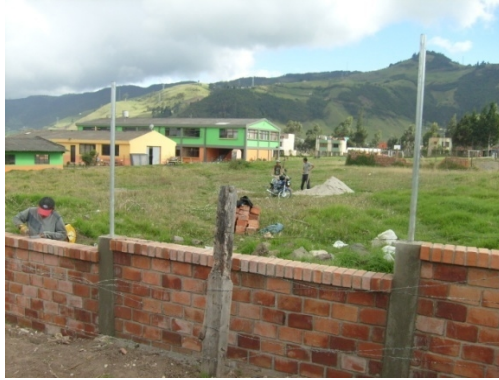
Figura 61. Limpieza de mampostería
