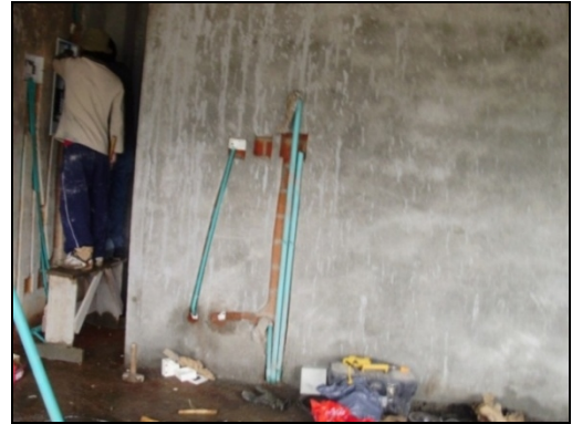
Figura 22. Regatas instalación eléctrica
