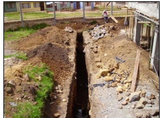
Figura 12. Excavación para filtro perimetral
