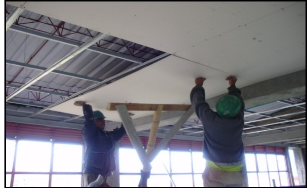
Figura 30. Instalación cielo raso
