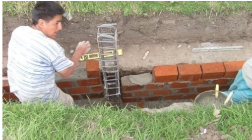
Figura 59. Pega de muros
