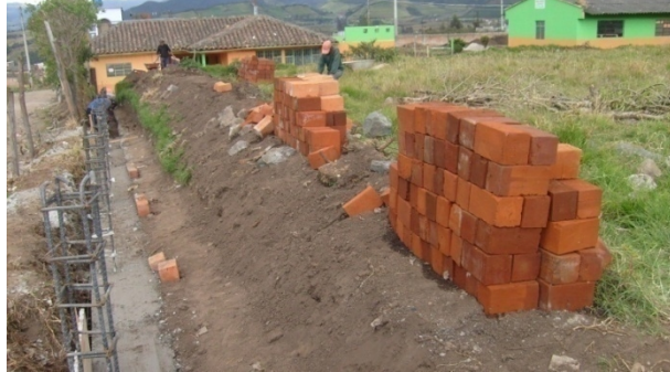
Figura 58. Acopio de materiales
