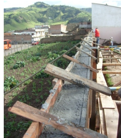
Figura 71. Fundición de viga aérea
