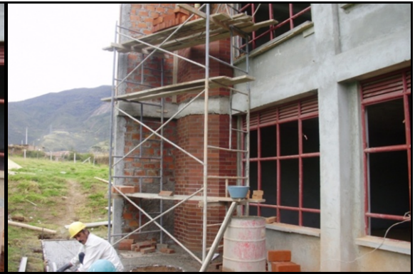
Figura 34. Mampostería en ladrillo visto
