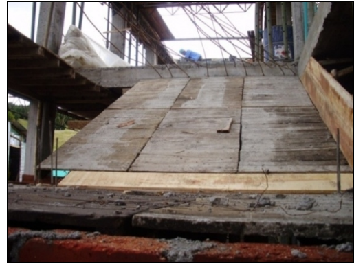
Figura 14. Formaleta para escalera
