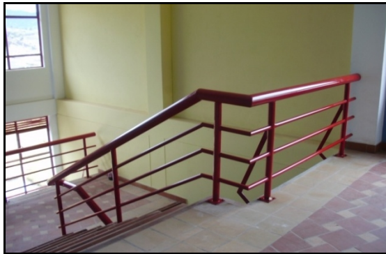
Figura 42. Pasamanos con pintura anticorrosiva
