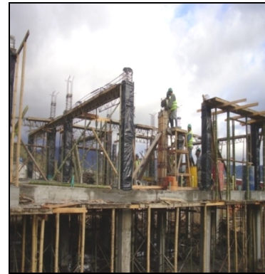
Figura 6. Curado de columnas
