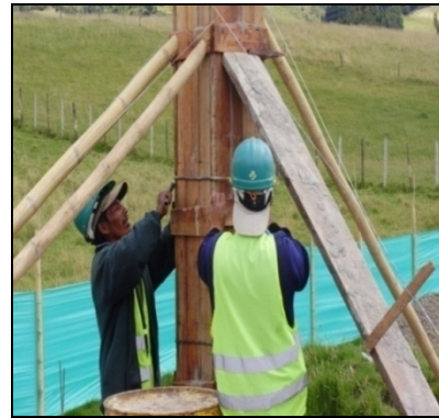
Figura 2. Formaleta para columnas
