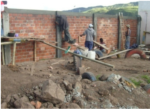
Figura 72. Afinado de vigas y columnas
