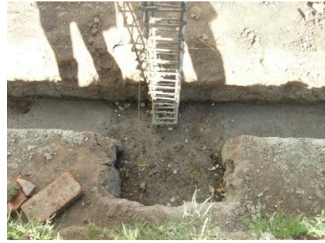
Figura 69. Fundición de viga de cimentación
