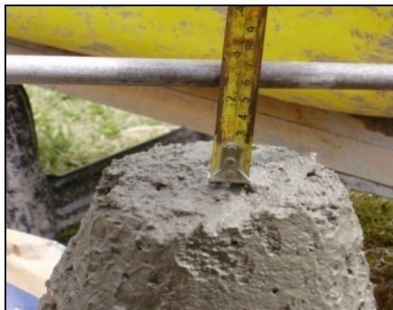
Figura 3. Prueba de Slump
