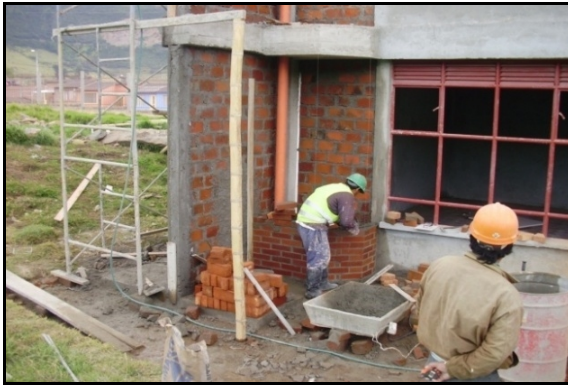
Figura 33. Mampostería para fachada
