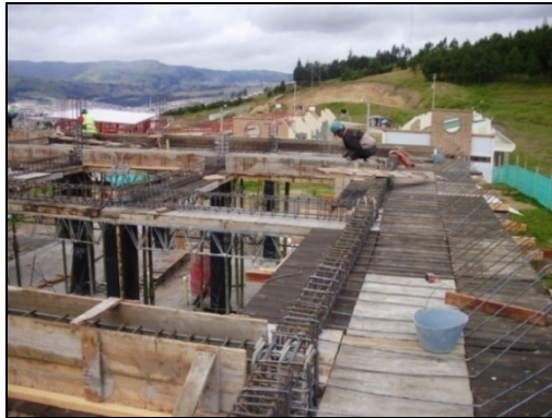
Figura 7. Refuerzo viga canal
