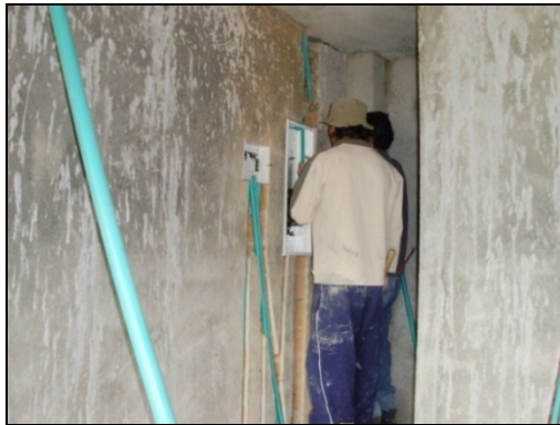
Figura 23. Instalación red eléctrica
