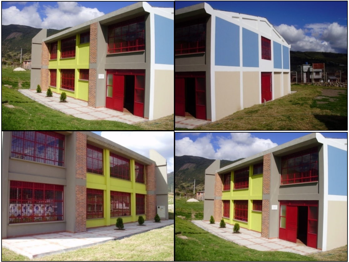
Figura 51. Fachadas ya terminadas
