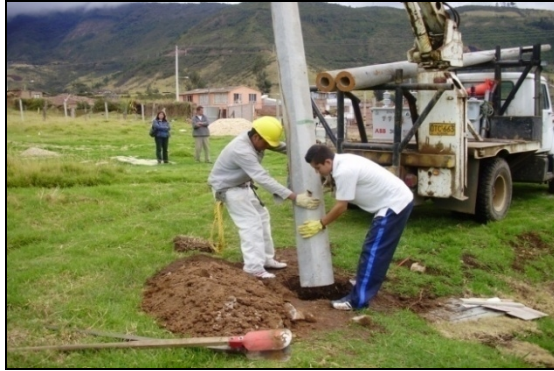
Figura 44. Instalación de postes de energía
