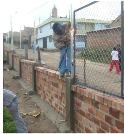
Figura 62. Instalación de módulos metálicos
