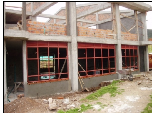
Figura 20. Instalación de ventanas
