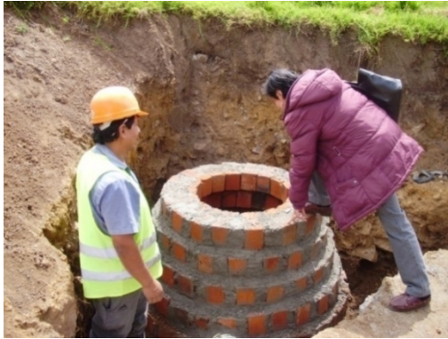
Figura 29. Remate poso de inspección
