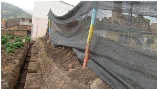
Figura 66. Excavación para cimentación
