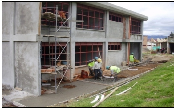
Figura 35. Fundición de andenes
