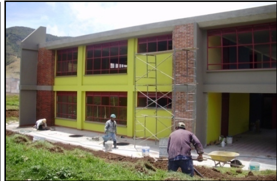
Figura 40. Labores de limpieza y adecuación
