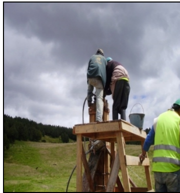
Figura 5. Fundición de columnas
