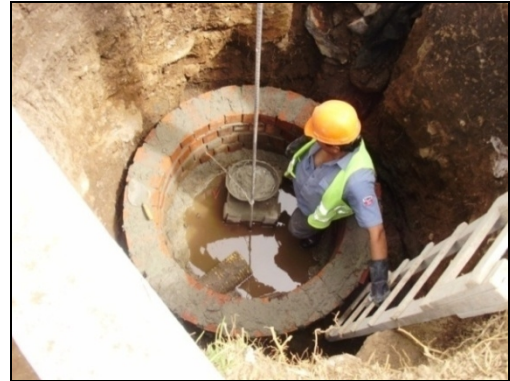
Figura 28. Construcción poso de inspección
