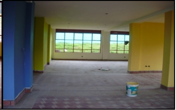
Figura 38. Pintura en corredores
