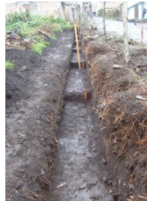
Figura 56. Perfilado del terreno
