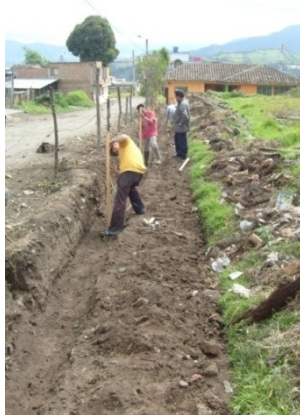
Figura 55. Toma de niveles
