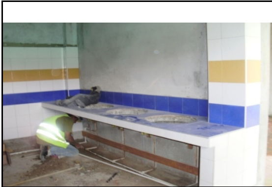
Figura 31. Instalación red hidráulica
