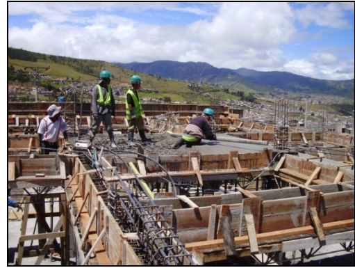
Figura 10. Fundición placa maciza
