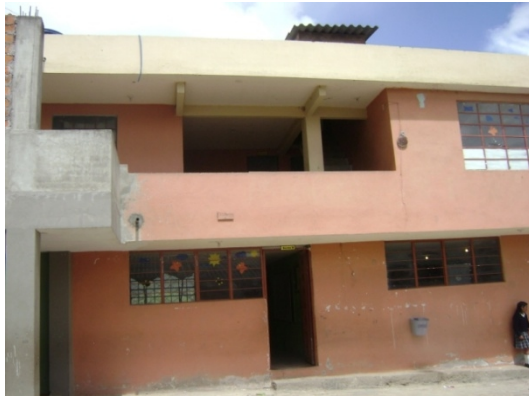
Figura 124. Fachada E.R.M Santa Bárbara
