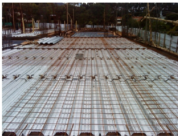
Ilustración 49 Instalación de malla electrosoldada, separación del metaldeck mediante panelas de mortero
