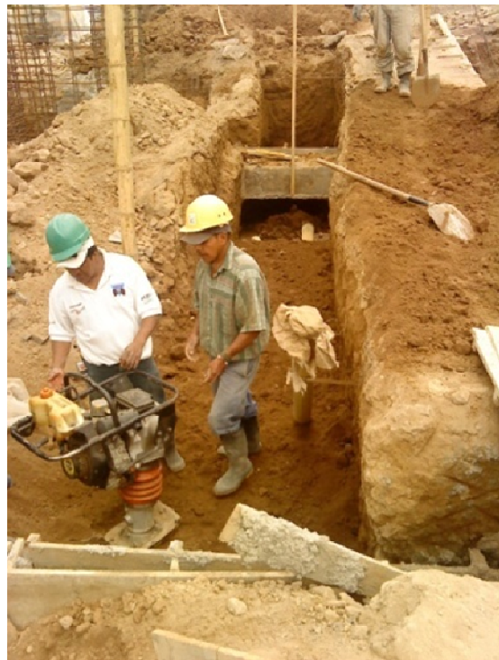
Ilustración 32 Compactación de material de sitio con saltarín
