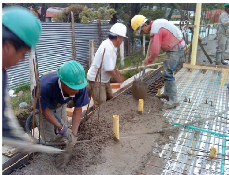
Ilustración 54 Uso del vibrador en la fundición de losa de concreto monolítica: vigas, losa y perfiles
