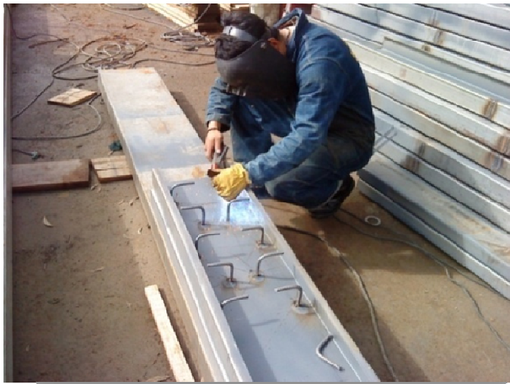
Ilustración 55 Soldadura de conectores de cortante d 3/8" dentro del perfil
