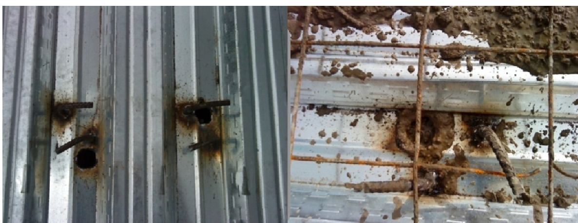
Ilustración 50 Agujeros dentro del perfil metálico para facilitar llenado del concreto
