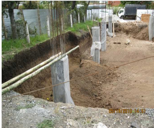
Ilustración 30 Excavación para muro de contención
