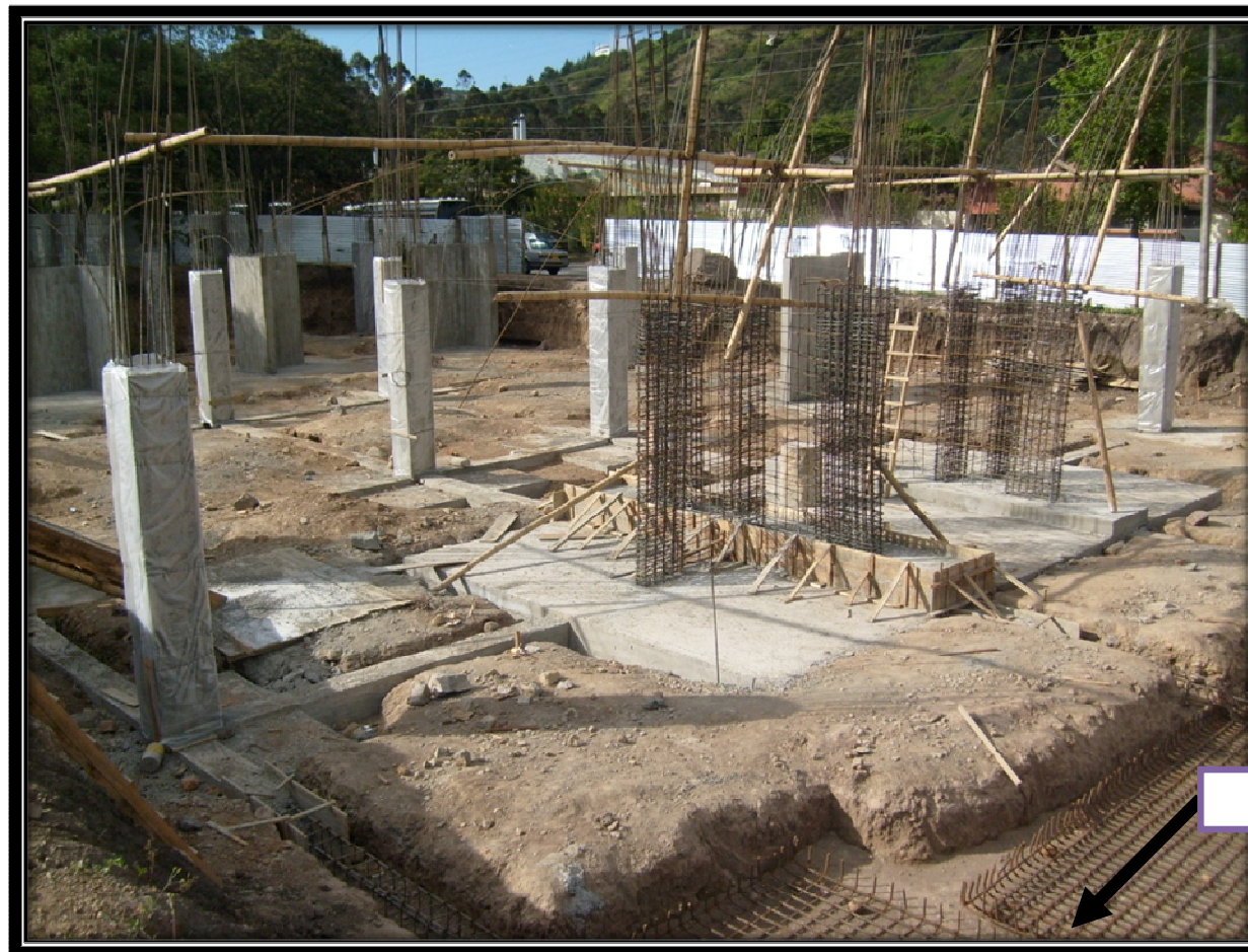
Ilustración 17 Estado Inicial de bloque Aulas y Sistemas zona norte
