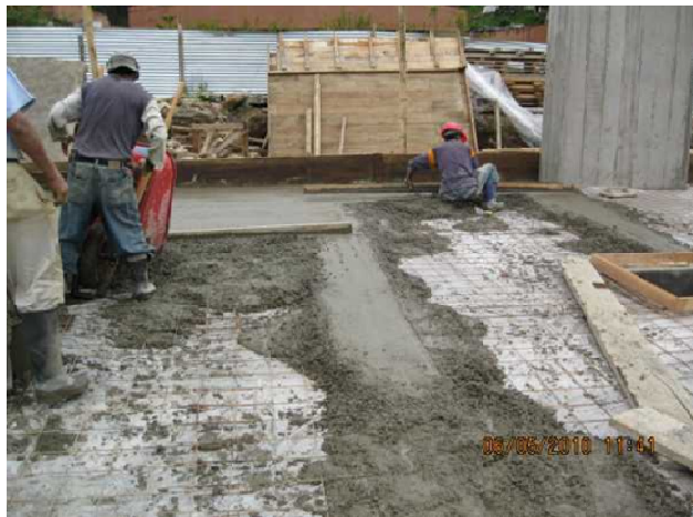
Ilustración 44 Fundición losa contrapiso
