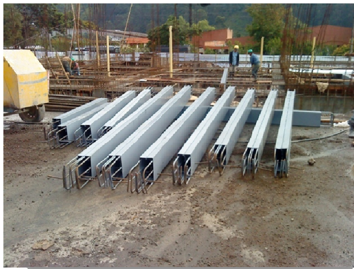
Ilustración 57 Perfiles en cajón y pintados con anticorrosivo
