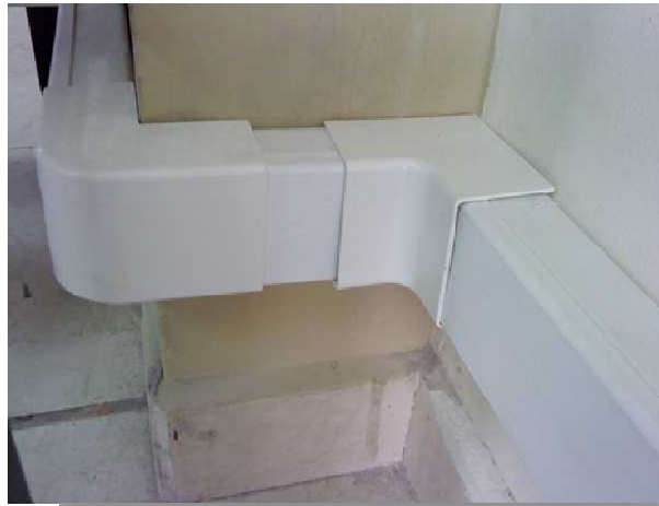
Ilustración 4 Accesorios para canaleta instalados
