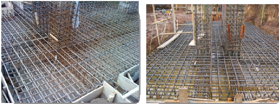
Ilustración 35 Armado refuerzo zapatas y pantallas
