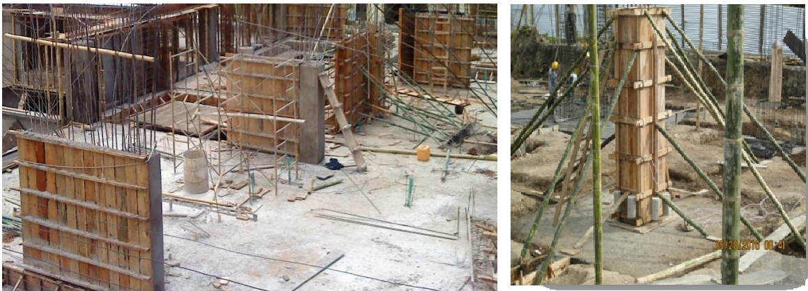
Ilustración 37 Encofrado de columnas y pantallas
