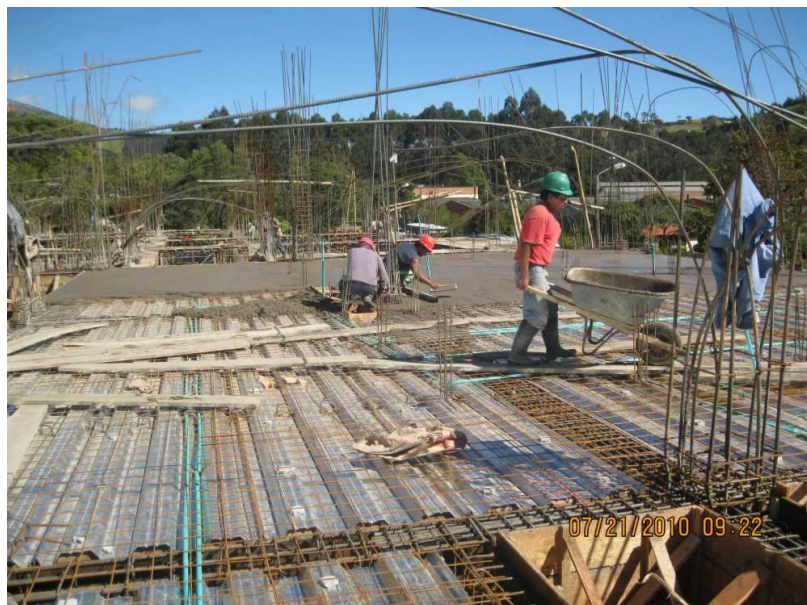
Ilustración 52 Caminos en tabla para proteger el metaldeck en fundición
