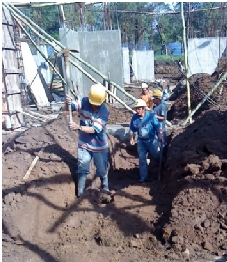
Ilustración 29 Excavación material común
