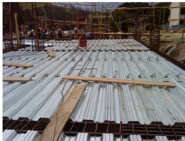
Ilustración 48 Soldadura de conectores de cortante d = \frac{1}{2} " sobre los perfiles metálicos
