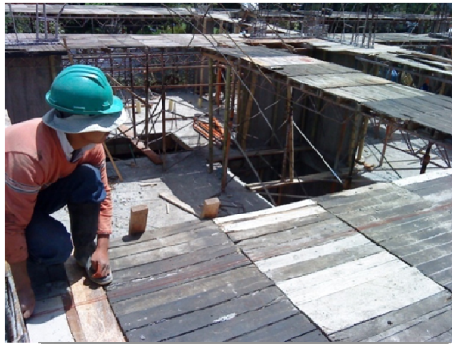
Ilustración 53 Replanteo y cimbrado de vigas de concreto
