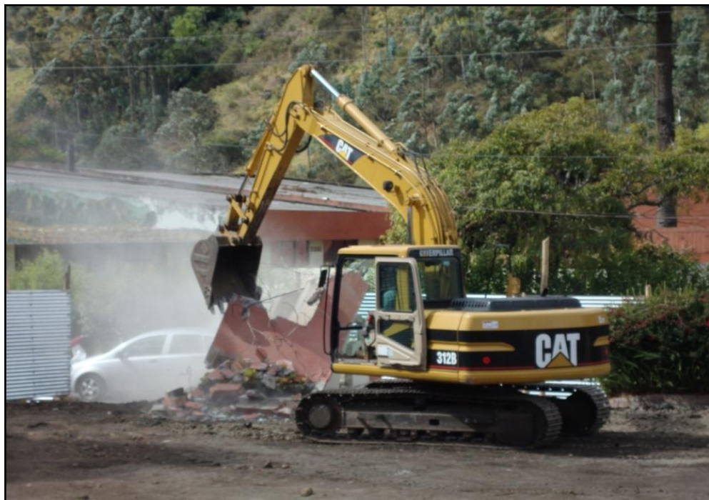
Figura 5. Demolición de la caseta de vigilancia
