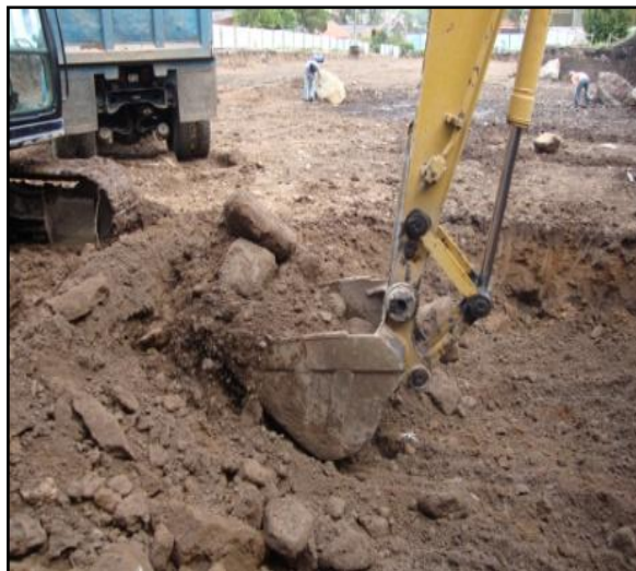
Figura 25. Excavación en roca
