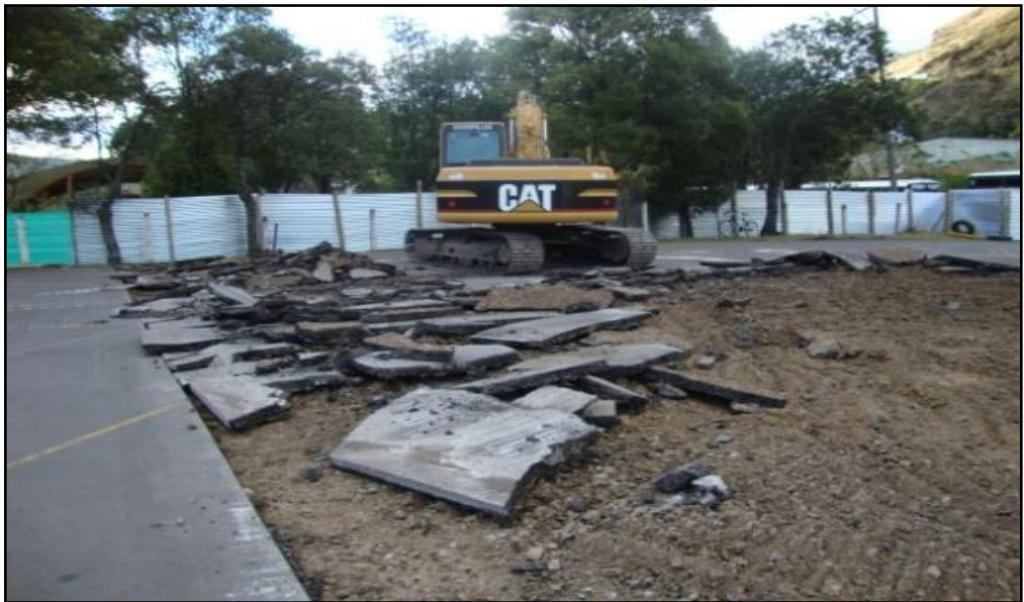
Figura 3. Demolición de la carpeta asfáltica
