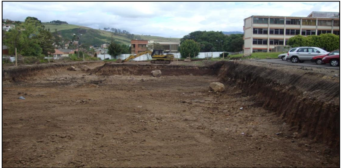
Figura 22. Excavación para cajeo del nivel de semisótano
