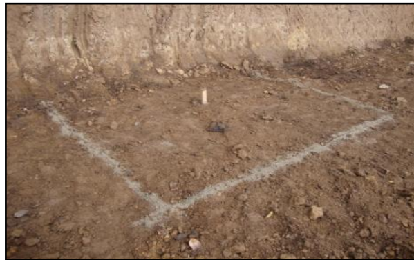
Figura 24. Localización y replanteo
