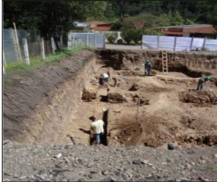
Figura 26. Excavación manual en conglomerado
