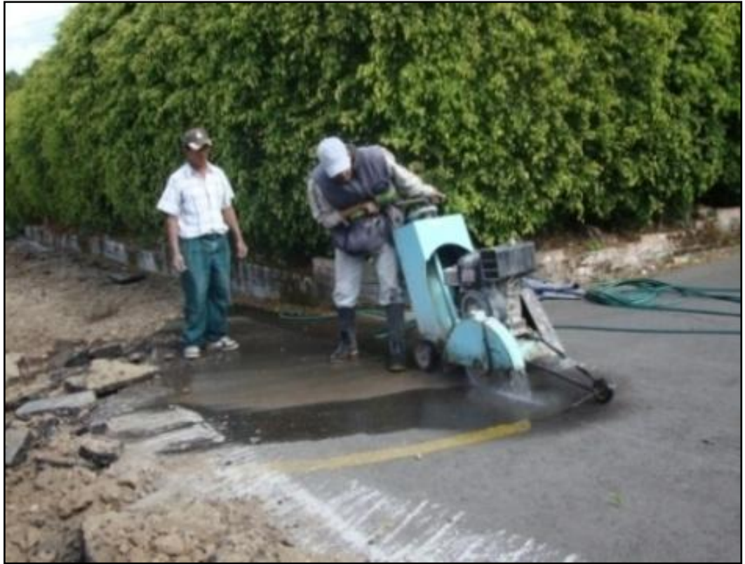
Figura 6. Corte de la carpeta asfáltica
