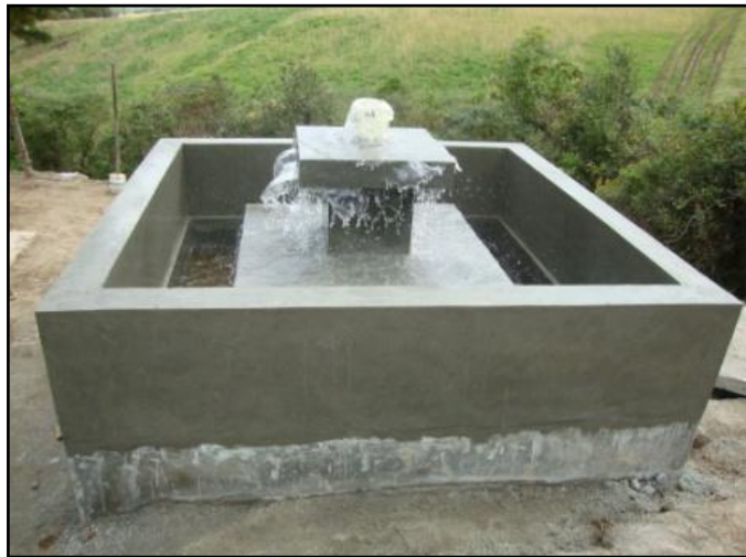
Figura 17. Sistema de aireación terminado y en funcionamiento
