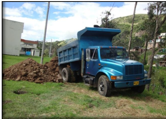
Figura 27. Desalajo de material de excavación en sitio
