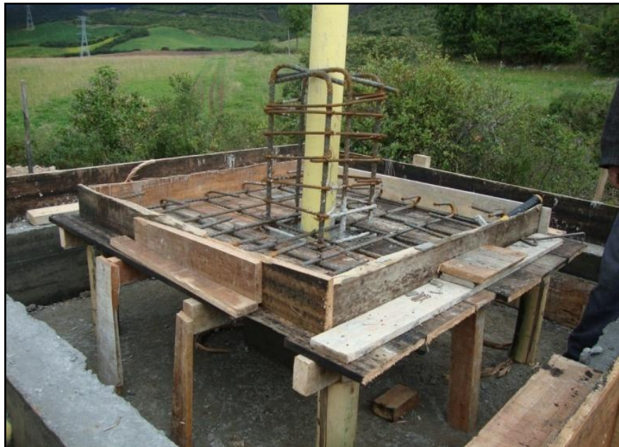
Figura 10. Armado de hierro de la columna 0.35x0.35m y de las bandejas de concreto
