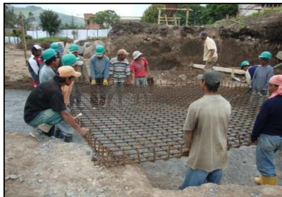
Figura 31. Acero de refuerzo A-60 (Zapatas)
