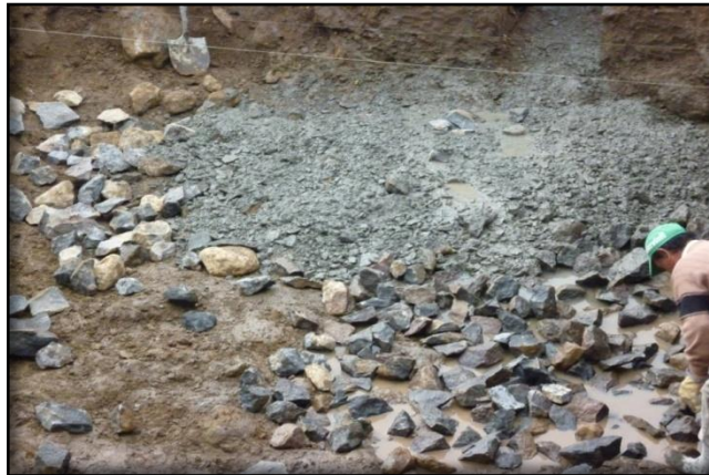
Figura 28. Concreto ciclópeo H=40cm (40% concreto + 60% rajón)
