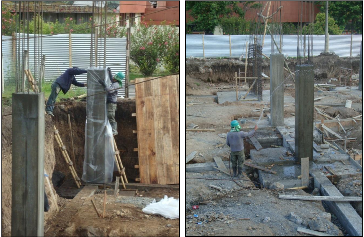
Figura 39. Curado de columnas
