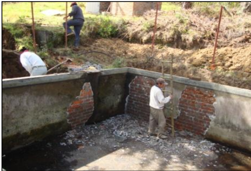
Figura 15. Demolición del pañete del tanque de almacenamiento
