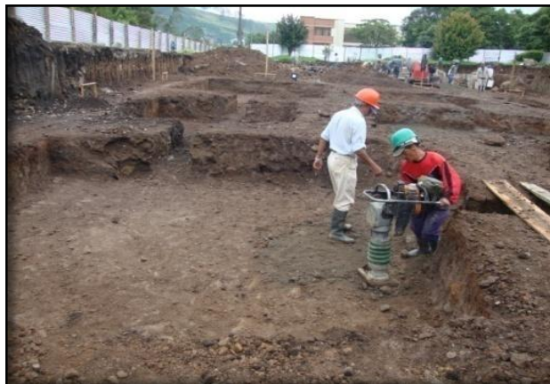
Figura 29. Relleno suelo-cemento 1:10 H=20cm
