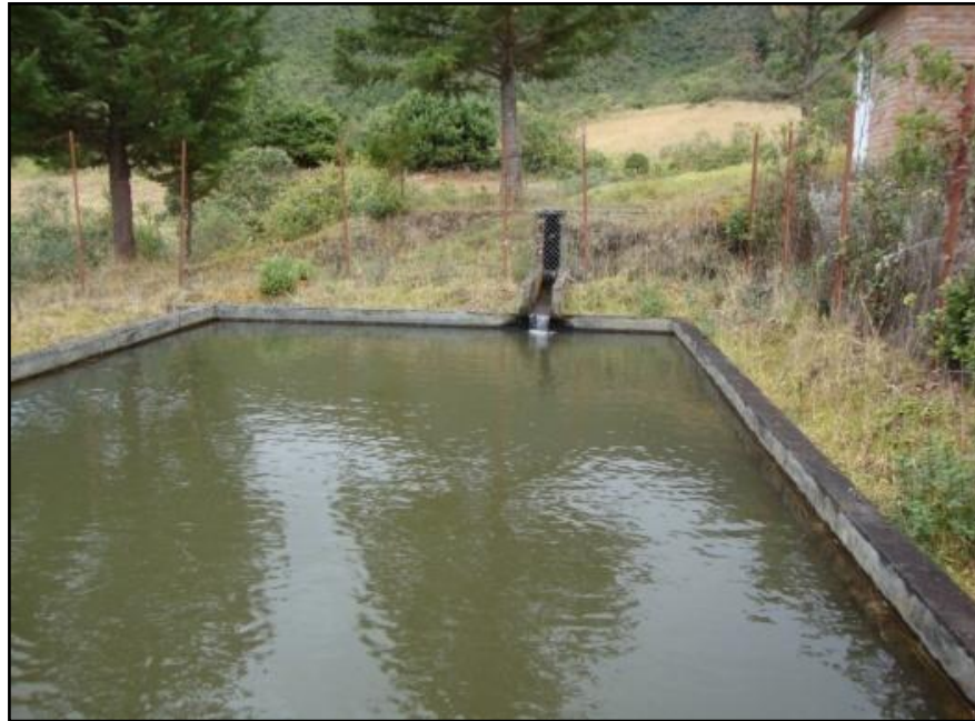
Figura 7. Tanque de almacenamiento existente en la Granja de Botana
