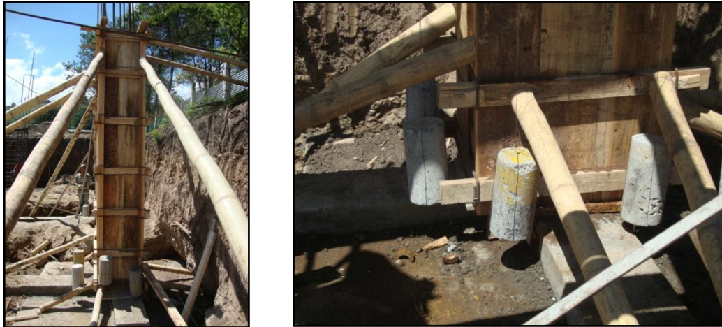
Figura 36. Chequeo de plomos y verificación de la verticalidad en columnas
