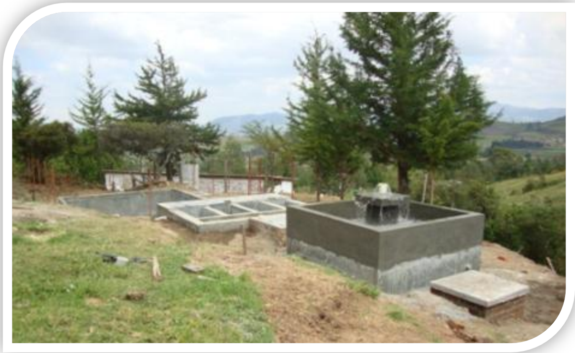
Figura 19. Final de la obra.
