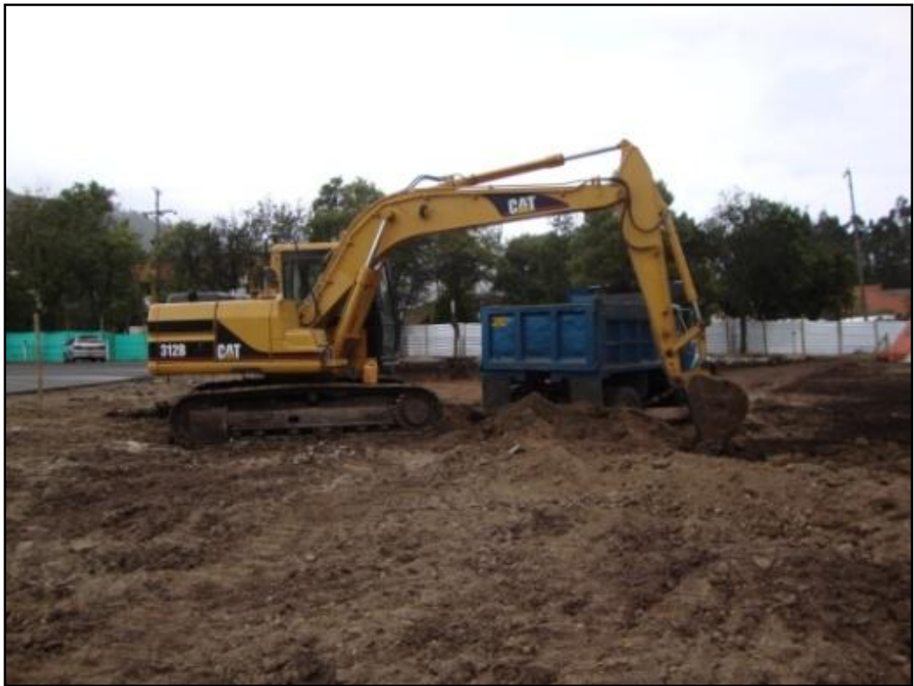
Figura 4. Excavación a máquina en las actividades preliminares
