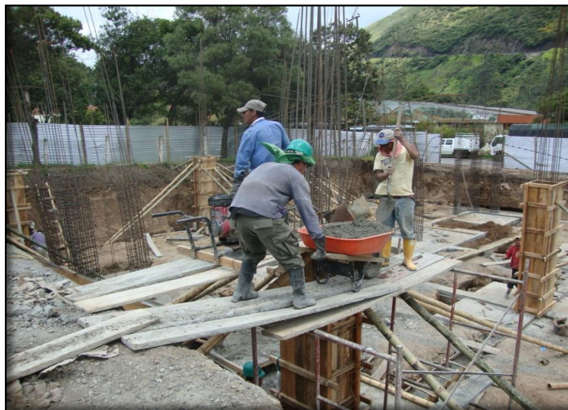
Figura 37. Concreto 3500 psi – Columnas y pantallas
