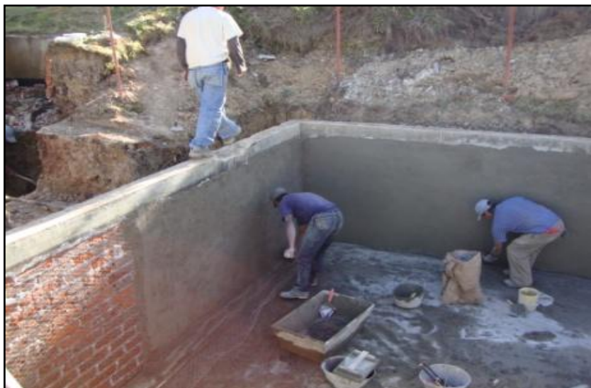
Figura 16. Pañete impermeabilizado y esmaltado de las paredes del tanque
