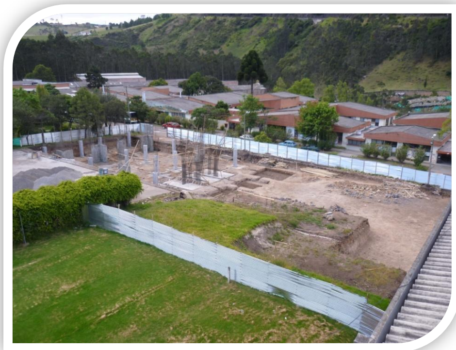
Figura 41. Final de la obra.
