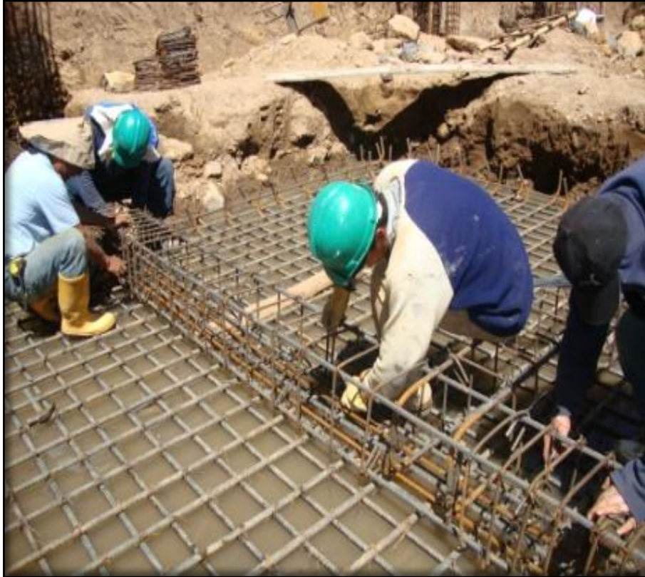
Figura 32. Acero de refuerzo A-60 (Vigas de cimentación)
