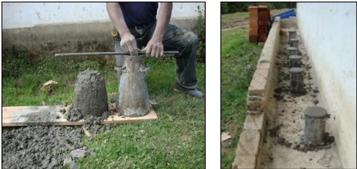
Figura 8. Ensayo de asentamiento y toma de cilindros
