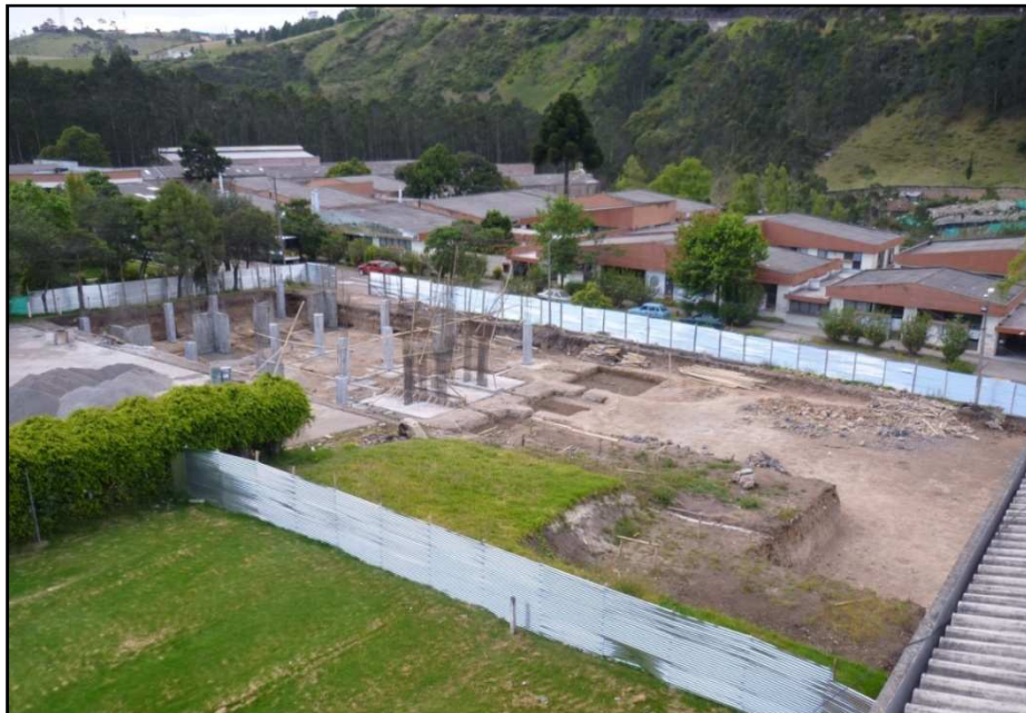
Registro Fotográfico del la Primera Etapa Sector Norte Bloque de Aulas.
