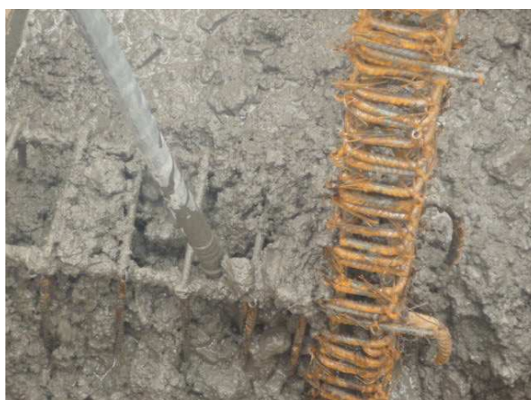
Ilustración 33 Vibrado del concreto
