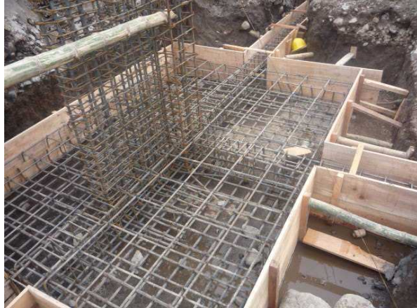
Ilustración 29 Formaleta de zapatas y vigas de cimient
