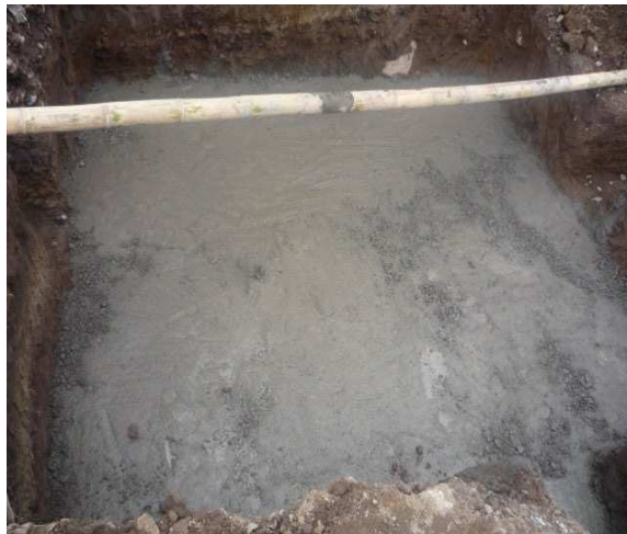
Ilustración 12 Colocación concreto de limpieza
