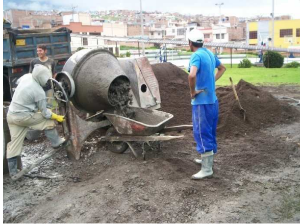
Ilustración 43 Mezcla de concreto
