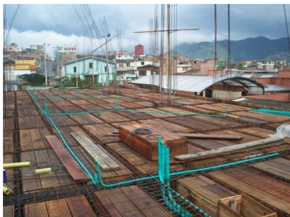
Ilustración 42 Instalación de casetones
