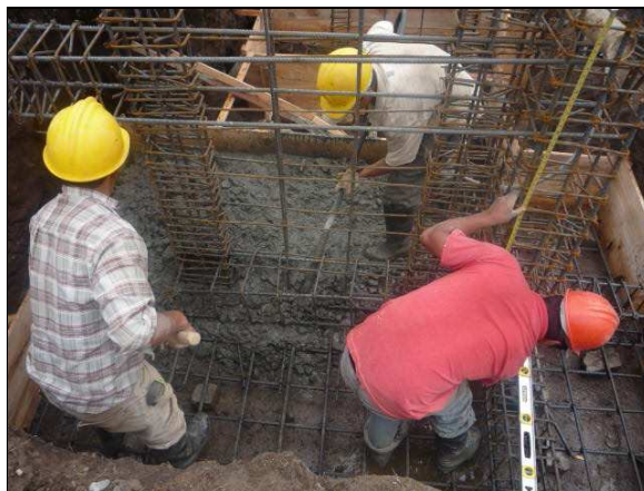
Ilustración 32 Vaciado de concreto
