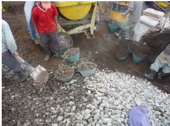
Ilustración 30 Medida de proporciones en obra para concreto de de 3000 PSI
