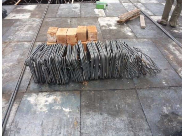
Ilustración 21 Refuerzo figurado puesto en obra
