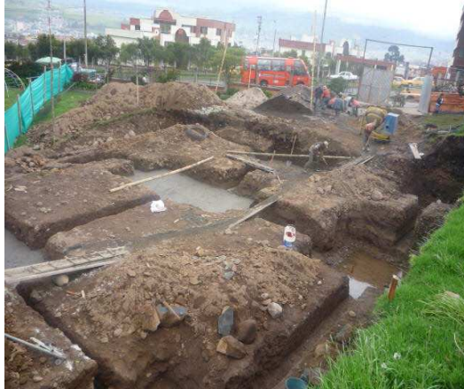
Ilustración 11 Colocación concreto de limpieza
