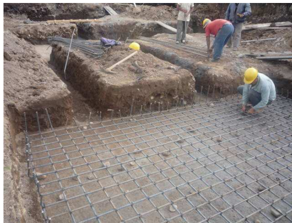
Ilustración 14 Colocación de refuerzo para cimentación
