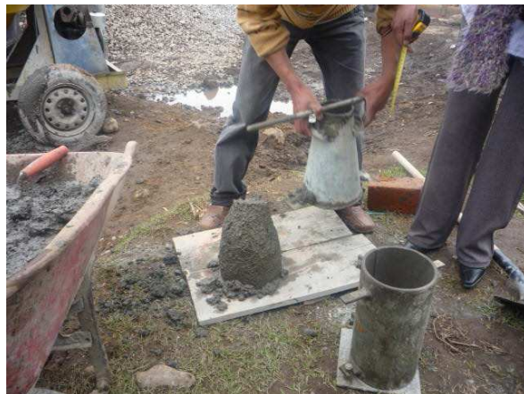
Ilustración 46 Retiro de cono y medida de asentamiento
