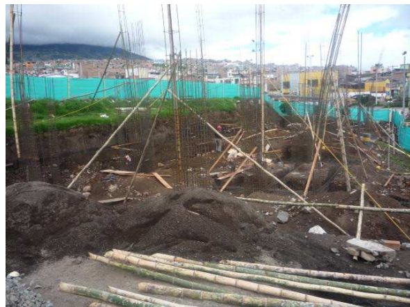
Ilustración 20 Colocación refuerzo de columnas y pantallas
