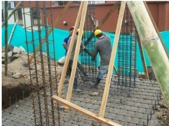
Ilustración 19 Proceso de colocación de refuerzo columnas y pantallas
