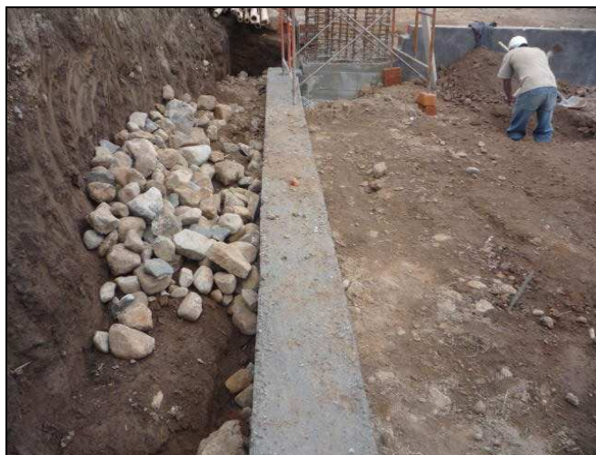
Ilustración 72 Muro en concreto ciclópeo
