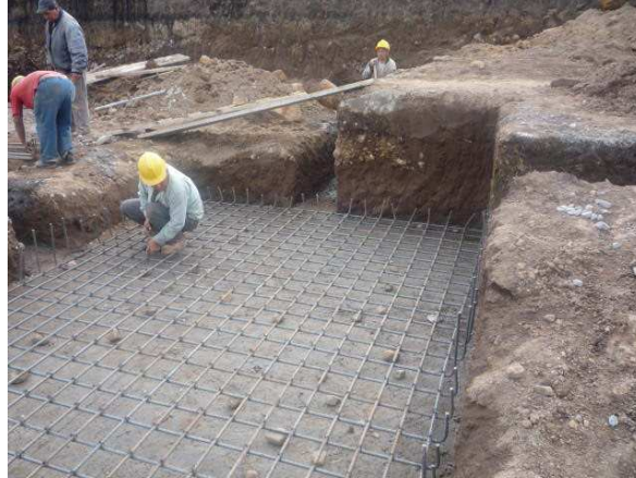
Ilustración 13 Colocación de refuerzo sobre el concreto de limpieza
