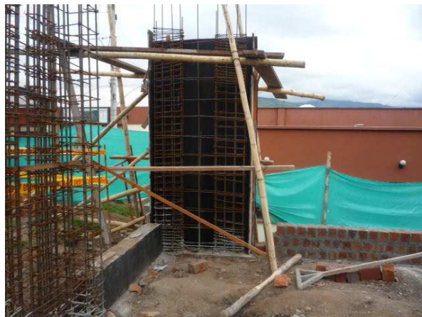
Ilustración 35 Armado de formaleta
