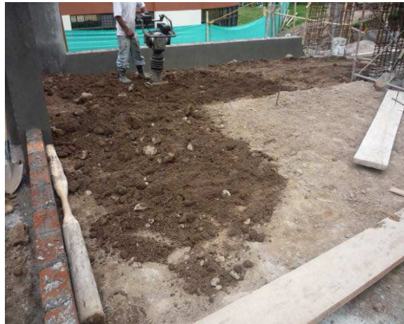
Ilustración 8 Relleno con material de sitio utilizando saltarín
