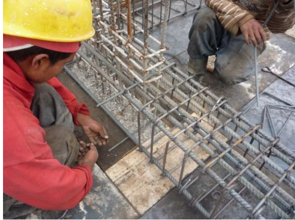
Ilustración 24 Colocación de estribos en C
