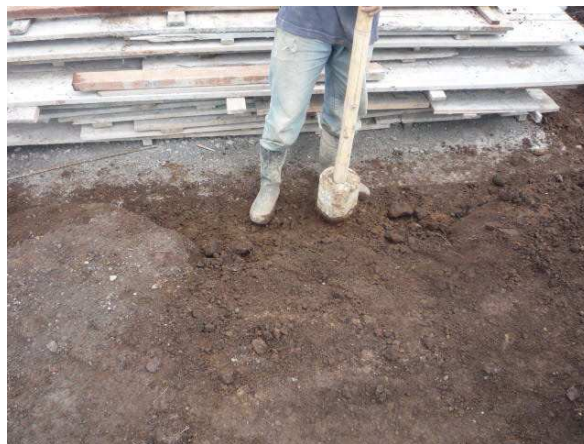
Ilustración 7 Relleno material de sitio utilizando pisón
