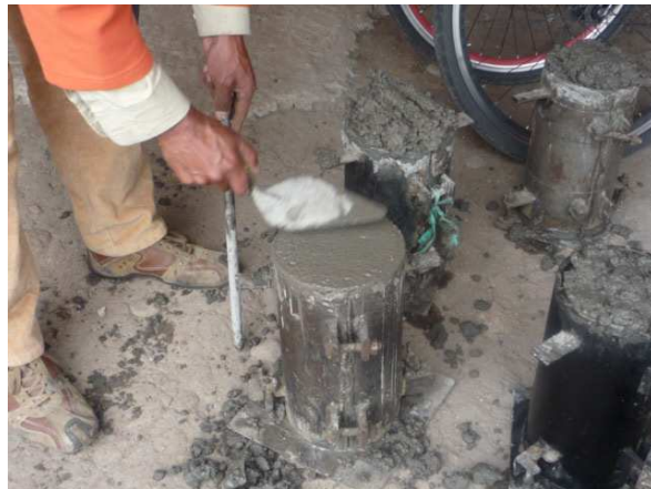
Ilustración 48 Enrase de cilindros de concreto
