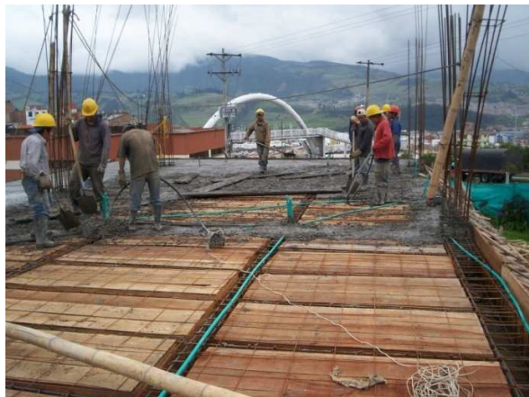
Ilustración 44 Proceso de colocación y vibrado del concreto
