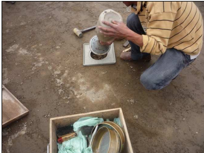
Ilustración 71 Ensayo de cono y arena
