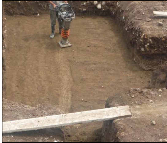
Ilustración 10 Compactación relleno recebo cemento
