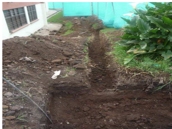
Ilustración 57 Excavación red sanitaria
