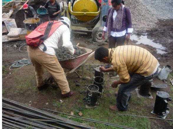
Ilustración 47 Toma de cilindros de concreto
