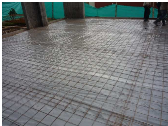
Ilustración 60 Instalación de polysec y malla electrosoldada
