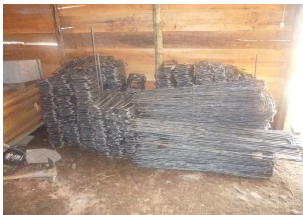
Ilustración 17 Almacenamiento de refuerzo transversal para columnas y pantallas
