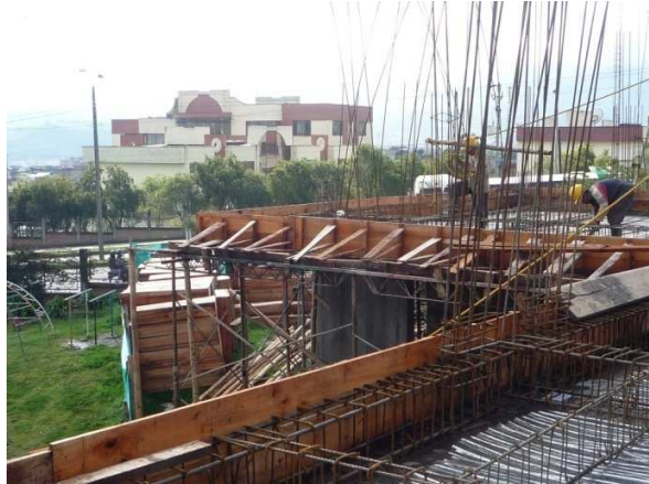
Ilustración 40 Tableros en madera para encofrar las caras externas de vigas
