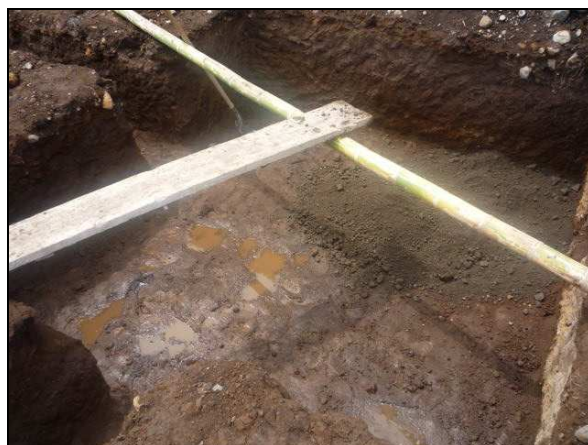
Ilustración 9 Vaciado relleno relleno cemento
