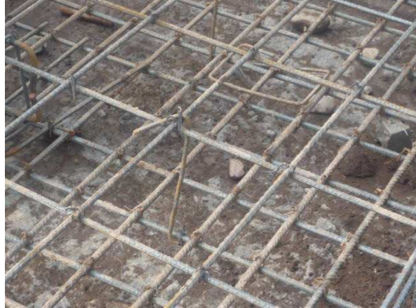
Ilustración 16 Refuerzo armado con doble parrilla
