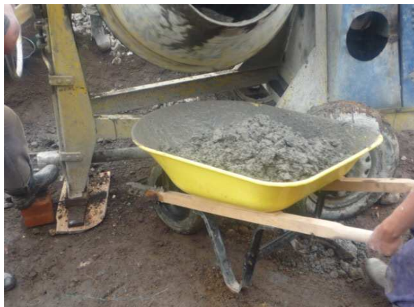
Ilustración 31 Mezcla y transporte de concreto
