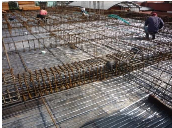
Ilustración 22 Colocación y amarre de refuerzo
