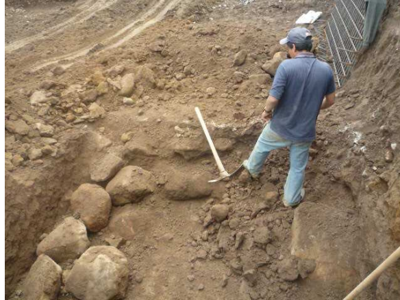
Ilustración 6 Excavación manual en conglomerado para cimentación
