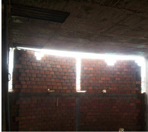
Ilustración 65 Confinamiento de muros de más de 3 metros de altura
