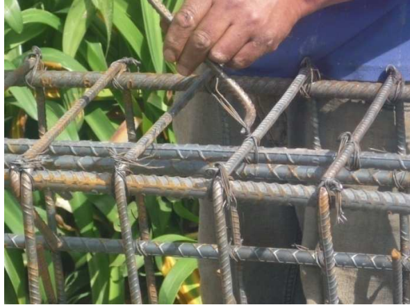
Ilustración 18 Armado refuerzo columnas y pantallas
