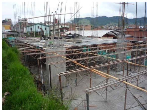
Ilustración 39 Armado de formaleta metálica
