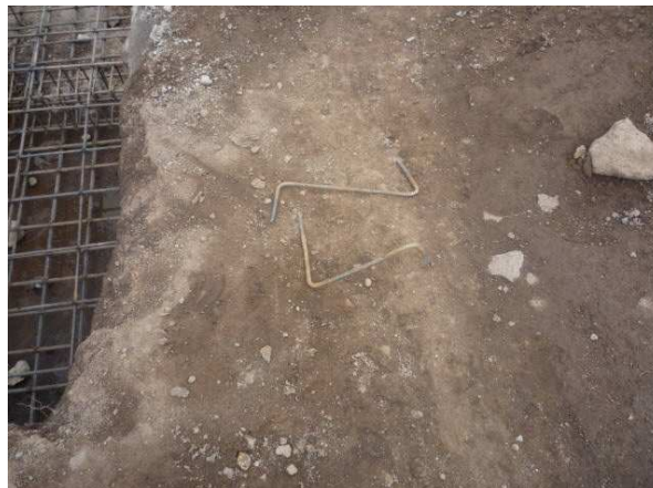
Ilustración 15 Separadores de refuerzo en doble parrilla
