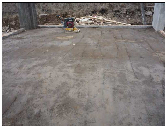
Ilustración 70 Base en recebo compactada
