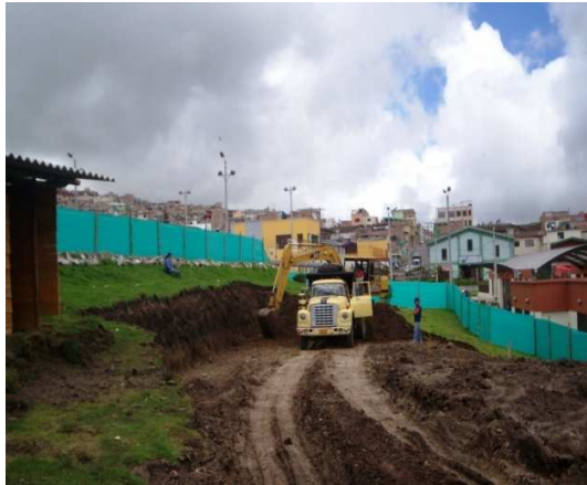
Ilustración 5 Excavación a máquina para explanación
