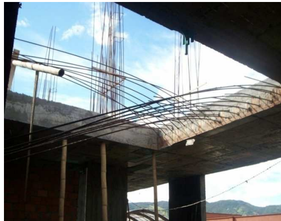
Ilustración 26 Refuerzo anclado para segundo tramo de escalera de primer piso y primer tramo de escalera del segundo piso
