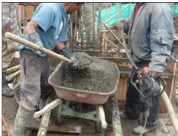
Ilustración 36 Proceso de fundición de pantallas y columnas
