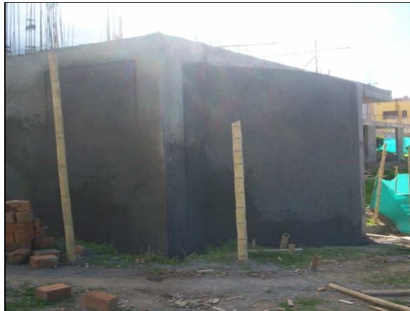
Ilustración 64 Muro de fachada
