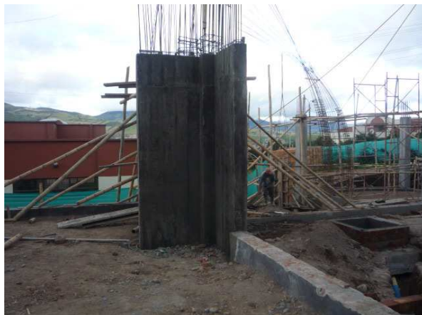
Ilustración 38 Sistema de columnas y pantallas terminadas
