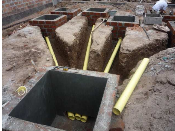
Ilustración 58 Instalación red sanitaria
