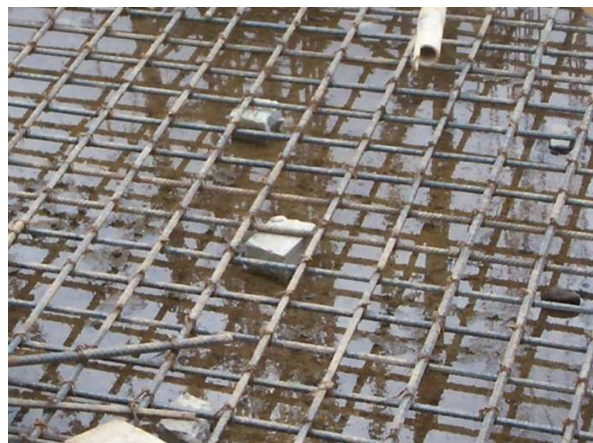
Ilustración 28 Las parrillas se colocan sobre panelas para garantizar el recubrimiento del refuerzo
