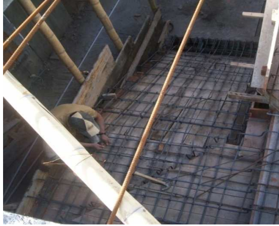
Ilustración 25 Colocación de refuerzo de escalera
