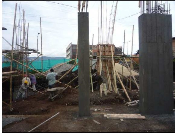
Ilustración 34 Formaleta para fundir columnas y pantallas
