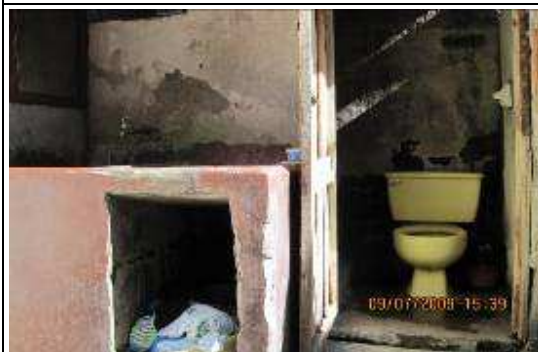
LAVADERO Y BAÑO ANTES
