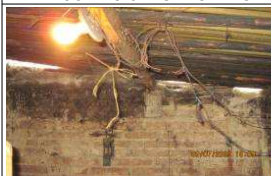
CUBIERTA Y PAÑETE ANTES
