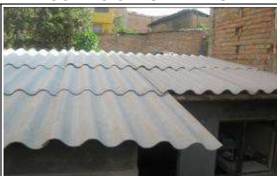
CUBIERTA Y PAÑETE DESPUES
