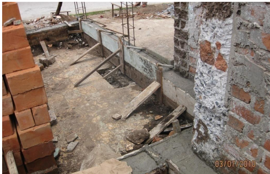
Figura 38 Actividad: Desencofrado de vigas de cimentación
