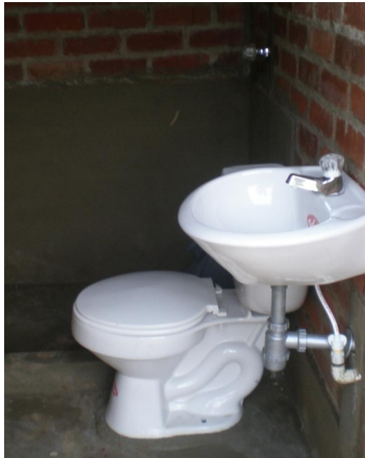
Figura 14 Actividad: Instalación de aparatos sanitarios. Inodoro, lavamanos, ducha. Localización: Vereda Potrerrillo.
