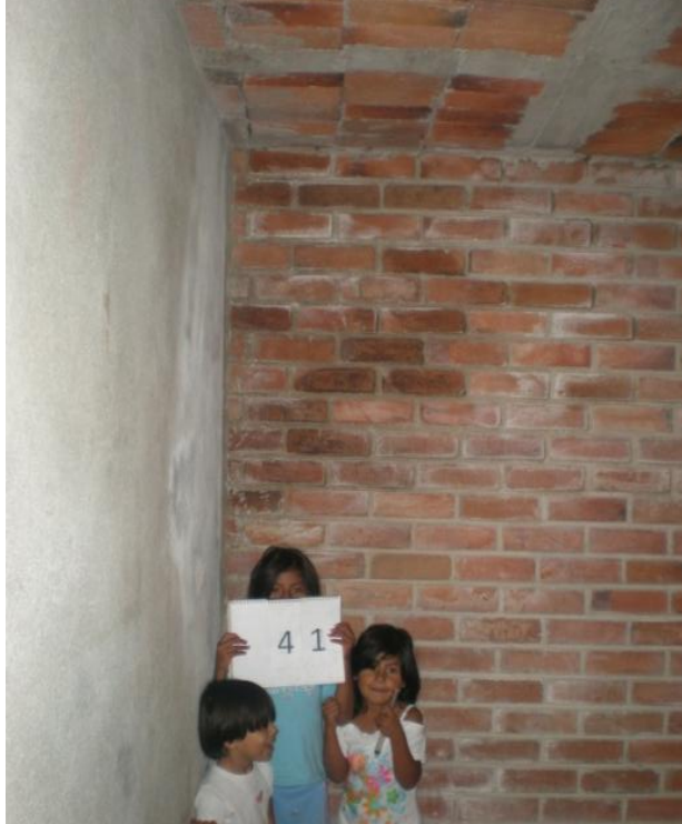
Figura 43 Actividad: Estado actual de muros y losa superior de la vivienda
