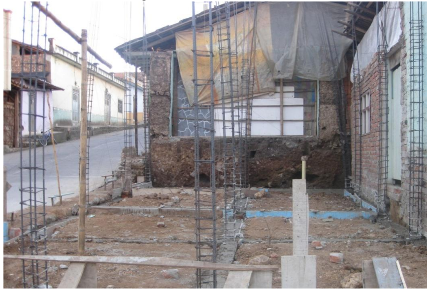
Figura 20 Actividad: Fundición de vigas de cimentación
