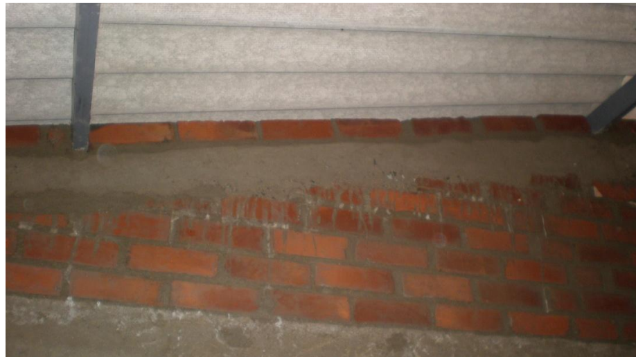
Figura 11 Actividad: Detalle viga cinta, perfil metálico y cubierta Localización: Vereda Altosano
