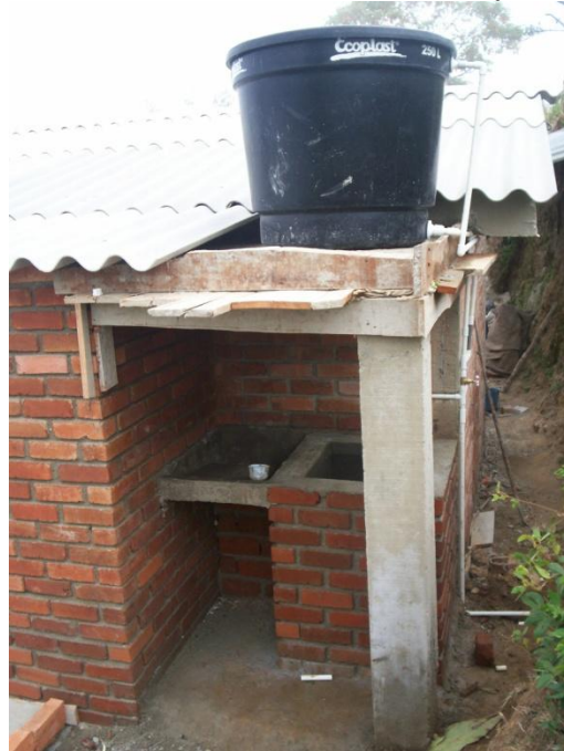
Figura 16 Actividad: Instalación de tanque de reserva. Localización: Vereda San Pablo Bajo
