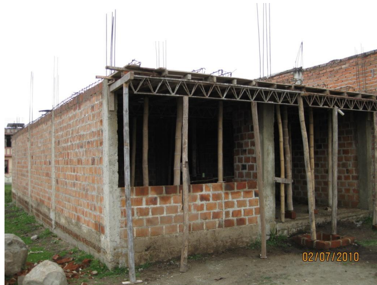
Figura 28 Actividad: Fundición de losa
