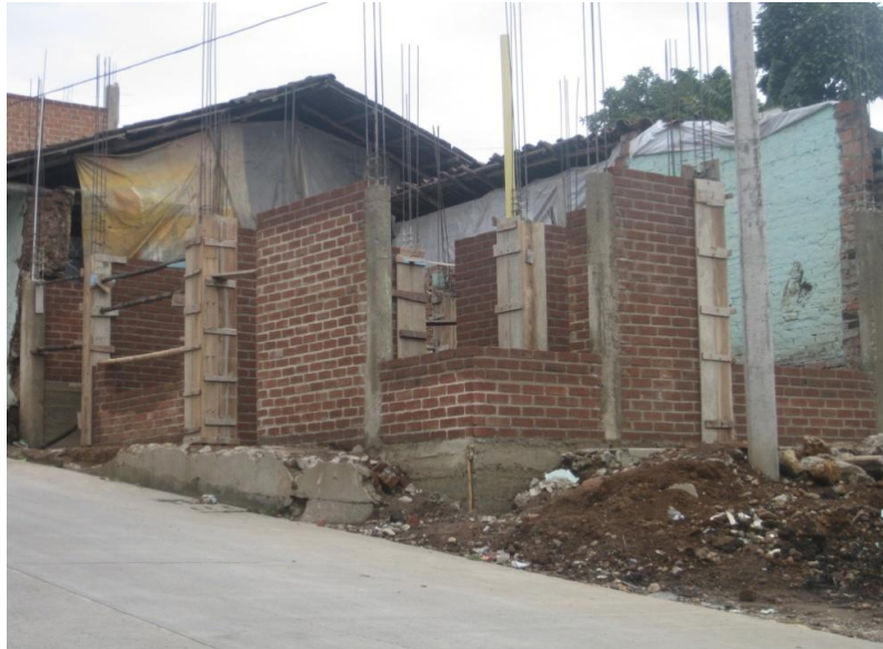
Figura 21 Actividad: Levantamiento de muros
