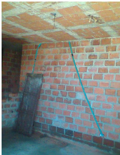
Figura 33 Actividad: Regatear y repellar instalación electrica
