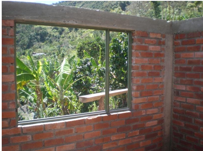
Figura 5 Actividad: Instalación de marcos y vidrios en ventanas. Localización: Vereda Potrerillo.
