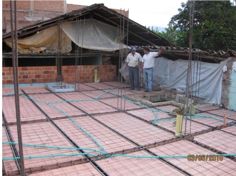
Figura 23 Actividad: Preparación para función de losa aligerada en Placa Fácil.
