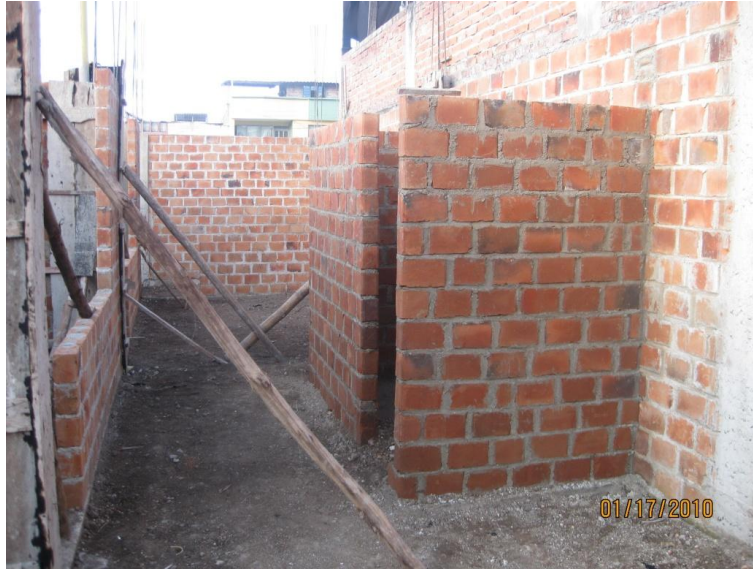
Figura 27 Actividad: Curado de columnas
