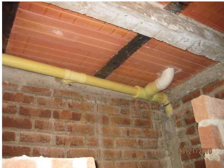
Figura 24 Actividad: Vista inferior de losa aligerada en Placa Fácil.
