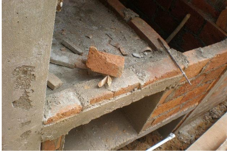
Figura 13 Actividad: Construcción de lavadero Localización: Vereda Aminda.
