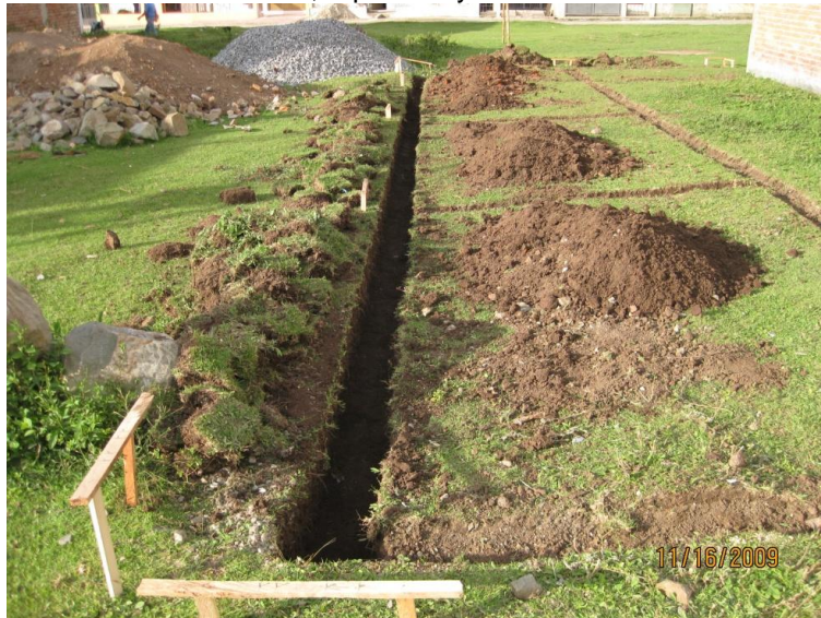
Figura 25 Actividad: Localización, replanteo y excavación
