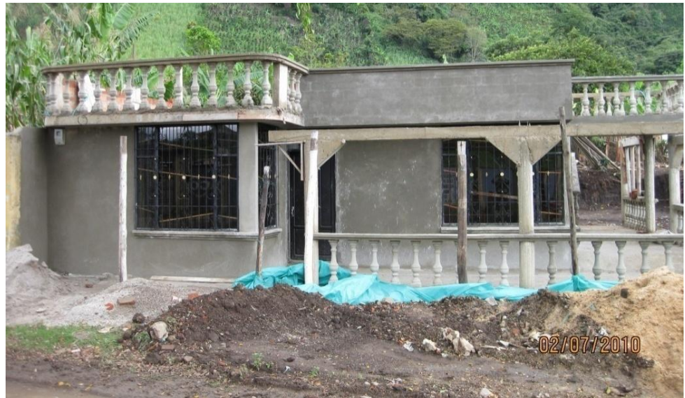
Figura 34 Actividad: Repello de muros e instalación de puerta y ventana
