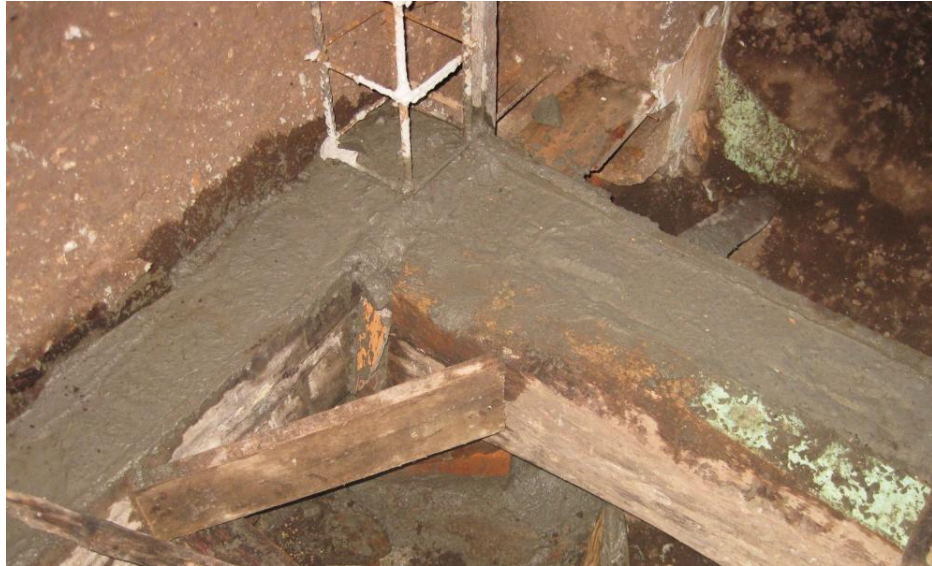
Figura 37 Actividad: Curado de vigas de cimentación
