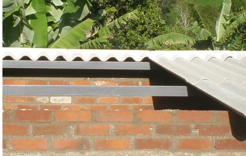
Figura 10 Actividad: Instalación de tejas y amarras para cubierta. Localización: Vereda Chuza
