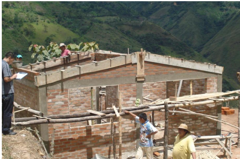
Figura 7 Actividad: Fundición de vigas cintas Localización: Vereda Potrerillo
