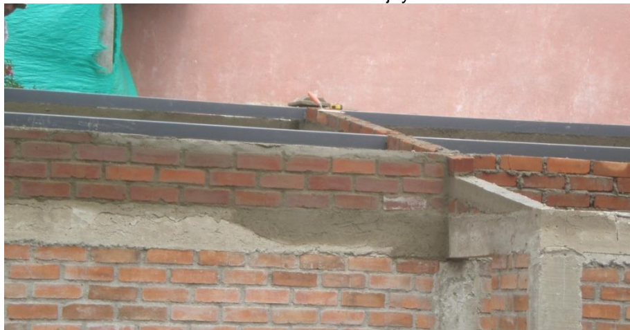
Figura 9 Actividad: Detalle de correas metálicas para cubierta Localización: Vereda Los llanos de Machabajoy
