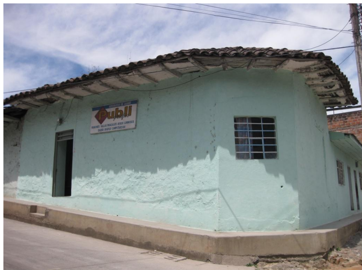
Figura 17 Actividad: Estado inicial de la vivienda
