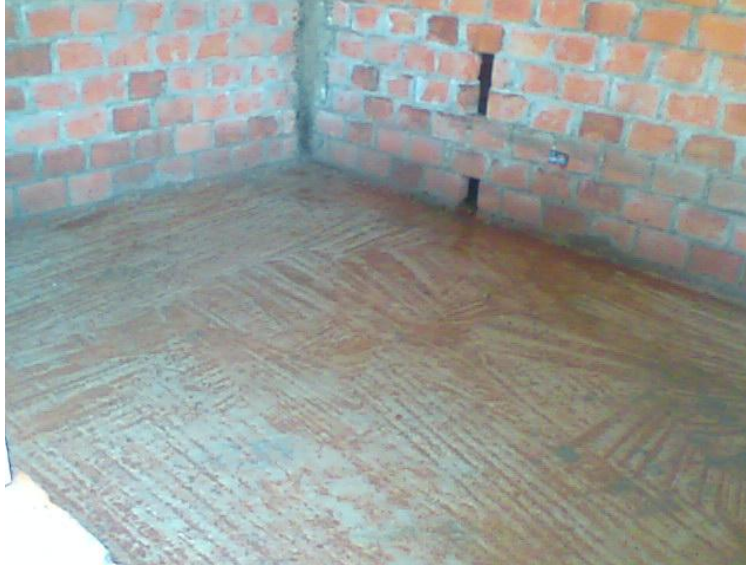
Figura 32 Actividad: Fraguado de losa de piso
