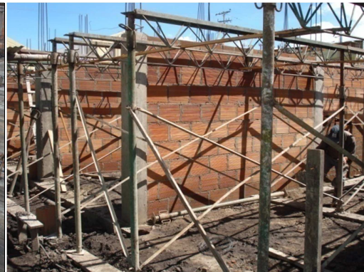
Fig. 73 Armado estructura de soporte losa
