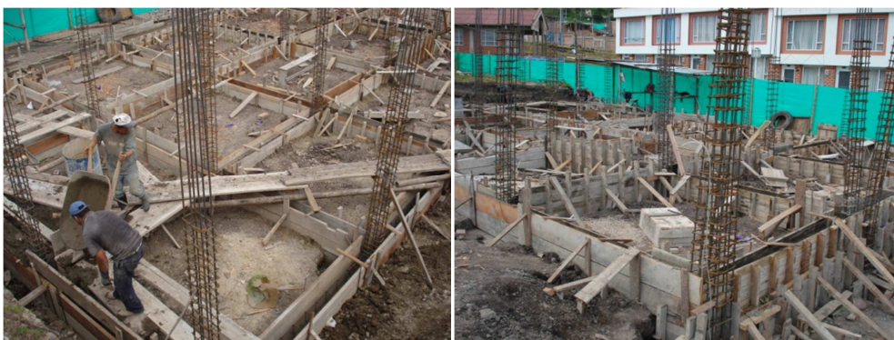
Fig.29 y 30 Apuntalamiento formaleta de vigas de cimentación.
