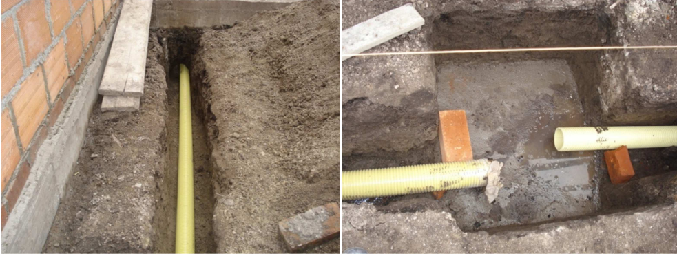
Fig. 40 Tubería 4" entre cajas B-C y C-D. Fig. 41 tubería 4" en caja B-C
