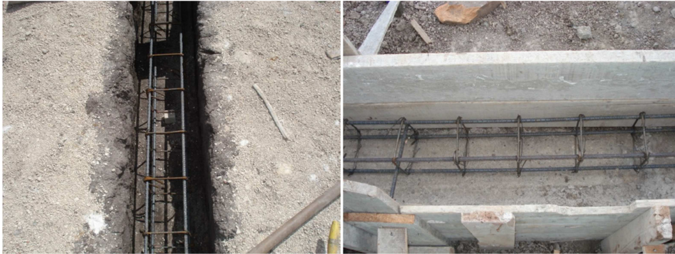
Fig. 27 y 28 Refuerzo de vigas de cimentación
