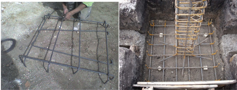
Fig. 19 y 20. Armada y nivelada del refuerzo de zapatas
