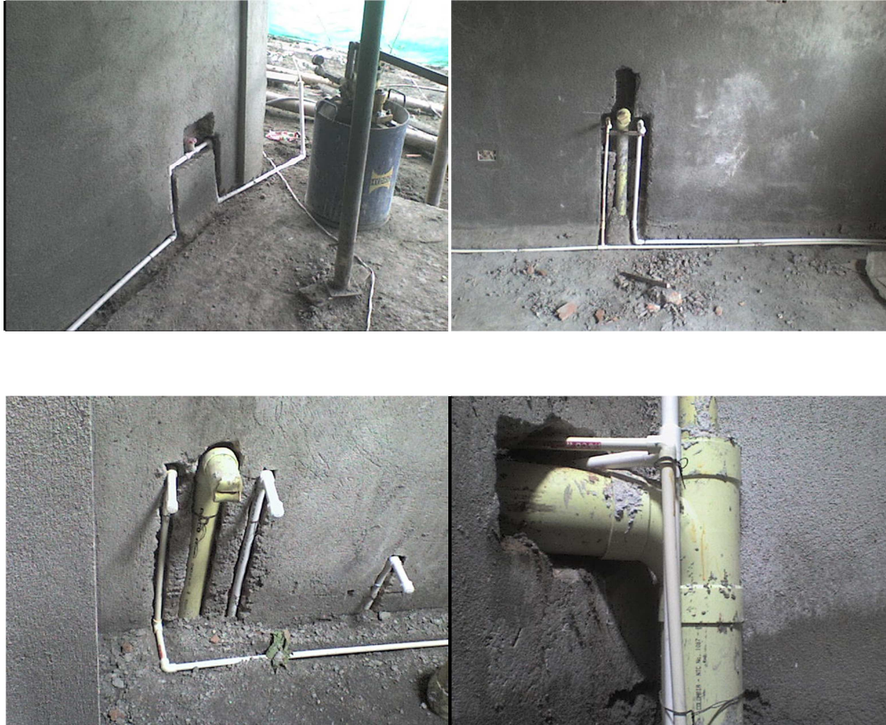
Fig 53-56. Instalaciones Hidráulicas sala, cocina, baño y entrada baño 3P
