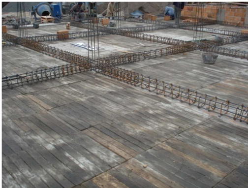
Fig. 72 Armado de vigas losa
