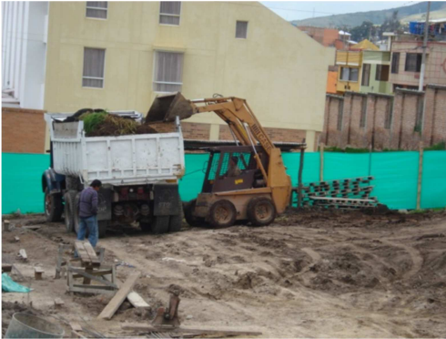
Fig.13 Cargue de material de excavación
