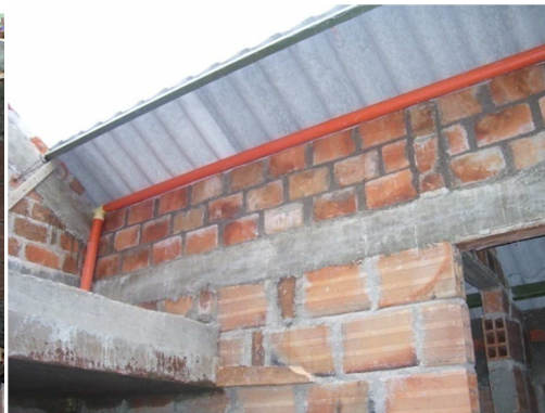
Fig.77 Tubería de ventilación
