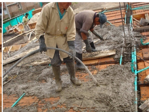
Fig. 75 Vibración vigas losa
