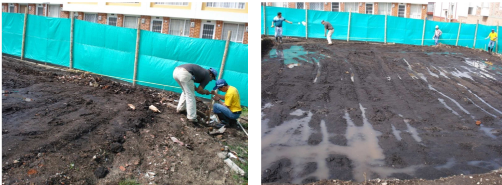
Fig. 7 Y8 Localización y replanteo e instalación de estacas
