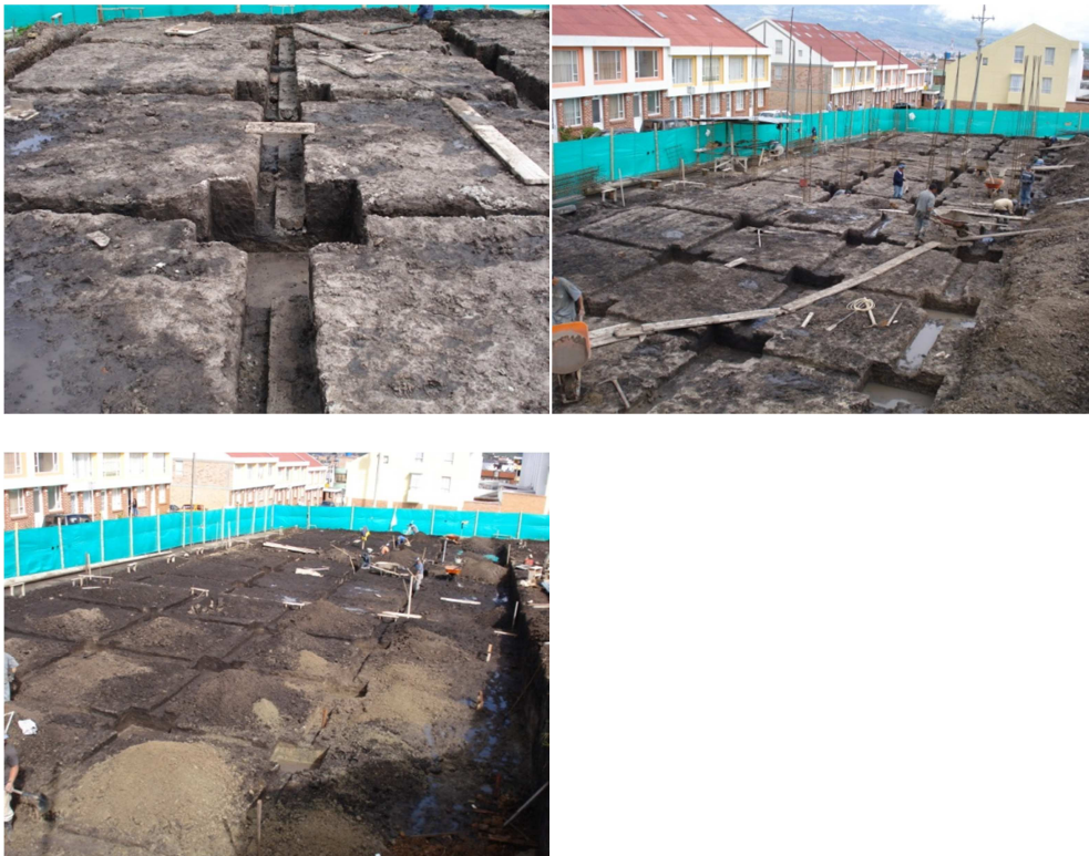
Fig. 9-11. Excavaciones de zapatas Fase 1 Casas 14-26
