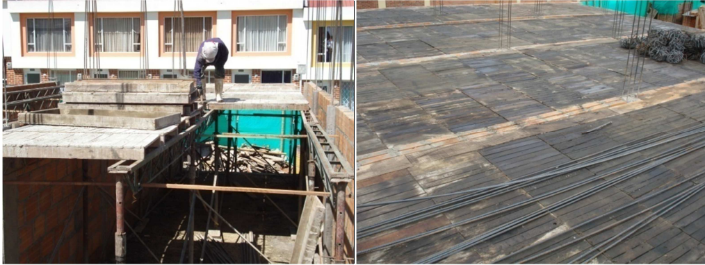
Fig. 70 Armado de la Formaleta. Fig. 71 Formaleta totalmente soportada
