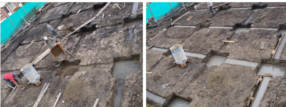
Fig. 14 y15.Fundición de solados en zapatas y vigas de cimentación
