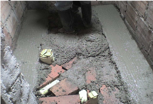
Fig. 49 Fundición sobre piso baño
