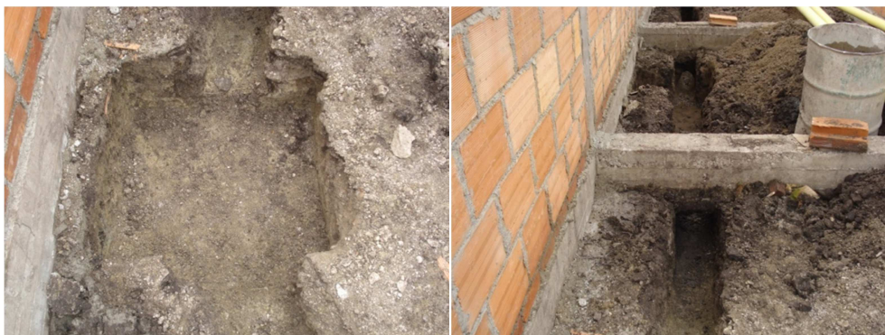
Fig. 35 Excav caja de sección 0.4*0.4 Fig.36Excav para tubería Novafor 4
