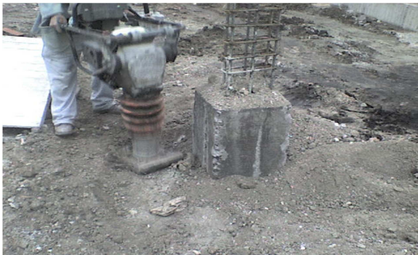
Fig. 12 Relleno y compactación alrededor de zapata y pedestal.
