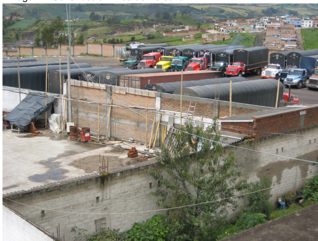
Imagen 4. Construcción Área de Personal.
