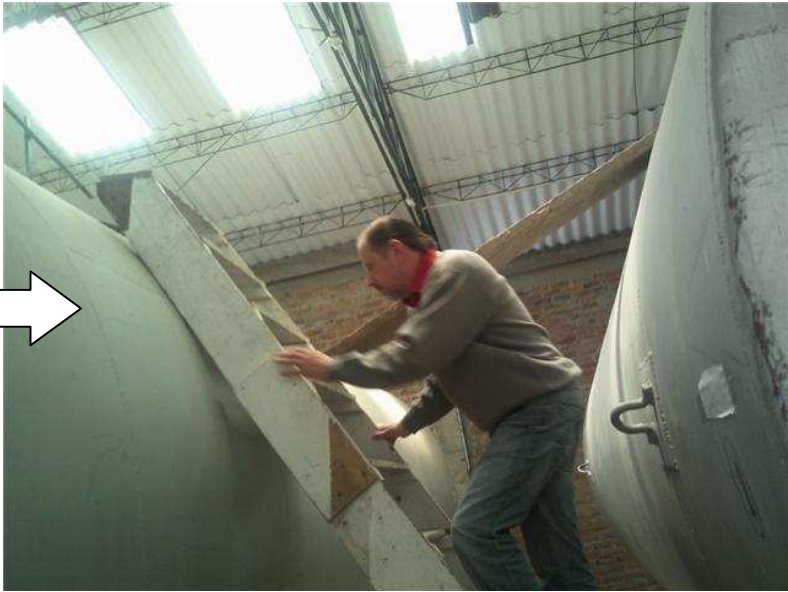
Observación tanque de almacenamiento Dr. Joaquín Adolphs
