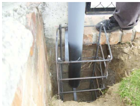
Imagen 6. Acero de refuerzo
