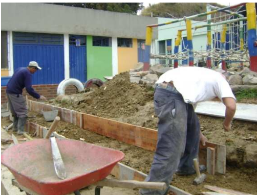
Imagen 42.conformacion formaleta gradas Acceso juegos infantiles
