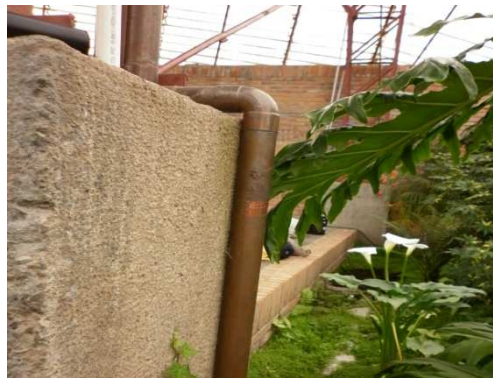
Imagen 15. Conexión tubería de cobre
