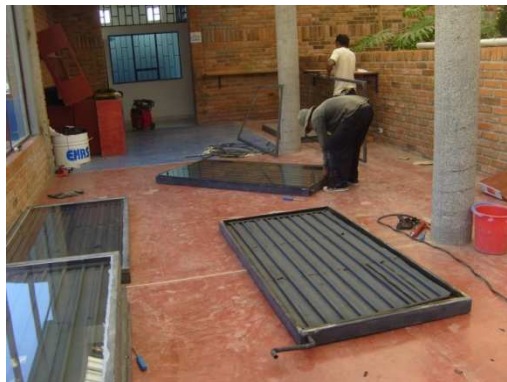
Imagen 11. Limpieza y mantenimiento de paneles solares
