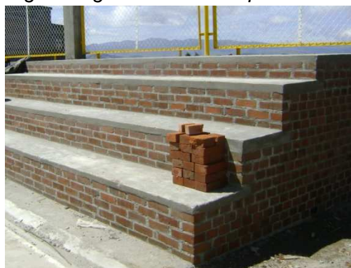
Imagen 64. gradería en mampostería.
