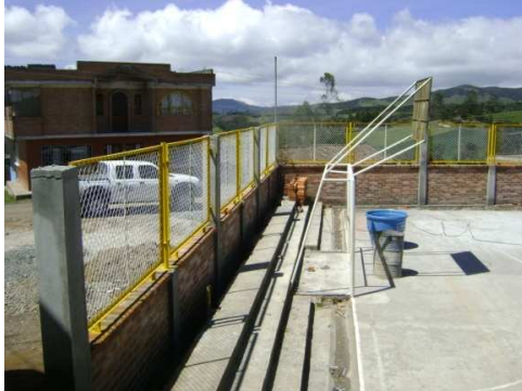
Imagen 56. Cerramiento de protección. malla.
