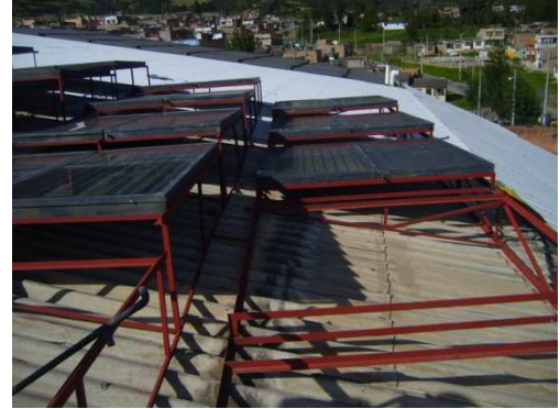
Imagen 14. Montaje de paneles solares
