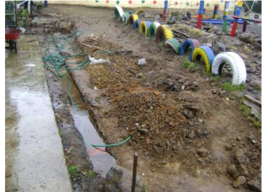
Imagen 31. Excavación acceso al restaurante
