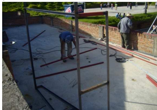
Imagen 12. Estructura soporte planta solar
