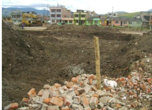
Imagen 66. excavacion de la cancha de futbol
