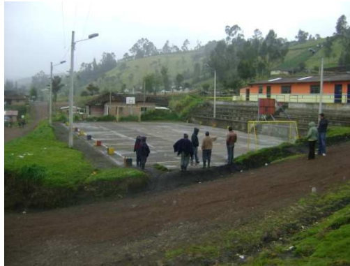
Imagen 1. Estado inicial polideportivo
