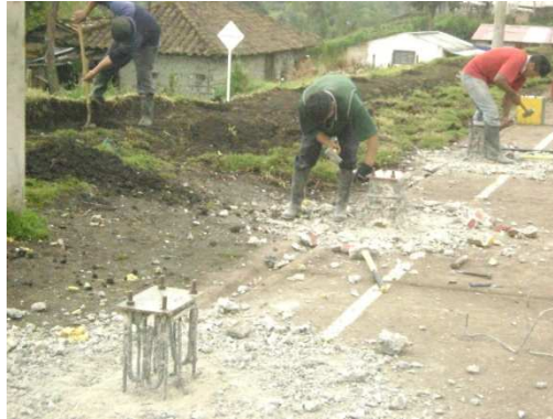
Imagen 3. Demolición dados en concreto
