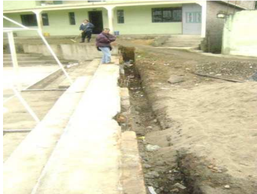
Imagen 30. Exc. Cimentación cerramiento.
