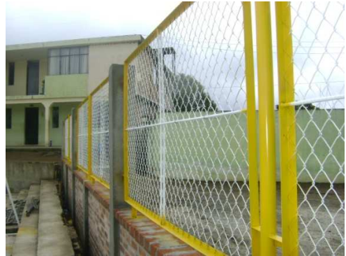
Imagen 57. refuerzo varilla 1/2" en
