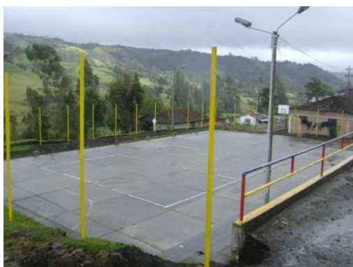
Imagen 7. Apoyo de cerramiento
