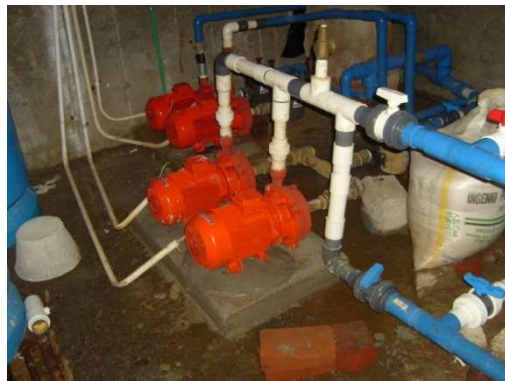
Imagen 20. Instalación subestación de bombas
