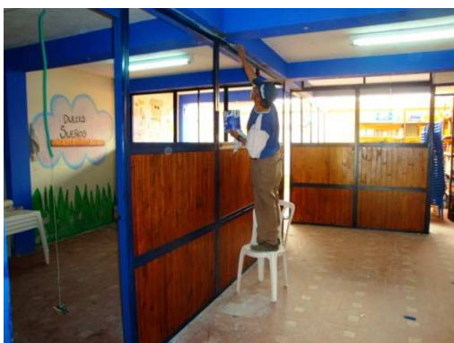
Imagen 24. Acabado de instalación
