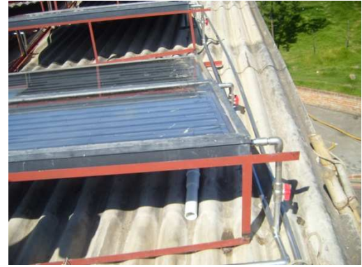
Imagen 19. Anclaje panel a estructura
