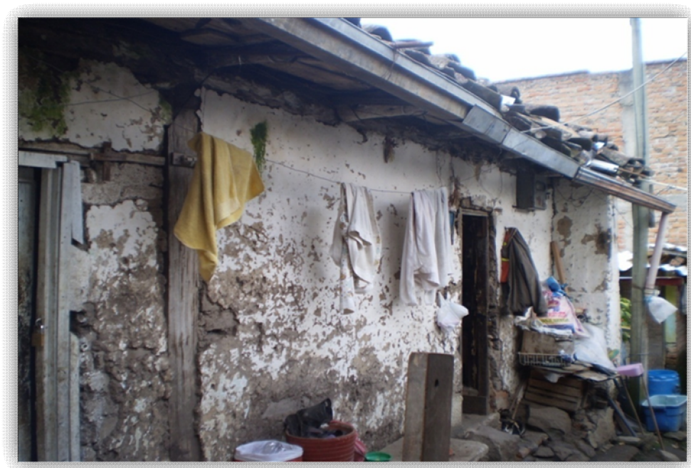
Figura 3. Vivienda localizada en el sector de San Antonio de Padua.
