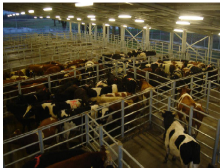
Figura 12. Corral con buena iluminación y cubierto.
