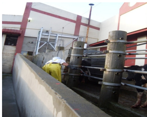
Figura 21. Finalización de Manga de acceso al cajón de Noqueo en la Planta de Sacrificio “FRIGOVITO”
