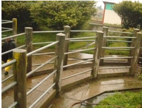
Figura 19. Inicio de Manga de acceso al cajón de Noqueo en la Planta de Sacrificio “FRIGOVITO”
