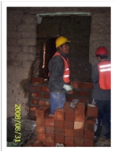
Figura 23. Reposición de Muros
