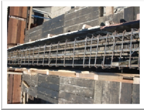
Figura 72. Armado y Fundición de Vigas.
