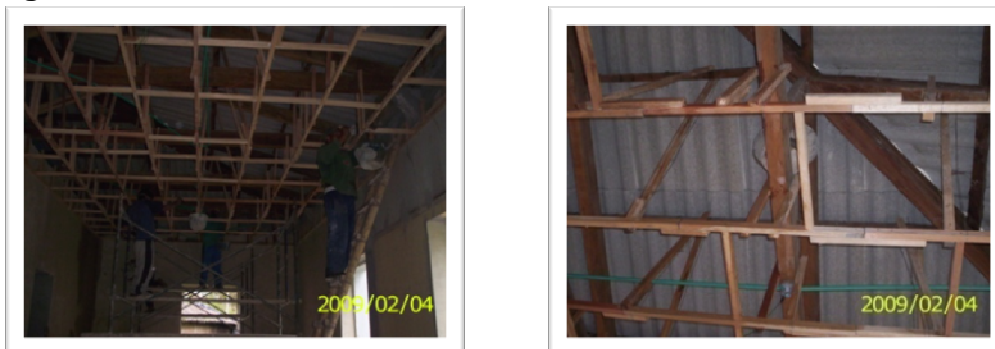
Figura 29. Entramado en Madera Cielo Falso 2do Piso.
