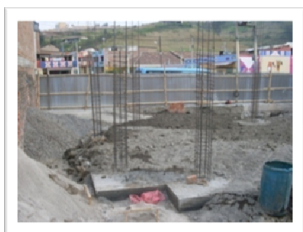
Figura 68. Relleno con Material Compactado
