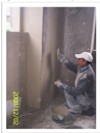
Figura 32. Estuco y Pintura.
