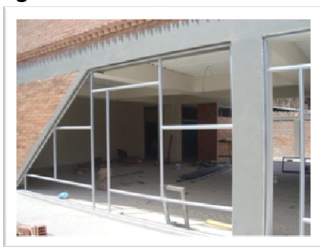
Figura 83. Instalación de Ventanas y Puertas
