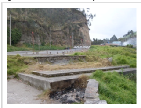
Figura 5. Exteriores y Talud Fachada Posterior
