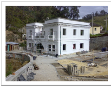
Figura 47. Pintura Fachadas Exteriores
