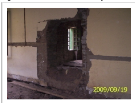
Figura 8 Demoliciones y Retiro de Enchapes
