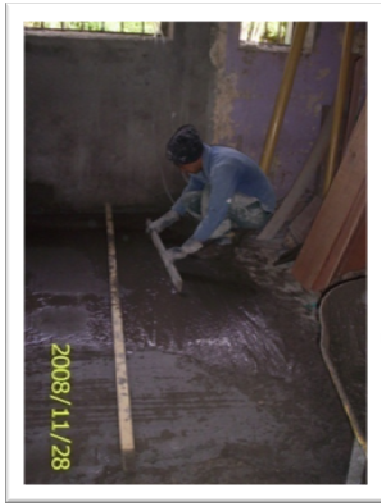
Figura 33. Fundición de Pisos y Repello.
