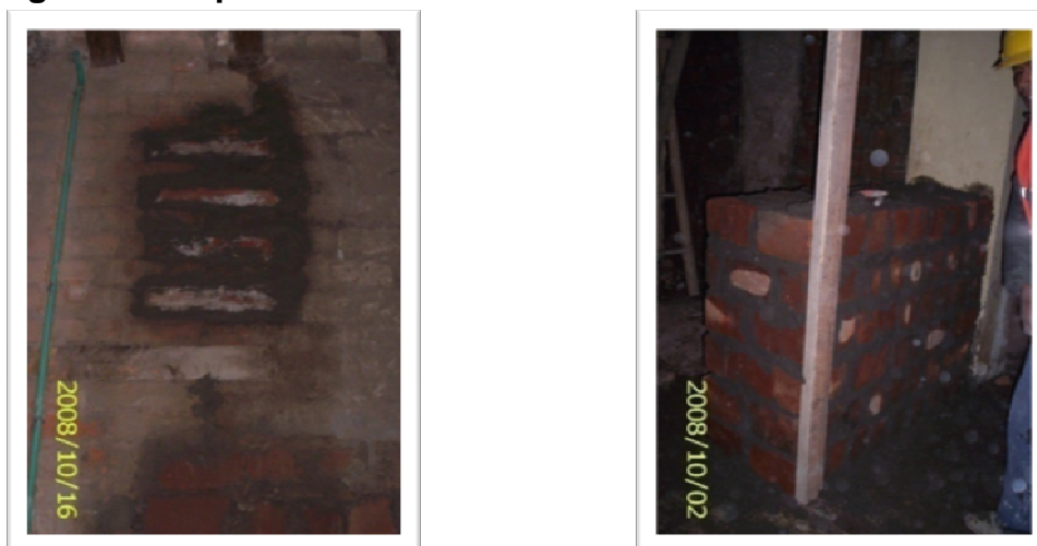
Figura 24. Reposición de Muros.
