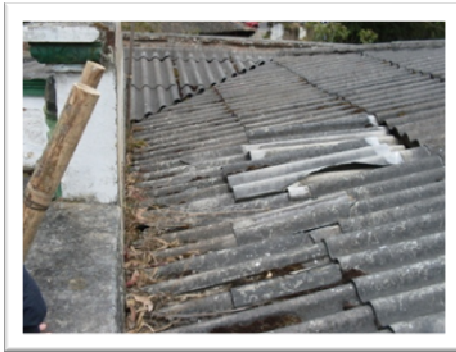
Figura 13. Retiro de cubierta
