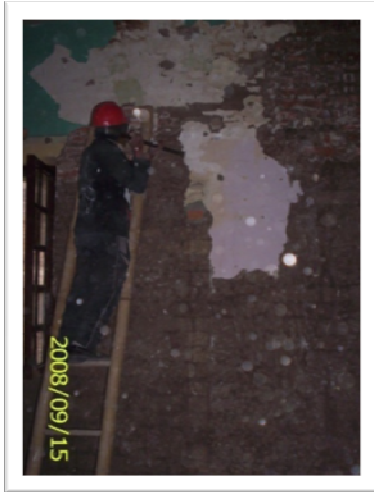
Figura 9. Retiro de repellos
