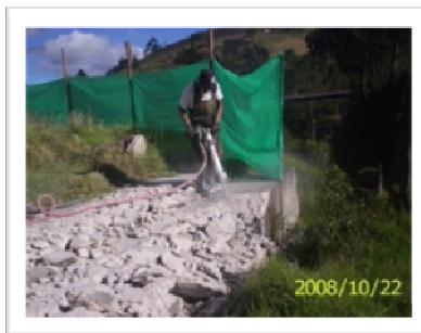
Figura 12 Demolición Cimiento Concreto Enterrado Puente Militar.
