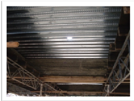
Figura 73. Instalación de Losa en Metaldeck
