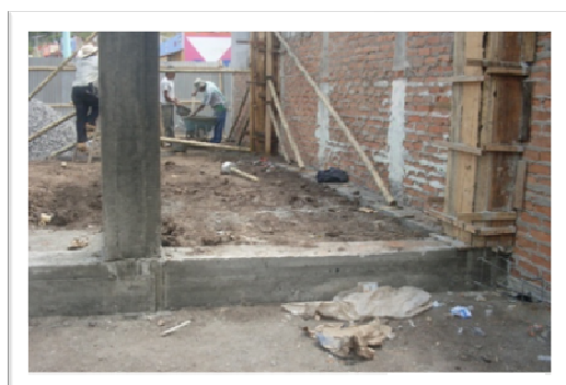
Figura 69. Vigas de Cimentación.
