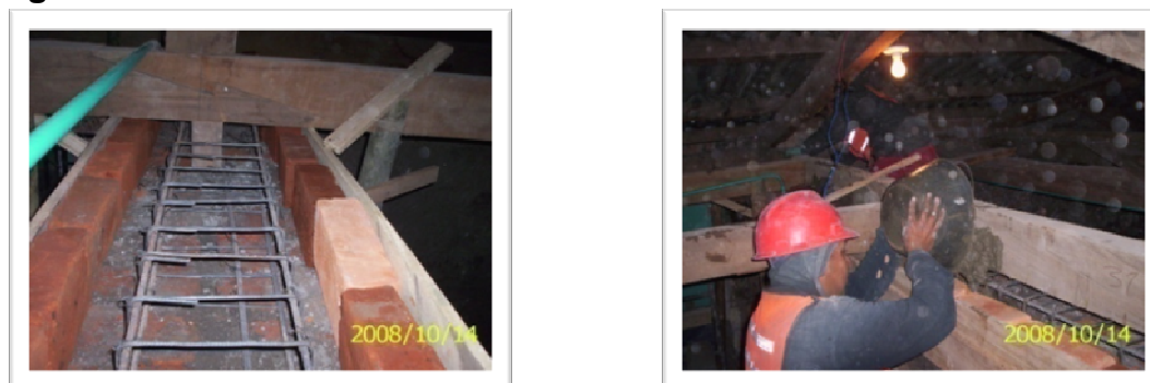
Figura 18. Anillo Cinta en Concreto Reforzado.
