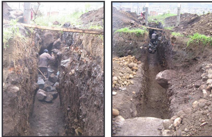
FIGURA 120. Corte de roca en excavación para empalme de alcantarillado sanitario.
