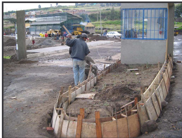
FIGURA 124. Construcción de bordillos entre las vías 1 y 2, entre K0+000 y K0+010.
