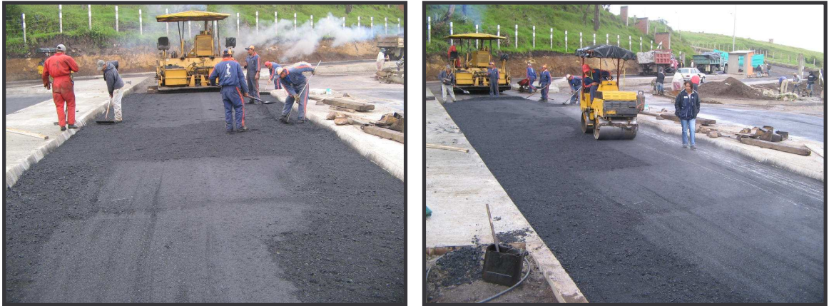
FIGURA 123. Pavimentación con asfalto en la vía 3 entre K0+015 y K0+032.
