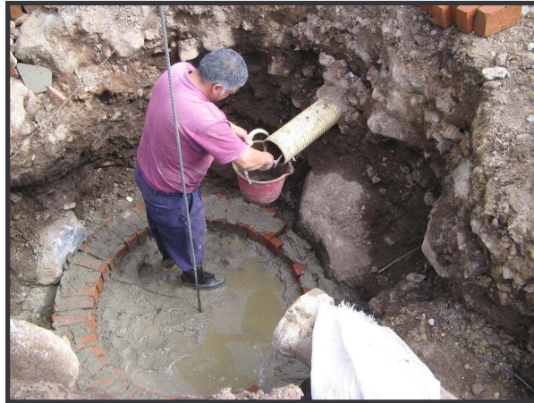
FIGURA113. Construcción de cámara de alcantarillado sanitario en la vía 1.
