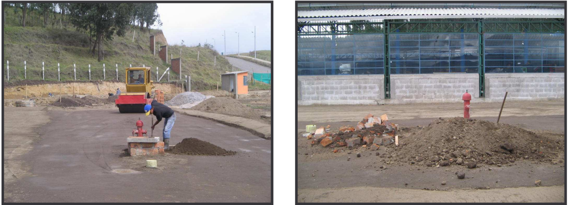
FIGURA 82. Excavación manual para retiro de hidrante.
