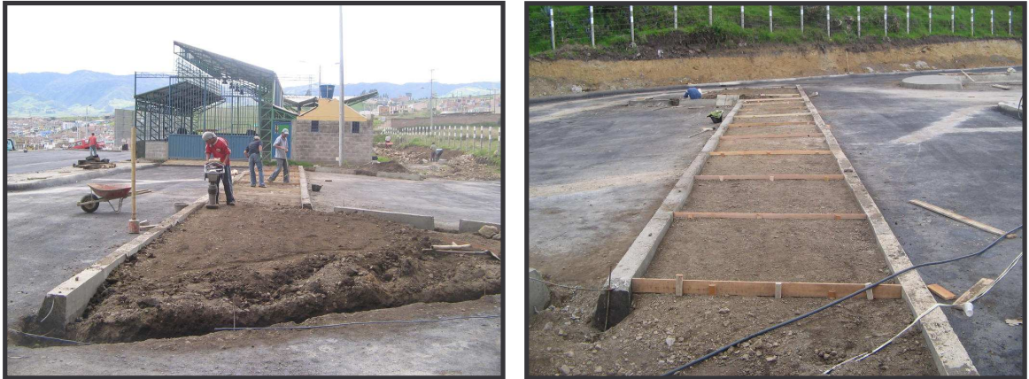
FIGURA 116. Compactación de recebo en andén ubicado entre las vías 3 y 1.
