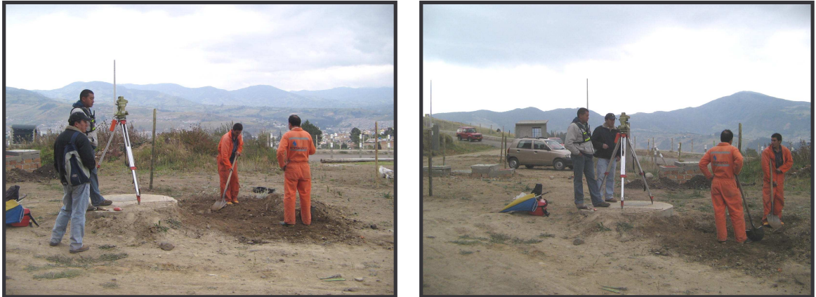
FIGURA 47. Localización y replanteo.
