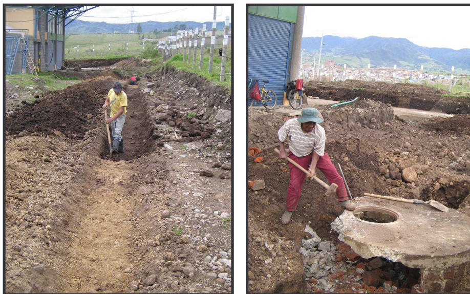
FIGURA 102. Excavación manual para profundizar alcantarillado sanitario, vía 1.
