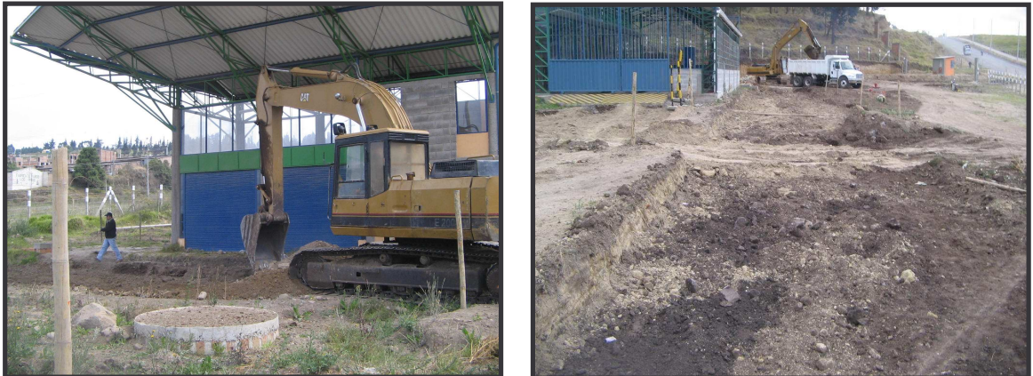
FIGURA 50. Excavación mecánica en vía 2.
