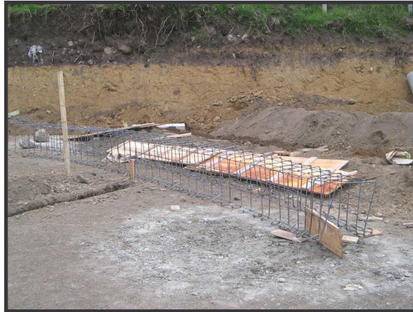
FIGURA 96. Hierro para recubrimiento en concreto reforzado de tuberías de conexión entre cámaras y sumideros.
