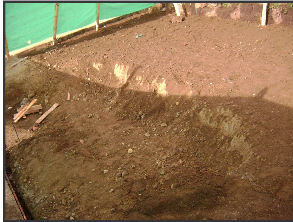
FIGURA 42. Relleno con material de préstamo.
