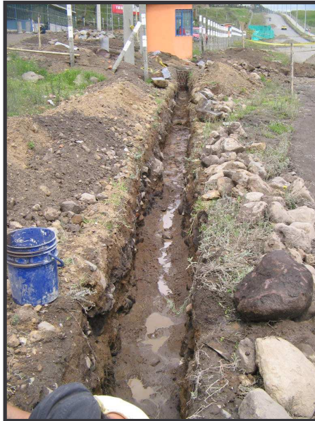
FIGURA 89. Excavación manual para conexión de cámara hacia sumidero externo.
