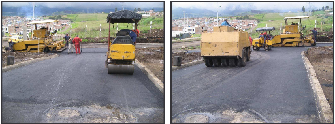
FIGURA 121. Pavimentación con asfalto en empalme entre la vía 1 y la vía 2.
