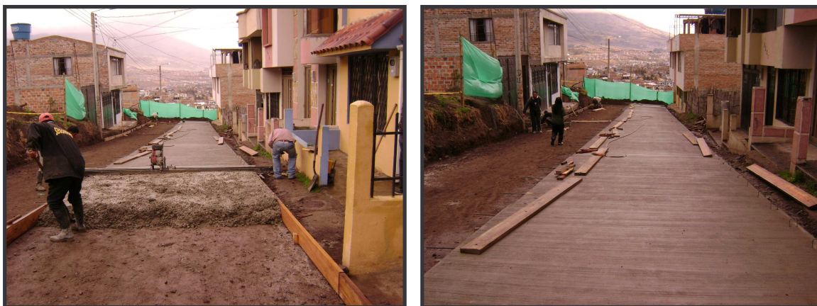
FIGURA 35. Pavimentación de la vía, carril derecho.
