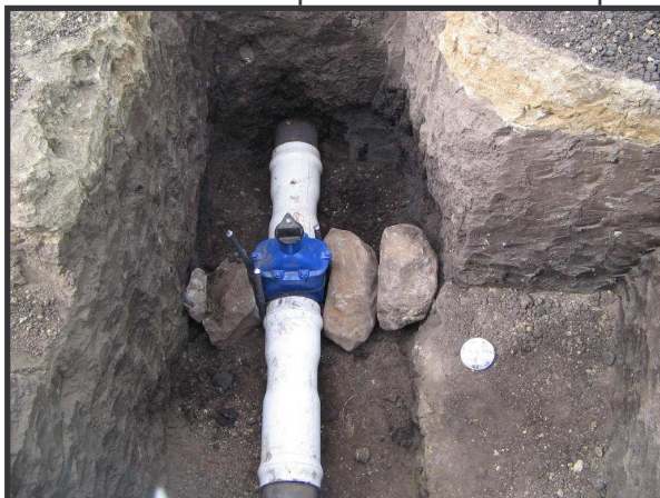
FIGURA 62. Instalación de válvula en la tubería de 8”.
