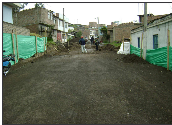
FIGURA 14. Excavación manual para cajeo de la vía desde K0+090 hasta K0+096.
