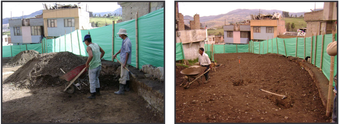
FIGURA 15. Extendido manual del material para Base granular.
