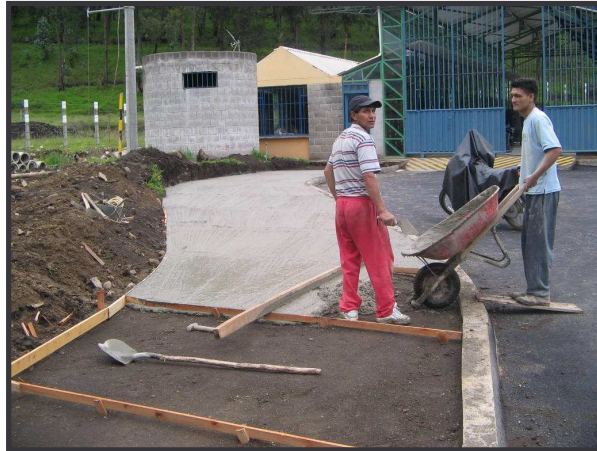
FIGURA 119. Construcción de andenes en la vía 3, lado derecho.
