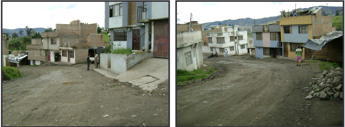
FIGURA 1. Estado inicial de la obra barrio El Rosario.
