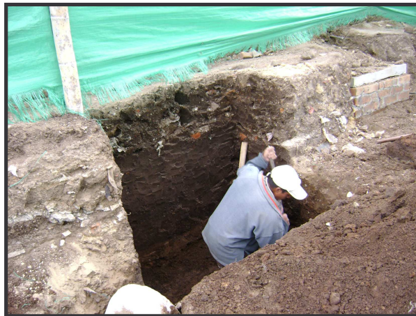
FIGURA 41. Excavación manual para sumidero.
