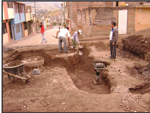
FIGURA 43. Relleno y compactación en zona de intersección con carrera 9Este B.
