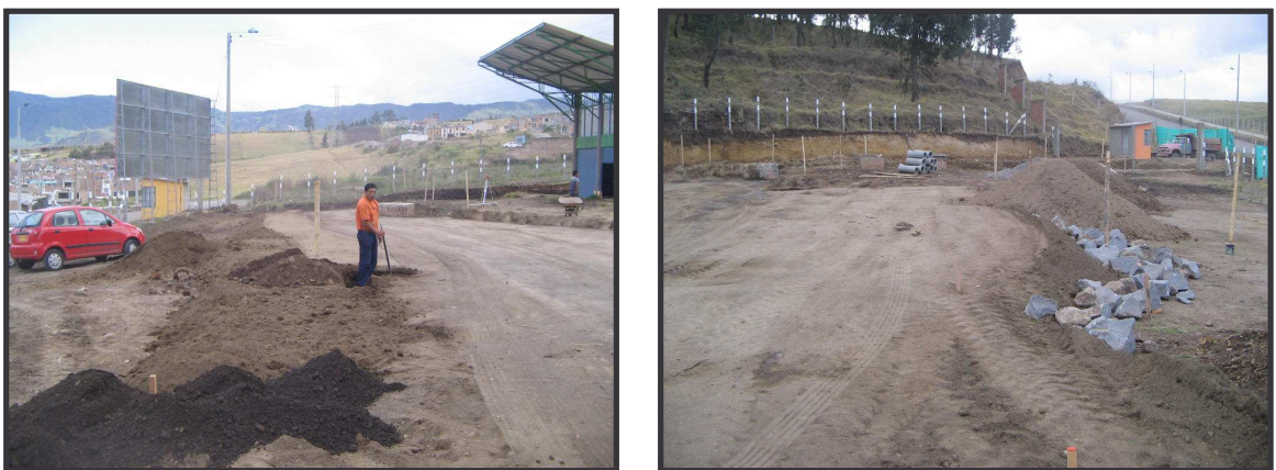
FIGURA 75. Extendido manual del material de recebo para el terraplén de la vía 2 lado izquierdo.
