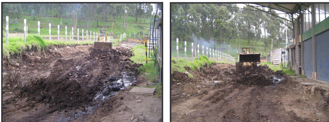
FIGURA 125. Retiro de material proveniente de las excavaciones manuales, vía 1.
