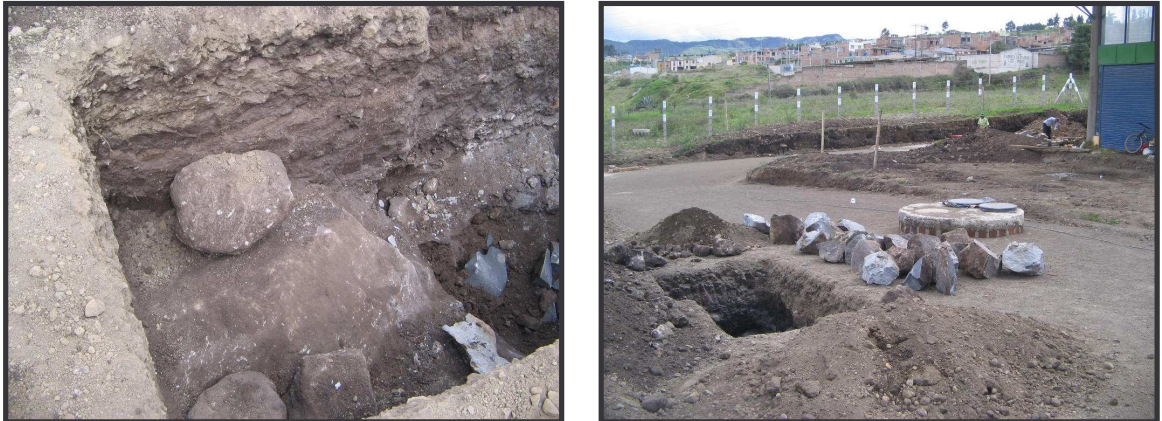
FIGURA 85. Corte de roca en excavación para sumidero en la vía 2.
