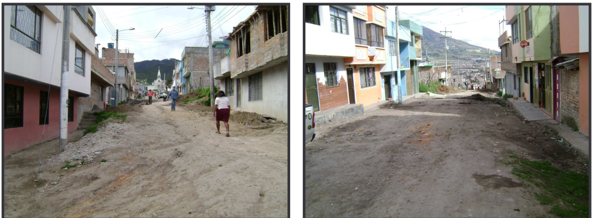
FIGURA 25. Estado inicial de la obra barrio El Triunfo.
