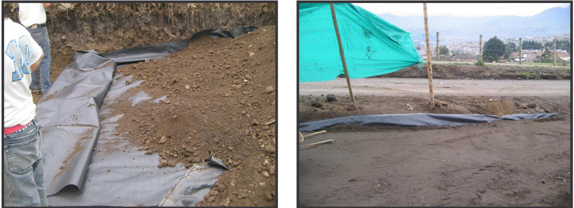
FIGURA 76. Geotextil colocado al inicio de las vías 1 y 2.
