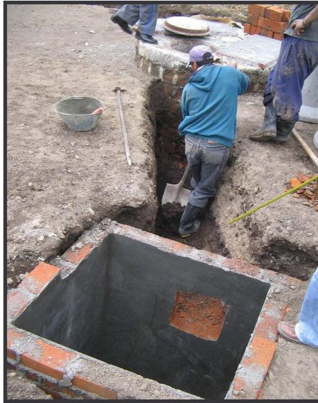
FIGURA 87. Excavación para conexión de sumidero a cámara, vía 2.
