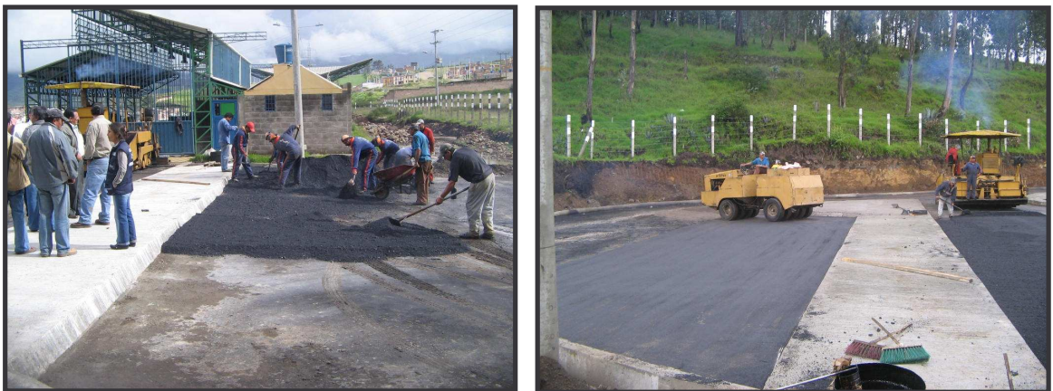
FIGURA 122. Pavimentación con asfalto en parqueadero de la vía 1.
