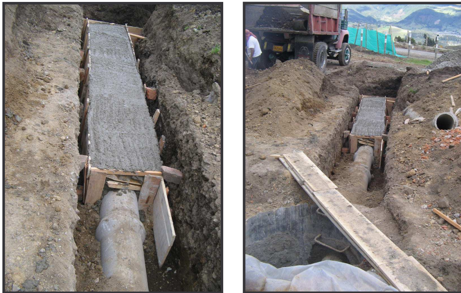
FIGURA 99. Recubrimiento de tubería de conexión de 10”.
