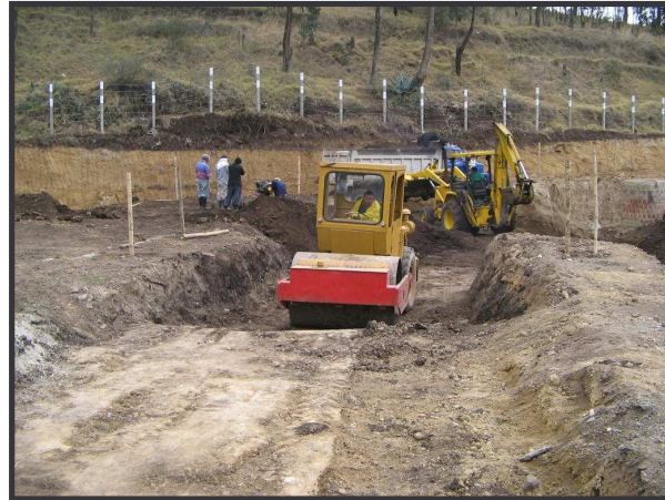
FIGURA 64. Compactación mecánica en la vía 2.
