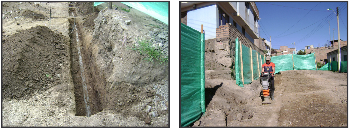
FIGURA 12. Relleno y compactación de zanjas donde se instaló tubería de acueducto.
