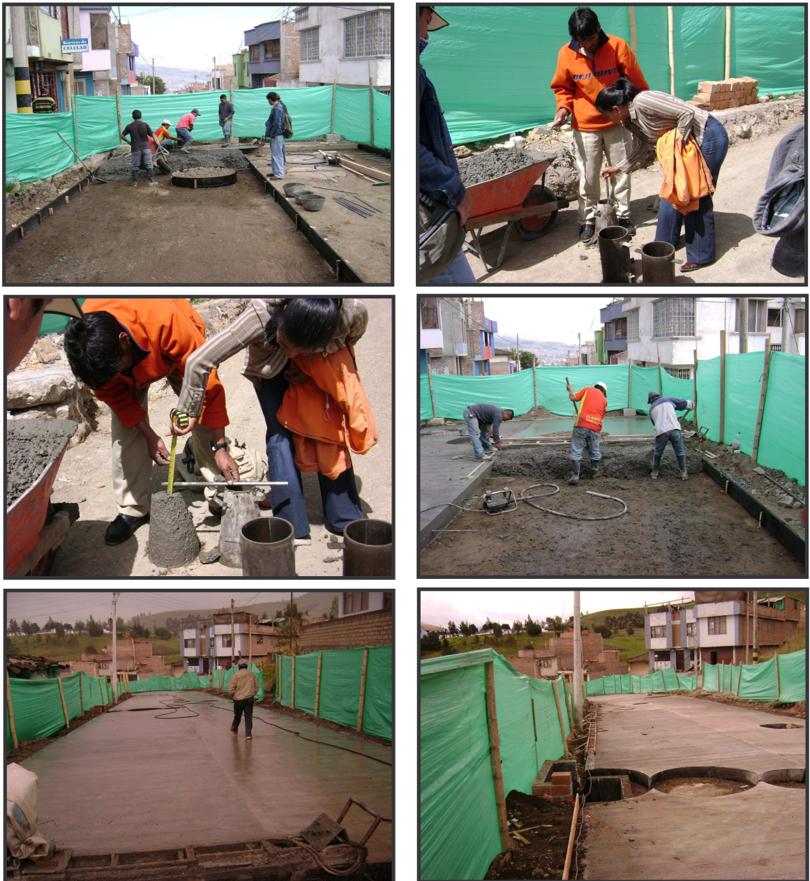
FIGURA 19. Fundición y control de calidad de concreto para la vía.
