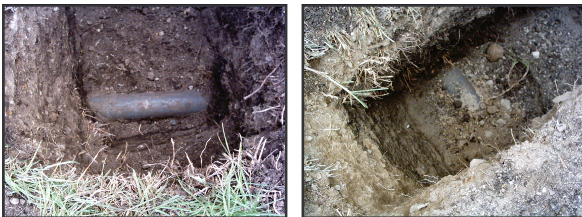
FIGURA 55. Apiques para descubrir la tubería de acueducto de 8".
