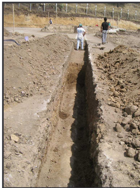
FIGURA 71. Excavación manual para reposición de tubería de conexión, alcantarillado pluvial en la vía 2.
