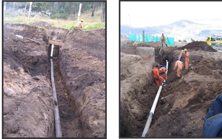
FIGURA 60. Instalación de tubería de 8”.
