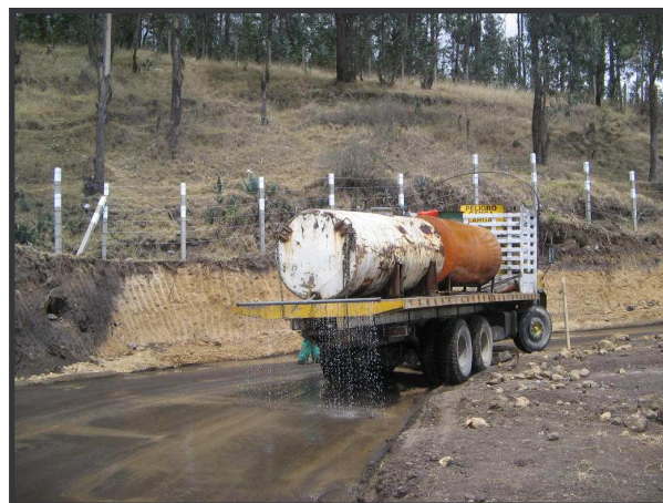
FIGURA 74. Tanque irrigador, hidratando la subbase en la vía 1.
