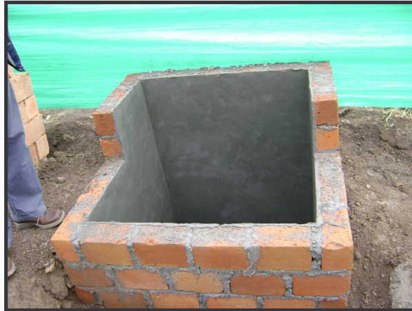
FIGURA 9. Construcción de sumidero ubicado en K0+078 lado derecho.
