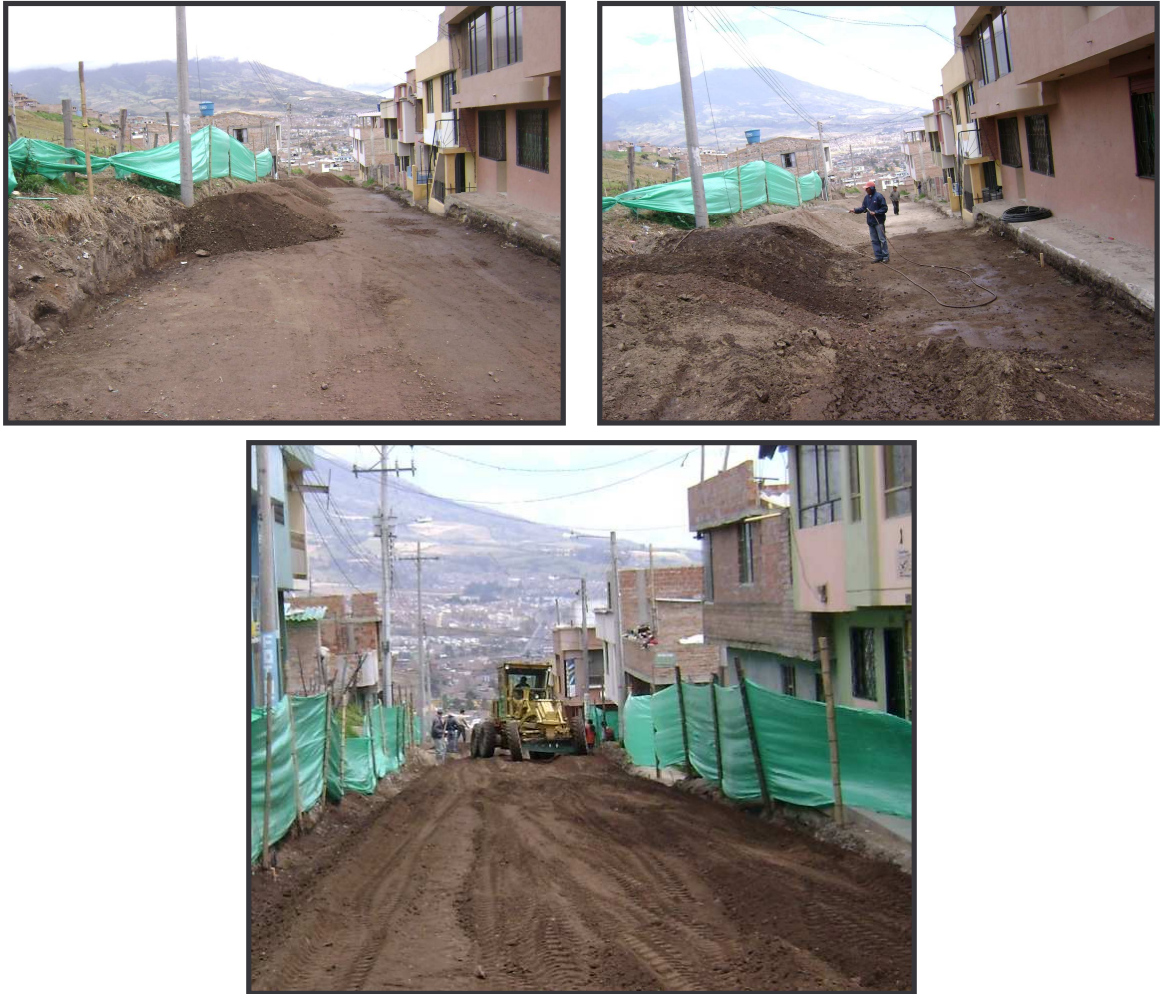
FIGURA 30. Acordonamiento y extendido a máquina de material de base granular.
