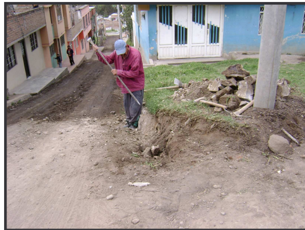
FIGURA 2. Vía alterna para tránsito vehicular mientras se ejecuta la obra.
