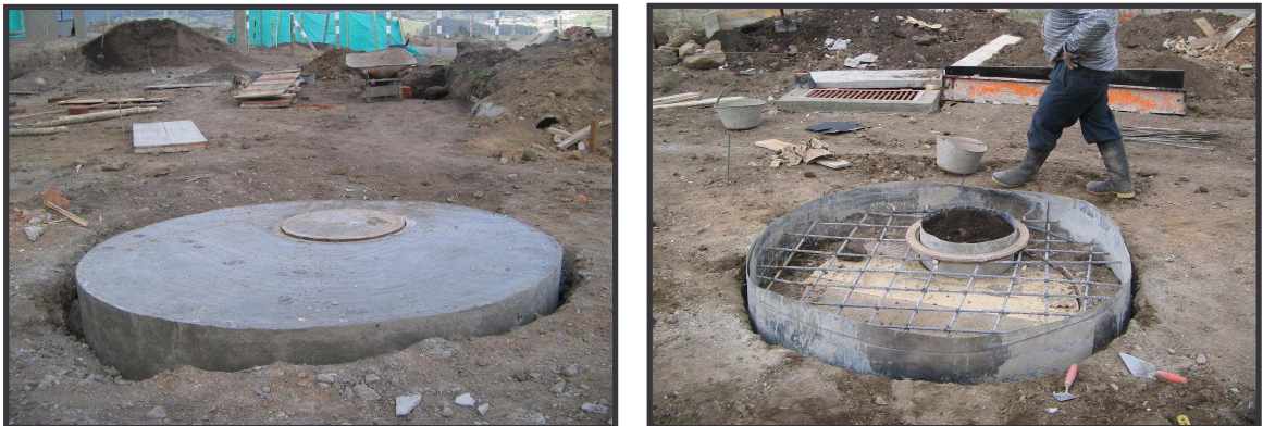
FIGURA 100. Realce de cámaras en la vía 2.
