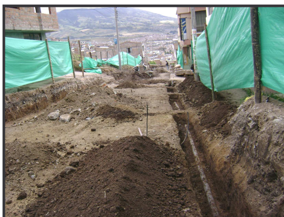
FIGURA 27. Excavación manual para recubrimiento de tubería.
