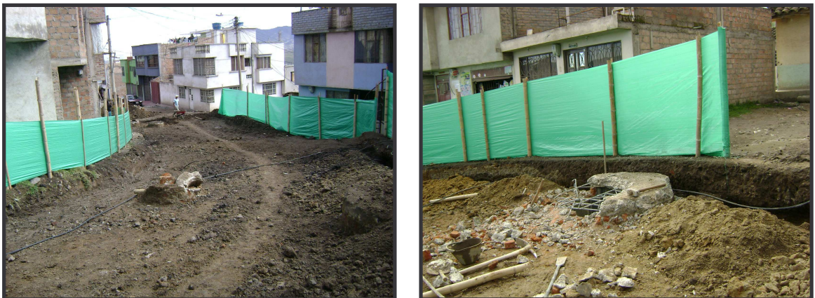
FIGURA 7. Demolición de cámaras, para posterior realce.
