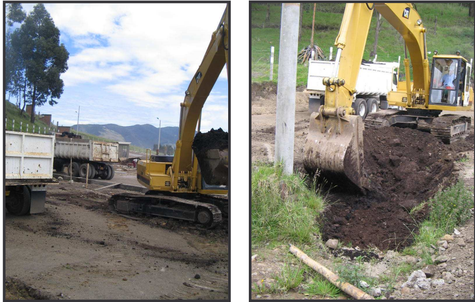
FIGURA 101. Excavación mecánica en parqueadero de la vía 1.
