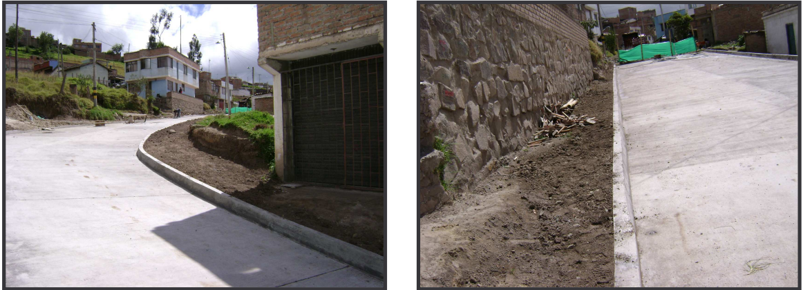
FIGURA 24. Obra terminada. Vía El Rosario - Jamondino.
