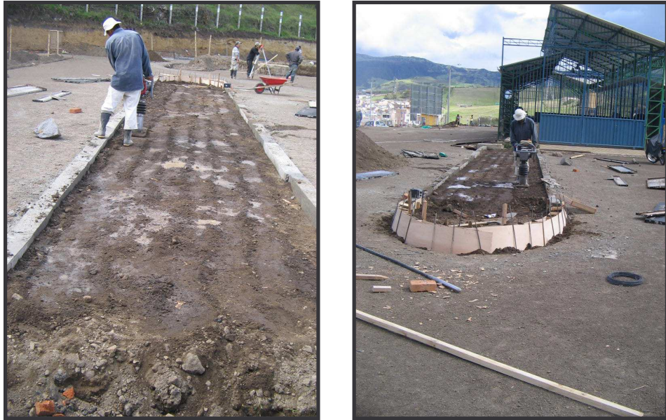
FIGURA 90. Relleno y compactación en separador de vías 2 y 3.
