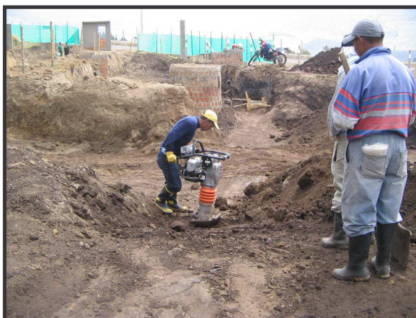
FIGURA 63. Relleno y compactación sobre la tubería de 8” profundizada.
