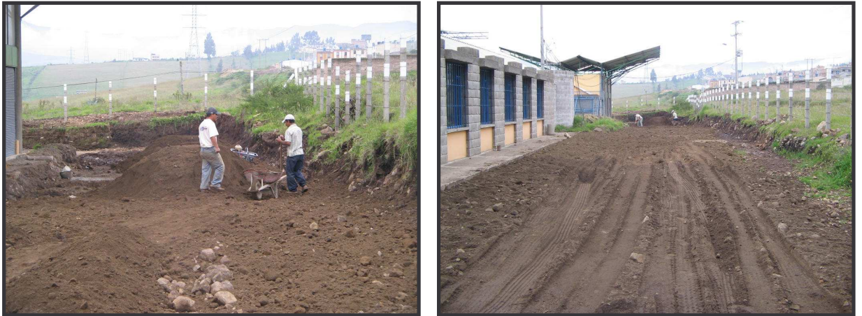
FIGURA 128. Extendido y compactación de recebo para afirmado en vía 1, entre K0+090 y K0+165.
