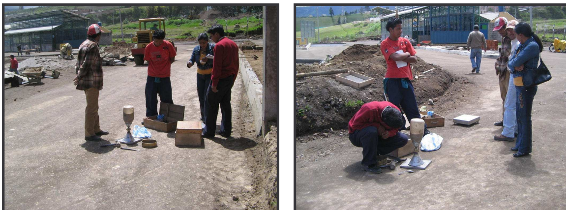
FIGURA 107. Toma de densidades en la vía 1, verificando el buen estado de la capa de base granular.
