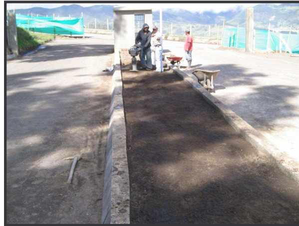
FIGURA 108. Relleno y compactación manual de andén, separador entre vías 1 y 2.
