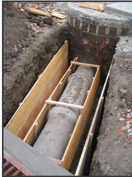
FIGURA 94. Instalación de tubería de conexión entre sumidero en vía 2 y cámara.
