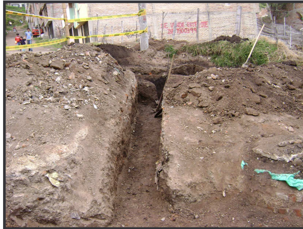
FIGURA 29. Excavación manual para construcción de sumidero y su conexión.
