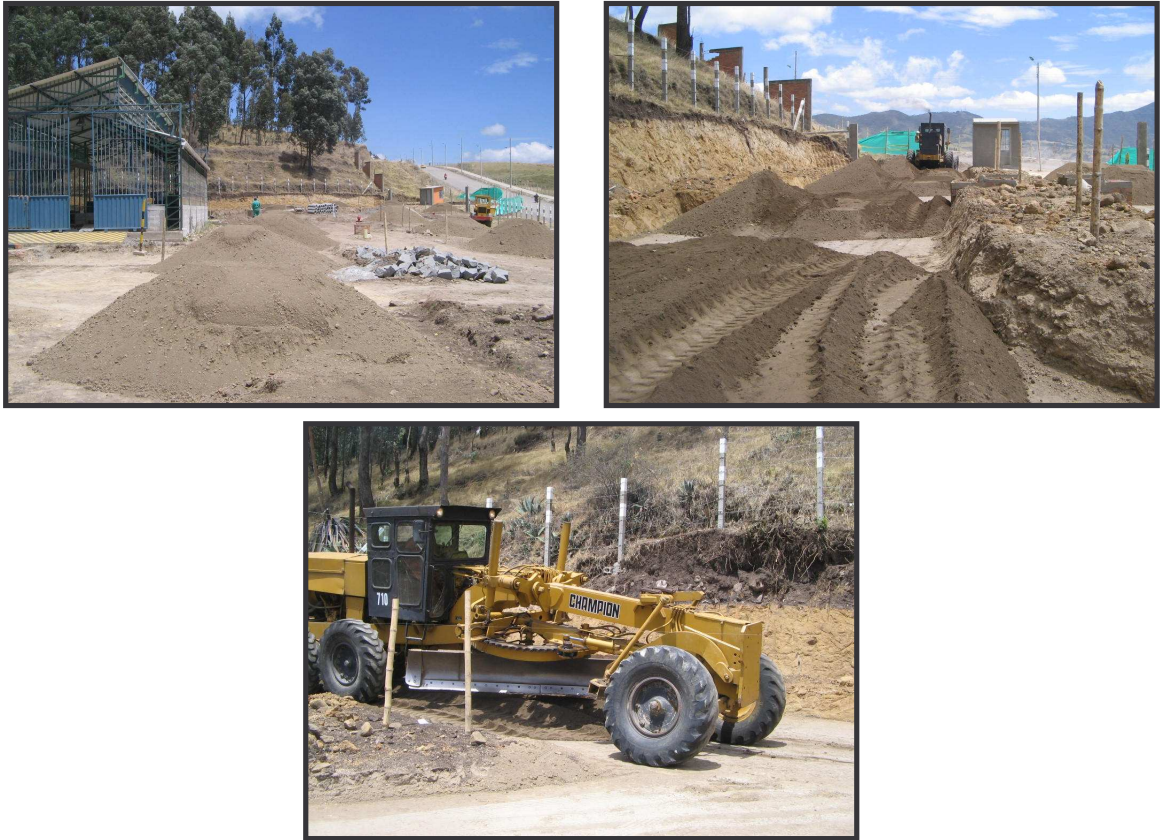
FIGURA 73. Extendido de material de subbase con motoniveladora.
