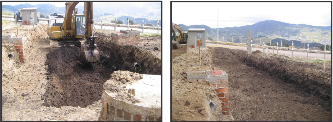
FIGURA 52. Excavación hasta 1,8 m de profundidad, vía 2.
