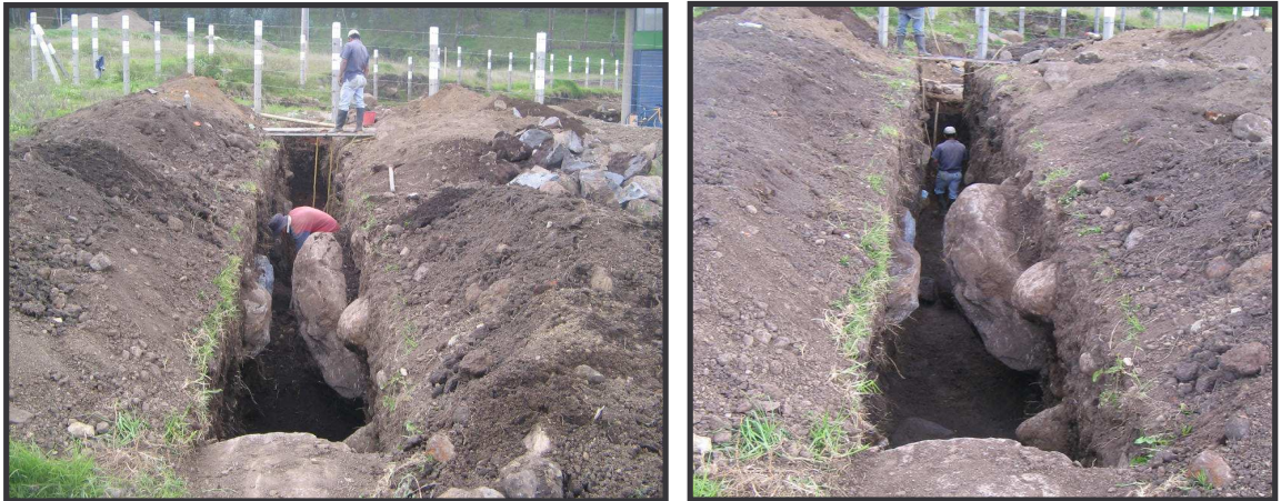
FIGURA 115. Rocas presentes en excavación para empalmar alcantarillado sanitario con cámara externa.
