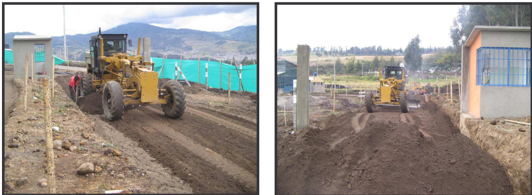
FIGURA 78. Extendido de material de base granular en la vía 2.
