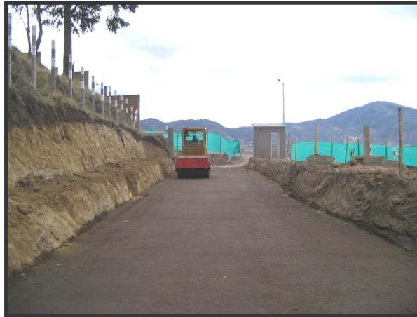
FIGURA 70. Compactación de segunda capa de recebo de mejoramiento en vía 1.
