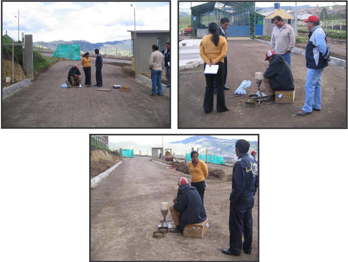
FIGURA 103. Toma de densidades en la base granular, vías 1, 2 y 3.
