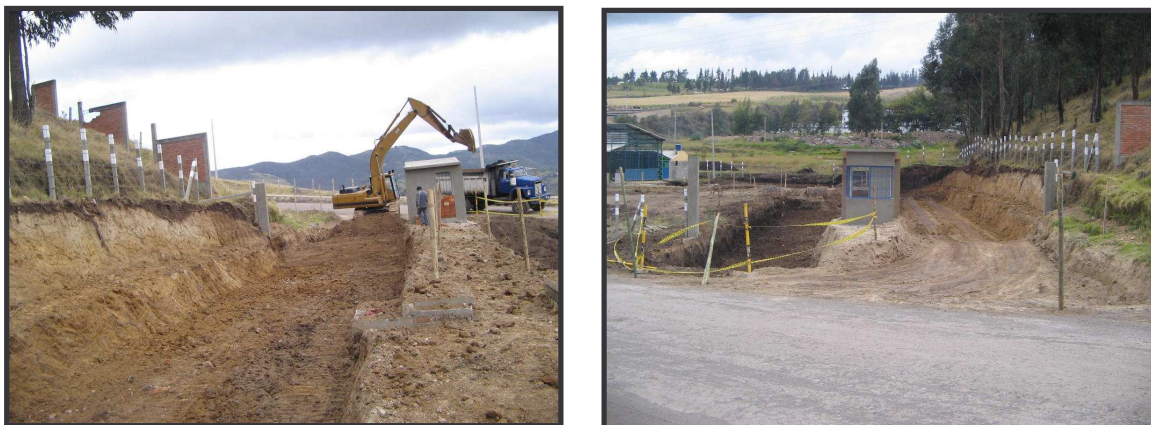
FIGURA 56. Excavación mecánica en vía 1, paralela a la vía 2.
