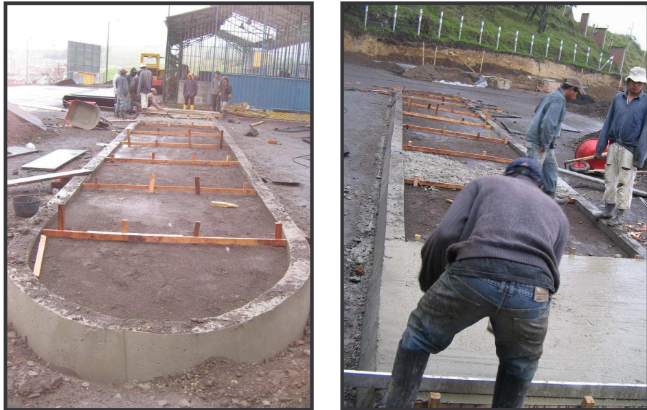
FIGURA 92. Fundición de andén, separador entre vías 2 y 3.
