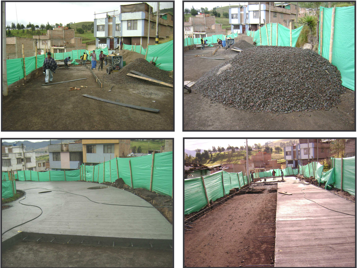
FIGURA 20. Control de calidad de materiales para construcción de pavimento.
