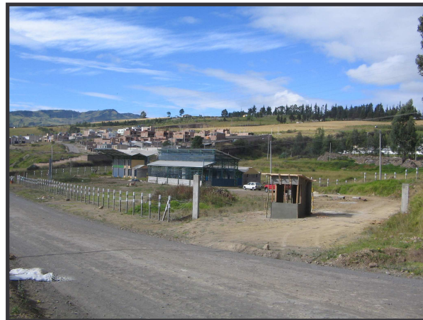
FIGURA 48. Caseta y columnas construidas previas a la ejecución del proyecto.
