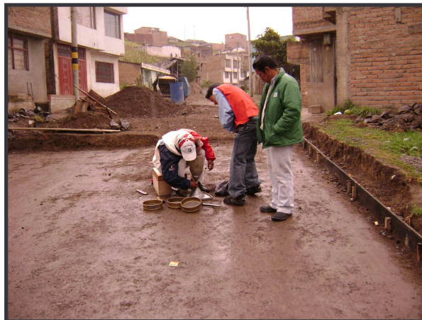
FIGURA 22. Toma de densidades base granular.
