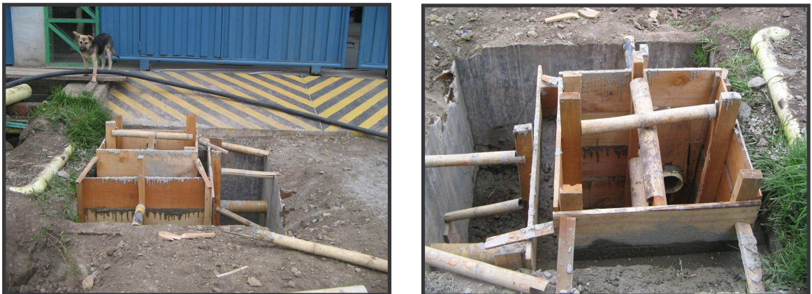
FIGURA 93. Fundición de trampa de grasas.
