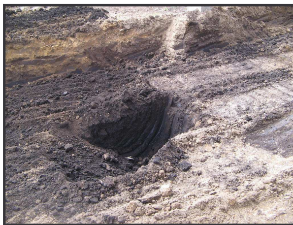
FIGURA 49. Apique hecho con retroexcavadora.
