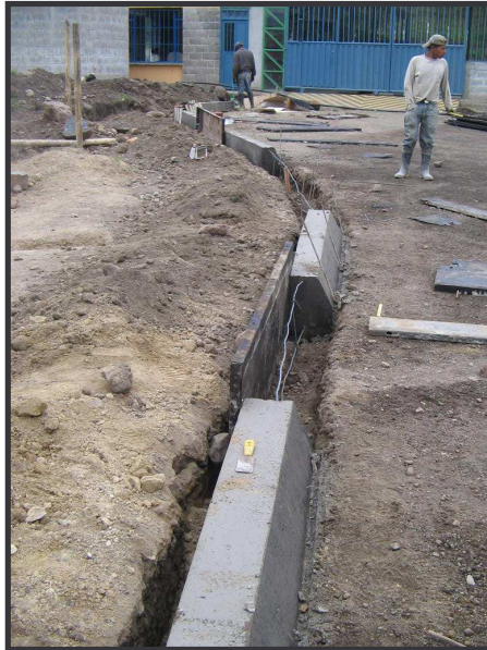
FIGURA 98. Construcción de bordillos en vía 3, lado derecho.
