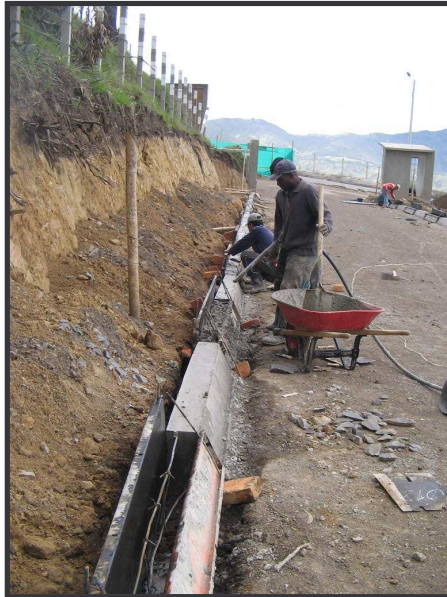
FIGURA 86. Fundición de bordillos, vía 1, lado derecho.
