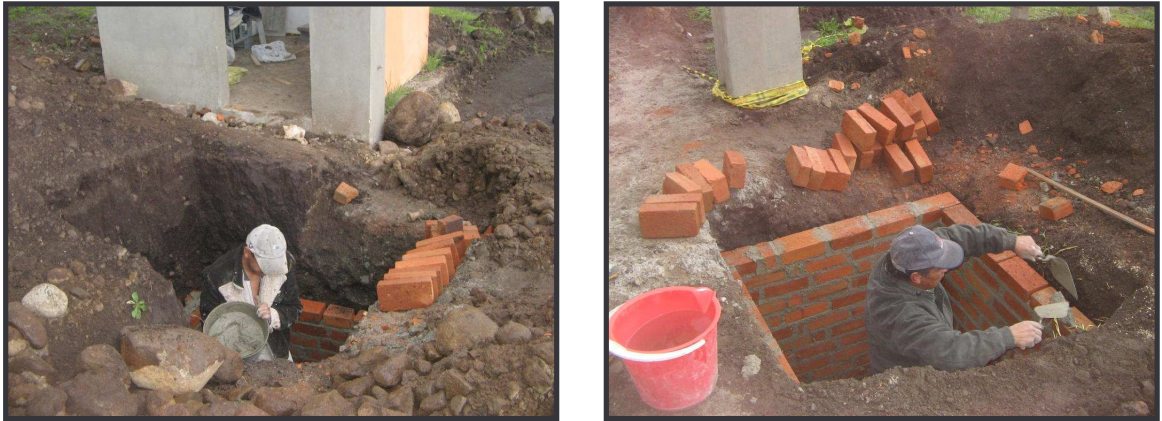
FIGURA 83. Construcción de sumideros vía 1 K0+194.
