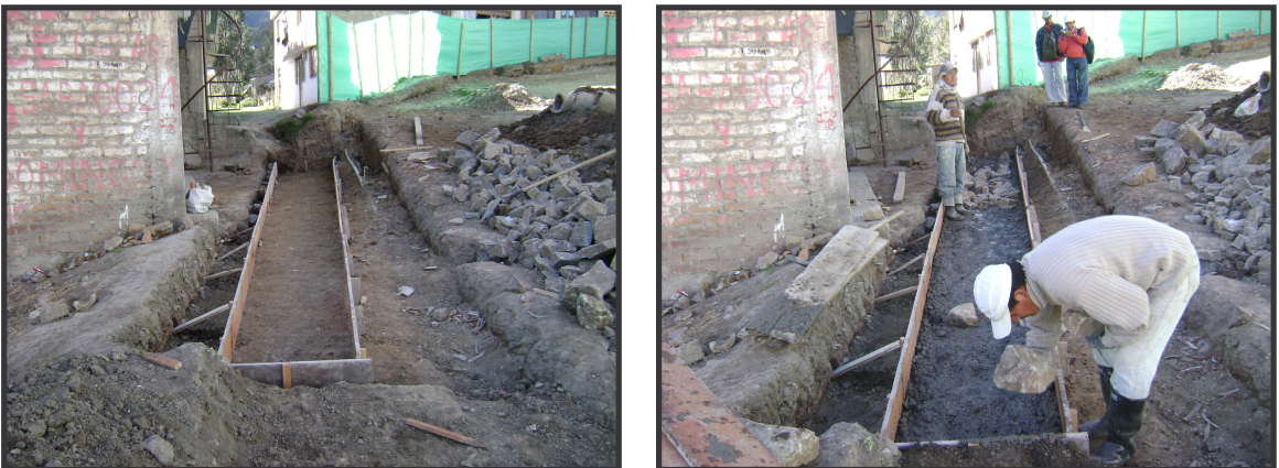
FIGURA 11. Construcción zarpa de muro en concreto ciclópeo.
