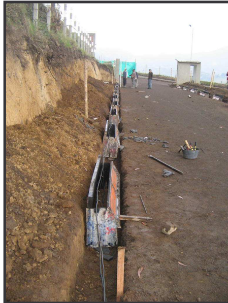
FIGURA 84. Colocación de formaleta metálica para construcción de bordillos en la vía 1, lado derecho.
