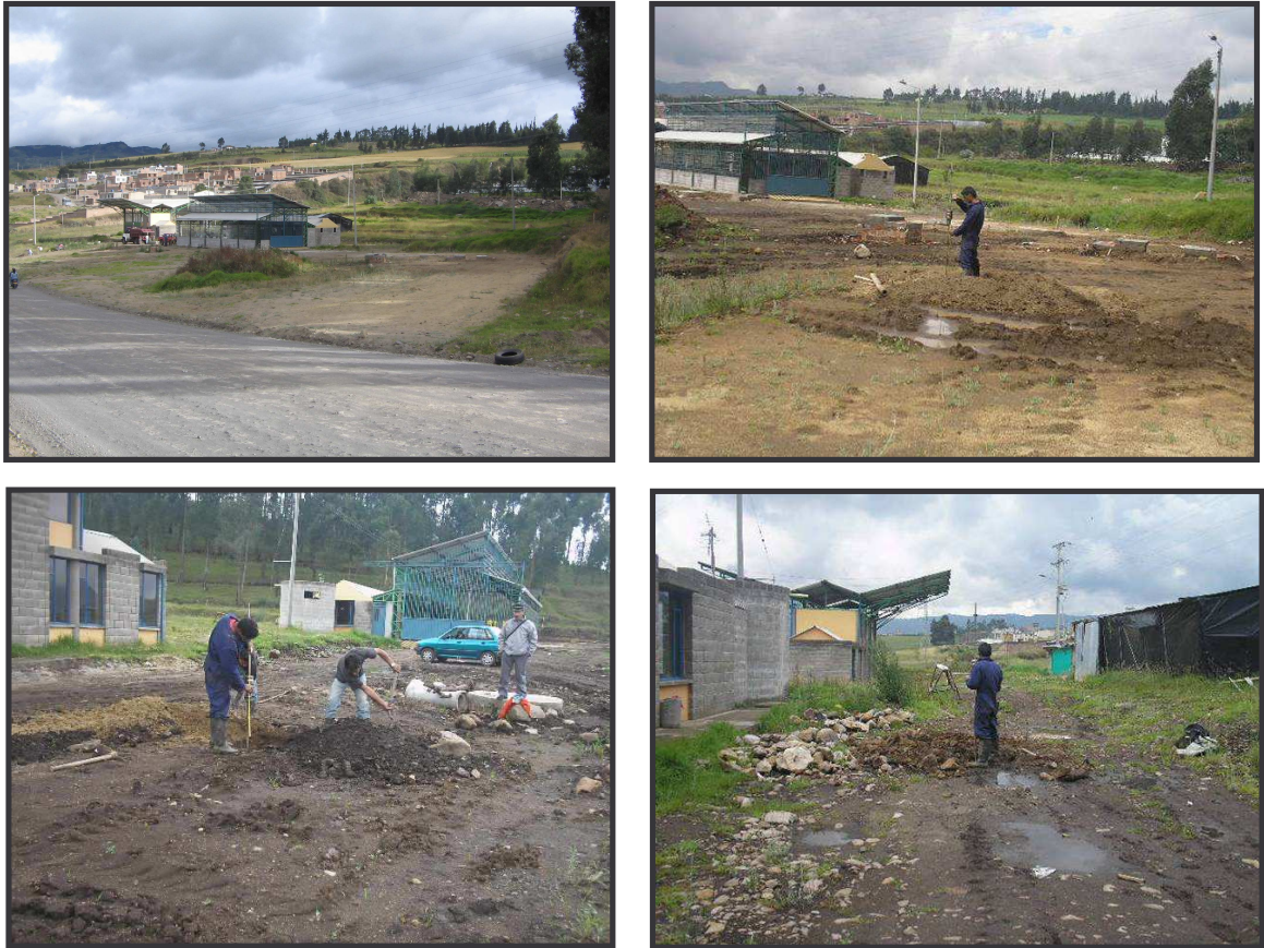
FIGURA 46. Estado inicial de la obra CEDAP.
