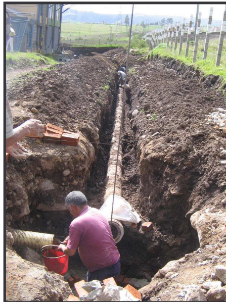
FIGURA 112. Conexión para alcantarillado sanitario en vía 1.
