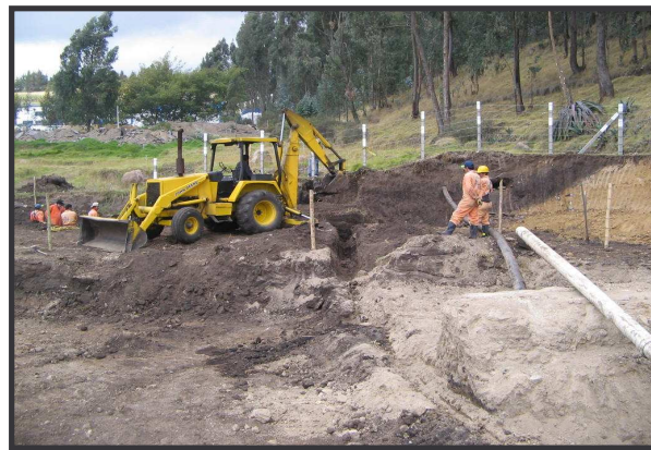
FIGURA 59. Excavación mecánica para profundización de tubería de acueducto de 8".
