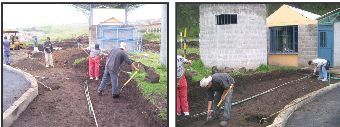
FIGURA 118. Excavación manual para andén en vía 3, entre K0+054 y K0+078.
