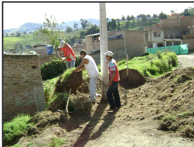
FIGURA 5. Excavación manual para acondicionar paso peatonal.
