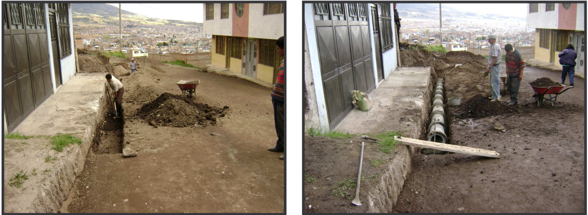
FIGURA 32. Excavación manual para sumidero, cajilla auxiliar y conexión.
