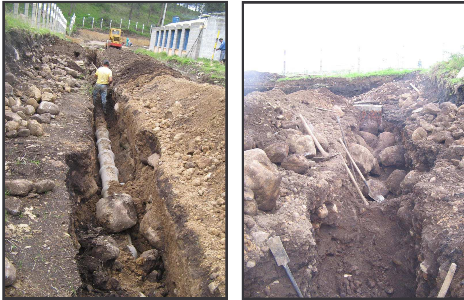
FIGURA 104. Rocas presentes en excavación para alcantarillado sanitario en vía 1.
