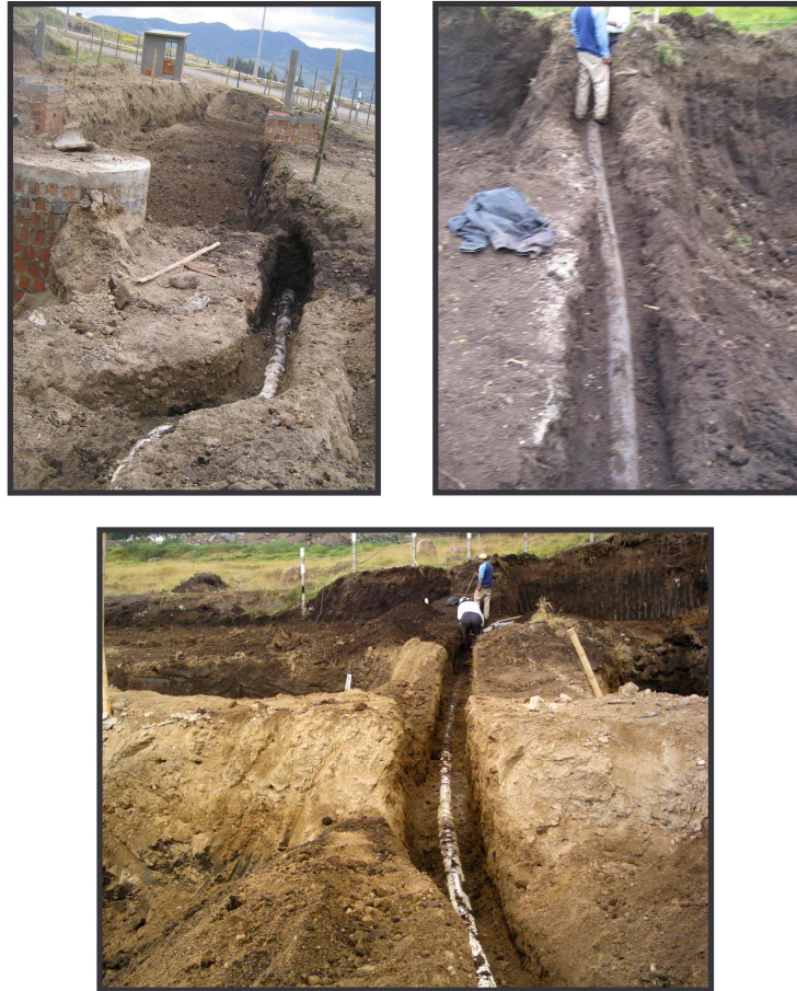
FIGURA 57. Excavación manual para descubrir tubería de acueducto de 8”.
