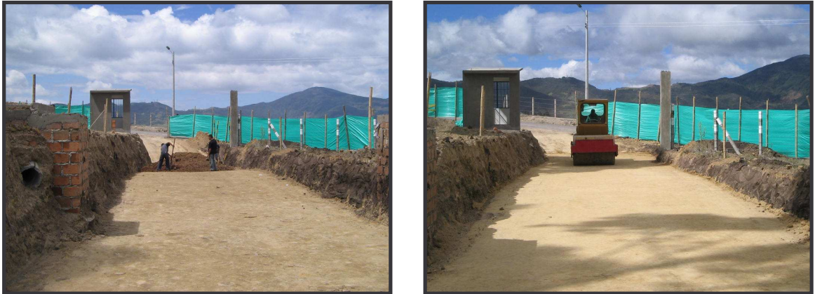
FIGURA 66. Relleno y compactación de arcilla, vía 2.
