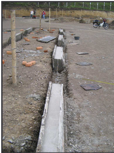
FIGURA 88. Fundición de bordillos en separador de vías 2 y 3.
