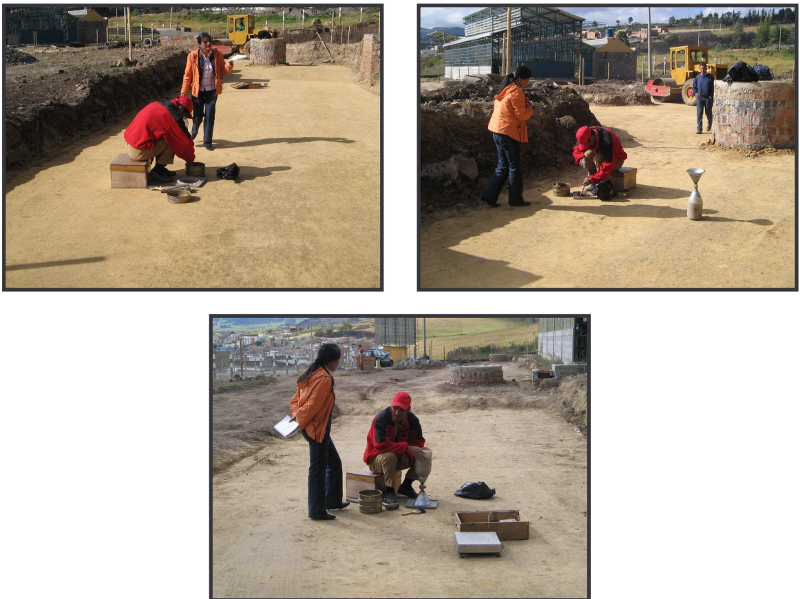
FIGURA 68. Toma de densidades, relleno con tierra amarilla en la vía 2.
