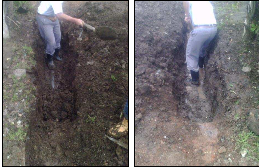
Foto: 94. Excavaciones para revisión de tubería
