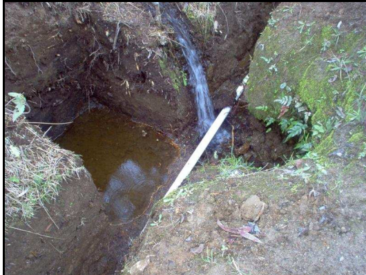
Foto: 82. Excavación para construcción de cajillas de seguridad
