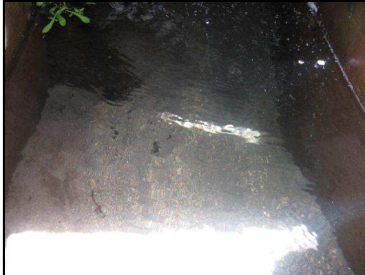
Foto: 32. Interior del desarenador
