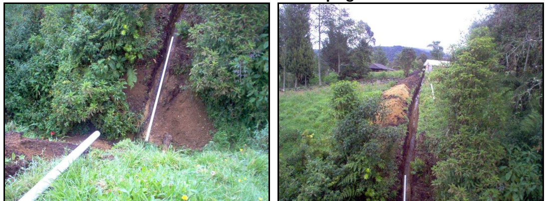
Foto: 79. Tubería enterrada de acuerdo a la topografía del terreno
