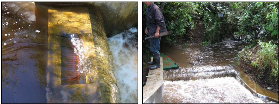
Foto: 9. Captación, bocatoma y detalle de la rejilla
