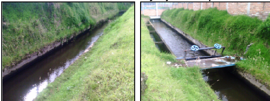
Foto: 40. Entrada al canal de conducción y rejilla de separación
