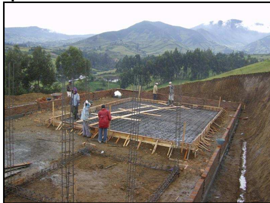
Foto: 53. Preparación para fundición de losa
