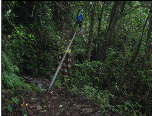
Foto: 5. Paso elevado en tubería
