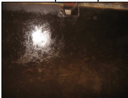
Foto: 43. Ventana comunicante tanque 1 al tanque 2
