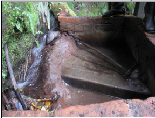
Foto: 29. Bocatoma y salida a San Cayetano en la parte inferior izquierda
