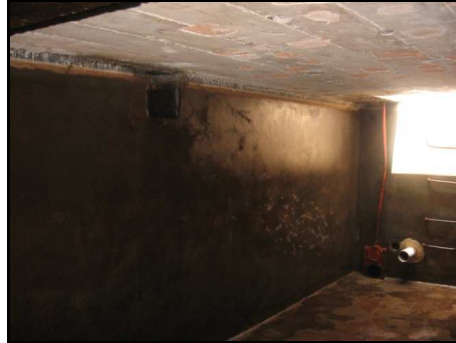
Foto: 45. Detalles del interior del tanque
