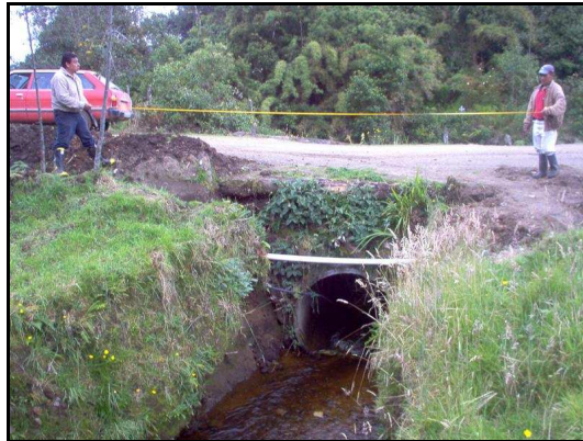
Foto: 81. Medición para construcción de viaductos
