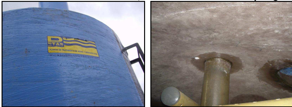
Foto: 56. Detalle del interior del filtro, tubería de distribución por gravedad
