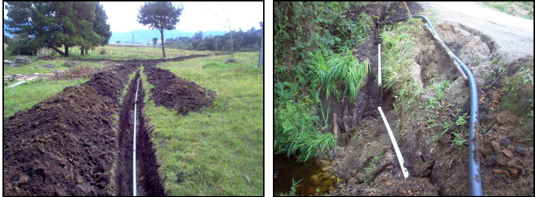
Foto: 80. Proceso de instalación de tubería
