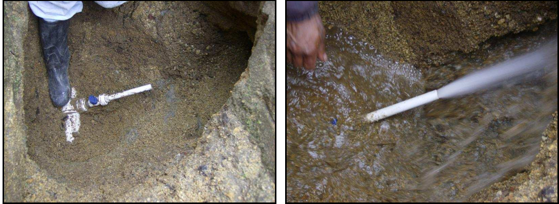
Foto: 85. Ensayo de válvula purga
