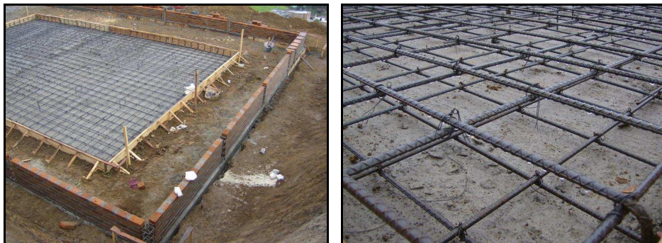
Foto: 51. Detalle de la losa del sistema de tratamiento
