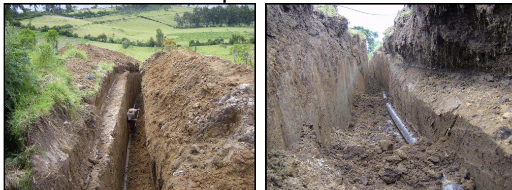
Foto: 96. Excavación manual complementaria
