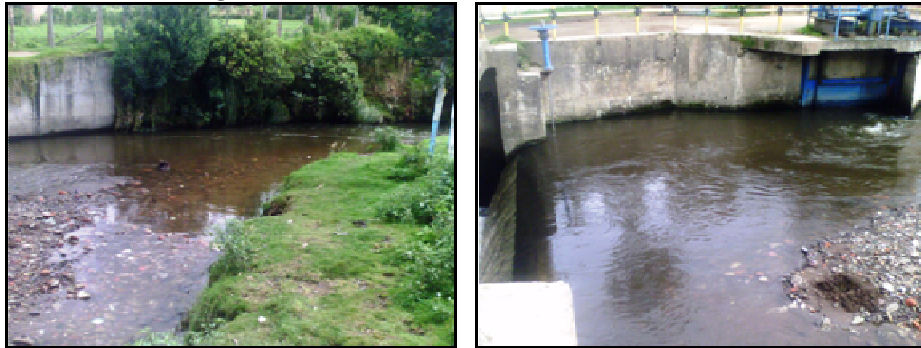
Foto: 38. Entrada de aguas vertidas al canal de conducción existente
