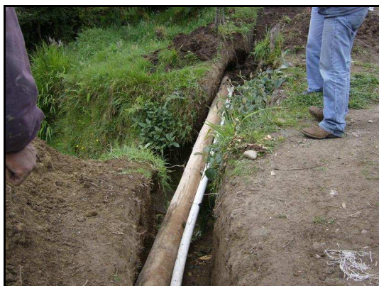
Foto: 83. Viaductos en madera rolliza
