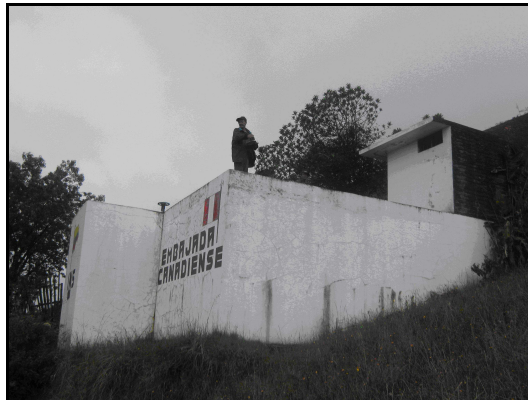
Foto: 6. Tanque de almacenamiento
