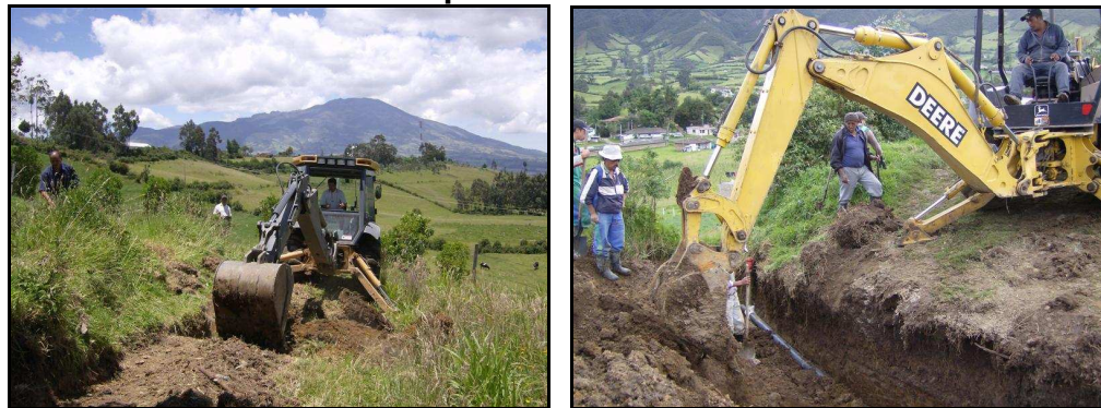
Foto: 95. Excavación mecánica para revisión de tubería
