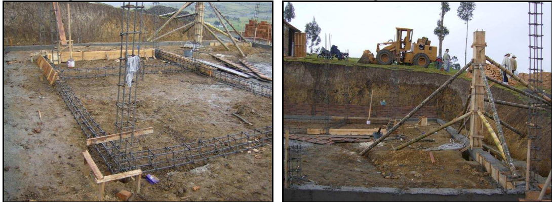
Foto: 52. Figurado, formaletas y fundición de las vigas de cimentación
