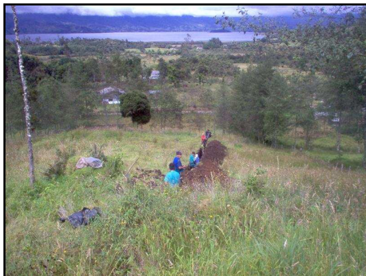
Foto: 77. Actividades de excavación iniciales
