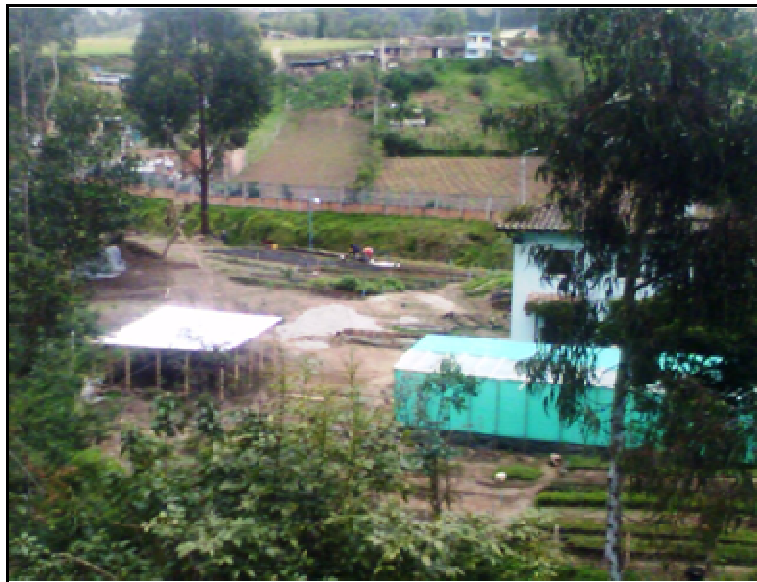
Foto: 36. Lote de la PTAR
