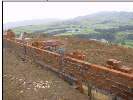
Foto: 50. Construcción de muros perimetrales
