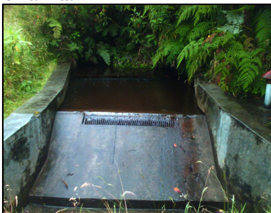
Foto: 19. Bocatoma Toma Alta
