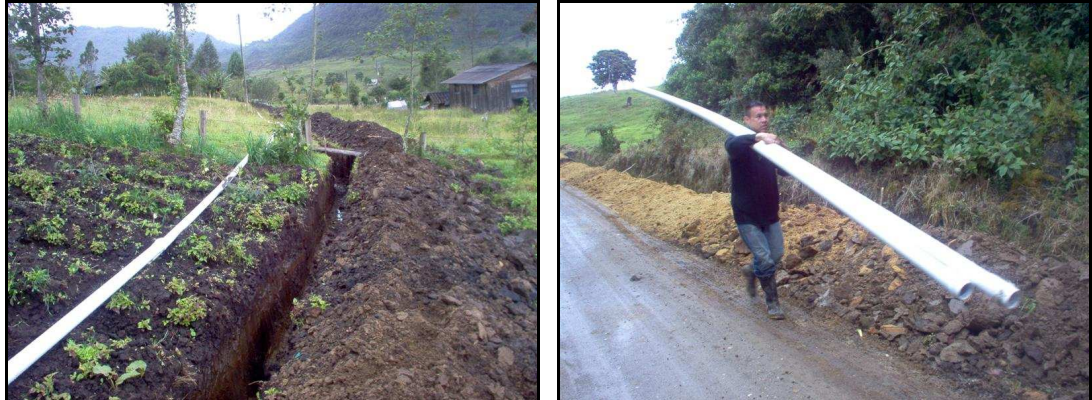
Foto: 78. Tubería transportada al lugar de trabajo
