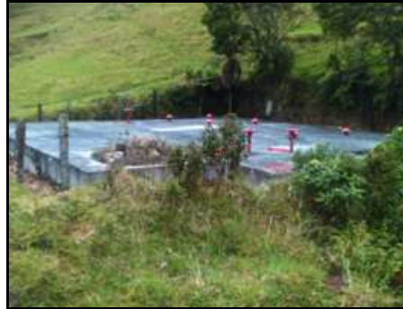
Foto: 42. Tanques de almacenamiento existentes
