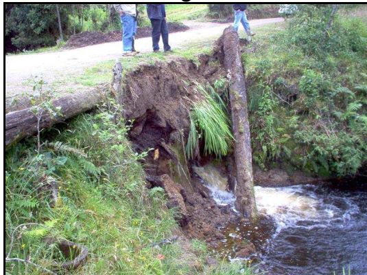
Foto: 76. Pasos obligados de la tubería nueva
