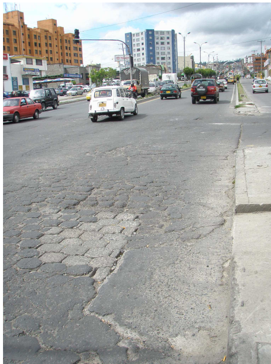
Figura 14. Ubicación del parche en la calle 16 (sobre la Panamericana).
