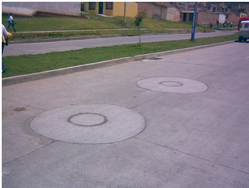
Figura 23. Conteo cámaras de inspección y sumideros.
