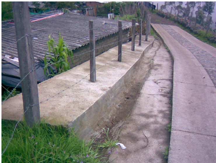
Figura 32. Corona repellada del muro en gaviones.
