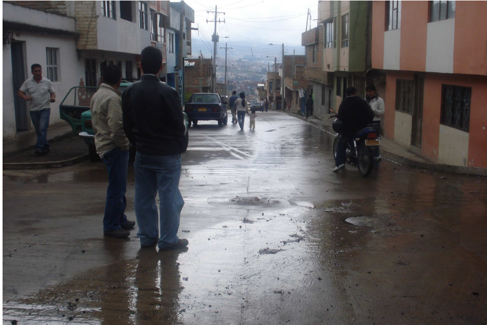
Figura 42. Vista general de la vía pavimentada.
