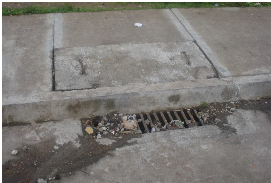
Figura 29. Sumidero convencional construido por el proyecto.
