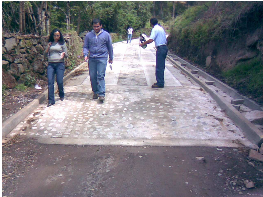
Figura 17. Rampa en pedraplen de acceso a la placa huella.
