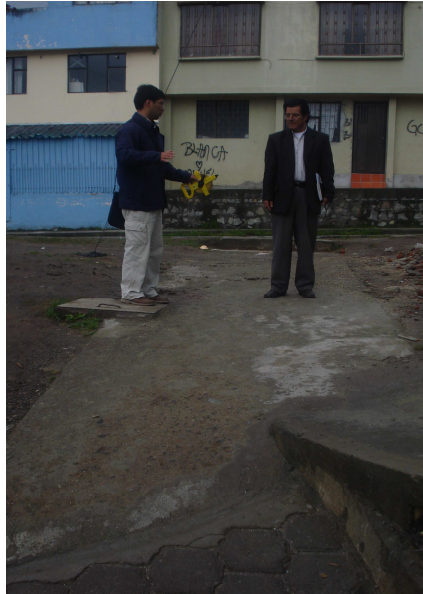
Figura 50. Detalle anden en concreto rígido.
