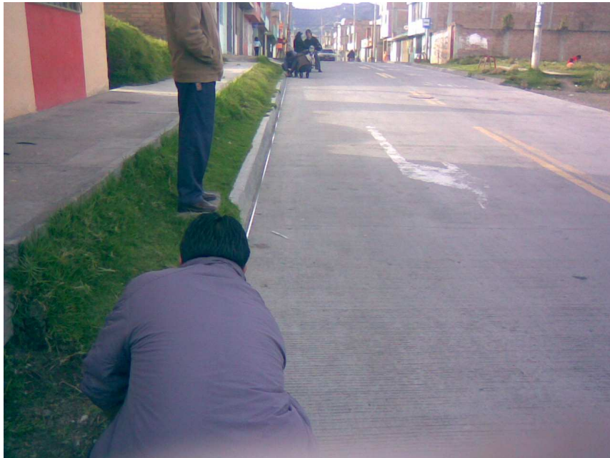
Figura 18. Inspección y medición placa de pavimento.
