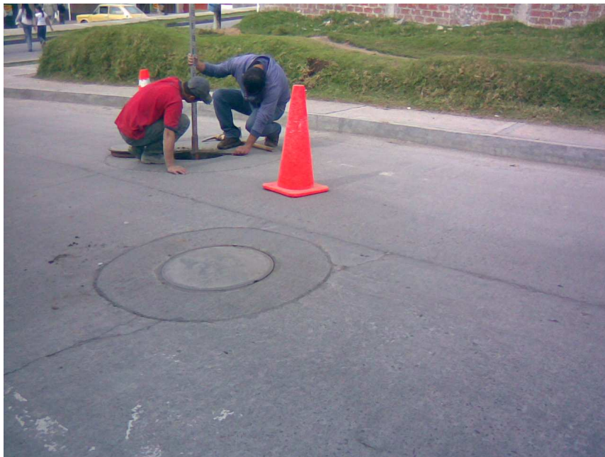
Figura 19. Inspección y medición de cámaras red sanitaria.
