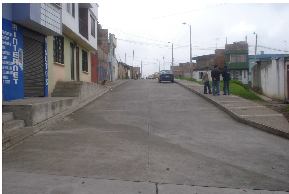
Figura 28. Vista general de la vía pavimentada.
