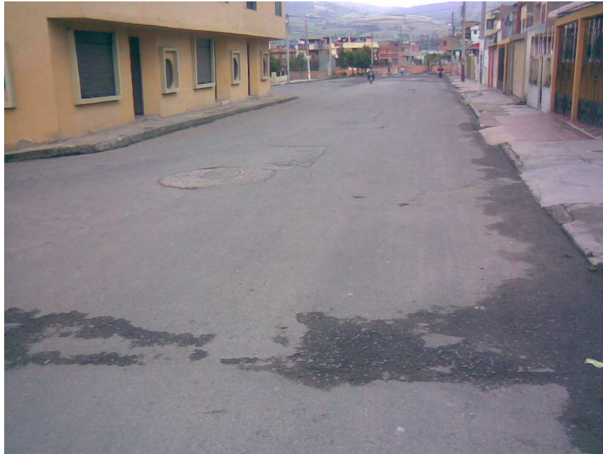
Figura 35. Vista general del parche N° 1.
