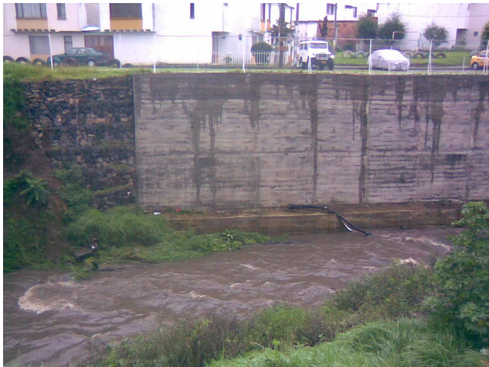
Figura 41. Muro de Contención construido por urgencia manifiesta.
