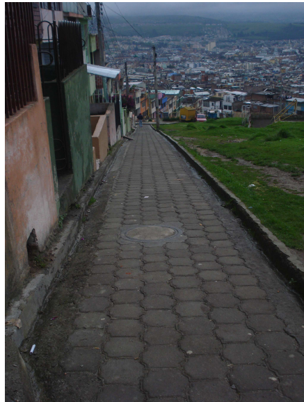
Figura 48. Vista pavimento en adoquín manzana C del Barrio Panorámico.
