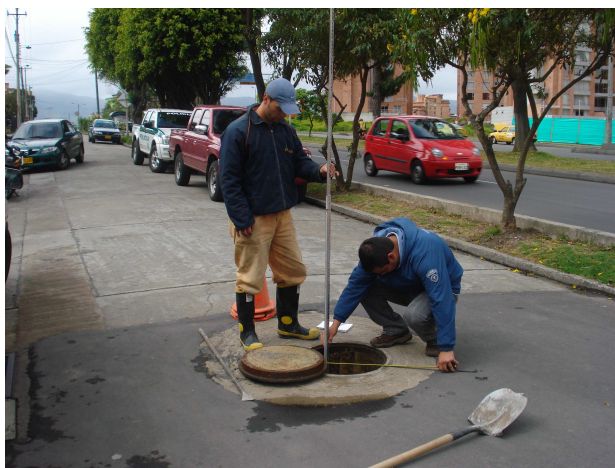
Figura 3. Medición cámara de inspección.
