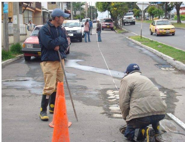
Figura 2. Medición entre cámara de inspección y empalme.
