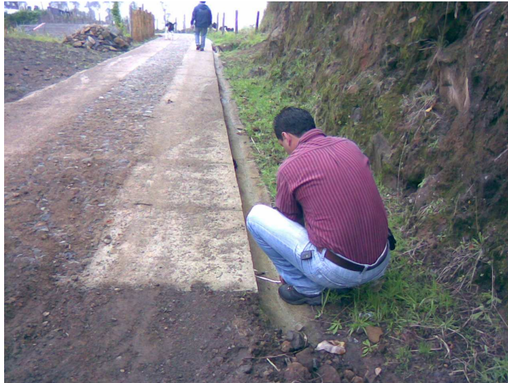
Figura 31. Medición primer tramo de la placa huella.
