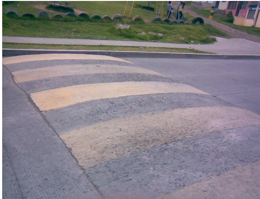
Figura 25. Resalto ubicado en San Albano fase II.
