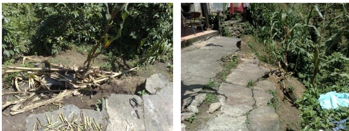
Figuras 38 Y 39. Deslizamientos frente a una vivienda.
