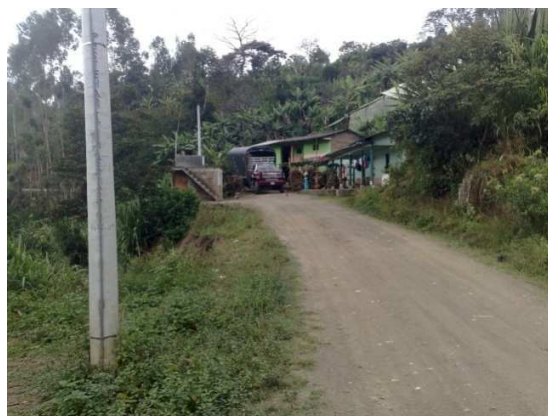
Figura 12. Vivienda en riesgo.
