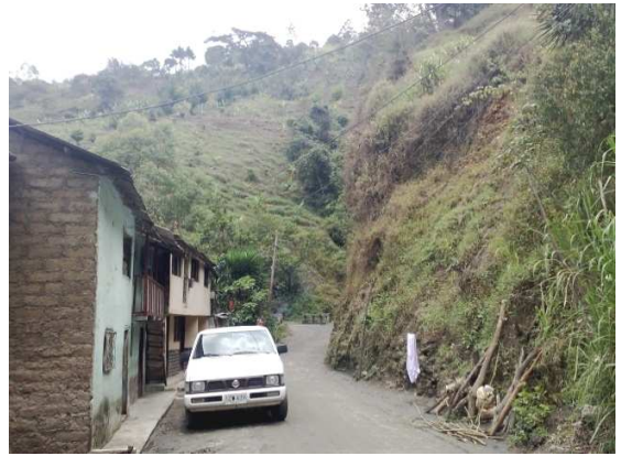
Figura 3. Amenaza por talud
