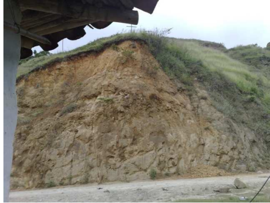
Figura 35. Talud en la vía.
