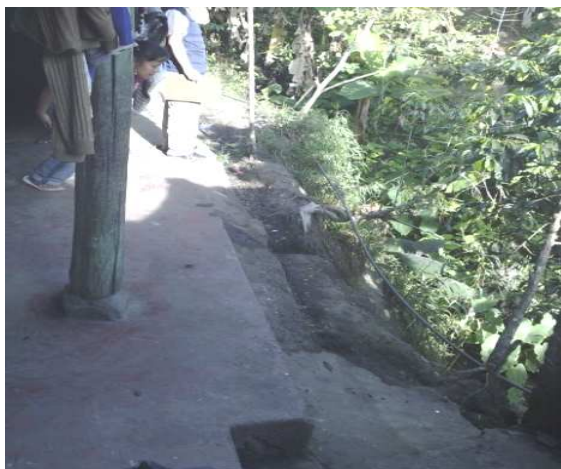
Figura 20. Vivienda construida junto al cauce de una quebrada.
