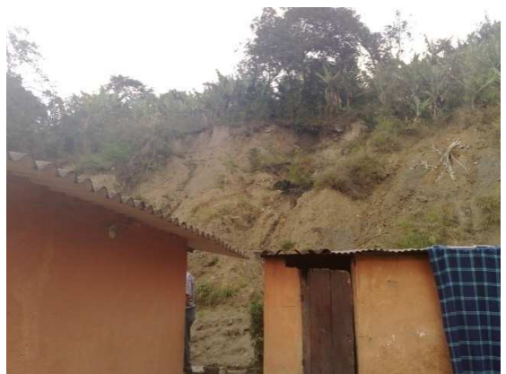
Figura 5. Talud al frente
