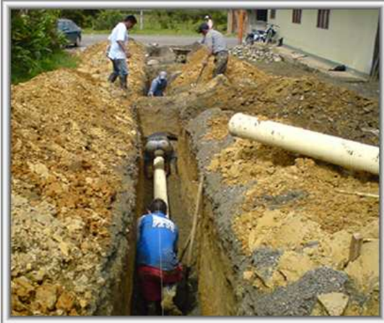
Foto 47. Instalación de tubería pvc 8"
