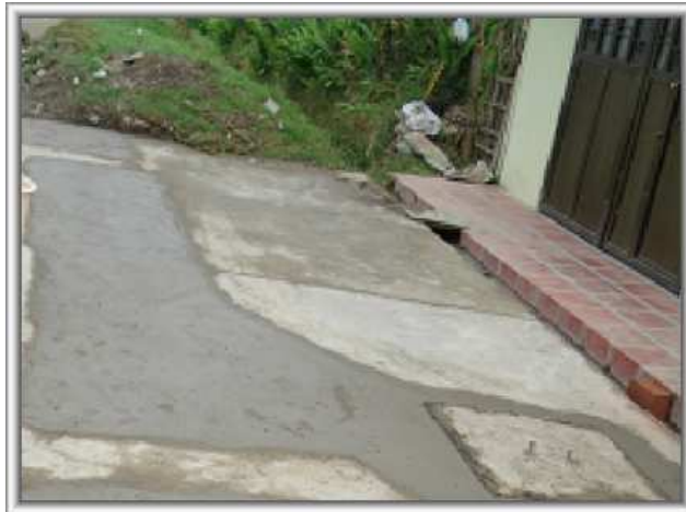
Foto 30. Reposición placa de concreto
