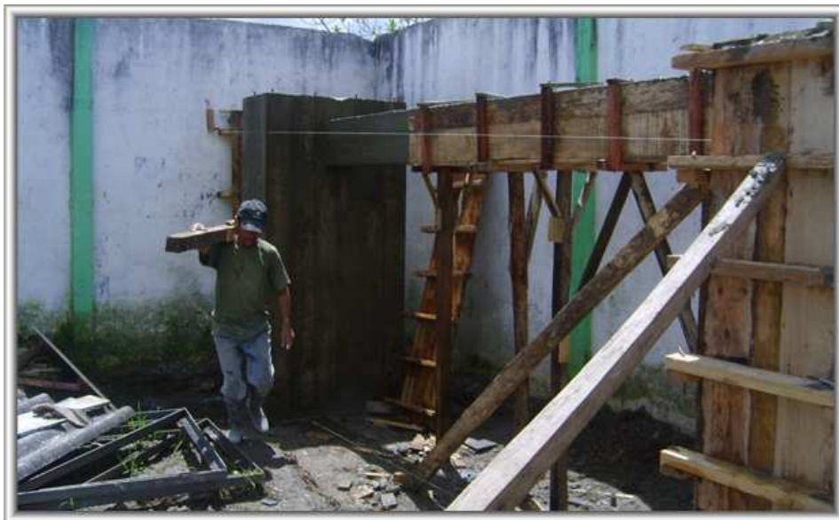
Foto 8. Construcción de pedestales
