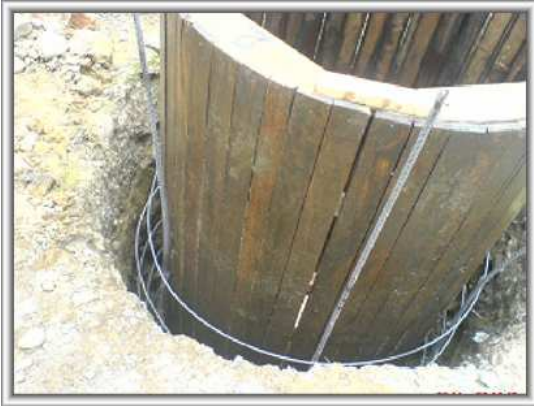
Foto 28. Construcción cámara de inspección
