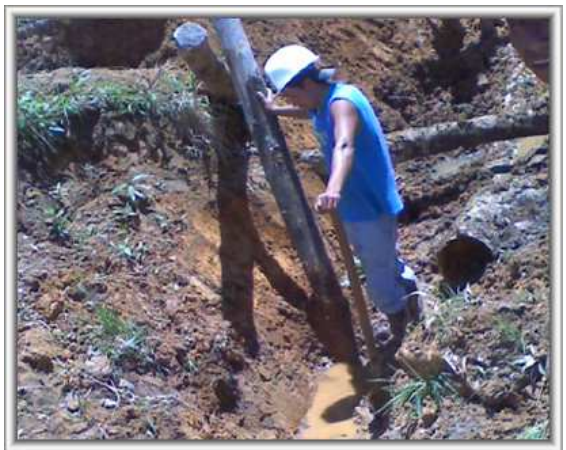
Foto 38. Excavación manual para muro de contención
