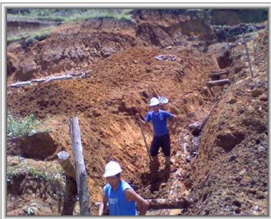
Foto 37. Excavación manual en material común
