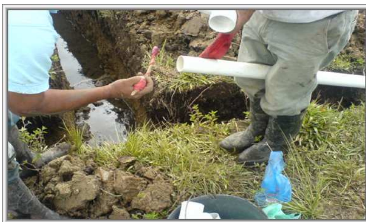
Foto 72. Suministro e Instalación codos gran radio
