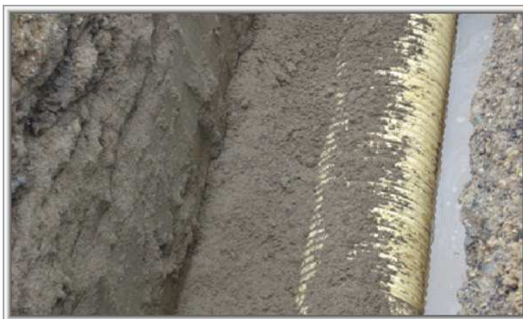
Foto 24. Encamado de la tubería
