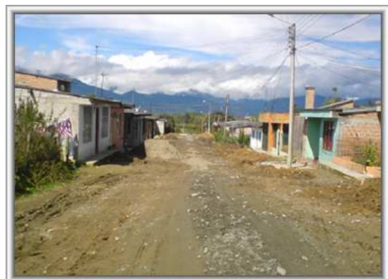
Foto 50. Relleno y compactación material de río
