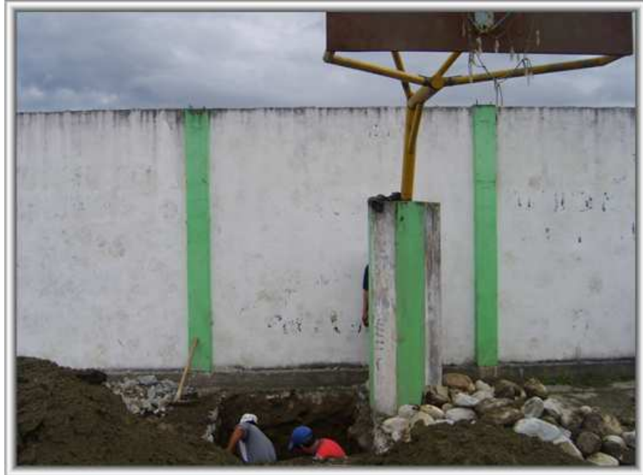
Foto 3. Excavación manual para cimientos
