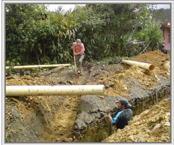
Foto 48. Excavación manual para acometida
