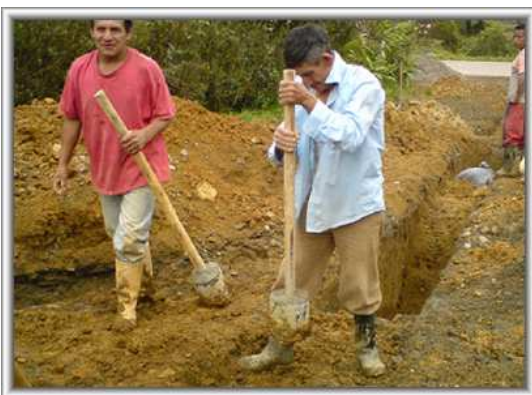
Foto 49. Relleno y compactación
