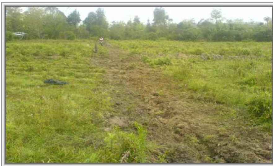
Foto 63. Relleno y compactación
