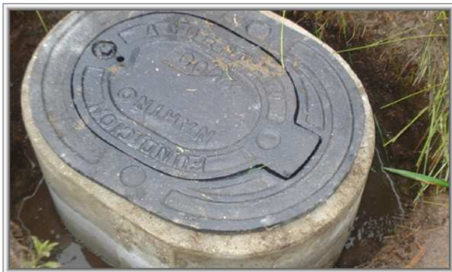
Foto 77. Suministro e Instalación tapa cajilla
