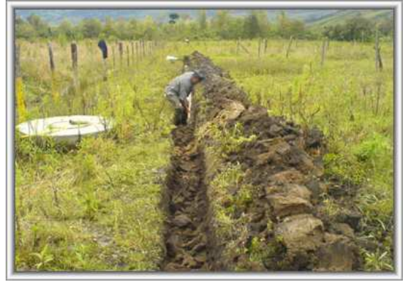
Foto 61. Excavación manual en material común
