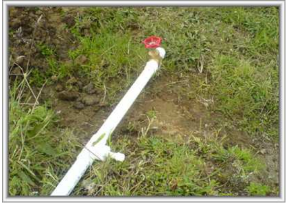
Foto 68. Suministro e Instalación válvula de compuerta 2"
