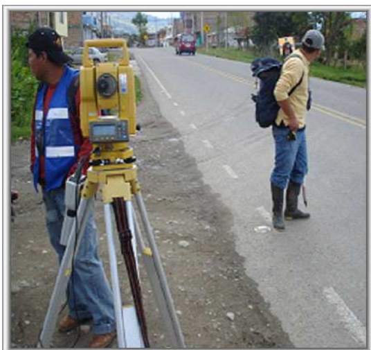
Foto 17. Localización Y Replanteo
