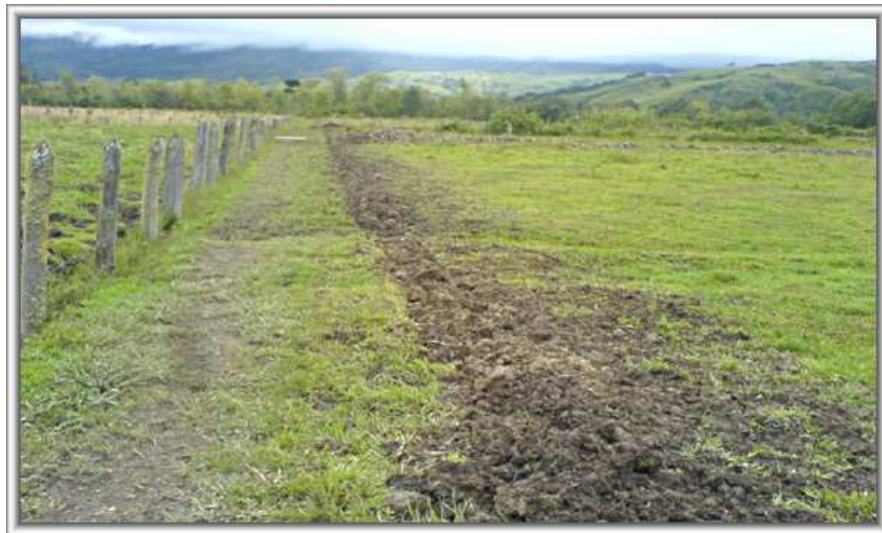
Foto 62. Relleno y compactación
