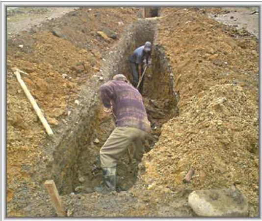
Foto 45. Excavación manual en material común
