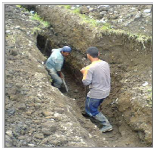
Foto 20. Excavación manual en material común
