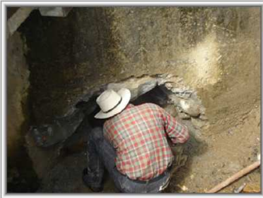
Foto 31. Demolición de aleta en concreto
