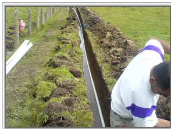
Foto 65. Instalación de tubería pvc pavco 2" rde 21
