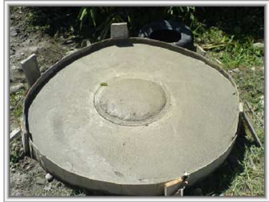
Foto 29. Construcción tapa cámara de inspección
