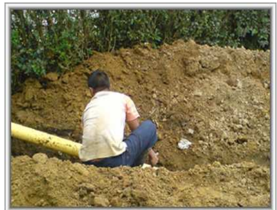
Foto 56. Instalación de acometida domiciliaria
