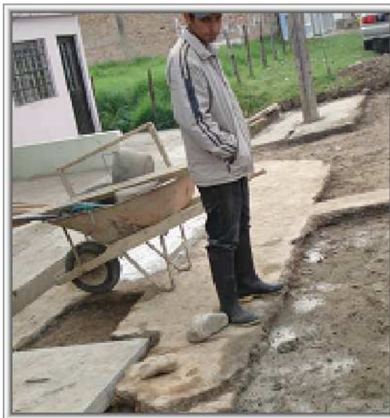
Foto 22. Demolición de placa existente
