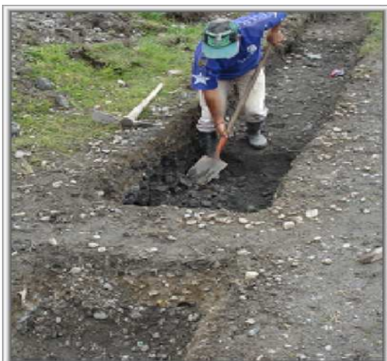
Foto 19. Excavación manual en conglomerado
