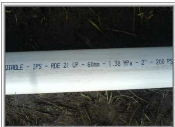
Foto 64. Suministro tubería pvc pavco 2" rde 21
