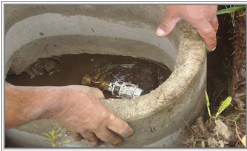
Foto 76. Suministro e Instalación acometida domiciliaria ½”
