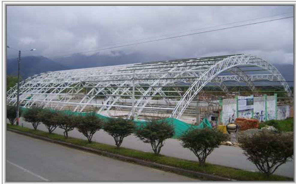
Foto 16. Terminación estructura metálica para cubierta
