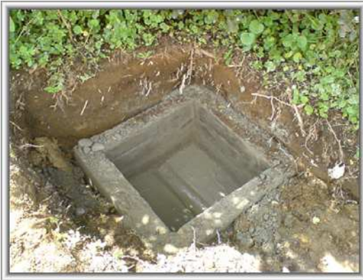
Foto 53. Construcción cajillas de inspección
