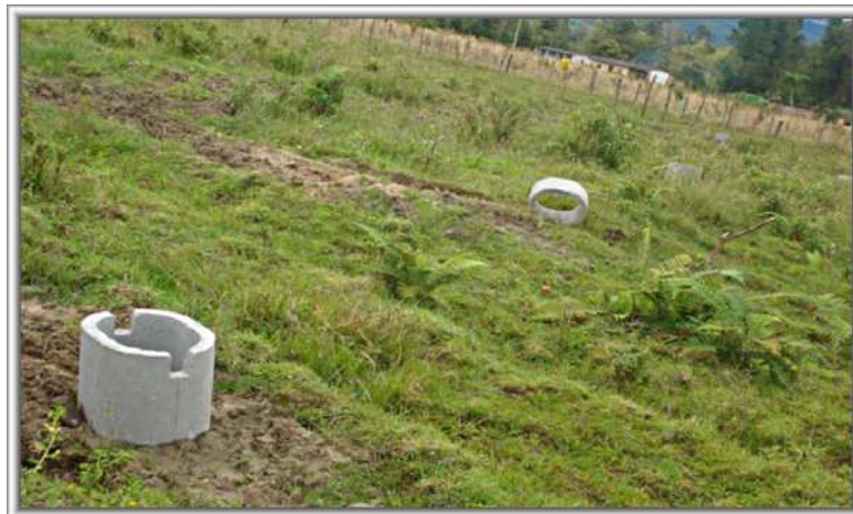
Foto 75. Relleno compacto del sitio de la obra
