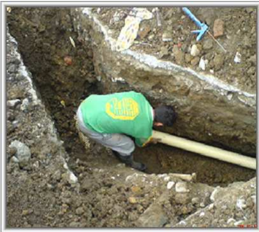
Foto 26. Instalación de acometida domiciliaria
