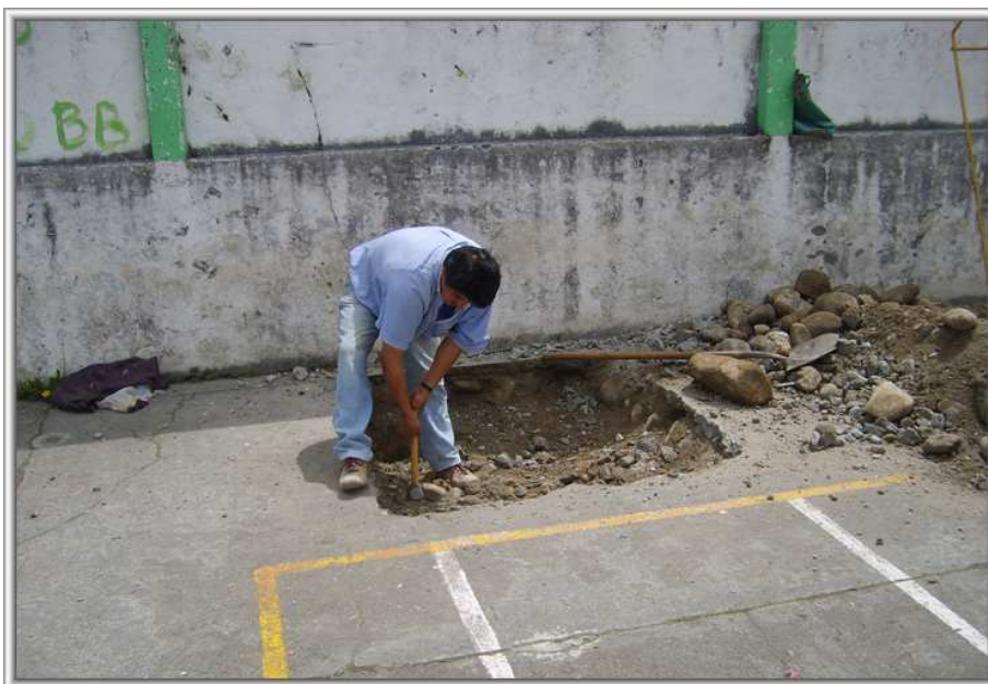
Foto 2. Demolición de placa existente
