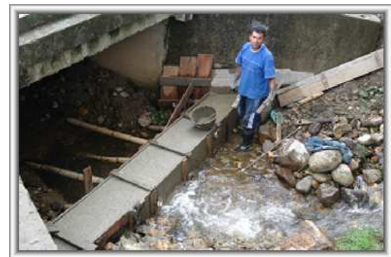
Foto 34. Construcción viga de recubrimiento
