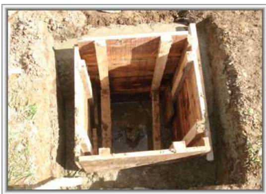
Foto 70. Formaleta cajillas para válvulas
