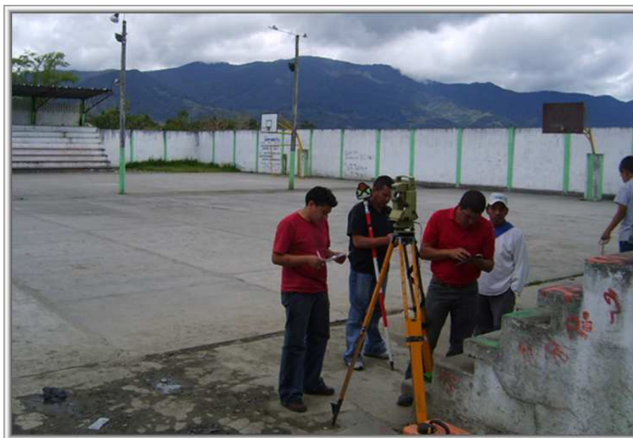
Foto 1. Localización Y Replanteo
