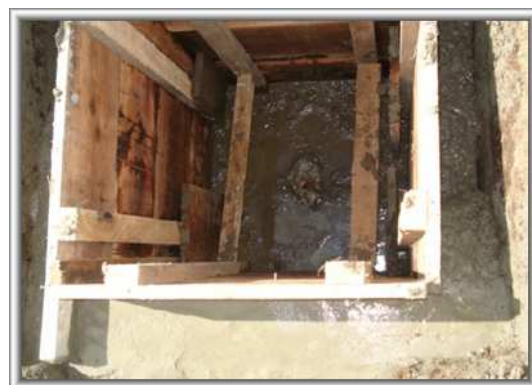
Foto 71. Construcción cajillas para válvulas
