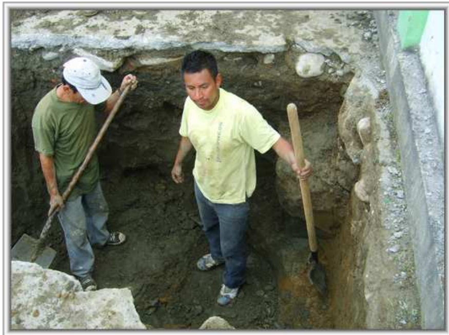
Foto 4. Excavación manual para cimientos
