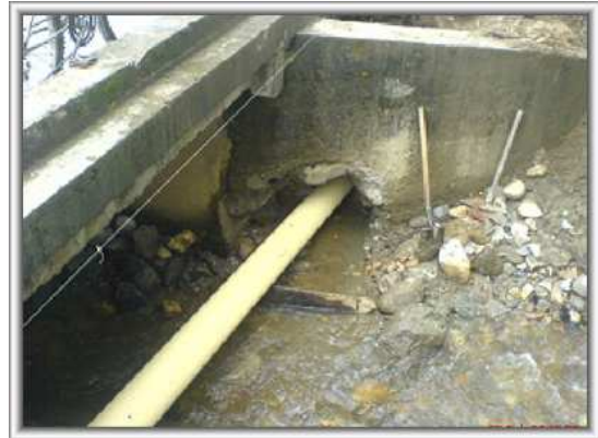
Foto 32. Paso de la tubería por estructura existente
