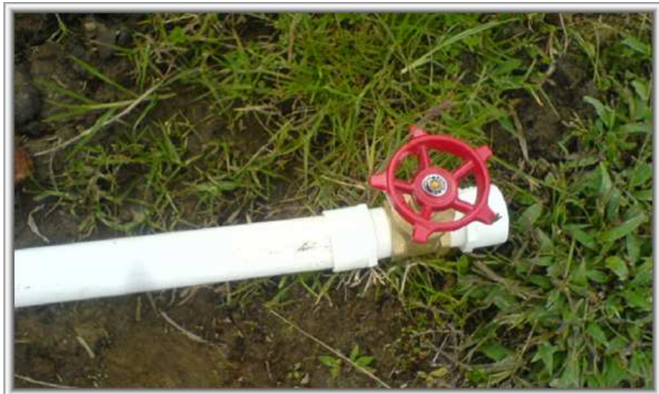
Foto 69. Suministro e Instalación válvula de compuerta 1.5"
