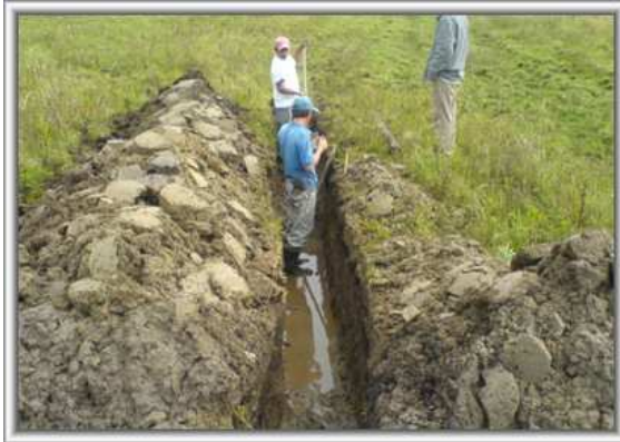
Foto 60. Excavación manual en material común
