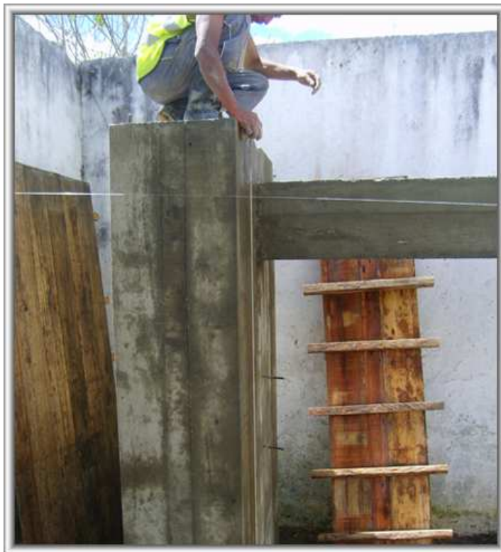
Foto 9. Construcción de pedestales
