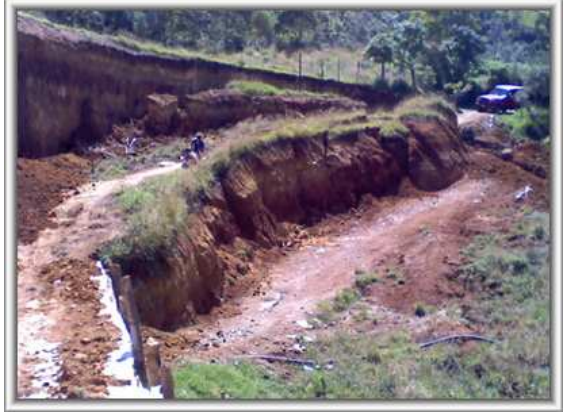
Foto 36. Localización y replanteo del terreno
