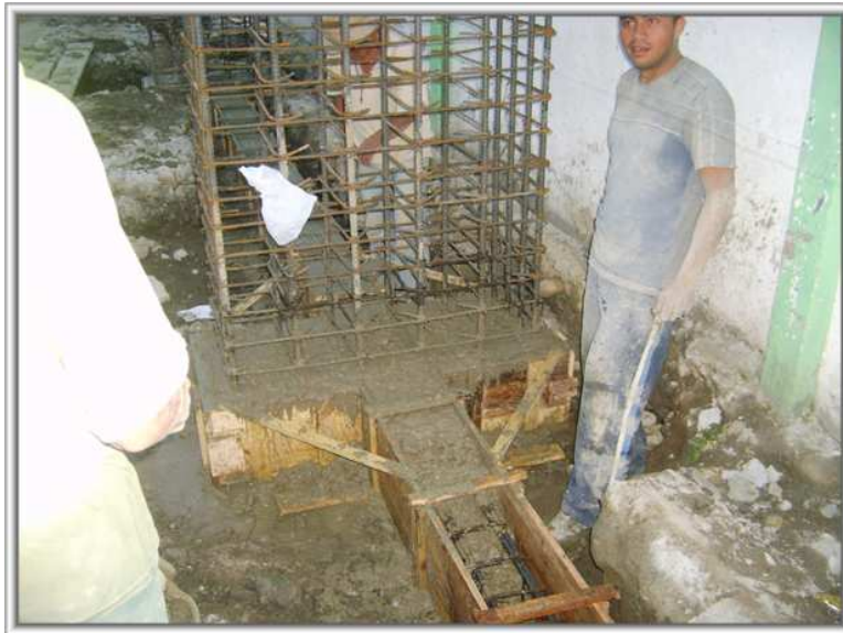
Foto 5. Construcción viga de cimentación
