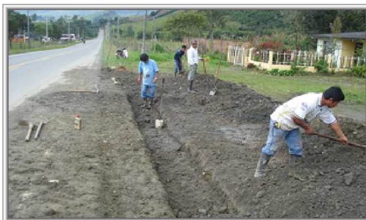
Foto 25. Relleno y compactación
