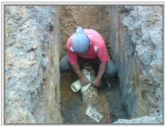
Foto 57. Instalación de silla yee 8" * 4"
