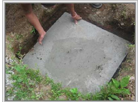
Foto 54. Construcción tapas para cajillas de inspección
