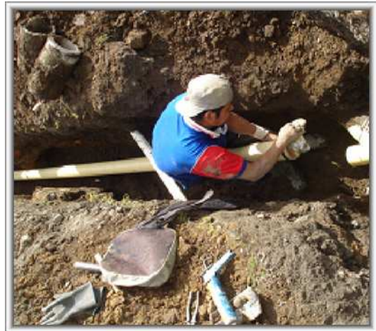
Foto 27. Instalación de silla yee 8" x 4"
