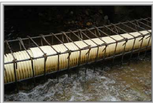
Foto 33. Acero de refuerzo para construir viga de recubr.
