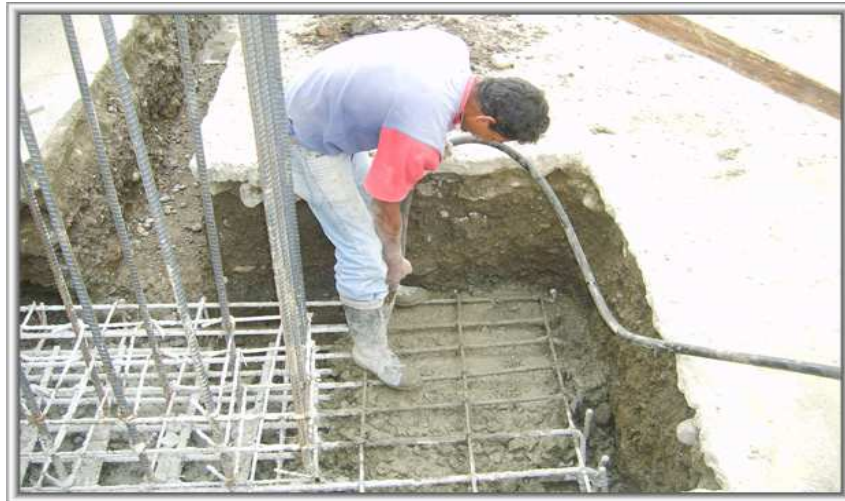
Foto 7. Construcción de zapatas
