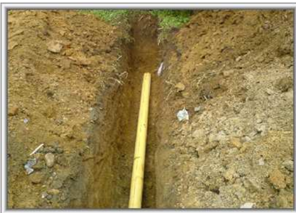
Foto 55. Instalación de acometida domiciliaria
