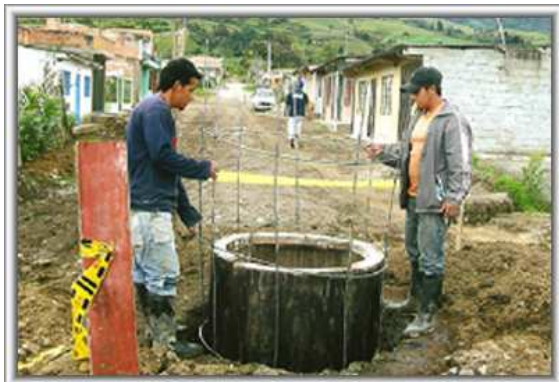
Foto 51. Construcción cámara de inspección
