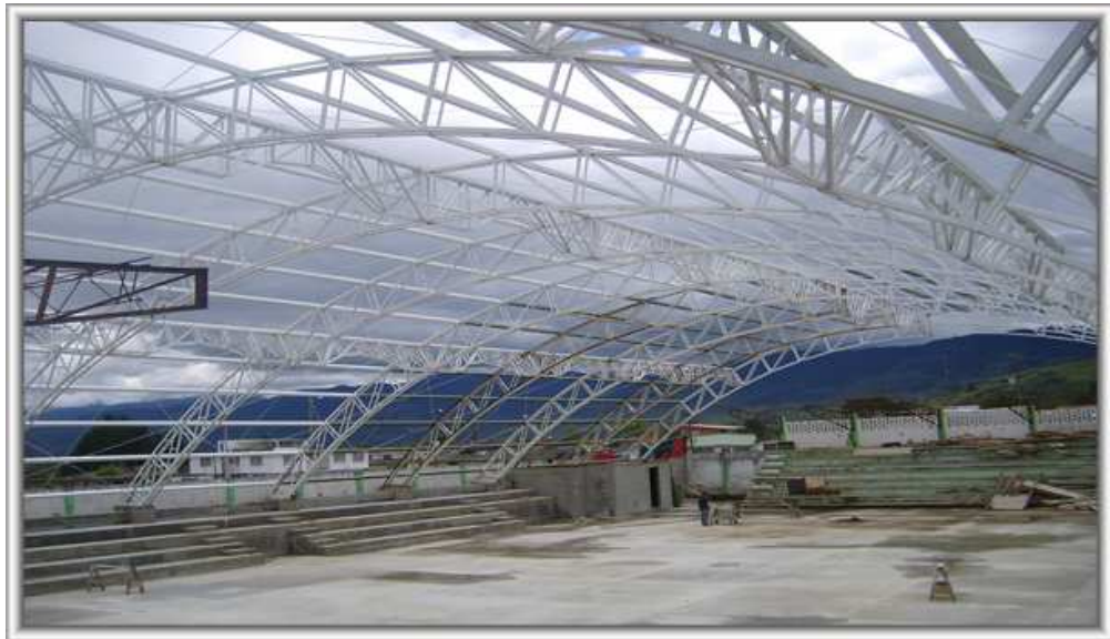
Foto 15. Construcción estructura metálica para cubierta
