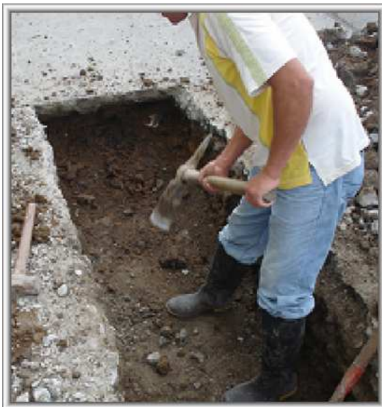
Foto 21. Demolición placa en concreto
