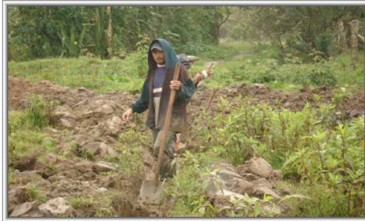
Foto 74. Excavación manual en material común
