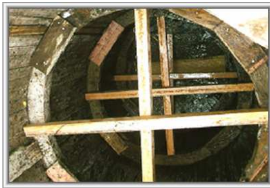
Foto 52. Construcción cámara de inspección
