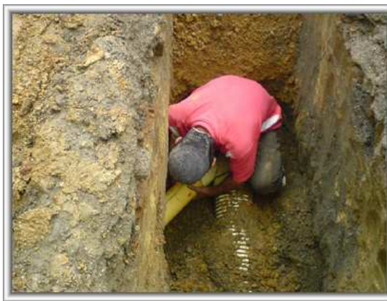
Foto 58. Instalación de silla yee 8" * 4"
