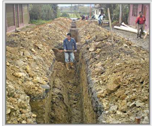
Foto 46. Excavación manual en material común
