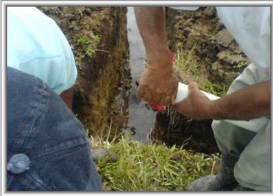
Foto 67. Suministro e Instalación válvula de compuerta 2"
