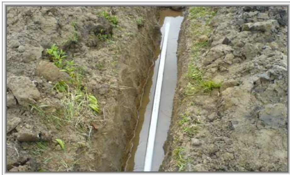
Foto 66. Instalación de tubería pvc pavco 2" rde 21
