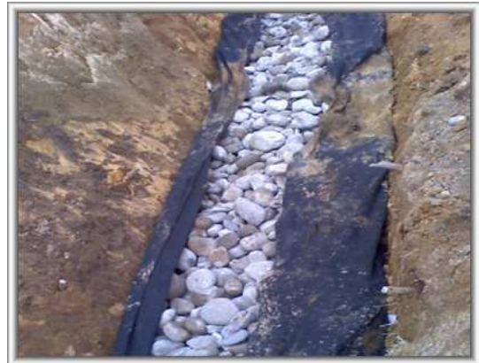
Foto 44. Construcción de filtros
