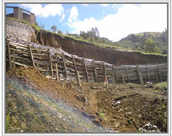
Foto 40. Construcción de muro con pilares de madera
