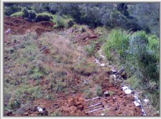
Foto 35. Localización y replanteo del terreno
