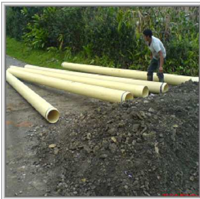
Foto 23. Suministro de tubería pvc 8"
