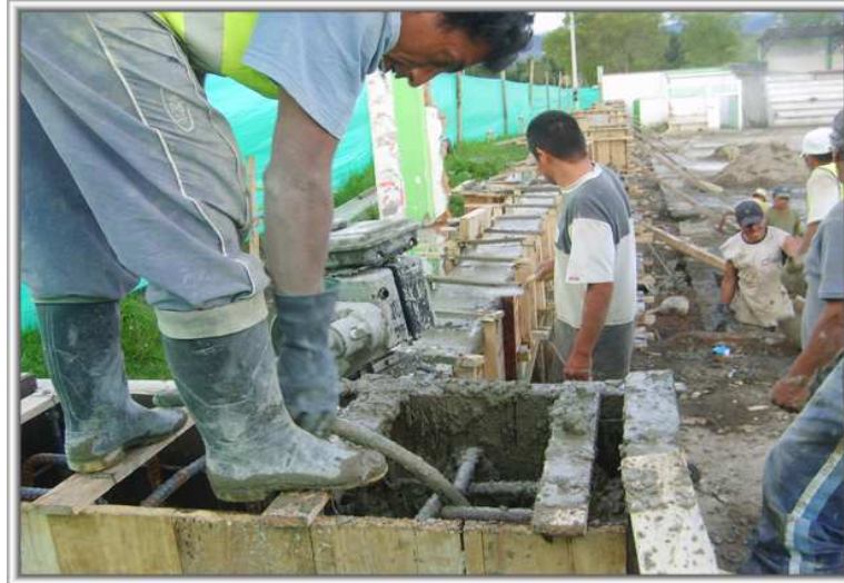
Foto 6. Construcción viga de coronamiento
