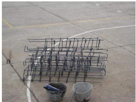
Figura 144. Flejado de columnas
