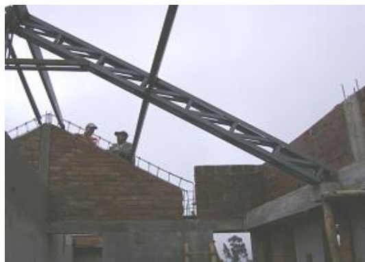
Figura 82. Instalación de cubierta metálica
