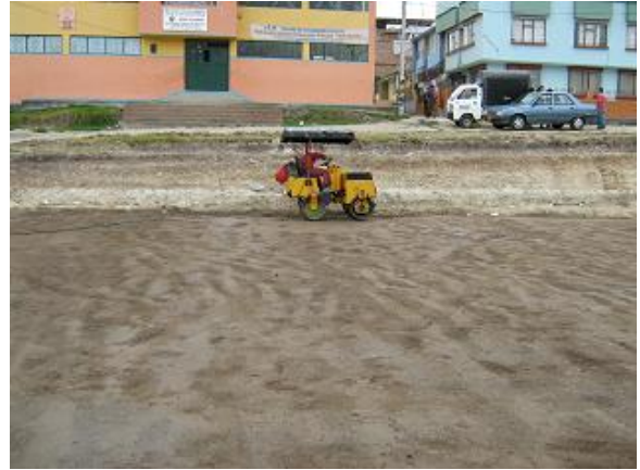
Figura 7. Compactación del terreno.
