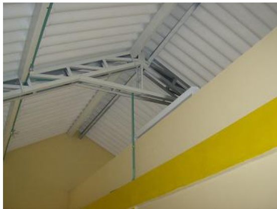
Figura 94. Pintura en cubierta e interiores
