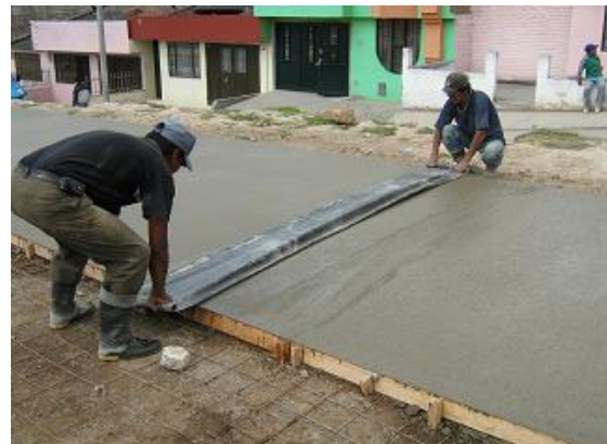
Figura 12. Acabado de paño de fundición.
