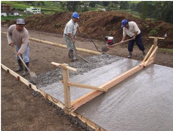
Figura 132. Fundición de paño en concreto
