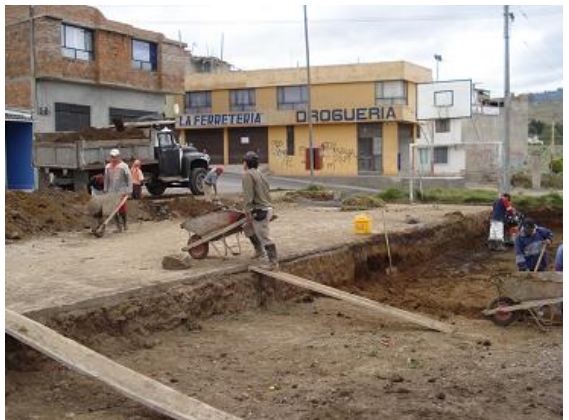
Figura 59. Trabajos de excavación
