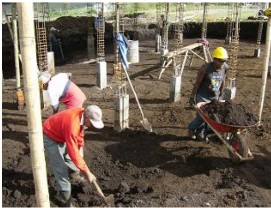
Figura 74. Compactación de base
