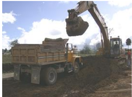
Figura 101. Excavaciones con retroexcavadora
