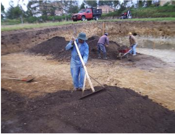
Figura 128. Colocación de material de base
