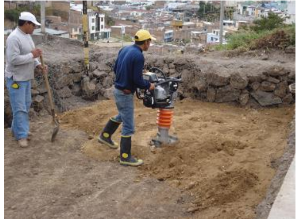
Figura 61. Compactación con saltarín
