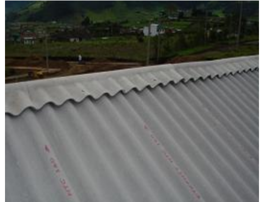
Figura 89. Caballetes de cubierta
