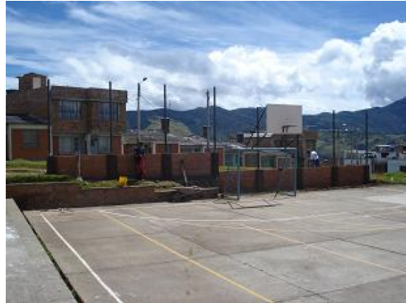
Figura 150. Columnas en concreto lado norte
