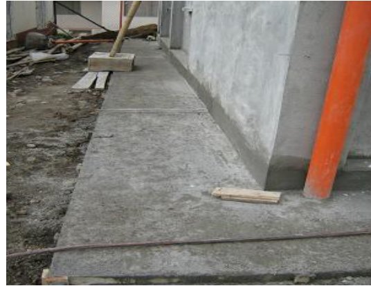
Figura 224. Anden en concreto
