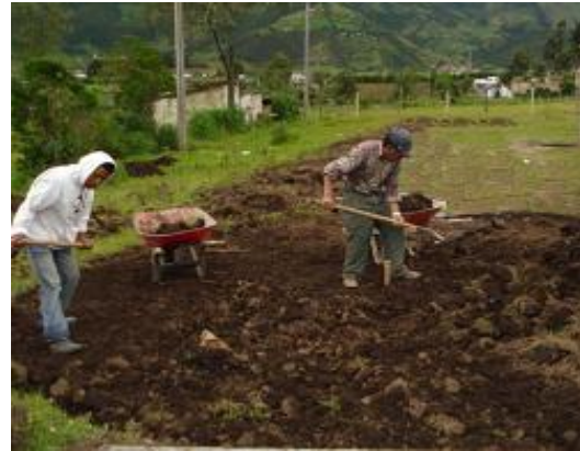
Figura 119. Excavación para plazoletas
