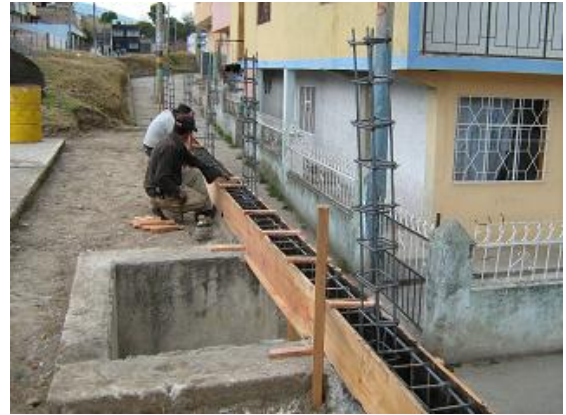
Figura 30. Formaleteado de vigas
