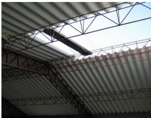
Figura 225. Instalación de cubierta
