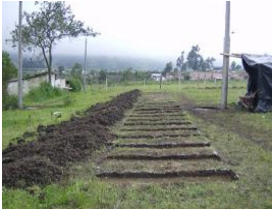
Figura 118. Excavación para plaquetas
