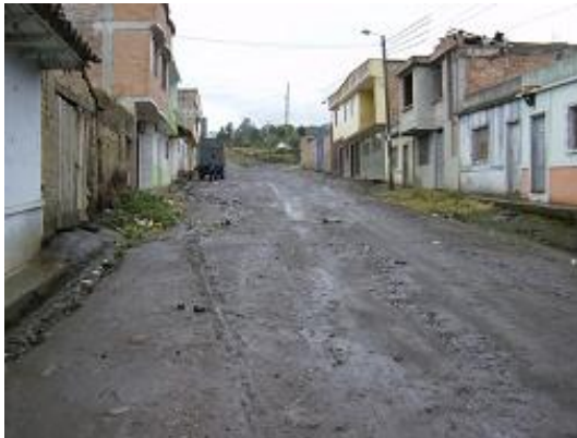
Figura 98. Estado inicial de la vía
