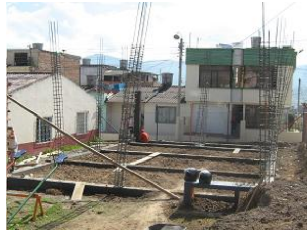
Figura 210. Vigas de cimentación
