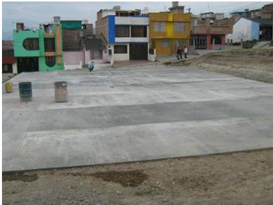
Figura 15. Placa de piso terminada
