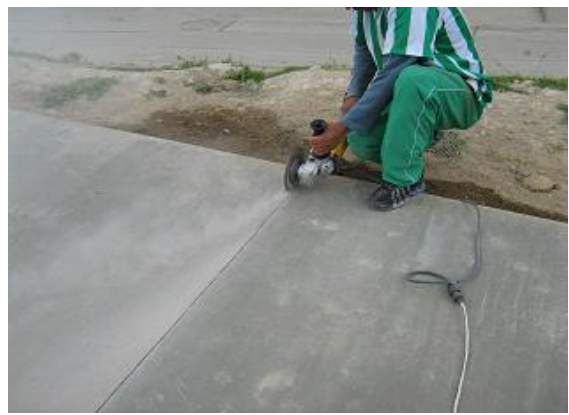
Figura 16. Corte de placa para dilataciones
