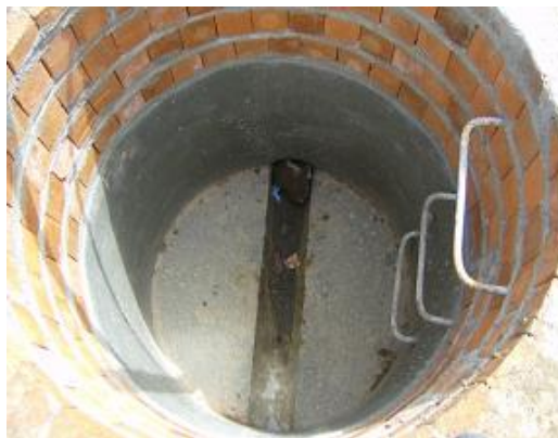
Figura 112. Cámara de inspección terminada
