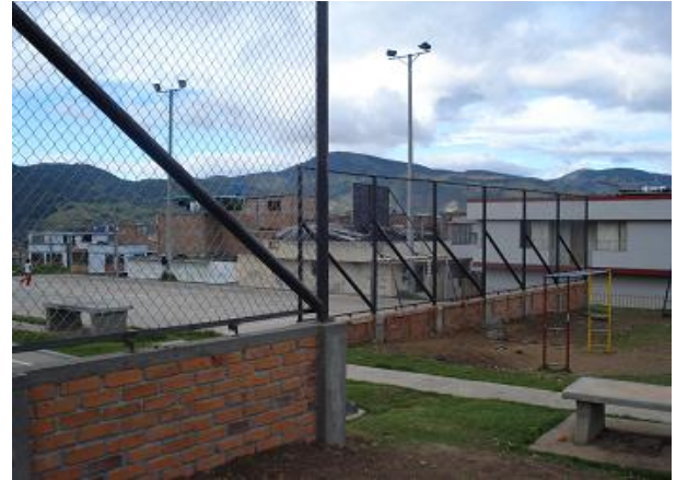
Figura 152. Cerramiento de protección lado sur
