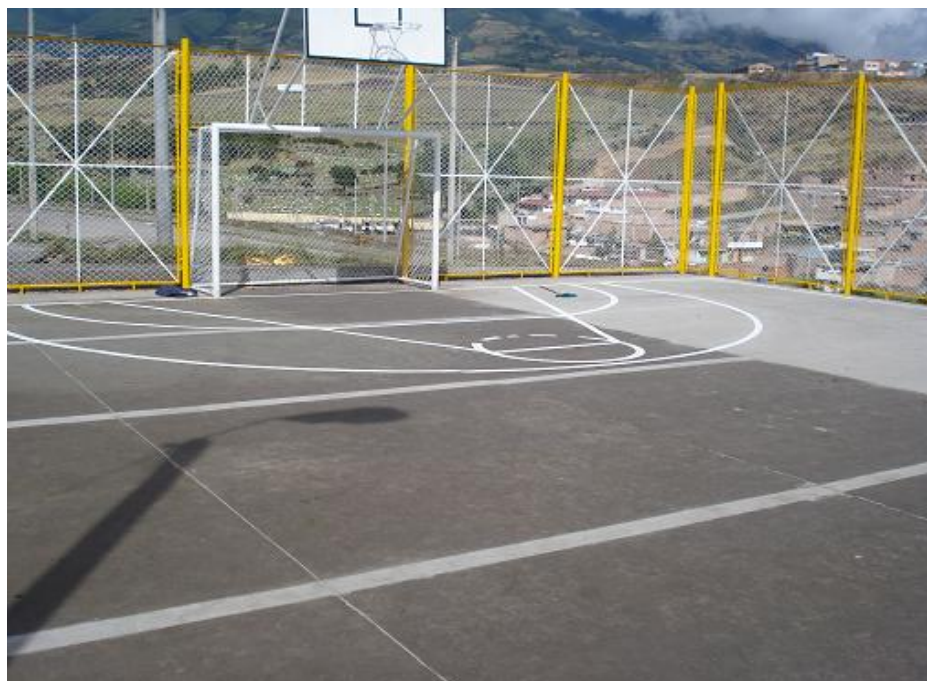
Figura 67. Polideportivo terminado sentido Este - Oeste
