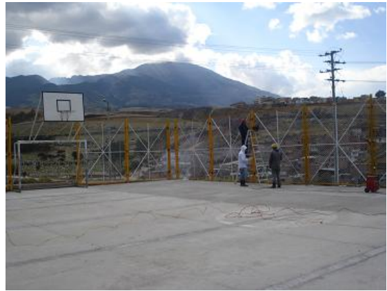
Figura 66. Cerramiento de protección
