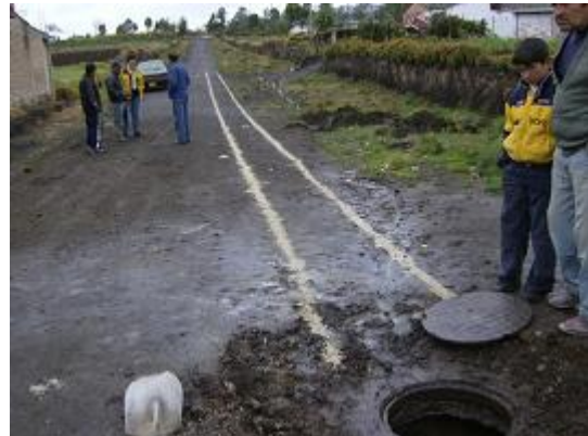
Figura 99. Localización y replanteo
