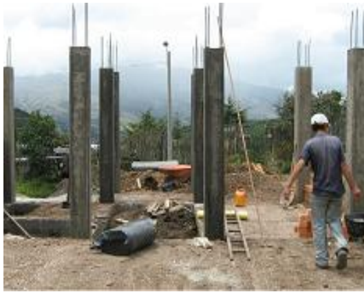
Figura 159. Columnas en concreto
