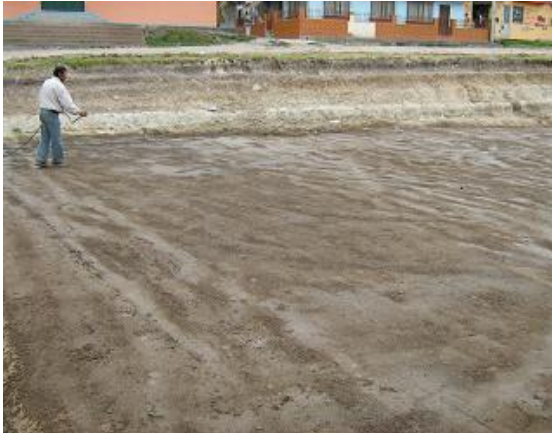
Figura 6. Humedecimiento de la capa
