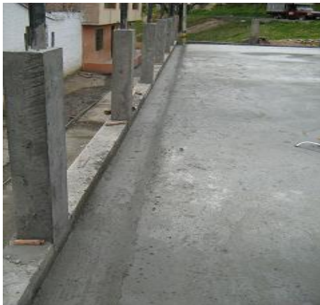
Figura 43. Cuneta en concreto
