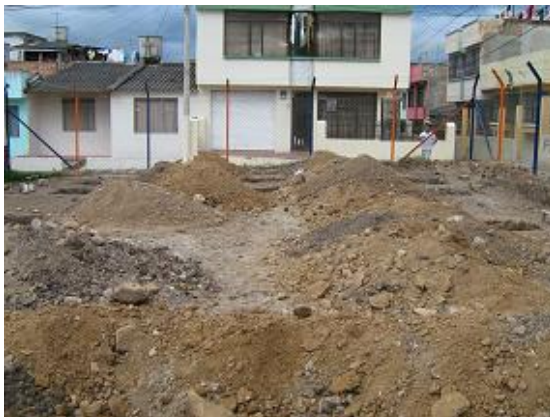
Figura 206. Zona de excavación para zapatas
