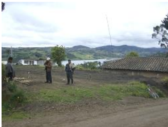
Figura 178. Sitio de construcción
