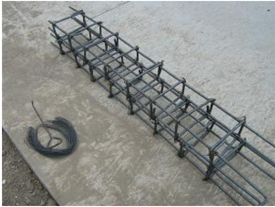
Figura 29. Flejado de estructuras
