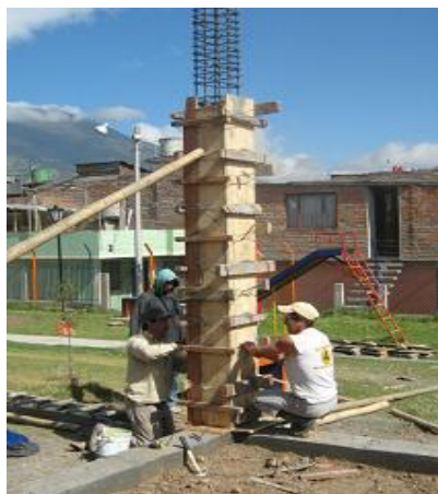
Figura 211. Armado de formaleta
