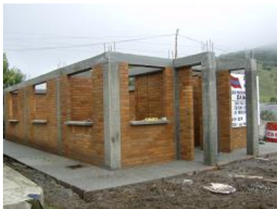
Figura 164. Viga aérea en concreto
