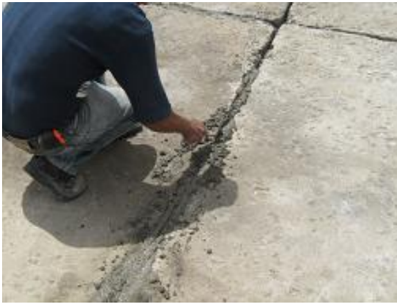
Figura 33. Relleno de juntas con mortero
