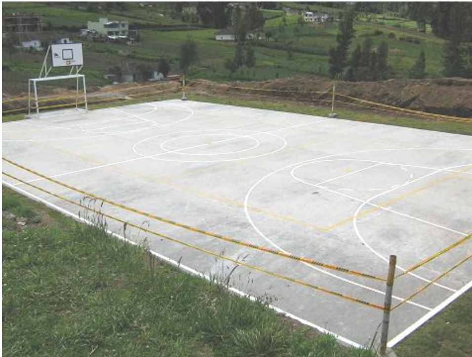
Figura 138. Polideportivo terminado sentido norte – sur.
