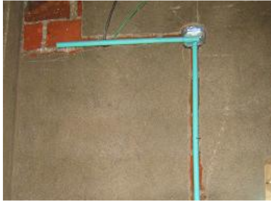
Figura 201. Regateo para instalaciones eléctricas
