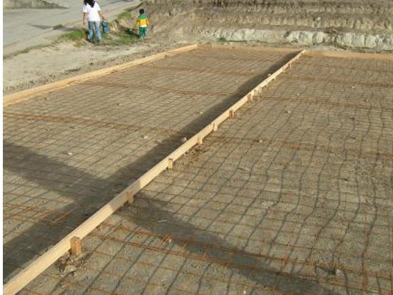
Figura 9. Armado de rieles y templado de malla
