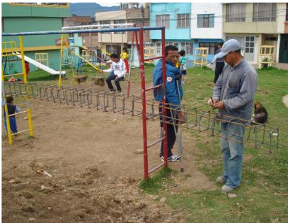
Figura 143. Flejado de vigas
