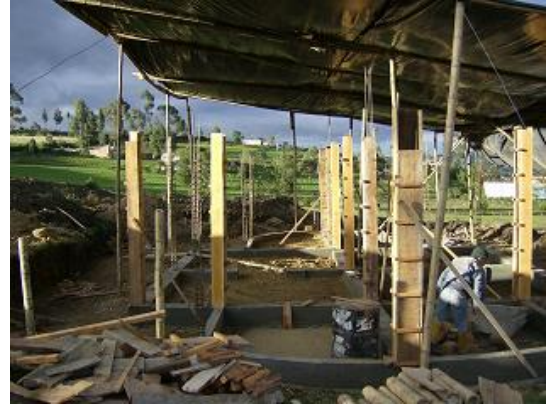
Figura 77. Formaletas para columnas
