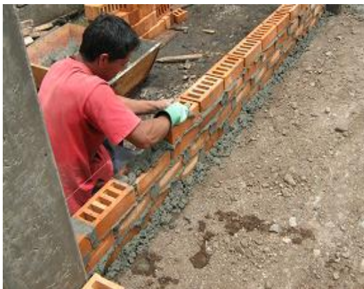
Figura 161. Pega de mampostería
