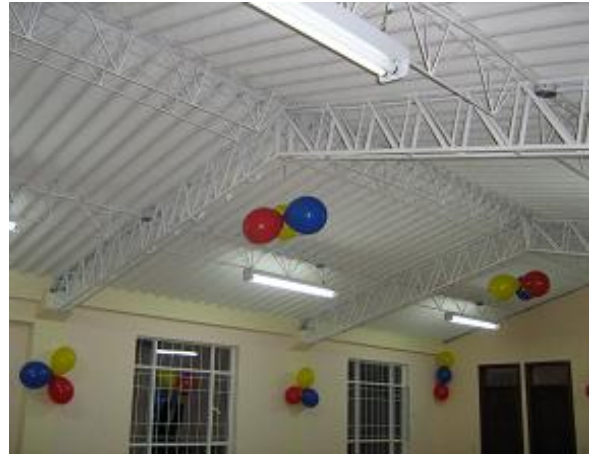
Figura 232. Cubierta, estructura metálica e iluminación.
