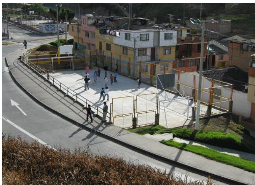
Figura 53. Polideportivo terminado sentido norte - sur
