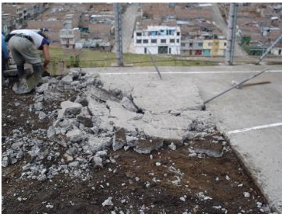
Figura 54. Demolición de placa
