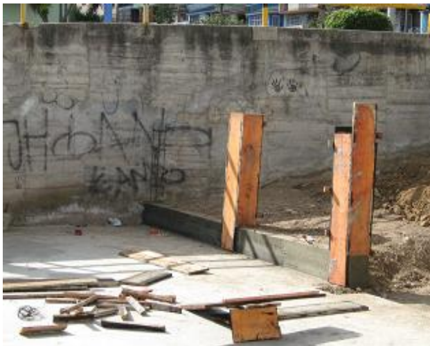
Figura 31. Formaleta de columnas
