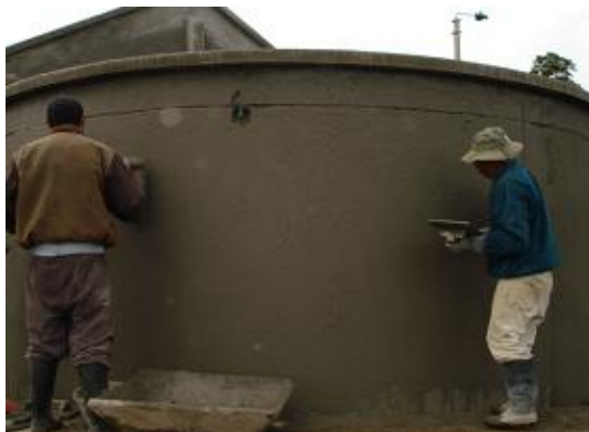
Figura 80. Terminación de pañetes
