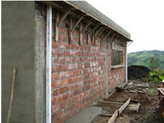
Figura 189. Muros sin pañetar
