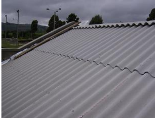
Figura 88. Cubierta en eternit
