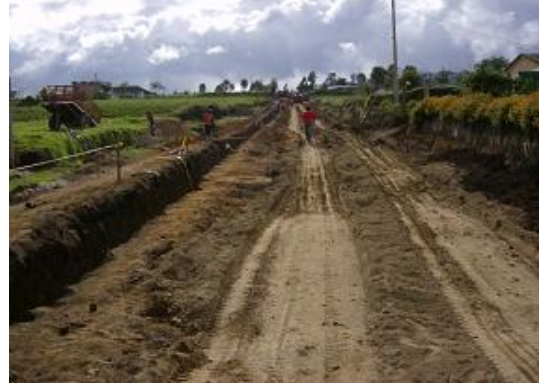
Figura 115. Trabajos de afirmado
