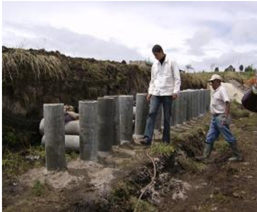
Figura 108. Verificación de la tubería
