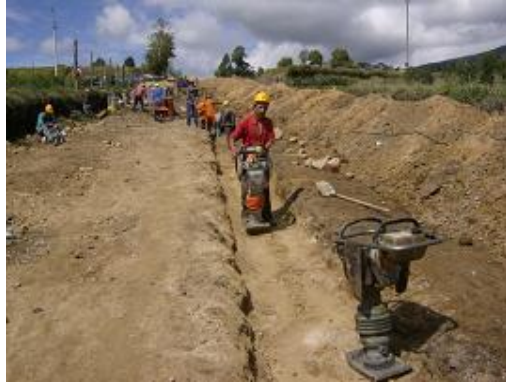
Figura 114. Trabajos de compactación.
