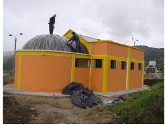
Figura 97. Batería sanitaria y camerinos
