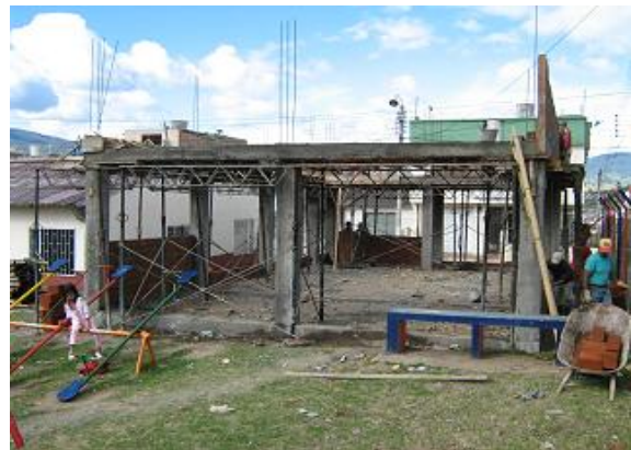
Figura 214. Estructuras en concreto
