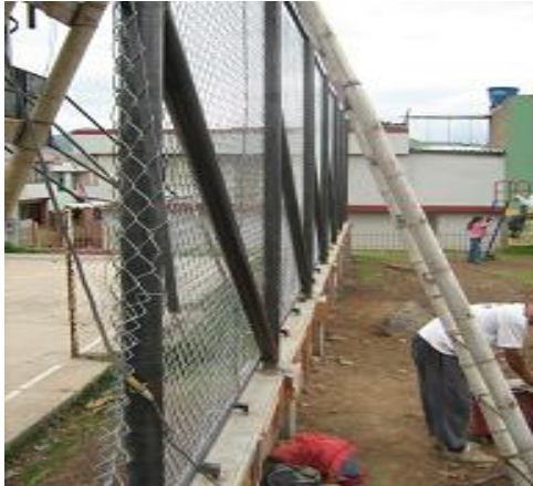
Figura 151. Trabajos de soldadura
