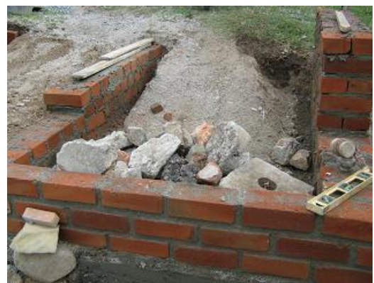
Figura 50. Relleno con rajón.
