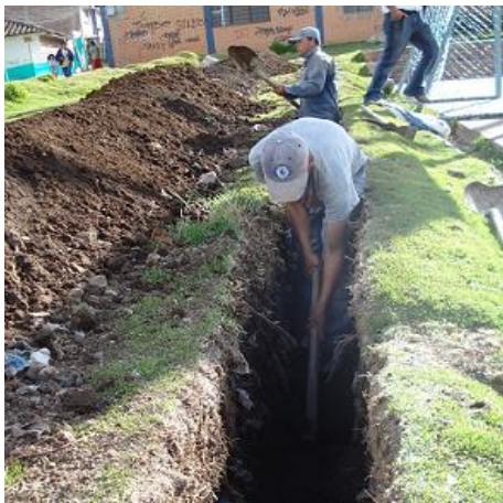
Figura 141. Trabajos de excavación.
