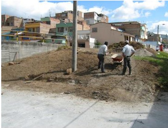
Figura 47. Excavaciones para graderías
