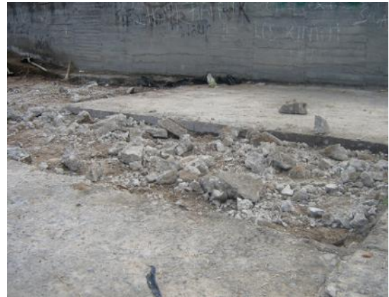
Figura 28. Demolición placa en concreto
