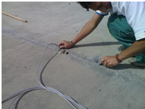
Figura 19. Colocación de cordón de respaldo
