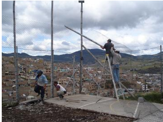
Figura 56. Desmonte de cerramiento
