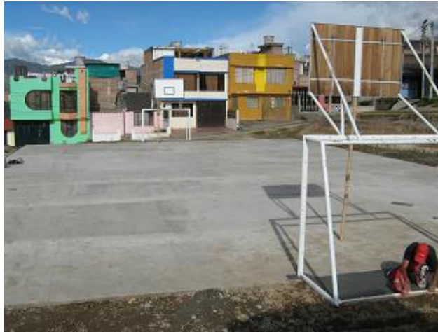
Figura 21. Instalación de canchas multifuncionales
