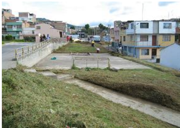
Figura 27. Trabajos de desmonte, descapote y excavación
