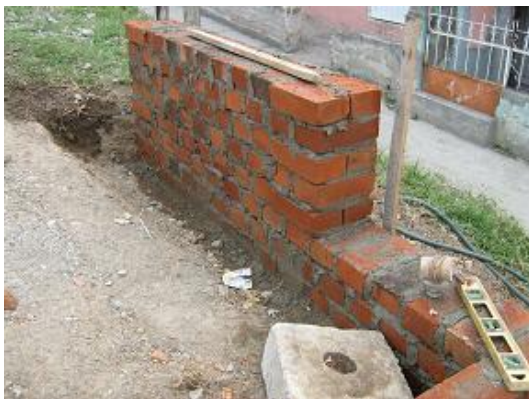
Figura 49. Mampostería para graderías
