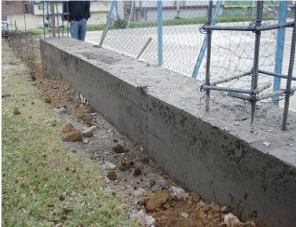
Figura 145. Viga de cimentación lado norte
