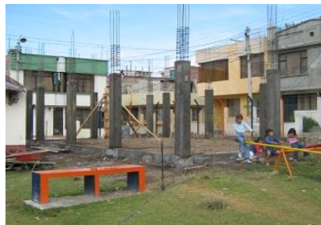
Figura 212. Columnas en concreto
