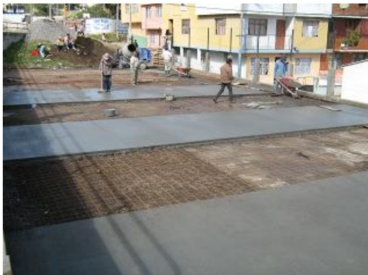
Figura 37. Fundición de placa polideportiva
