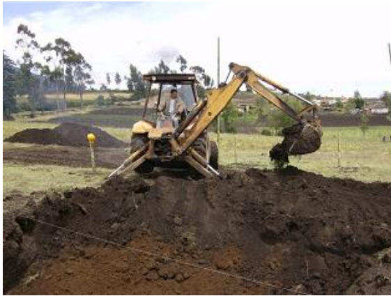
Figura 70. Excavaciones a maquina
