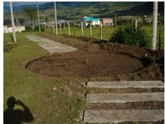
Figura 121. Vista sendero peatonal
