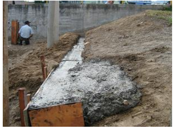
Figura 48. Fundición de concreto ciclópeo
