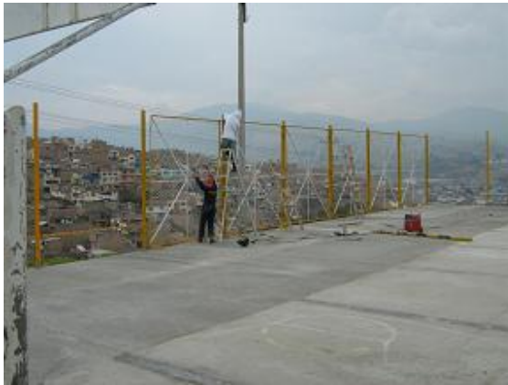
Figura 65. Instalación de cerramiento
