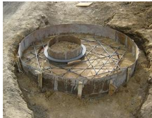
Figura 113. Construcción tapa para cámara
