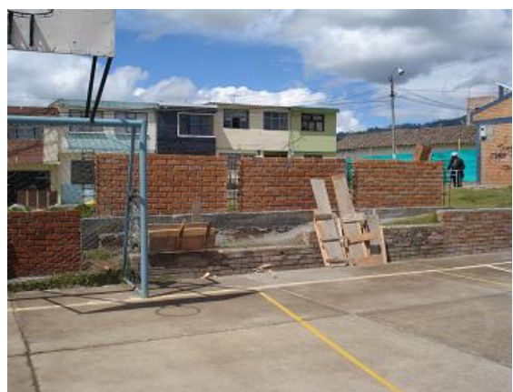
Figura 148. Mampostería lado sur
