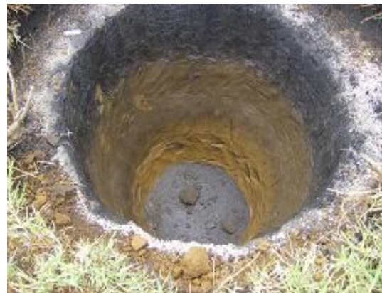
Figura 170. Tanque de absorción.
