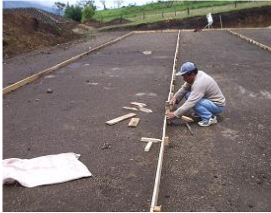
Figura 130. Trabajos de enriado
