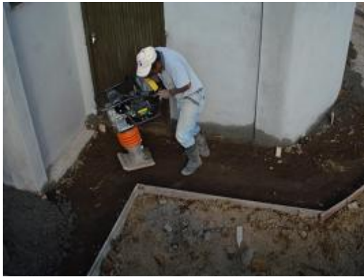
Figura 84. Compactación de base en recebo
