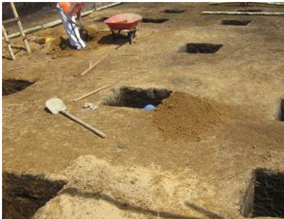
Figura 72. Excavaciones para zapatas
