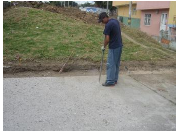
Figura 34. Picado de losa antigua
