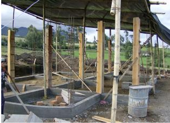
Figura 76. Vigas de cimentación
