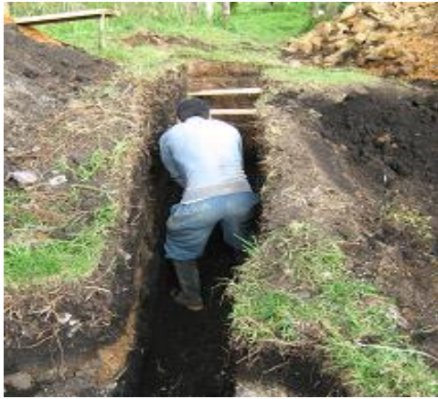
Figura 157. Excavaciones a mano
