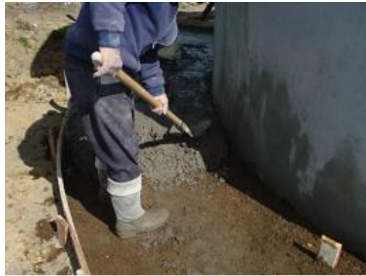
Figura 85. Fundición de andenes
