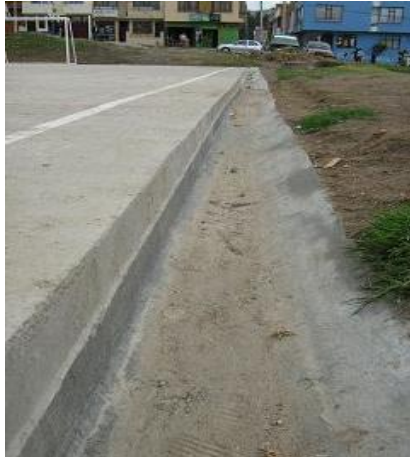
Figura 17. Cunetas en concreto
