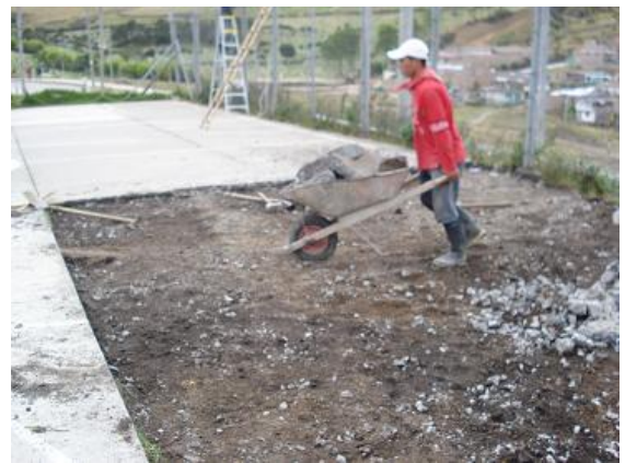
Figura 55. Retiro de material sobrante
