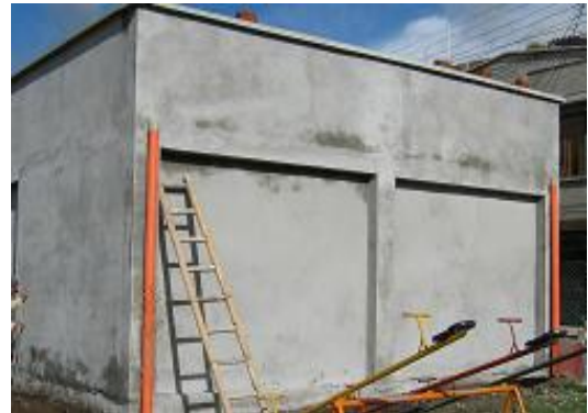
Figura 218. Bajante de aguas lluvias
