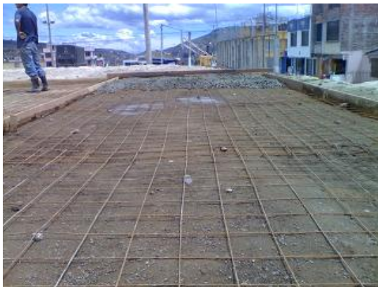
Figura 11. Fundición primer paño
