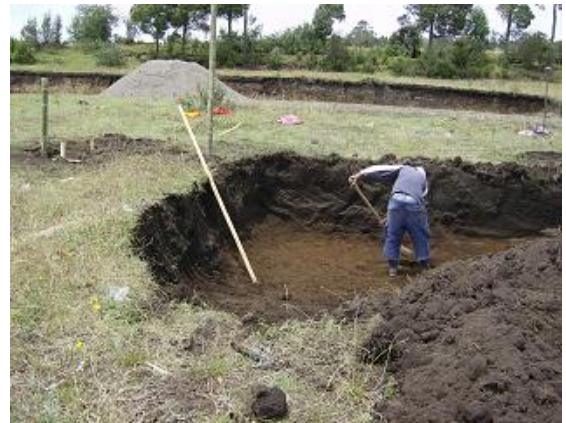
Figura 71. Excavaciones a mano
