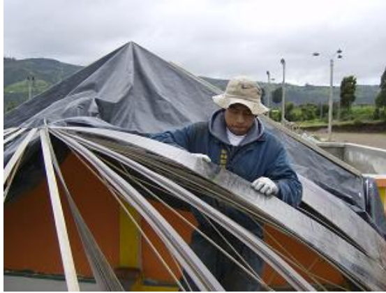
Figura 96. Instalación de cubierta en acrílico
