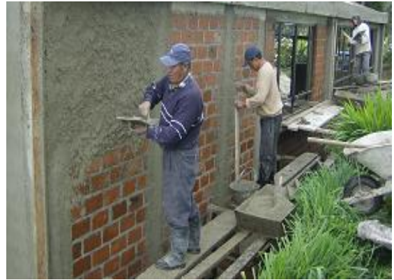
Figura 190. Pañetado de muros
