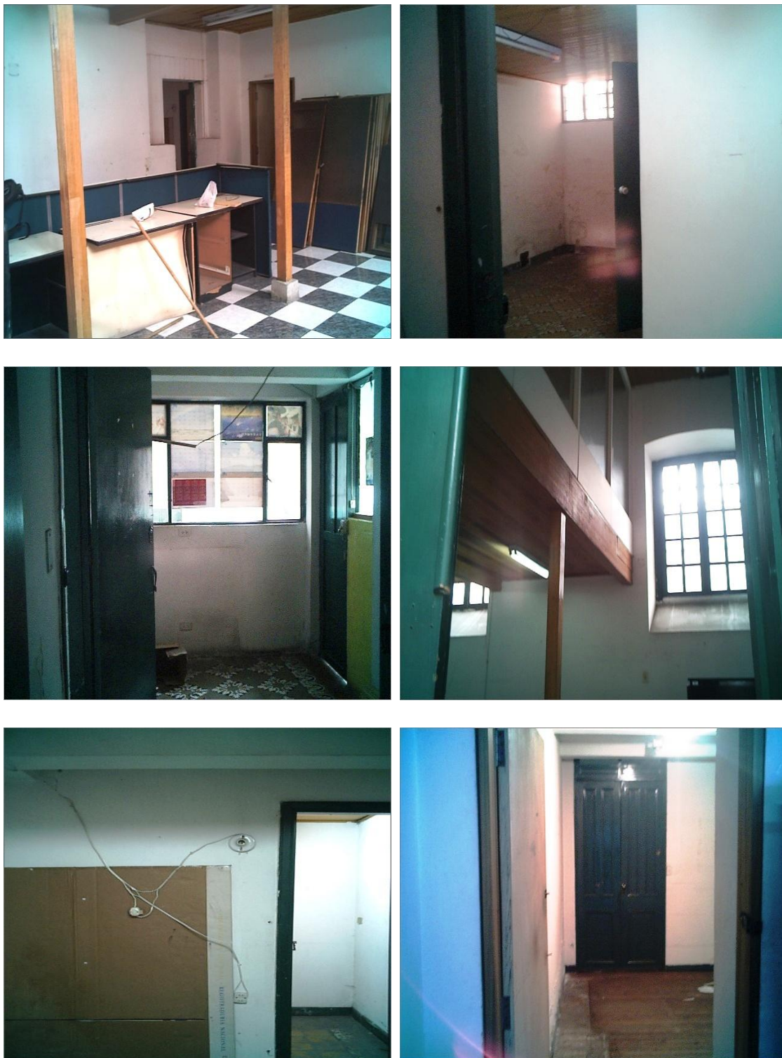
Figura 65. Estado actual del área de oficinas del antiguo liceo
