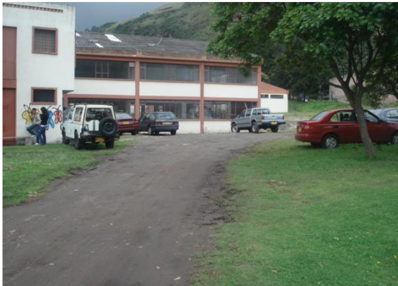
Figura 84. Panorámica de zona a intervenir
