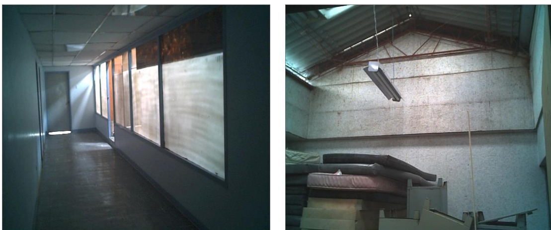
Figura 137. Estado actual de las Instalaciones a intervenir
