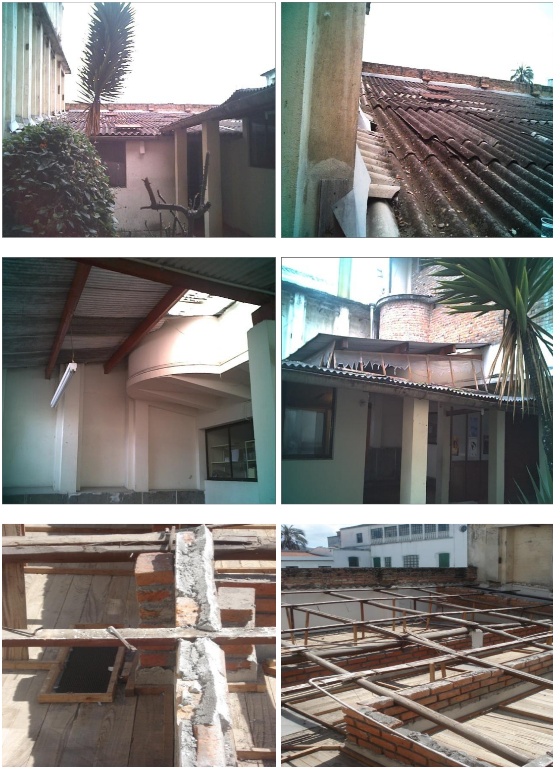
Figura 64. Estado actual de las Instalaciones en el área de cubierta
