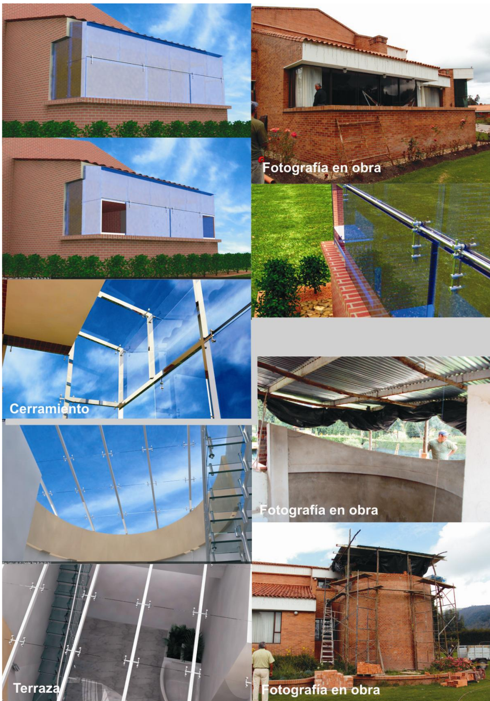
Imagen 18: Cerramiento y terrazas en vidrio.
