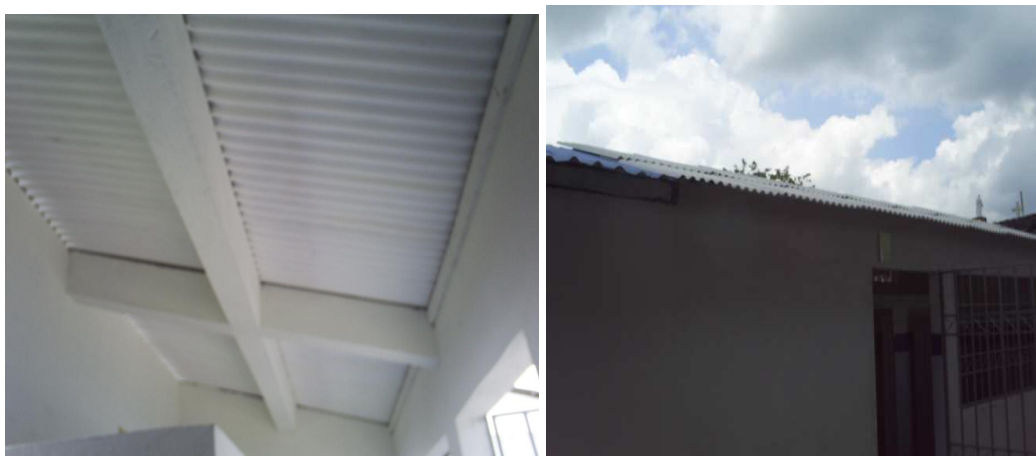
Foto 116 y 117. Cubierta y pintura de acabado
