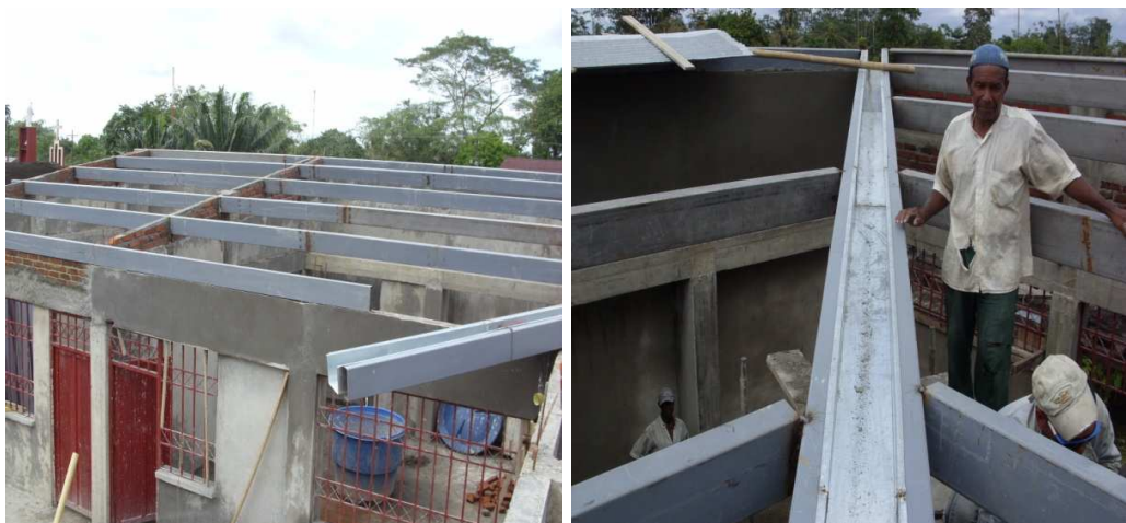
Foto 36 y 37. Estructura metálica de cubierta
