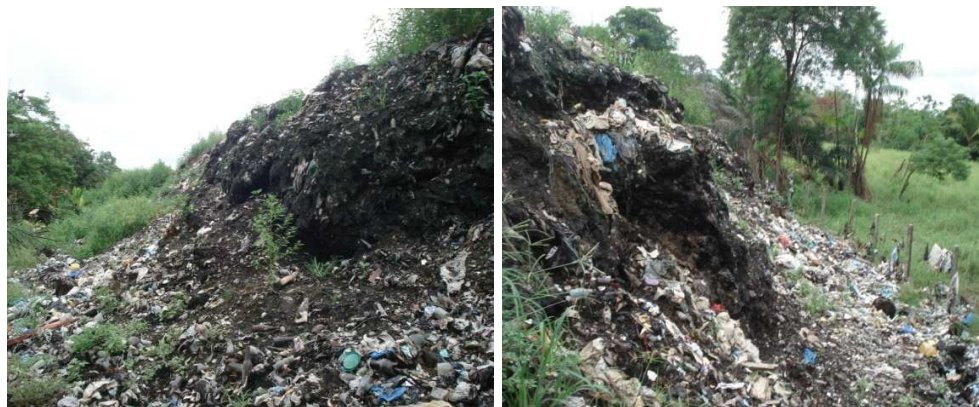
Foto 170 y 171. Taludes de residuos a estabilizar, obsérvese el deslizamiento producido en la foto 46
