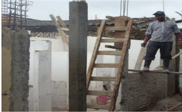
Foto 104. Columnetas para soporte de cubierta
