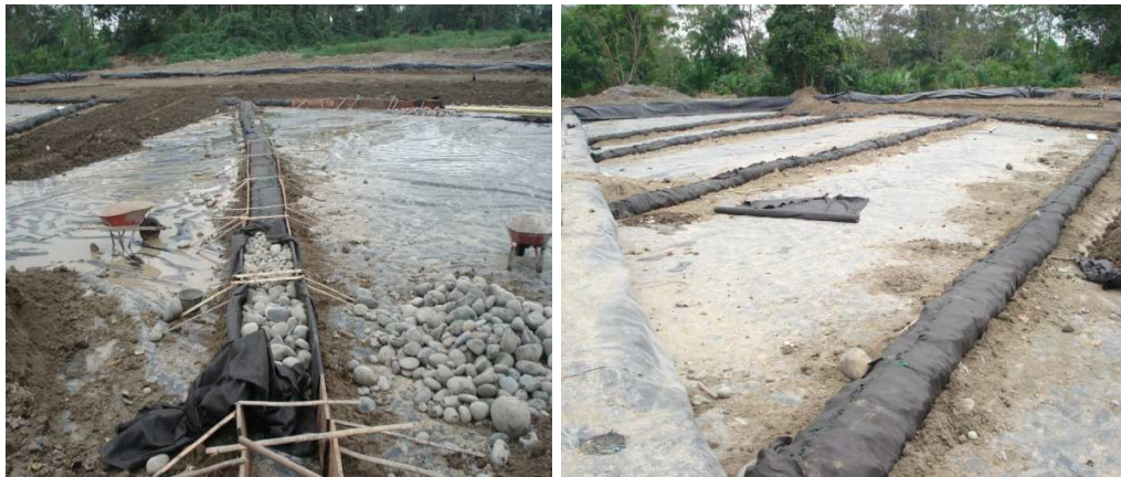
Foto 141 y 142. Construcción de filtro tipo B
