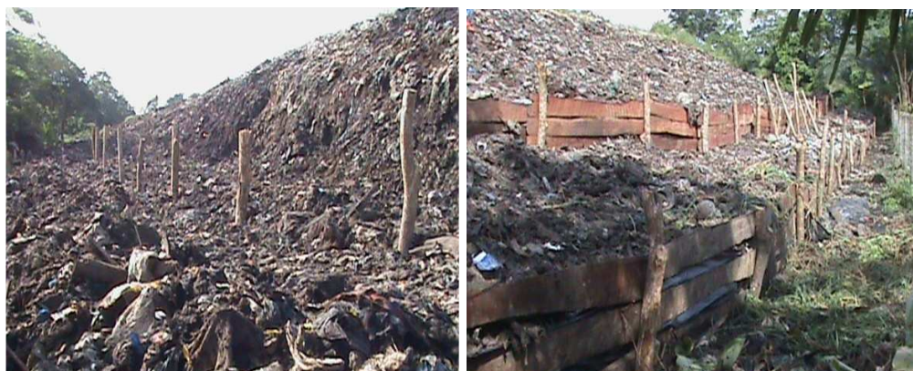
Foto 172 y 173. Estabilización de los taludes en los bordes del vertedero
