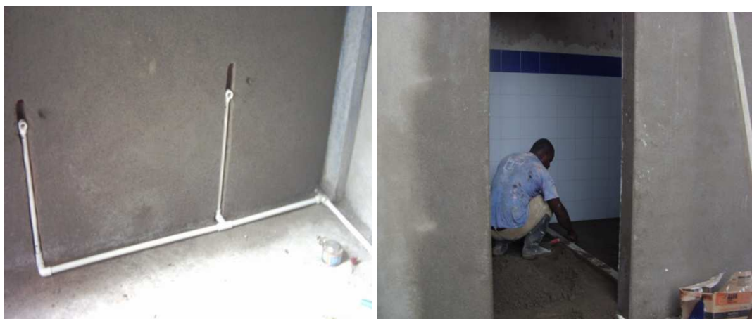
Foto 79 y 80. Instalación y cubrimiento de tubería por piso
