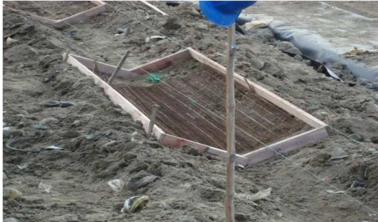
Foto 150. Cuneta lista para fundición
