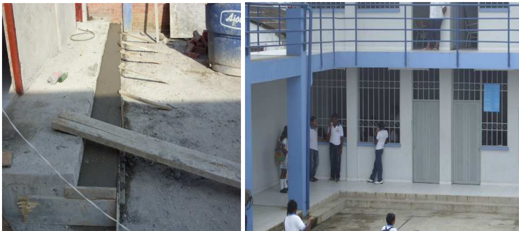
Foto 54 y 55. Proceso de construcción de andenes
