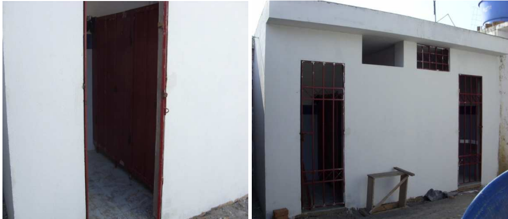
Foto 86 y 87. Carpintería metálica instalada con protección en anticorrosivo rojo
