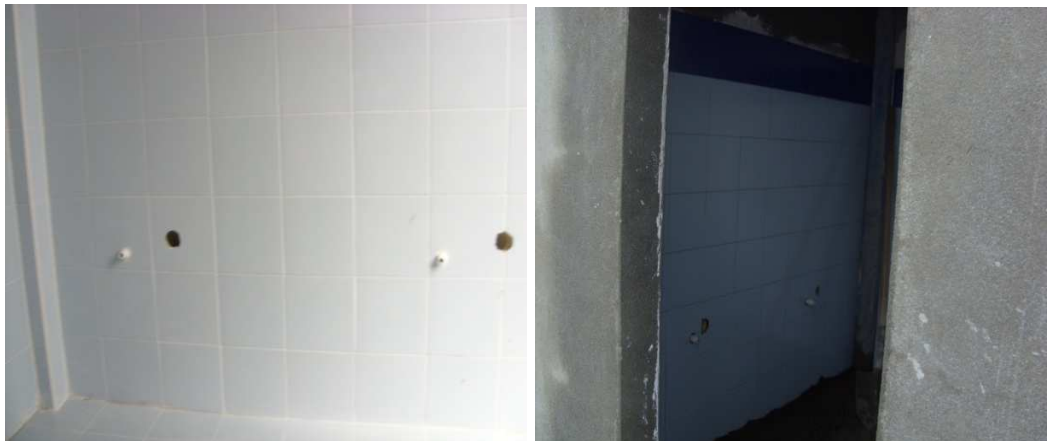
Foto 81 y 82. Vista de los muros enchapados en cerámica
