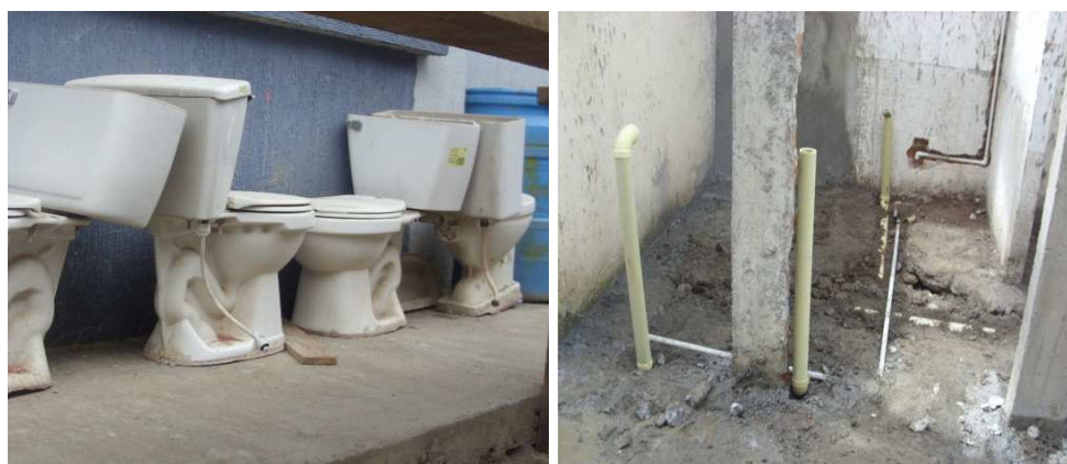
Foto 102 y 103. Sanitarios desmontados y tubería hidrosanitaria proyectada
