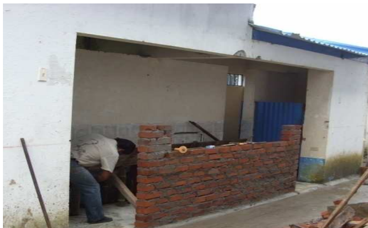
Foto 120. Muro de fachada nuevo
