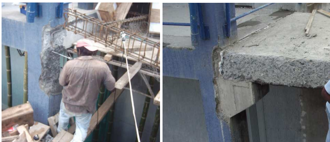
Foto 20 y 21. Construcción de ménsula
