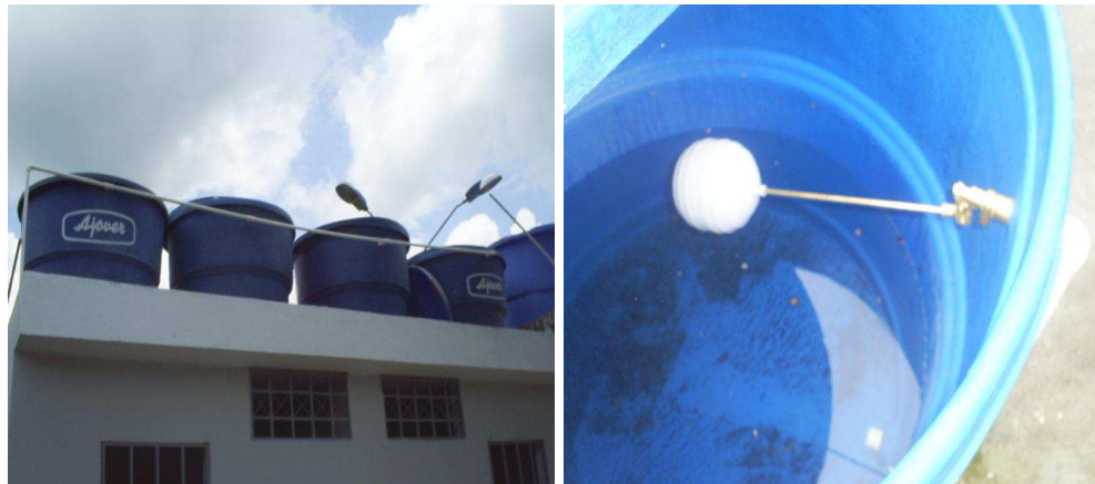
Foto 92 y 93. Vista de los tanques instalado con sus respectivos flotadores
