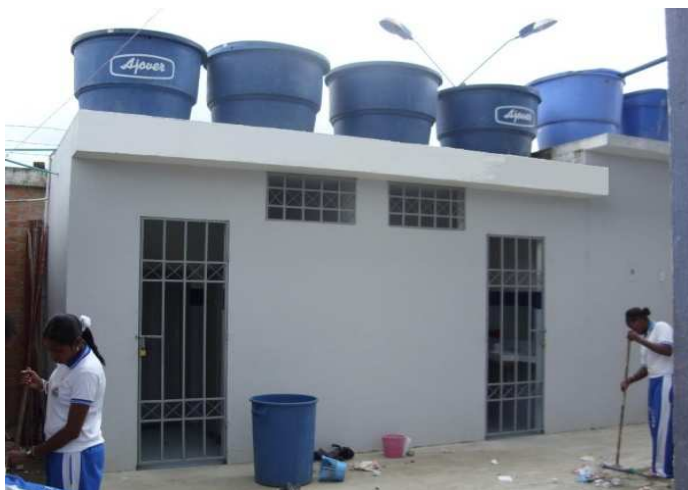
Foto 61. Batería sanitaria nueva terminada y en uso
