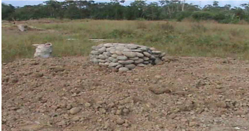
Foto 179. Vista final de las chimeneas en funcionamiento
