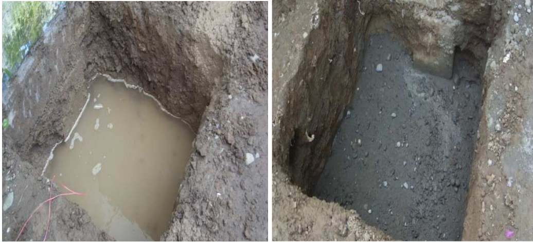
Foto 63 y 64. Excavación y solado de protección
