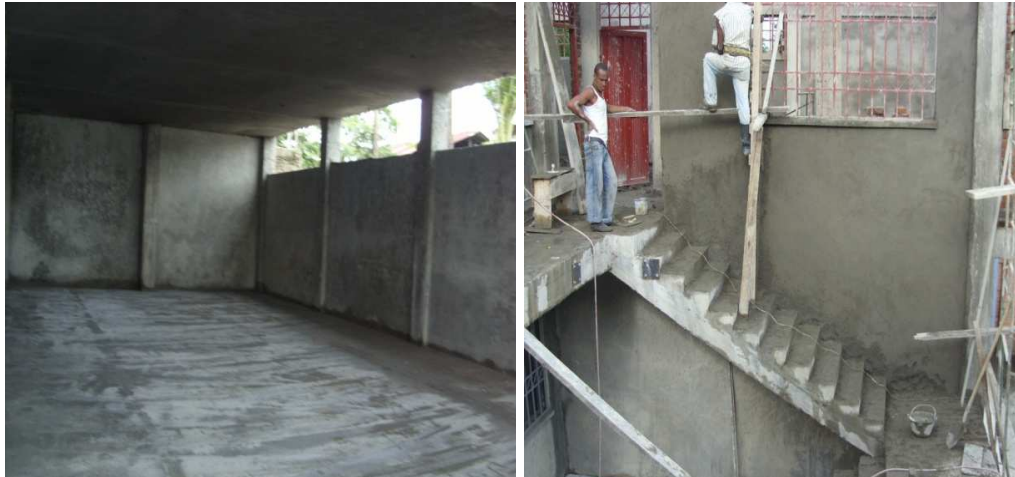
Foto 28 y 29. Muros repellados
