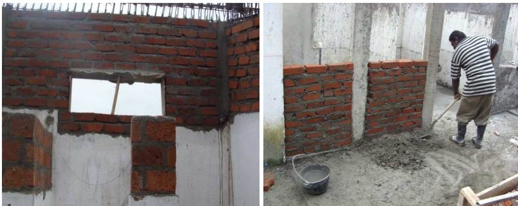
Foto 107 y 108. Vista de la colocación de los muros faltantes
