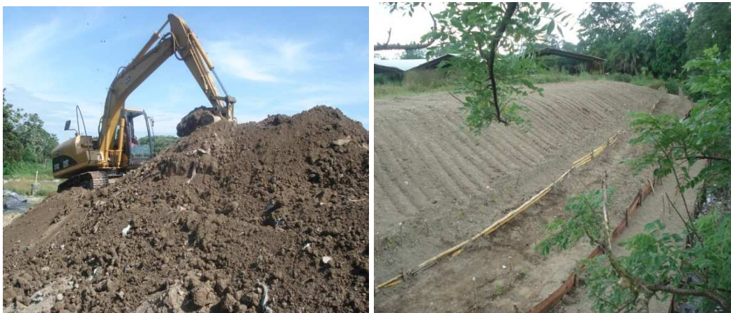
Foto 180 y 181. Proceso de extendido y compactación del suelo sobre residuos
