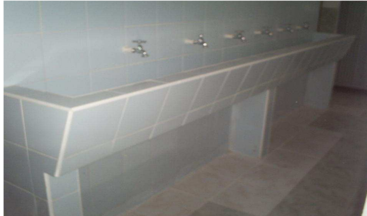
Foto 124. Lavamanos corrido terminado
