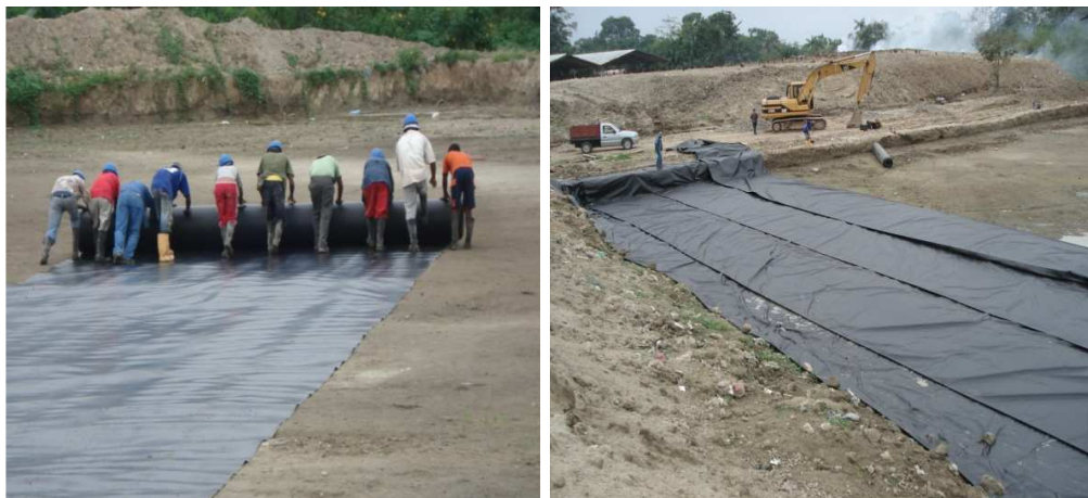
Foto 135 y 136. Instalación del geotextil
