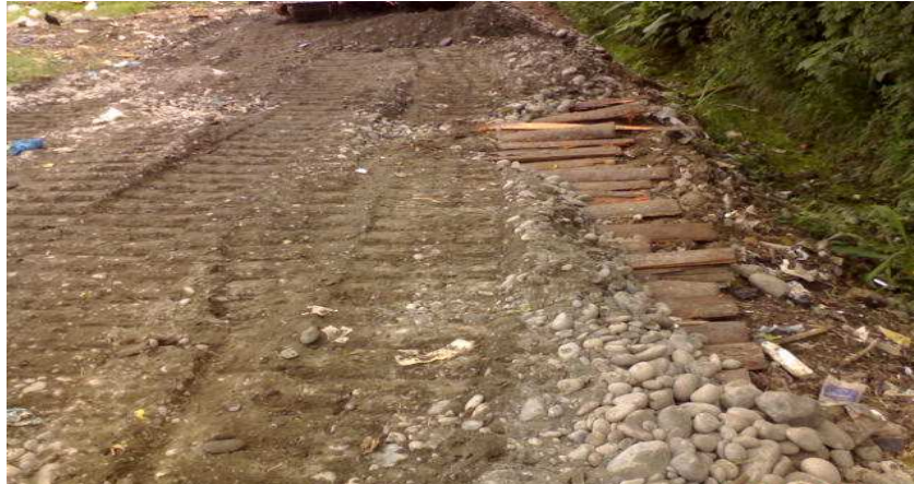
Foto 162. Proceso de extendido del material granular
