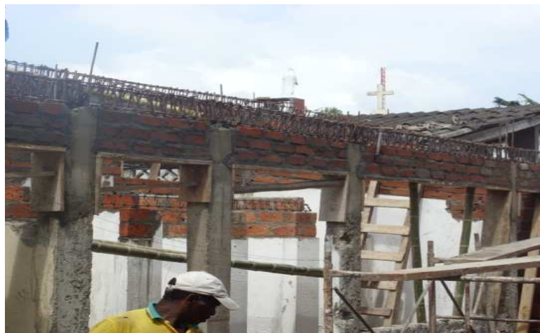
Foto 105. Armado de viguetas para estructura de cubierta
