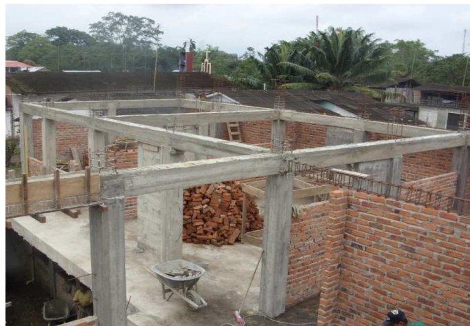
Foto 26. Construcción de vigas aéreas piso 2
