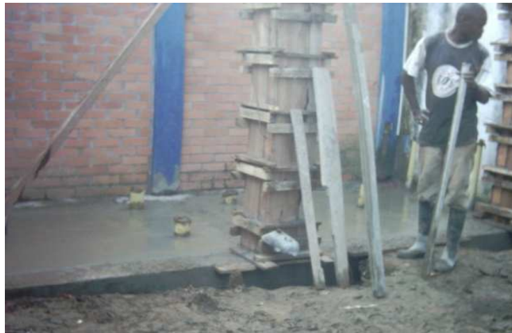
Foto 70. Placa contrapiso fundida, véase los puntos hidrosanitarios fijados
