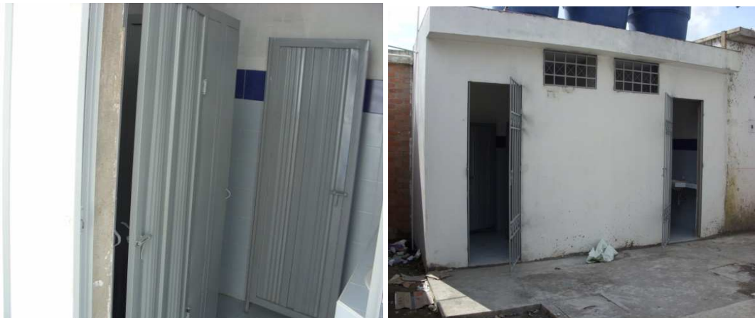
Foto 88 y 89. Puertas y ventanas metálicas acabadas
