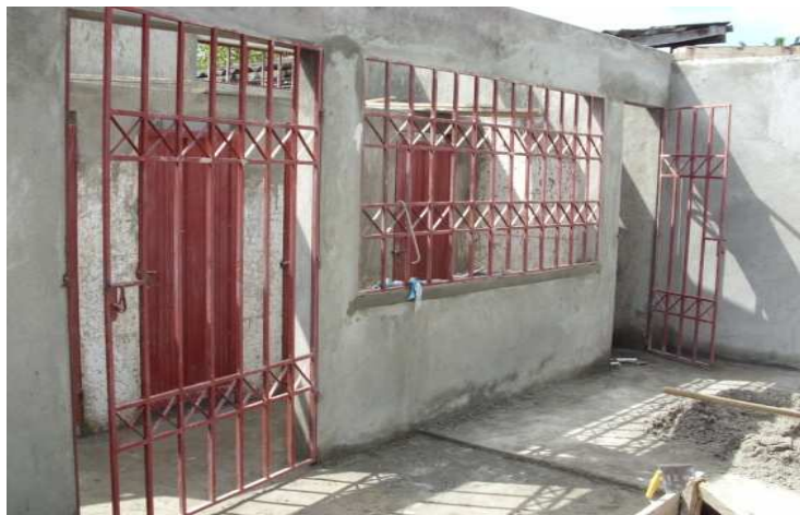
Foto 112. Carpintería metálica de la batería instalada
