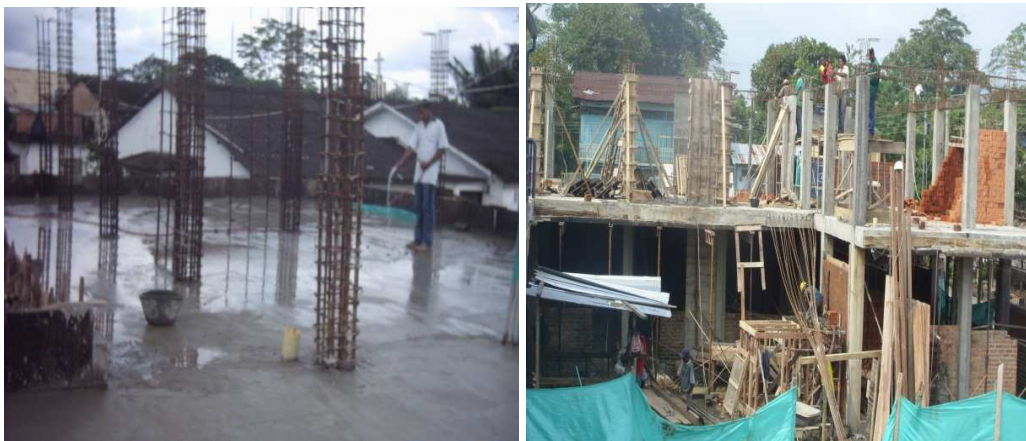
Foto 18 y 19. Losa de entrepiso fundida
