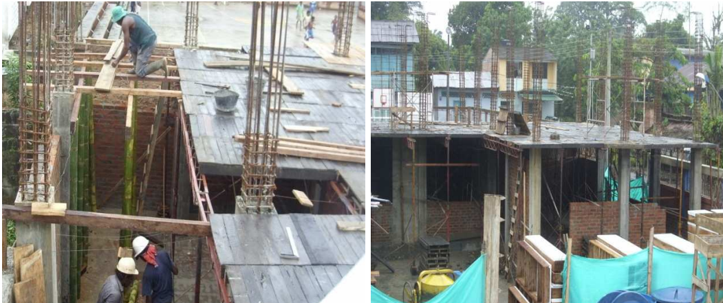
Foto 12 y 13. Armado de formaleta de entrepiso
