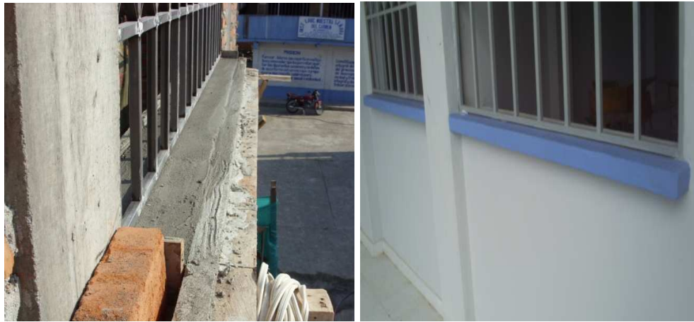
Foto 34 y 35. Alfajías fundidas y terminadas
