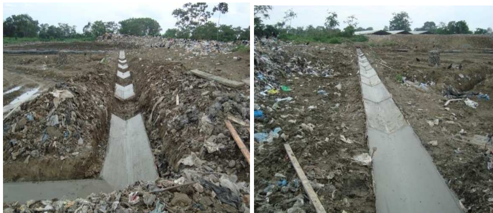
Foto 151 y 152. Cunetas construidas
