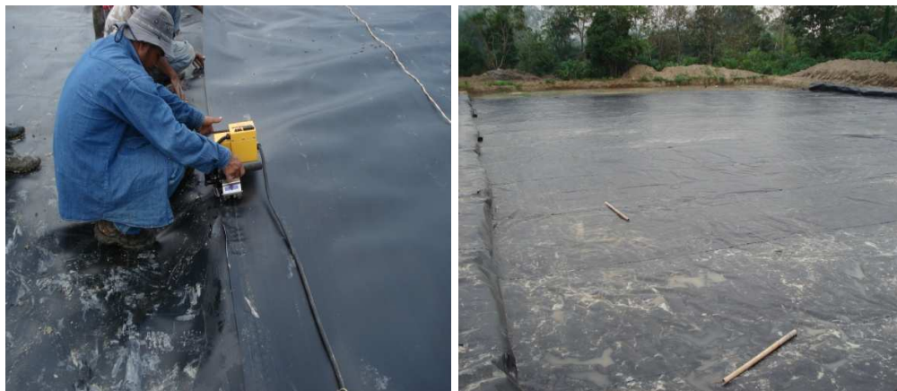
Foto 137 y 138. Proceso de instalación de geomembrana
