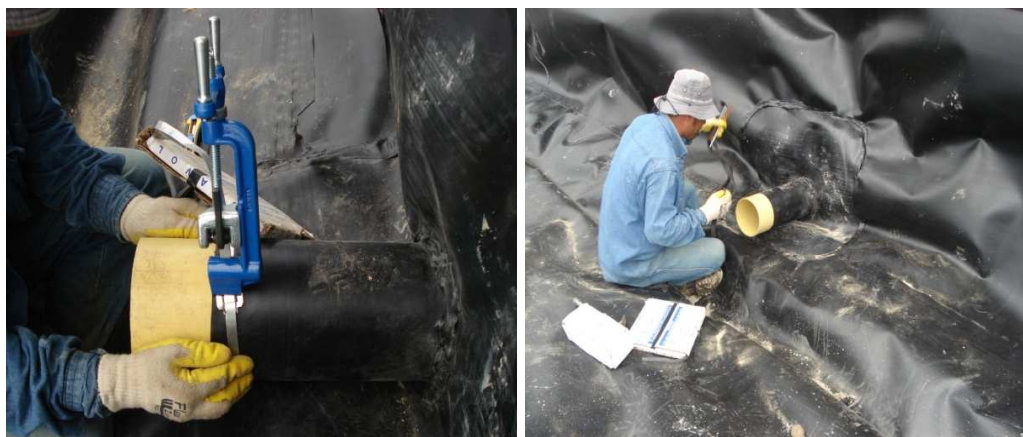
Foto 145 y 146. Instalación salida de lixiviados hacia tratamiento
