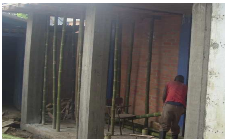
Foto 72. Vista de las columnas del la batería sanitaria construidas
