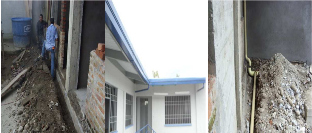
Foto 51 a 53. Excavación e instalación tubería de desagües
