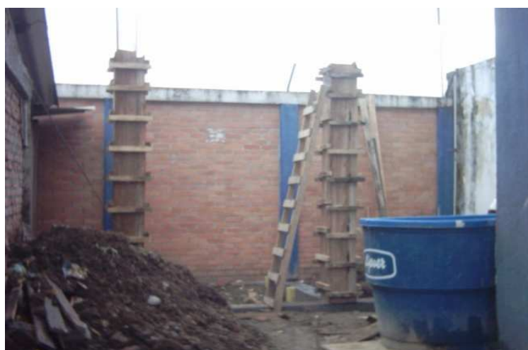
Foto 71. Columnas armadas y encofradas
