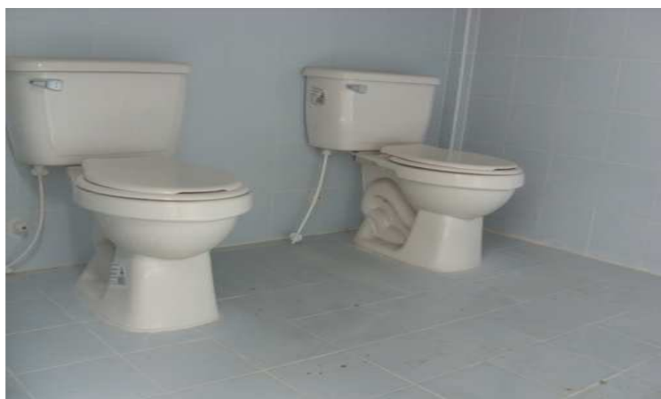
Foto 83. Vista del piso terminado, véase el emboquillado de los muebles sanitarios
