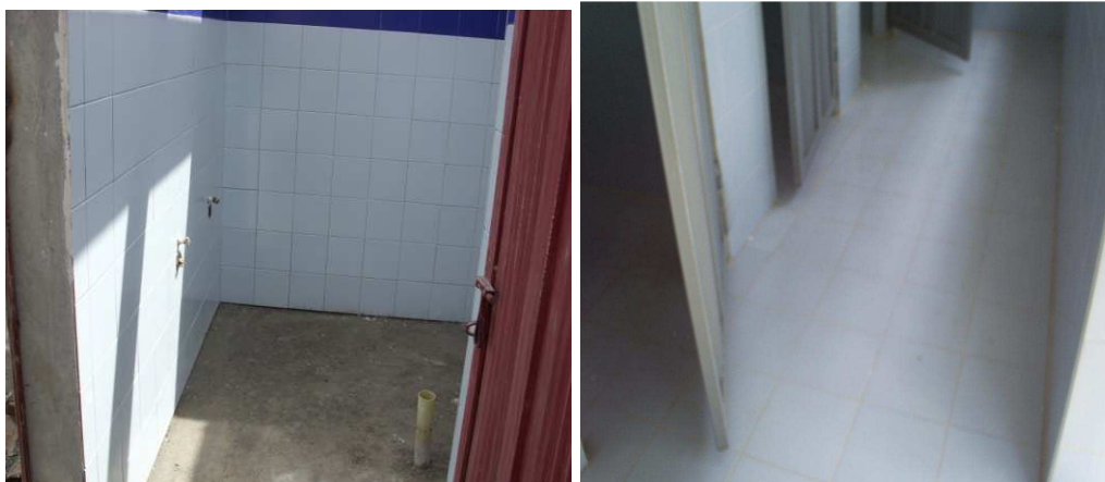
Foto 114 y 115. Enchape de muros y piso
