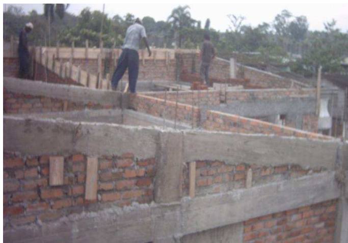
Foto 27. Construcción de viga cinta
