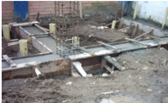
Foto 69. Vista de las vigas de cimentación fundidas
