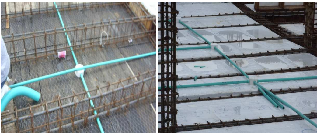
Foto 44 y 45. Instalación ductos para conductor eléctrico
