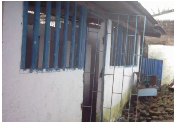
Foto 59. Estado inicial de la batería sanitaria de niños
