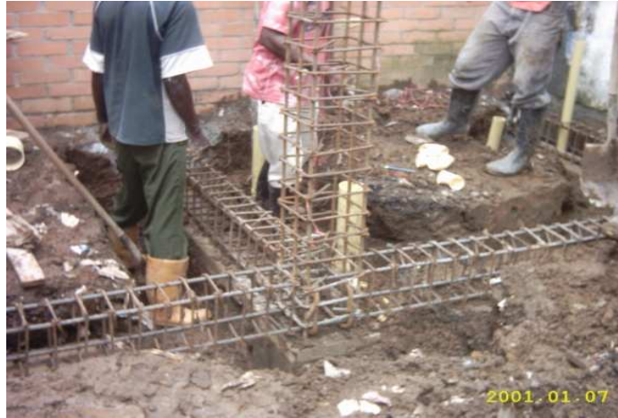
Foto 68. Vista del acero de refuerzo de las vigas de cimentación armado
