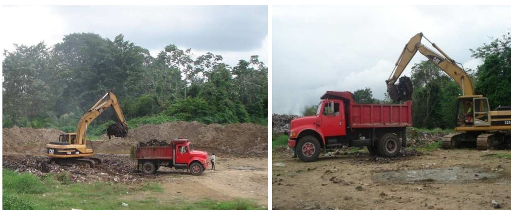
Foto 131 y 132. Proceso de desalojo de material
