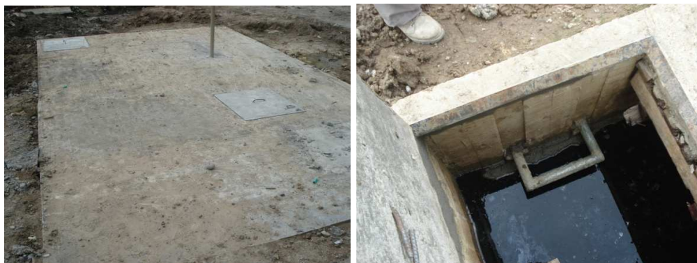
Foto 157 y 158. Vista de tanques terminados y en funcionamiento
