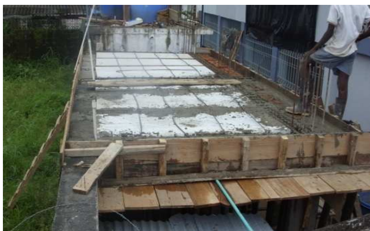
Foto 73. Proceso de construcción de la losa para tanques
