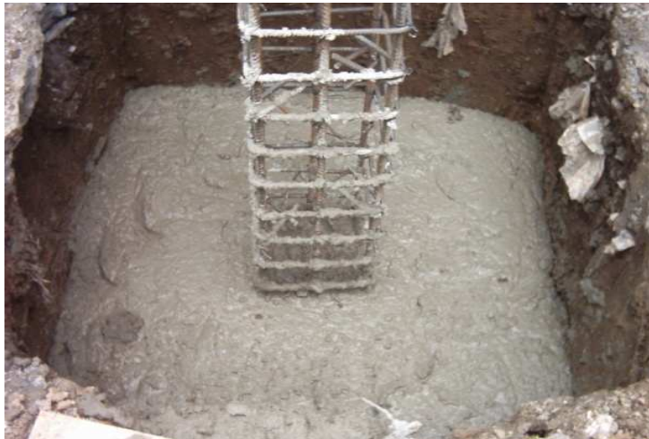
Foto 66. Zapatas fundidas en concreto
