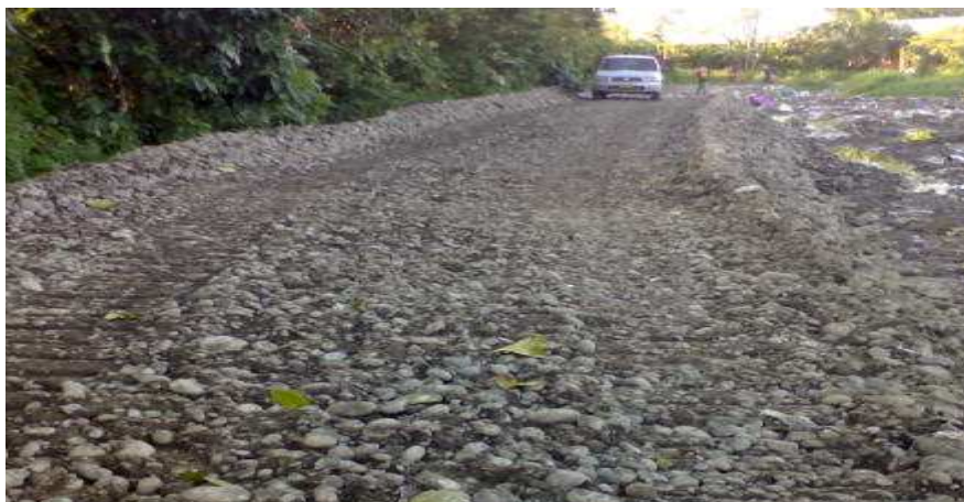
Foto 163. Vista de la vía de acceso terminada
