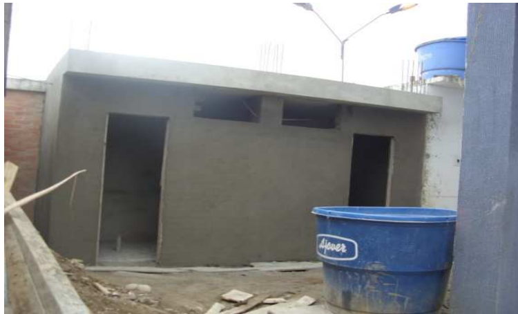
Foto 78. Repello afinado de muros
