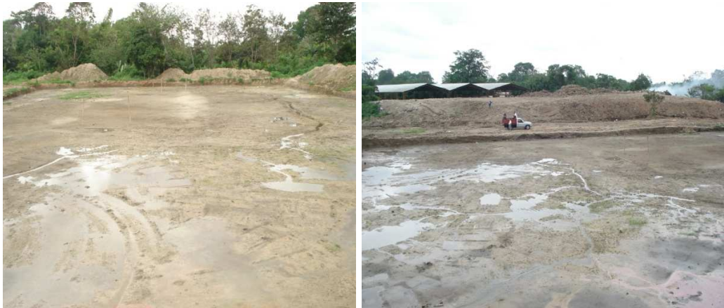
Foto 133 y 134. Terreno totalmente excavado
