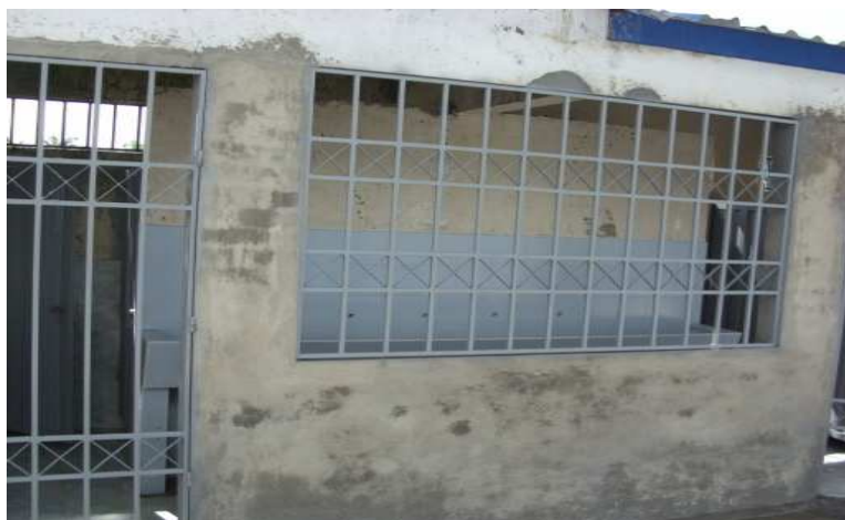
Foto 121. Muro con ventanales y puertas en carpintería metálica
