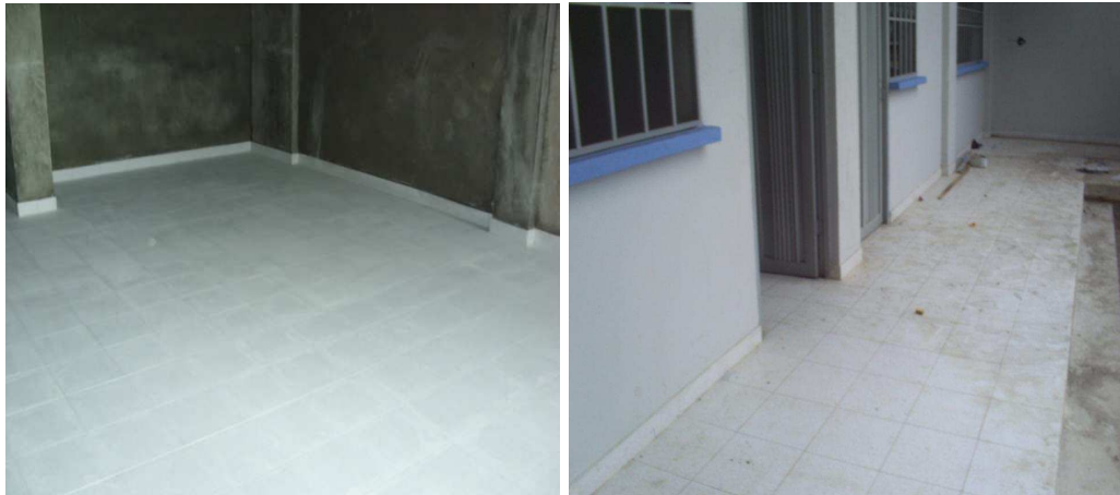
Foto 42 y 43. Instalación de pisos
