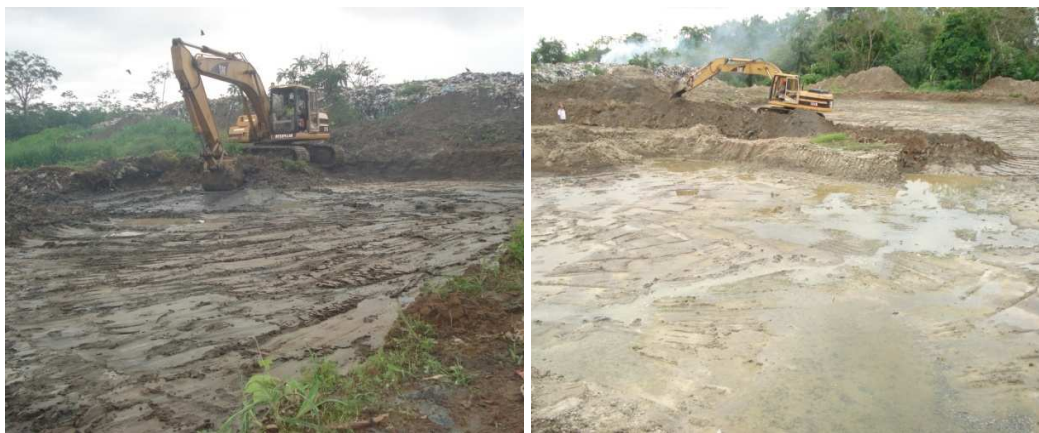
Foto 129 y 130. Proceso de excavación del terreno
