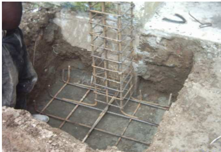
Foto 65. Parilla para zapatas antes de su instalación
