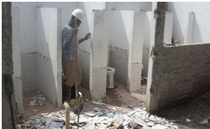
Foto 101. Vista de las demoliciones efectuadas
