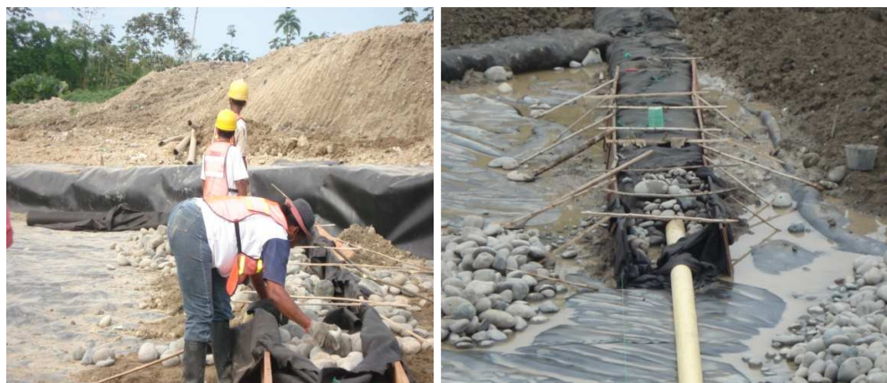
Foto 139 y 140. Construcción de filtro tipo A
