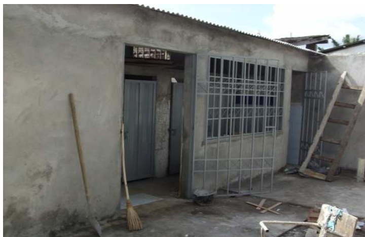
Foto 113. Carpintería metálica con pintura de acabado
