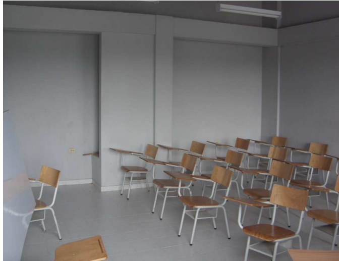
Foto 56. Pintura de muros internos
