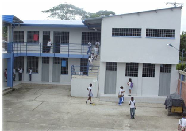
Foto 1. Bloque de aulas CERES terminado y en uso
