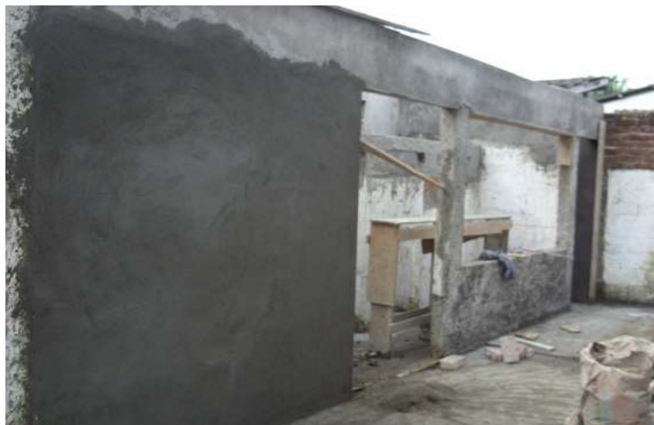
Foto 109. Proceso de pañetado de muros
