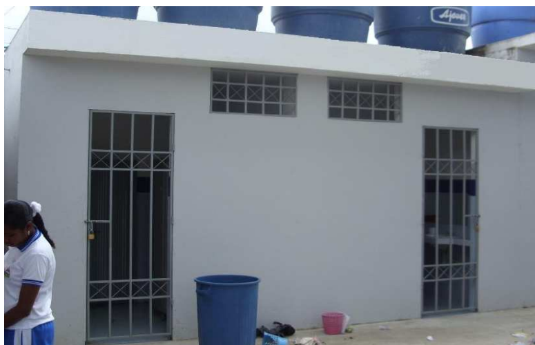
Foto 91. Pintura de acabado en vinilo tipo 1 o de protección a la intemperie
