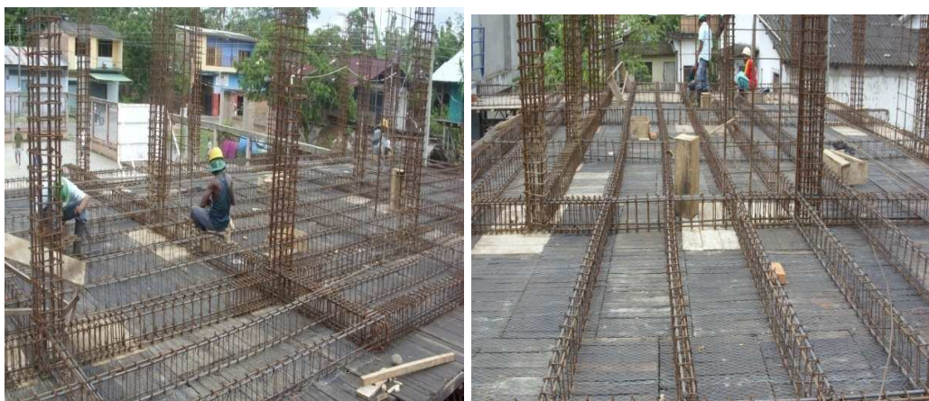
Foto 14 y 15. Acero de refuerzo de losa de entrepiso
