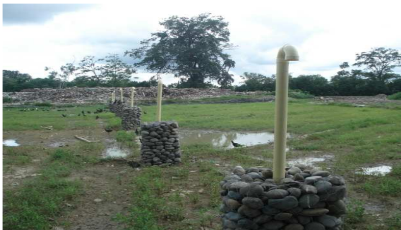
Foto 149. Remate de chimenea
