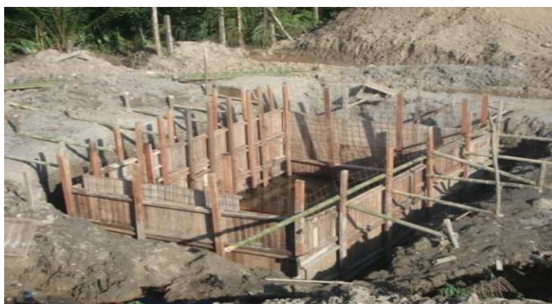
Foto 154. Proceso de construcción tanque para lixiviados
