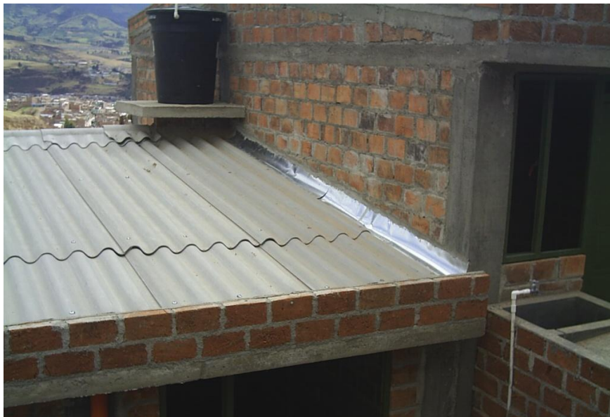
Figura 57. Cubierta de las viviendas
