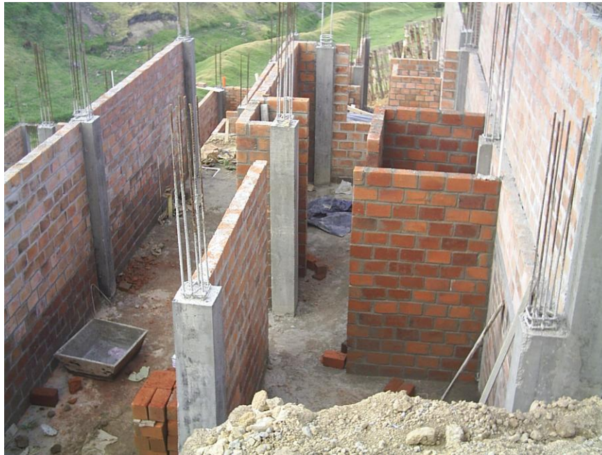
Figura 37. Ubicación vigas aéreas
