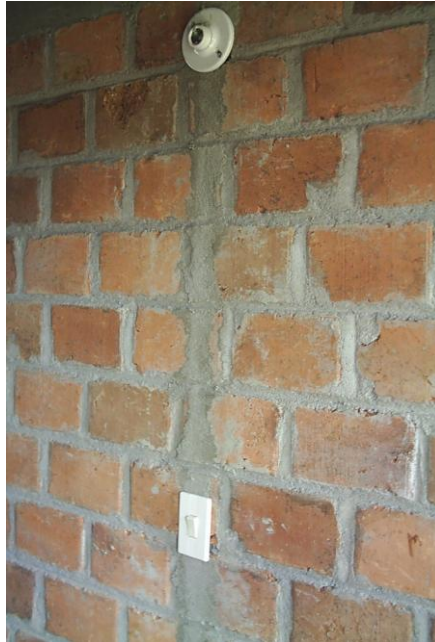
Figura 55. Colocación de accesorios eléctricos
