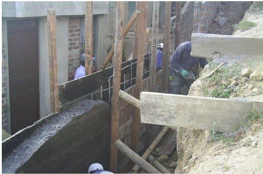
Figura 74. Formaleta para muro en concreto reforzado
