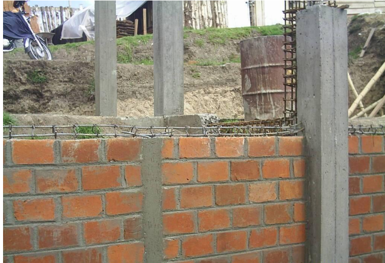
Figura 22. Sobrecimiento en ladrillo
