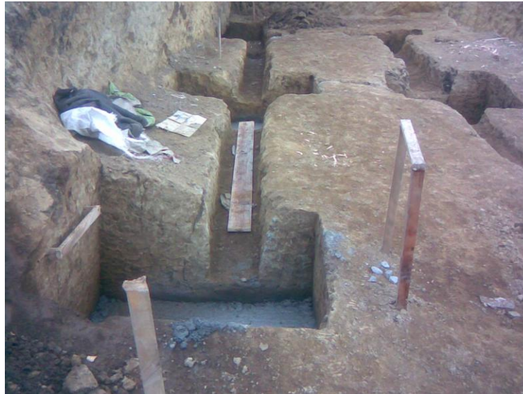
Figura 17. Solado de limpieza
