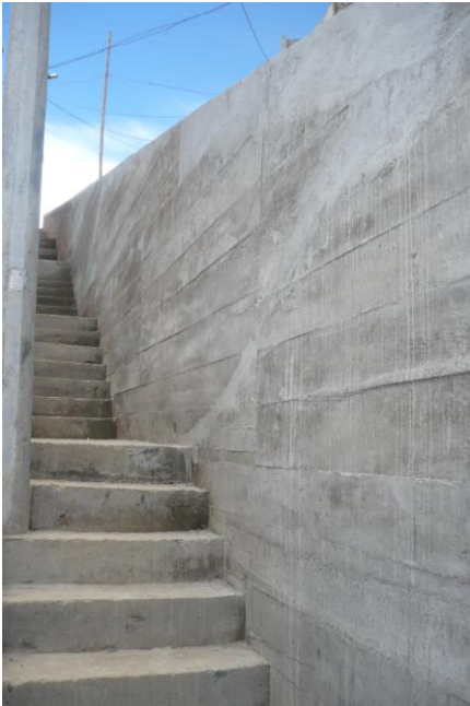
Figura 76. Elaboración de muros en mampostería
