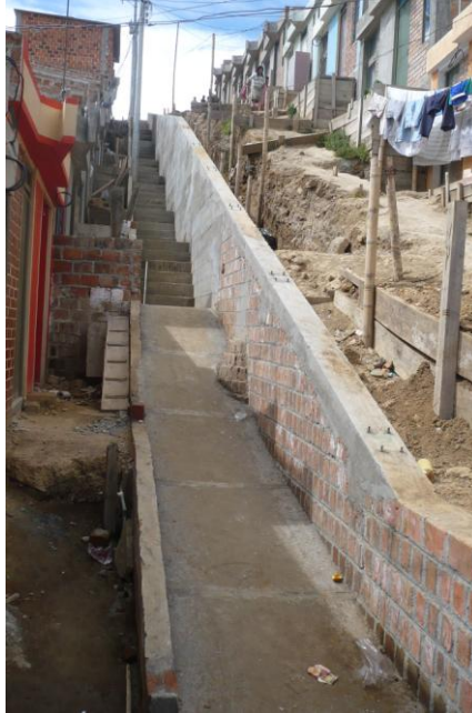
Figura 72. Terminación de andenes y escaleras
