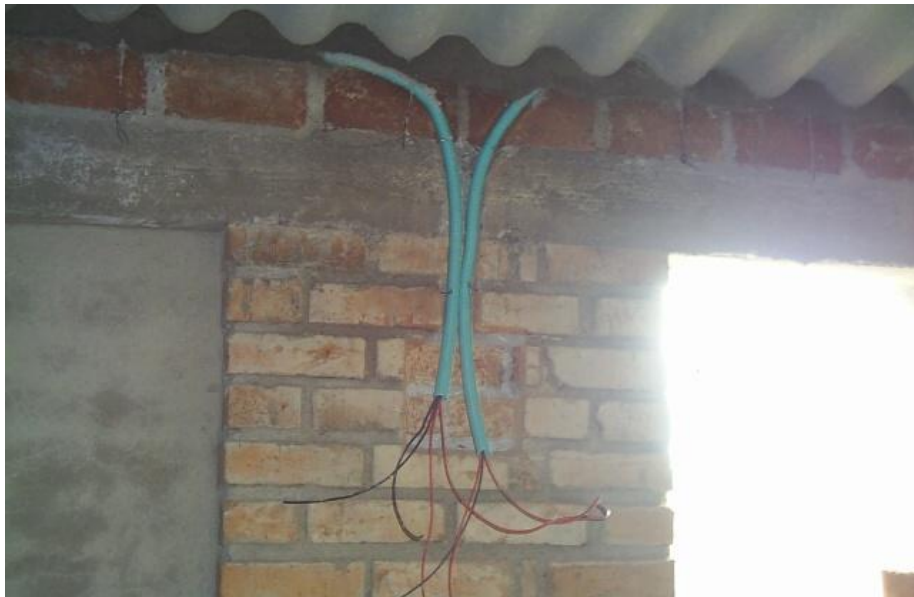
Figura 54. Instalación tablero de circuitos
