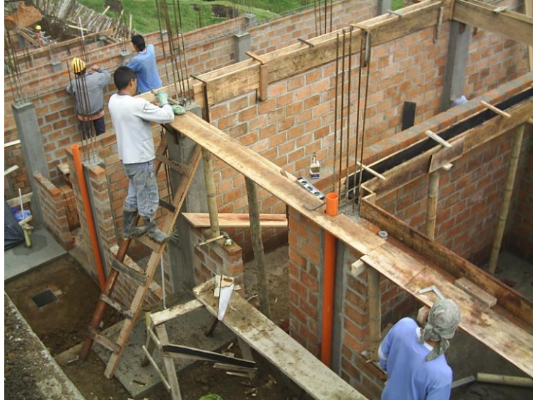
Figura 39. Formaleta general para vigas
