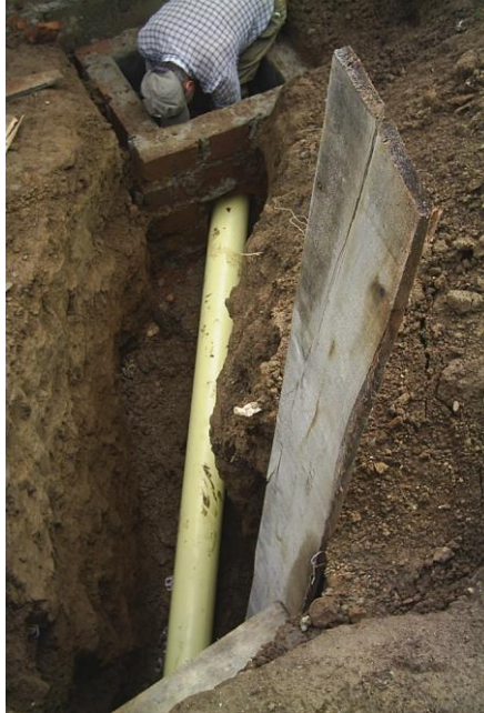
Figura 69. Nueva acometida sanitaria en tubería PVC
