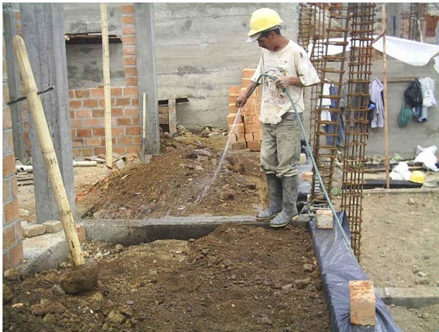
Figura 49. Preparación para la compactación de la base de contrapiso
