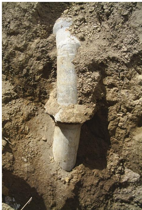
Figura 68. Acometida sanitaria existente en tubería de concreto
