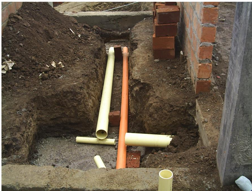
Figura 45. Instalación inicial de tubería sanitaria
