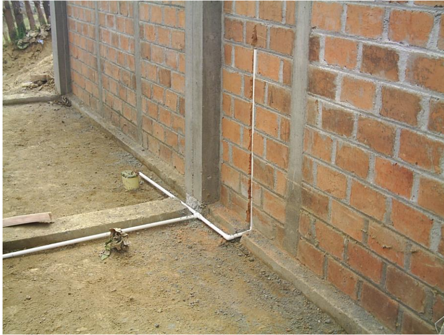
Figura 47. Regatas para instalaciones domiciliarias
