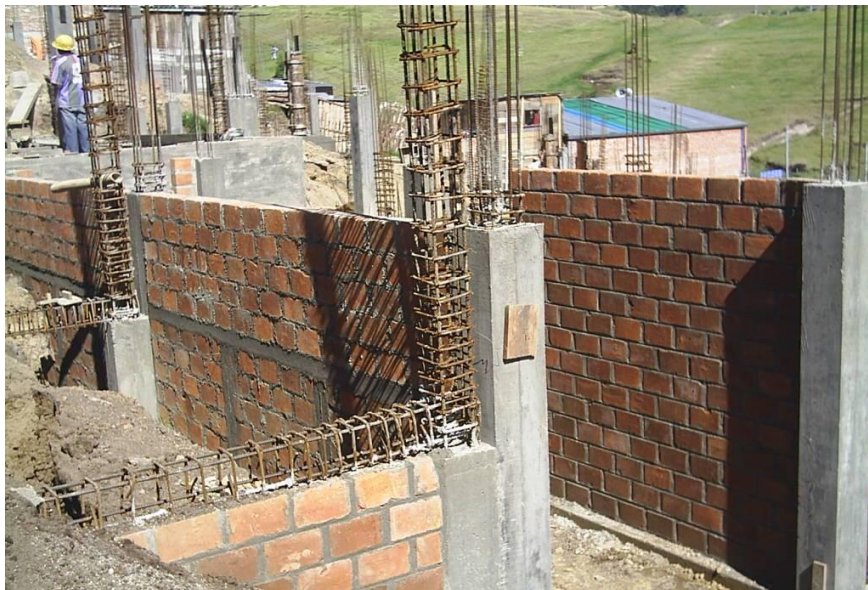
Figura 35. Enrasado de muros
