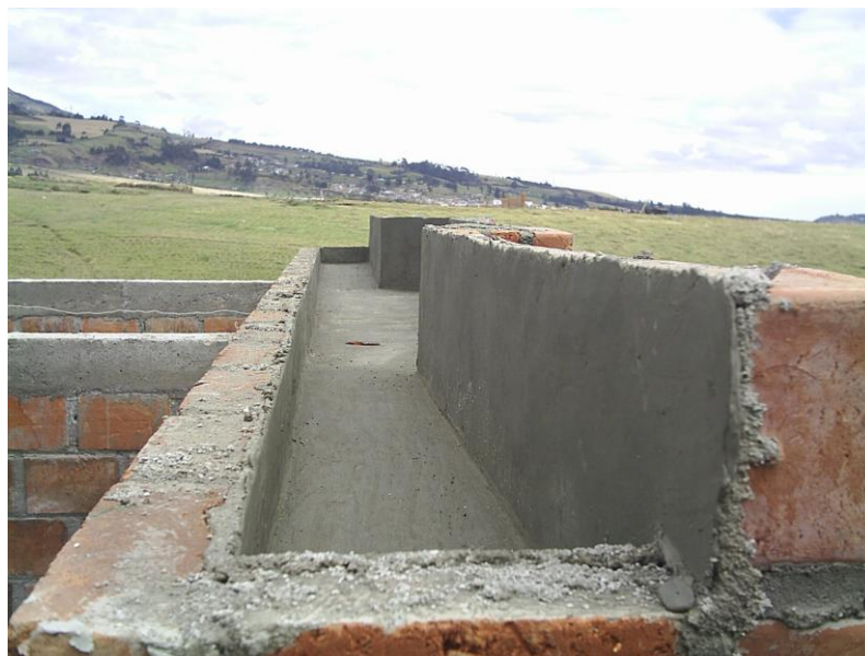
Figura 42. Viga canal terminada
