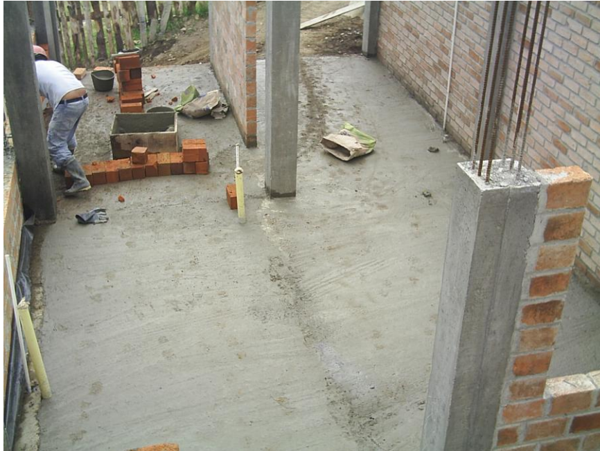
Figura 51. Placa de piso terminada
