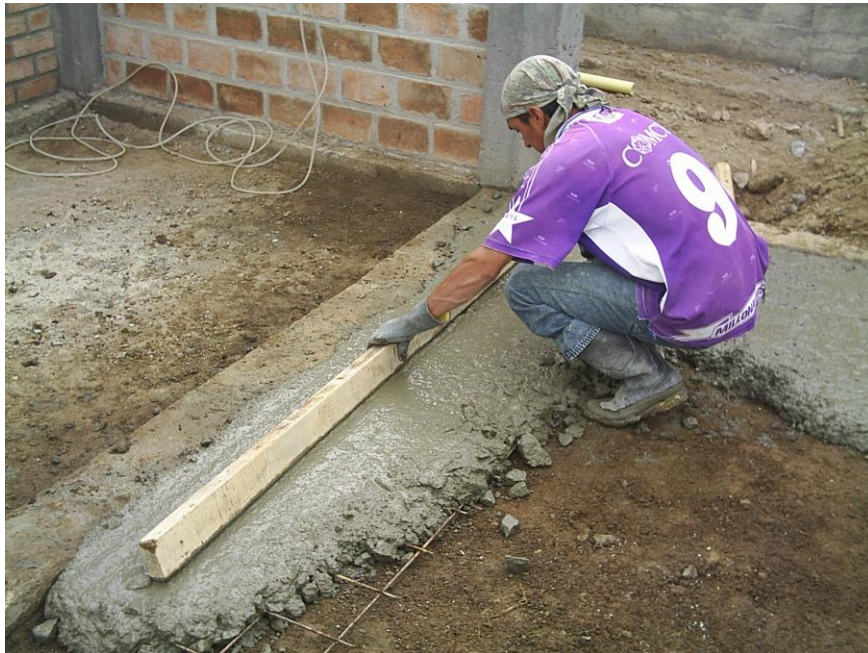
Figura 50. Vaciado de concreto para contrapiso
