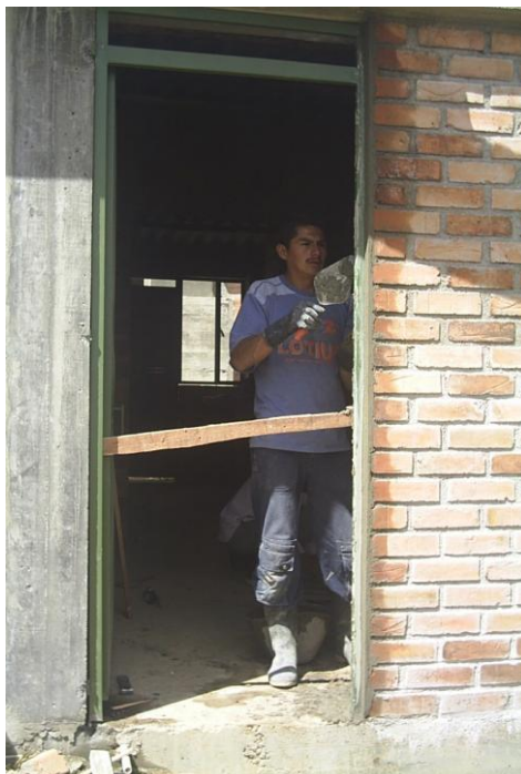
Figura 58. Instalación puerta principal metálica con chapa
