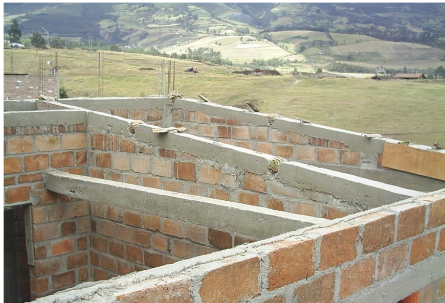
Figura 44. Cintas de amarre terminadas
