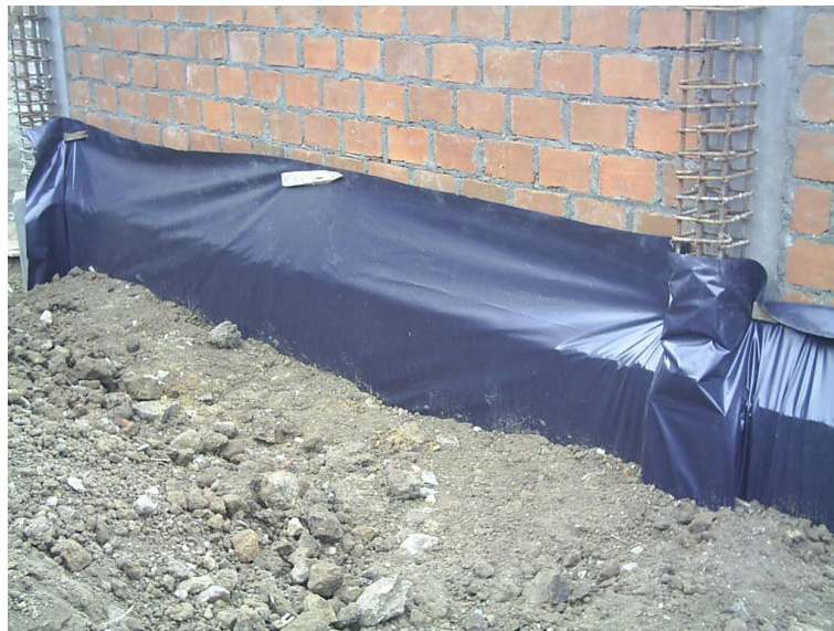
Figura 23. Colocación plástico de protección
