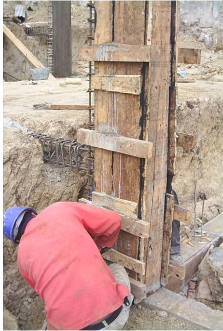
Figura 31. Conformación y revisión de formaletas para columnas
