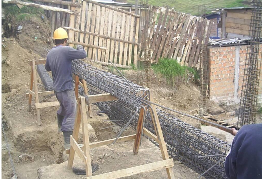
Figura 16. Figurado y armado del refuerzo para columna
