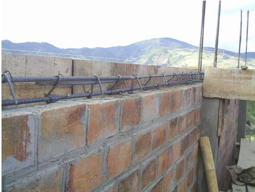
Figura 38. Montaje de refuerzos para vigas aéreas
