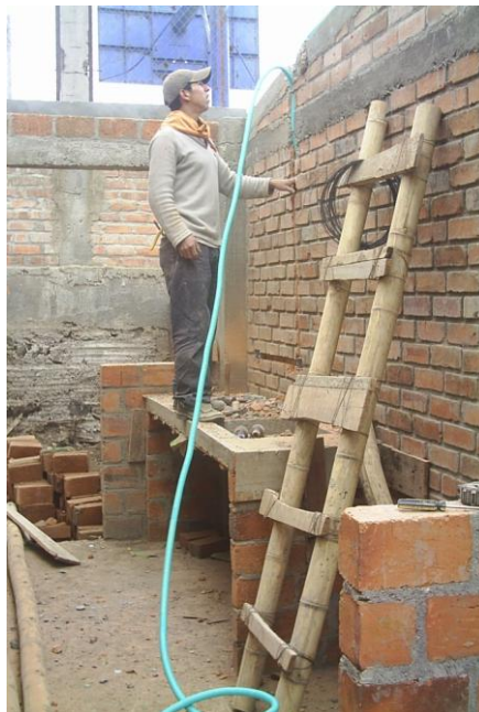
Figura 53. Regatas para instalaciones eléctricas
