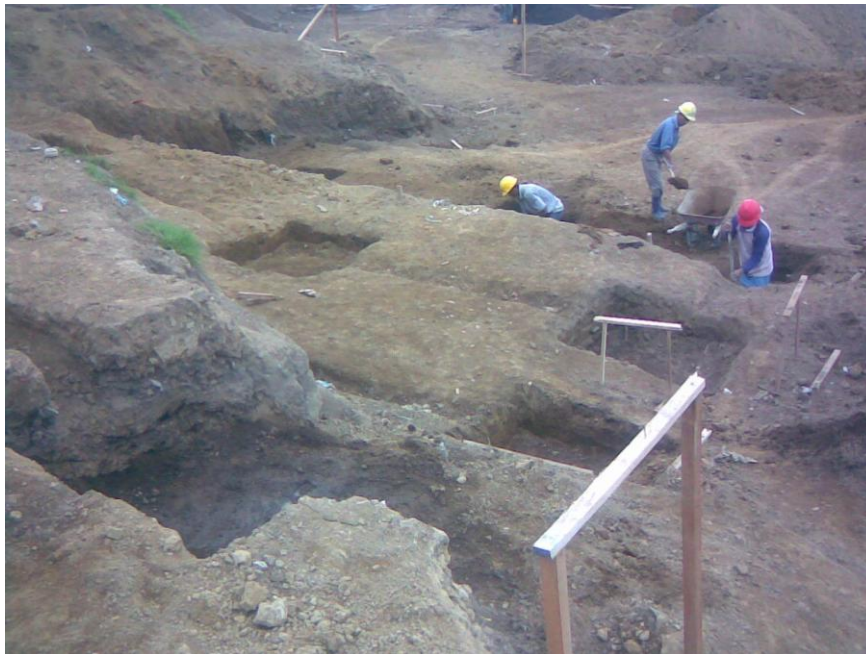
Figura 14. Excavaciones para cimentación
