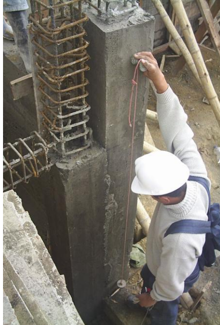
Figura 32. Revisión plomo columnas
