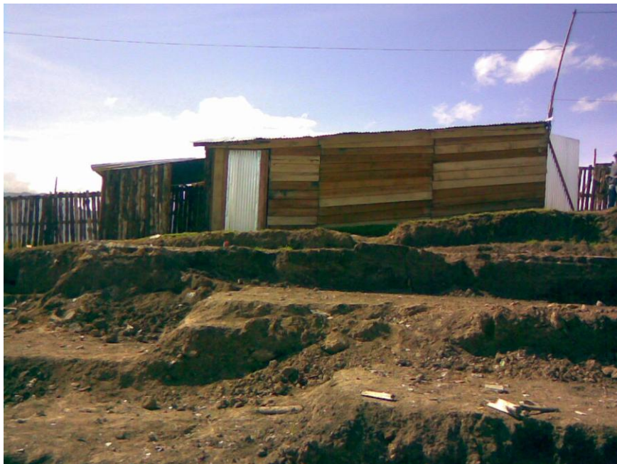
Figura 7. Campamento y cobertizo para madera
