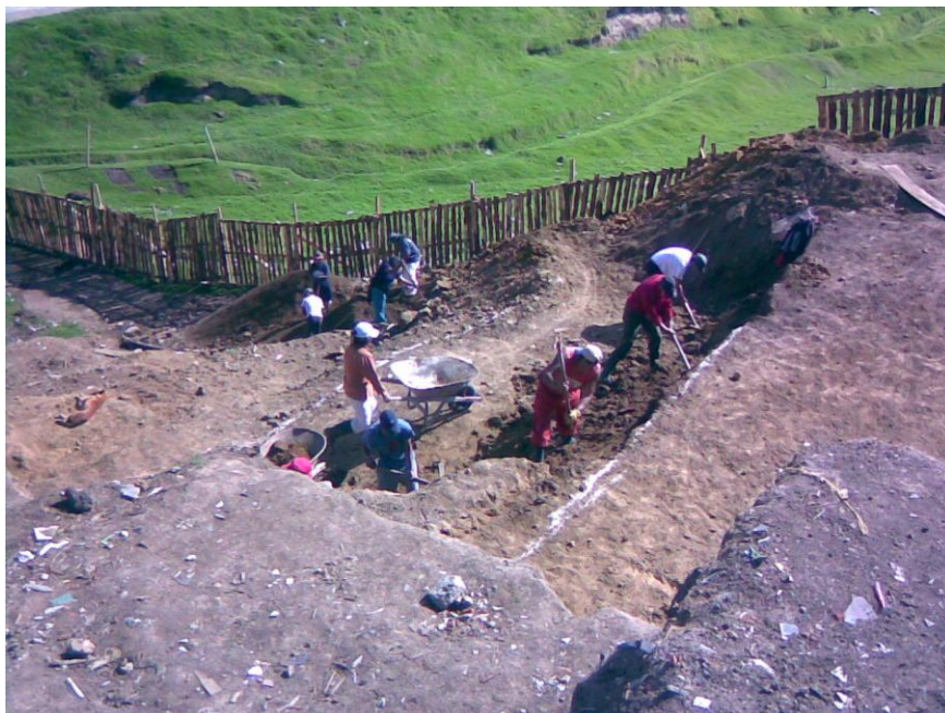
Figura 11. Limpieza y descapote
