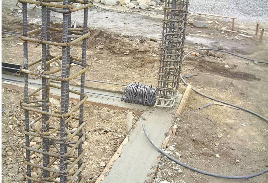
Figura 19. Armado y colocación de refuerzo para vigas de cimentación
