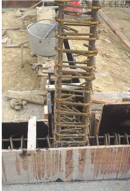
Figura 20. Colocación de la formaleta
