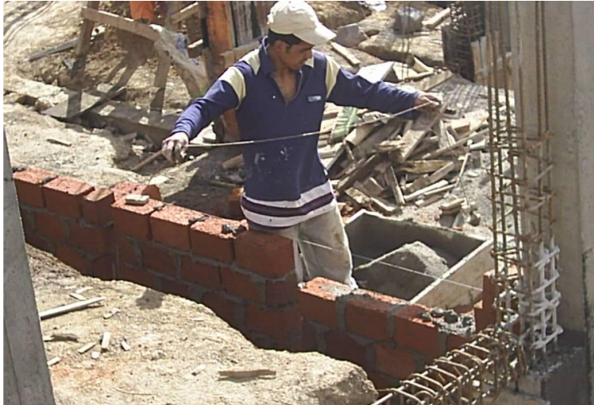
Figura 34. Elaboración de mampostería
