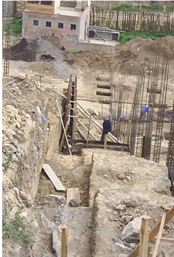
Figura 24. Excavaciones para la zarpa
