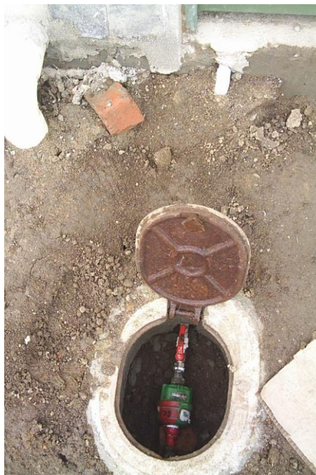
Figura 67. Medidor y bacinete instalados
