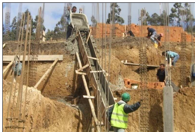
Figura 22. Canaleta de madera en forma de rampa para vaciar el concreto
