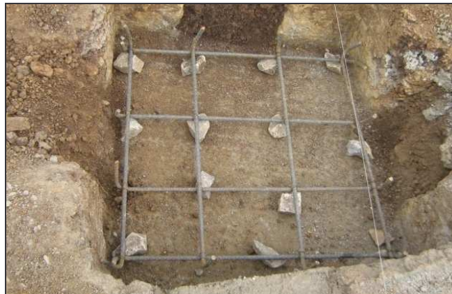
Figura 19. Colocación de la parrilla
