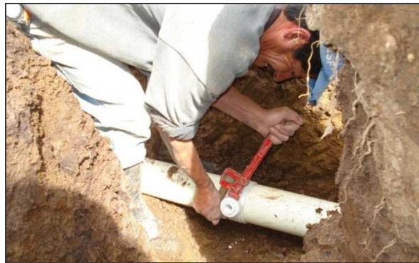
Figura 53. Instalación del collar de derivación
