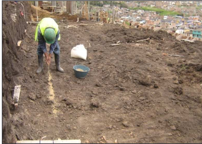
Figura 9. Localización y replanteo
