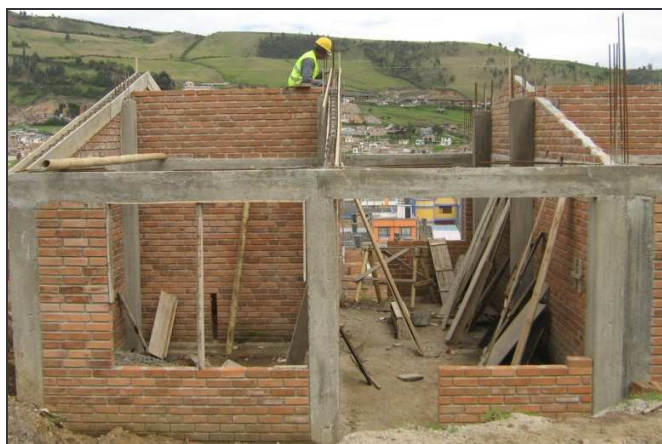
Figura 45. Encofrado de vigas cinta
