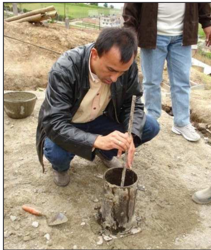
Figura 73. Compactación de capas de concreto
