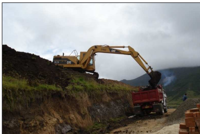
Figura 10. Cargue y desalojo de tierra
