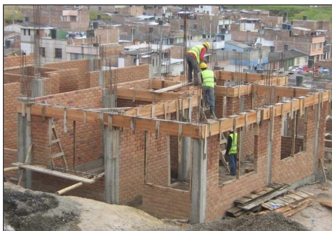
Figura 42. Fundición de vigas aéreas
