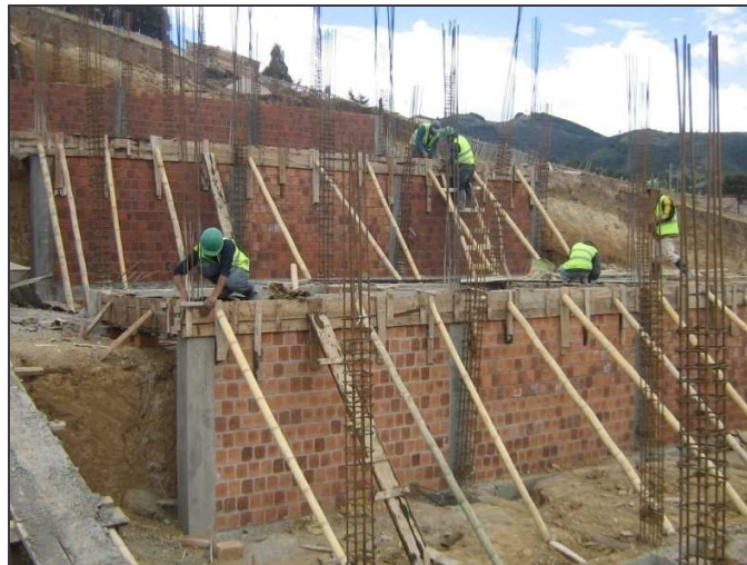
Figura 39. Muros en tizón para contención de terrazas
