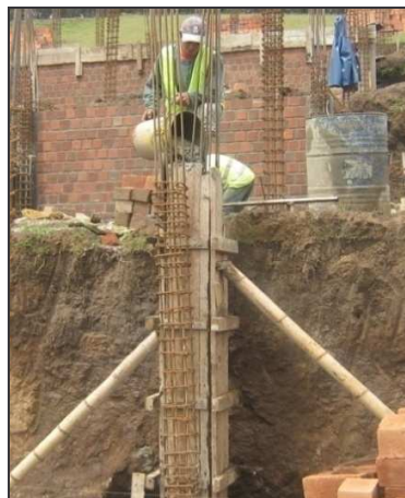
Figura 34. Fundición de columnas
