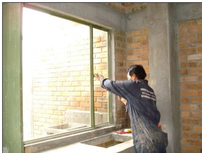
Figura 71. Instalación de vidrios
