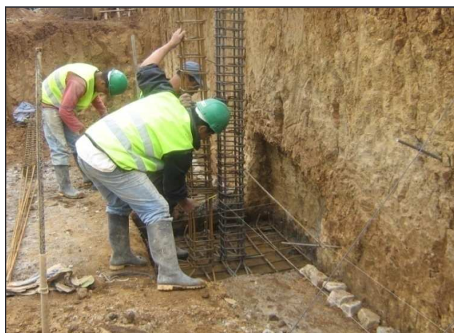
Figura 20. Colocación del refuerzo de la columna
