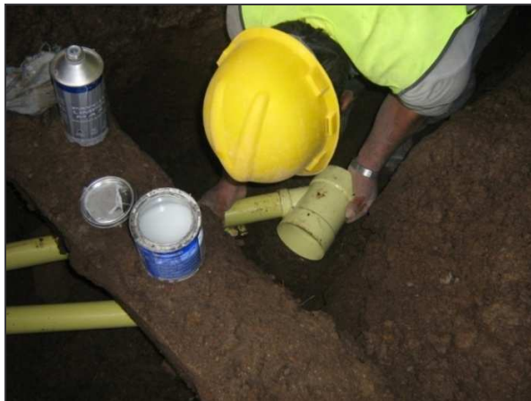
Figura 48. Instalación de tubería sanitaria
