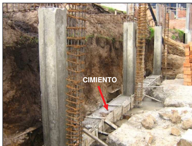
Figura 30. Cimiento en concreto ciclópeo para muro en tizón para contención de terraza
