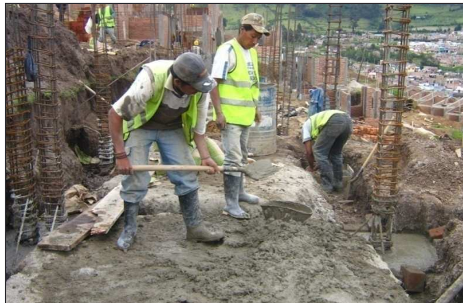
Figura 23. Elaboración manual del concreto
