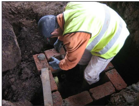
Figura 50. Elaboración de cajas de inspección
