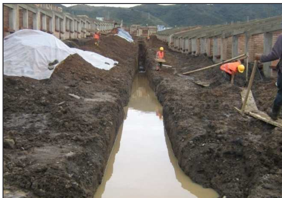
Figura 4. Obras de alcantarillado en la carrera 32A
