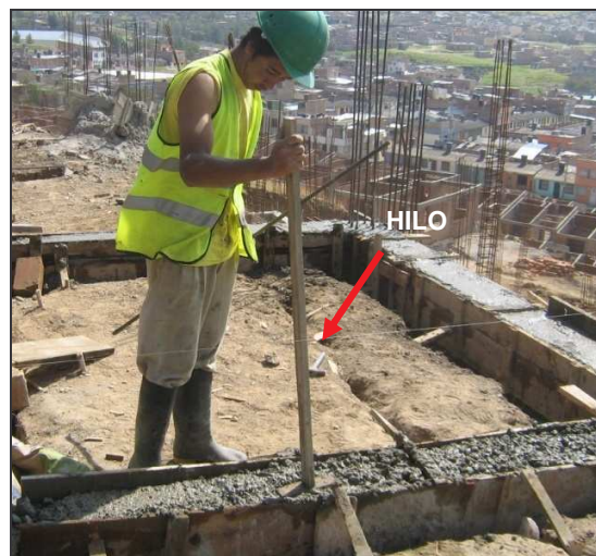
Figura 28. Fundición de vigas de cimentación
