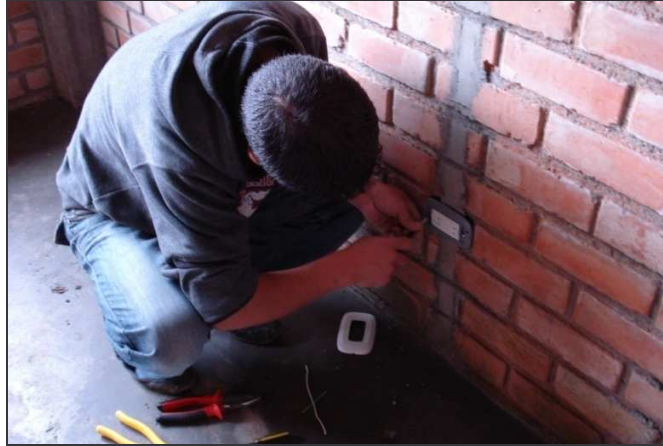
Figura 58. Instalación de apliques
