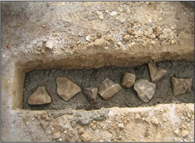
Figura 31. Cimiento en concreto ciclópeo para muros divisorios
