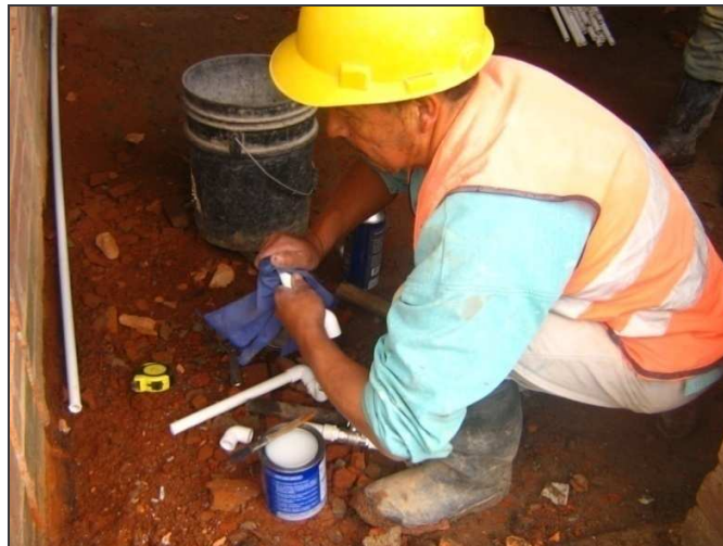
Figura 52. Instalación de tubería de presión
