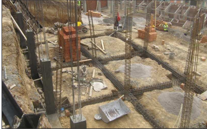
Figura 26. Refuerzo de vigas de cimentación
