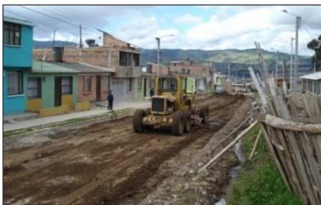
Figura 77. Escarificación en la carrera 32
