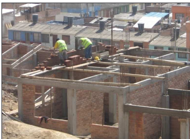
Figura 38. Construcción de muros tímpano
