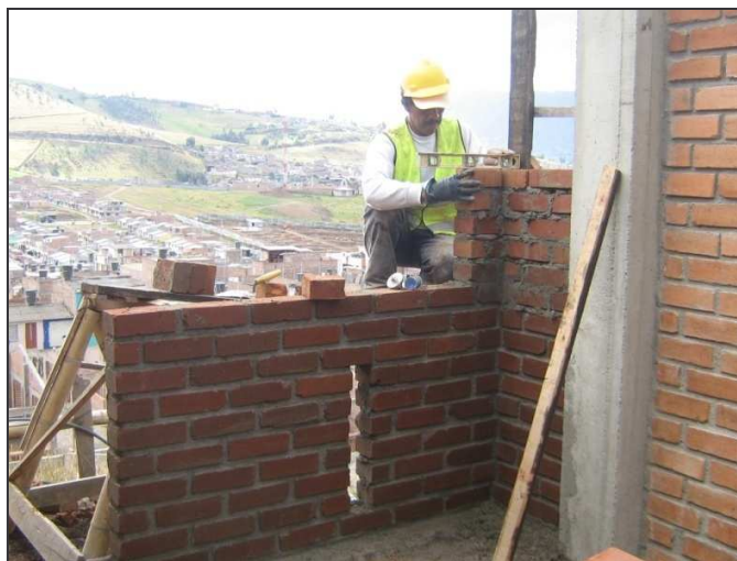
Figura 37. Nivelación de muros
