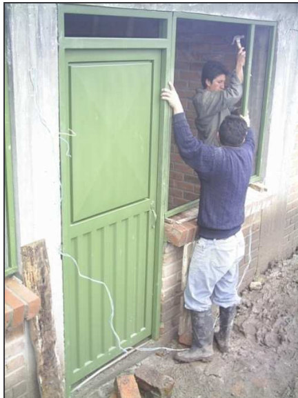
Figura 67. Instalación de puerta y ventana metálica
