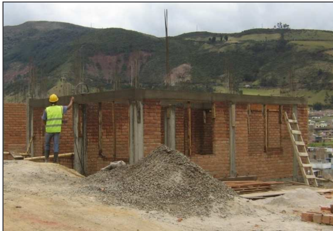
Figura 44. Curado de vigas aéreas
