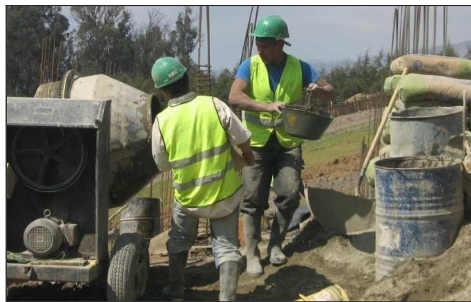
Figura 21. Elaboración del concreto con mezcladora
