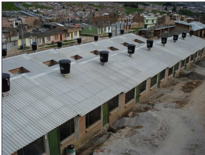
Figura 62. Cubiertas de las viviendas
