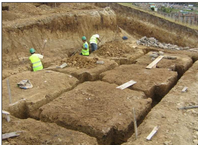
Figura 11. Excavación para cimentación
