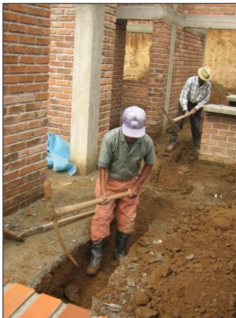
Figura 12. Excavación para instalación sanitaria
