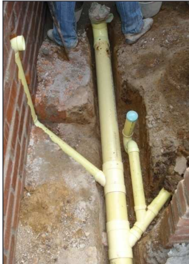
Figura 47. Tendido de tuberías sanitarias
