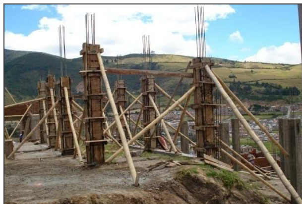
Figura 33. Encofrado de columnas
