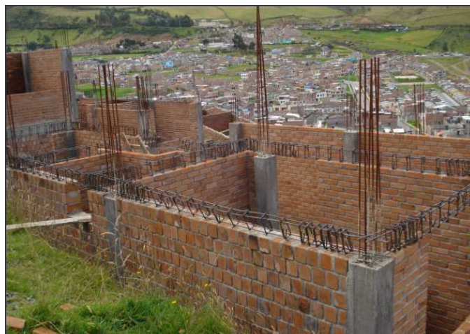
Figura 40. Armado de refuerzo de vigas aéreas
