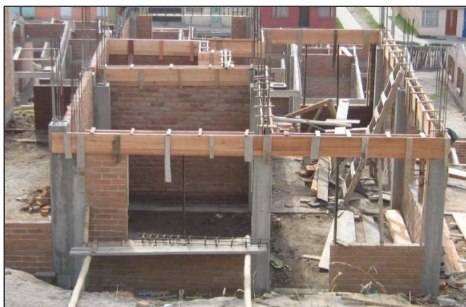
Figura 41. Encofrado de vigas aéreas
