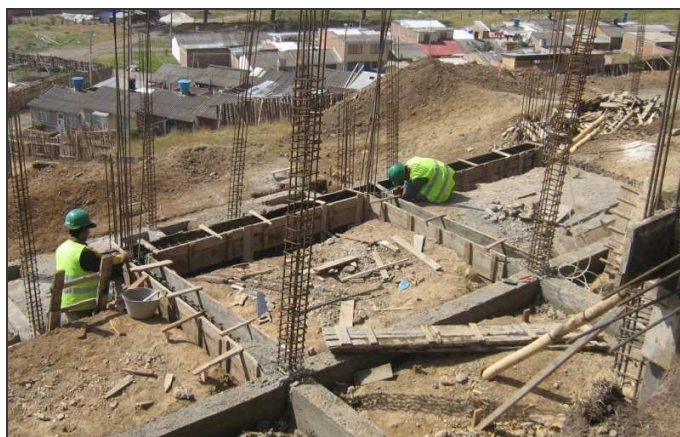
Figura 27. Encofrado de vigas de cimentación
