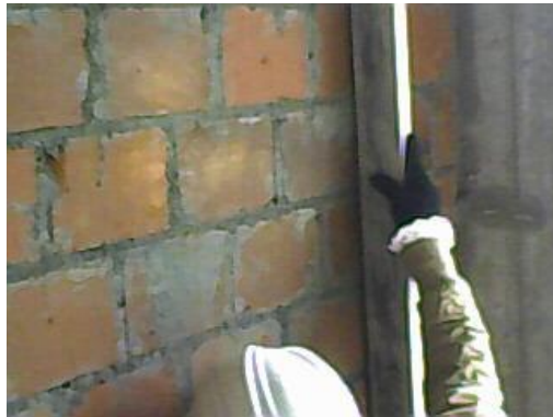
Foto 92. Inspección con codal.
