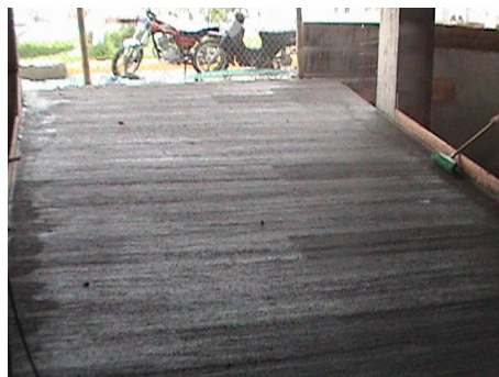
Foto 81. Terminado de rampa
