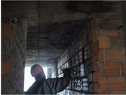
Foto 96. Preparación de superficie.
