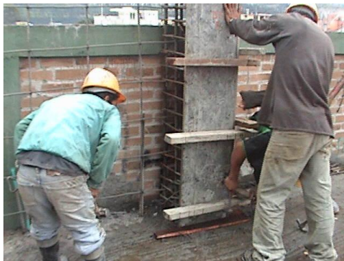
Foto 45. Formaleta de columna
