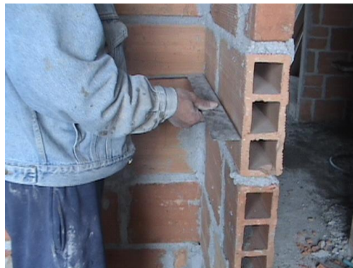
Foto 93. Inspección con escuadra.
