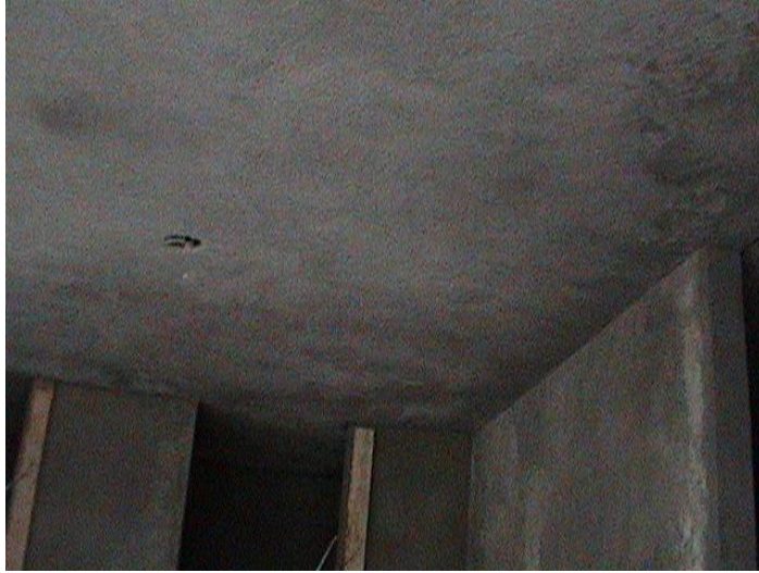
Foto 102. Terminado de repello de cielo raso.
