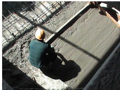
Foto 80. Fundición de rampa.
