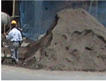
Foto 5. Agregados a utilizados en obra. Arena negra.
