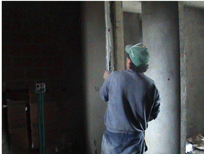
Foto 104. Inspección con codal.
