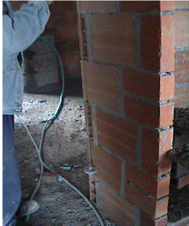
Foto 94. Inspección con ploma.
