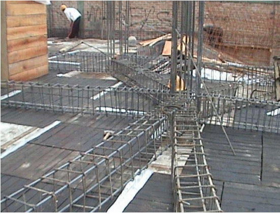
Foto 58. Vigas de entrepiso
