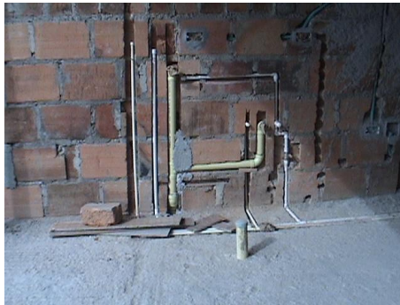
Foto 87. Tubería de instalaciones hidrosanitarias en muros.
