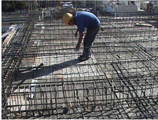
Foto 61. Refuerzo de losa.
