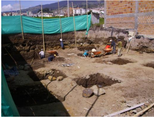
Foto 25. Excavación para zapatas.
