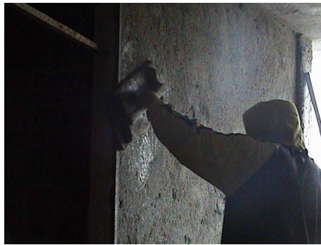
Foto 100. Terminado con llana de madera en muros.
