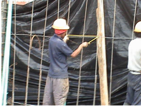
Foto 43. Armado de pantallas.
