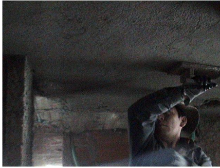
Foto 99. Terminado con llana de madera en cielo raso.
