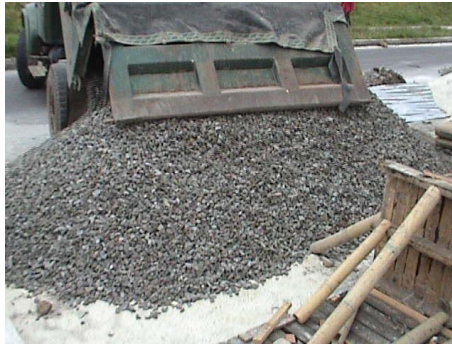
Foto 6. Agregados a utilizados en obra. Triturado seleccionado.
