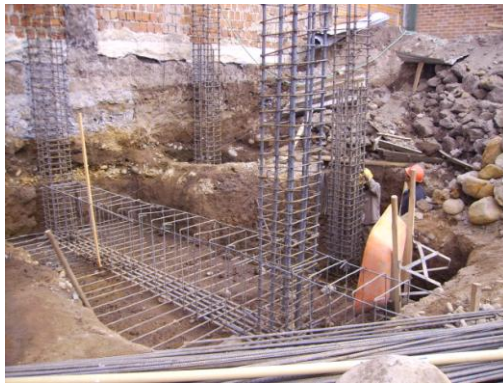
Foto 32. Viga de contrapeso
