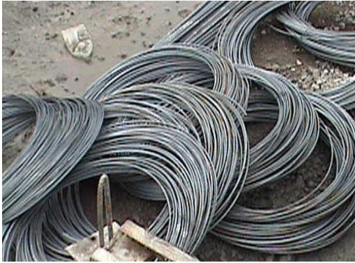
Foto 9. Acero de refuerzo a utilizar en obra. Chipas de 3/8”.
