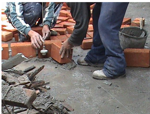
Foto 89. Ejecución de hilada inicial de muro
