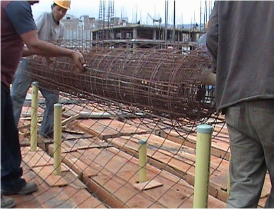
Foto 67. Colocación malla electrosoldada.
