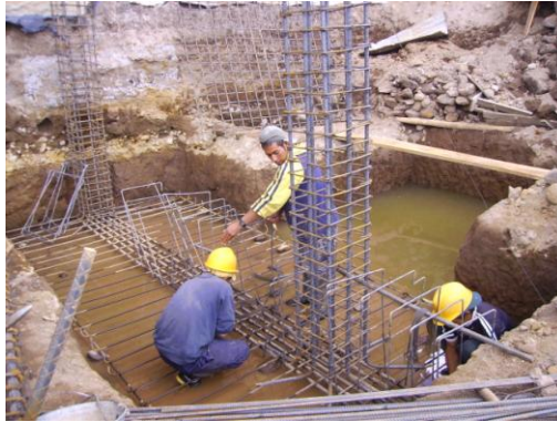
Foto 31. Armado de viga.
