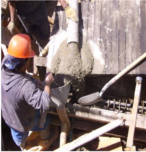
Foto 38. Fundición de viga de cimentación
