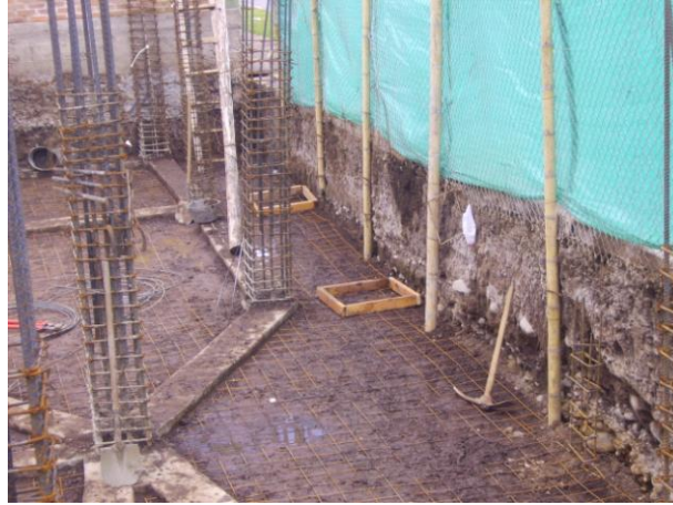
Foto 40. Colocación de malla electrosoldada
