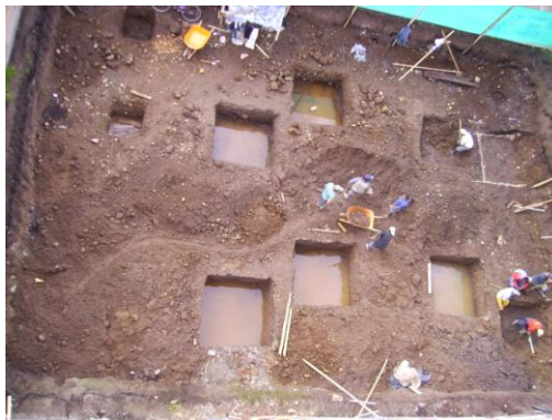
Foto 26. Panorámica de excavación.
