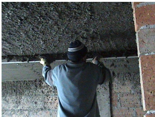
Foto 98. Nivelación con codal de mortero.
