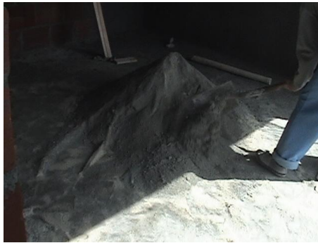
Foto 95. Relación arena – cemento.
