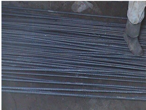
Foto 8. Acero de refuerzo a utilizar en obra. Acero de refuerzo.
