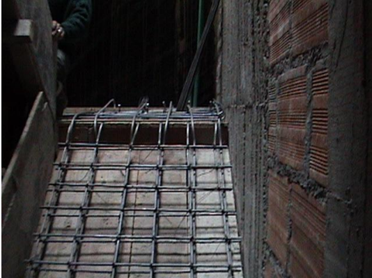
Foto 75. Armado de refuerzo.
