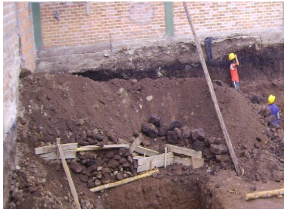
Foto 29. Material excavado y desalojado.
