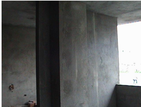
Foto 101. Terminado de repello de muro.
