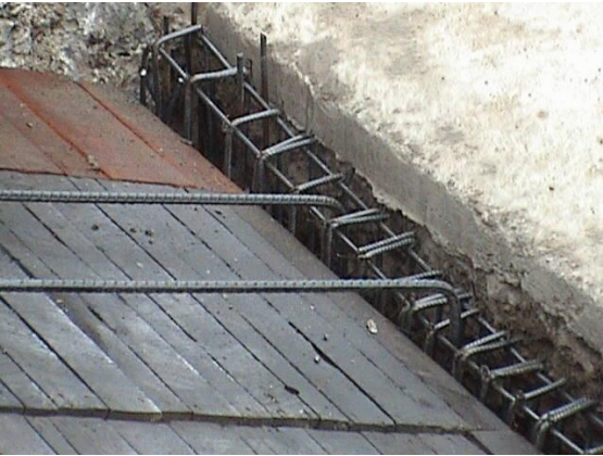
Foto 74. Armado de viga.
