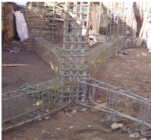
Foto 37. Refuerzo vigas de cimentación.
