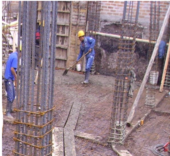
Foto 41. Fundición placa de piso.
