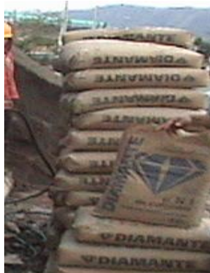
Foto 4: Cemento a utilizar en obra.
