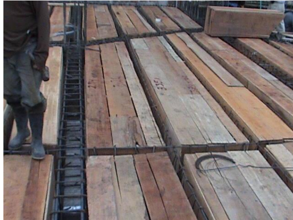
Foto 64. Colocación de casetones
