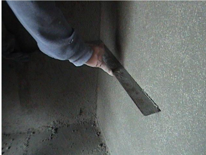
Foto 103. Inspección de escuadra.
