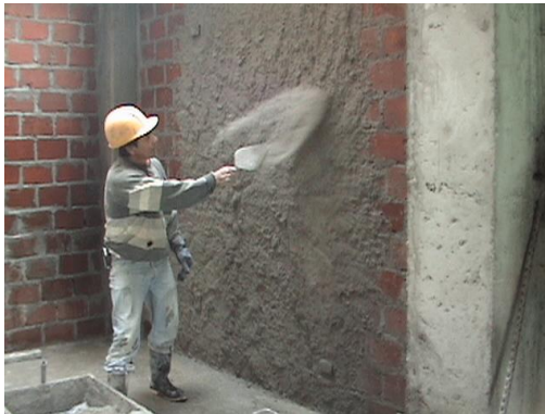
Foto 97. Aplicación de mortero.
