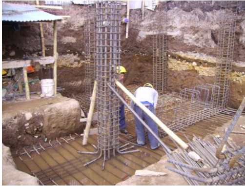
Foto 33. Anclaje de castillos de columnas.
