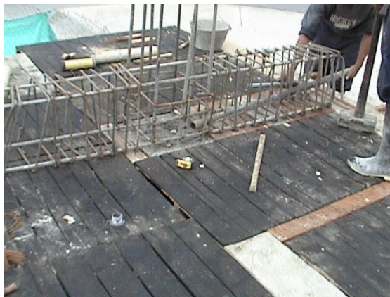
Foto 57. Armado de vigas
