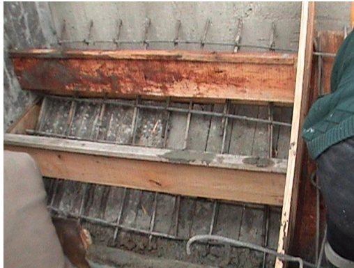
Foto 76. Formaleta de escaleras.
