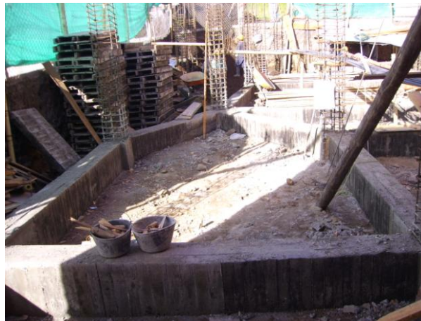
Foto 39. Viga de cimentación.
