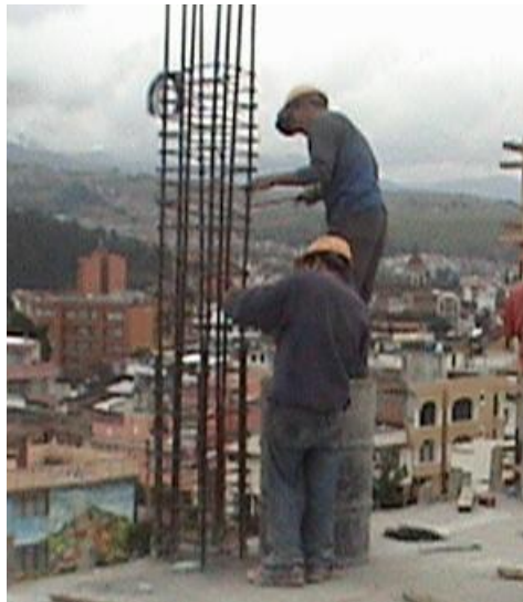
Foto 42. Armado de columnas.
