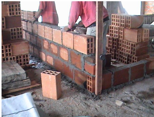
Foto 90. Pega de ladrillo.
