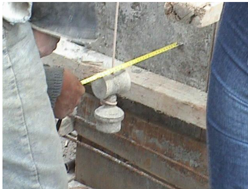
Foto 53. Revisión de verticalidad.
