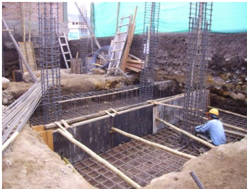
Foto 34. Formaleta de zapata.
