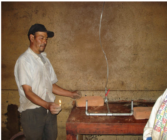
Foto 23: Se instala la T y los quemadores
