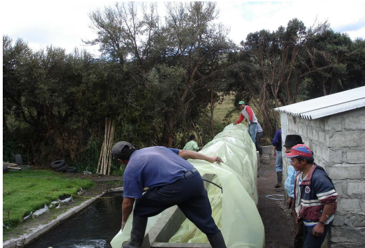
Foto 20: Se instala la cubierta del biodigestor Fuente: Esta investigación
