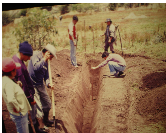
Foto 11: Excavación. Fuente: Corponariño
