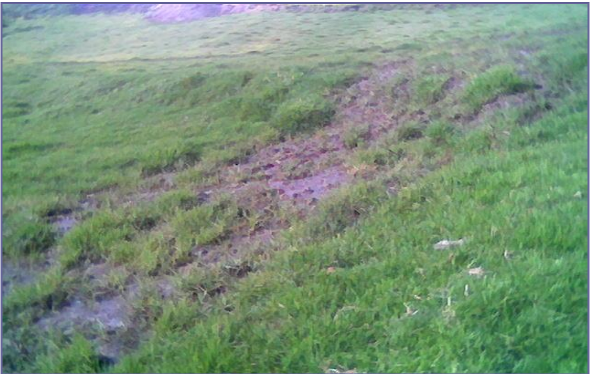
FIGURA No. 20 PUNTO DE VERTIMIENTO DE AGUAS RESIDUALES, USO ACTUAL DEL AGUA PECUARIO. MADROÑERO, ALEJANDRA. 2006.
