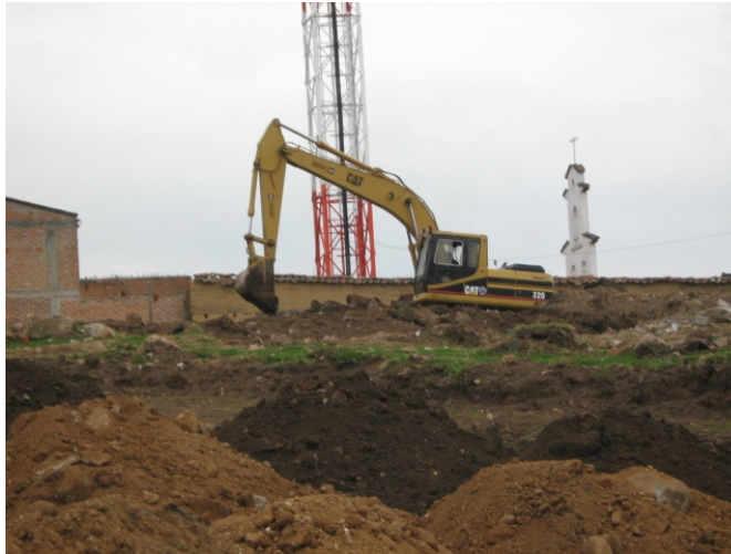
Foto 21. Retroexcavadora utilizada en la excavación
