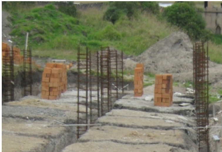
Foto 34. Armado de refuerzo en columnas
