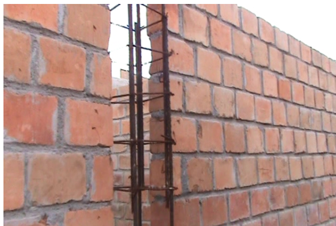
Foto 13. Ejecución de traslapos al 100% en la misma zona
