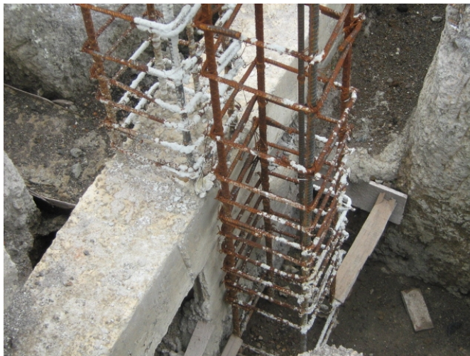
Foto 33. Detalle fundición de cimentación
