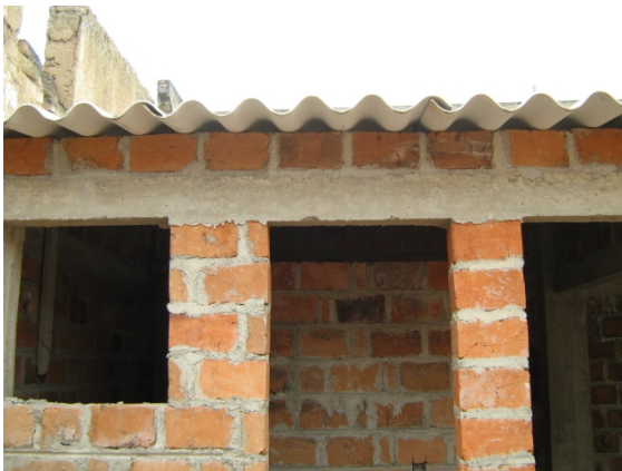
Foto 41. Vigas aéreas terminadas
