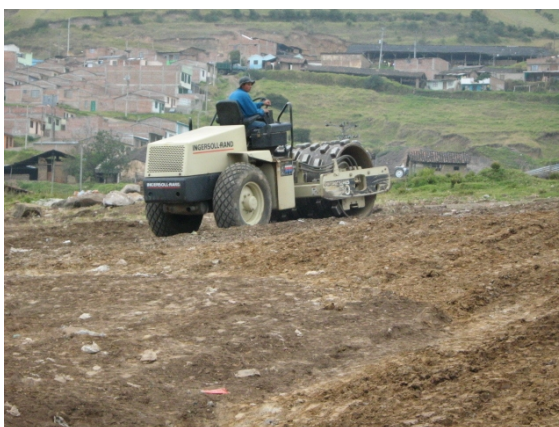
Foto 23. Compactación del terreno
