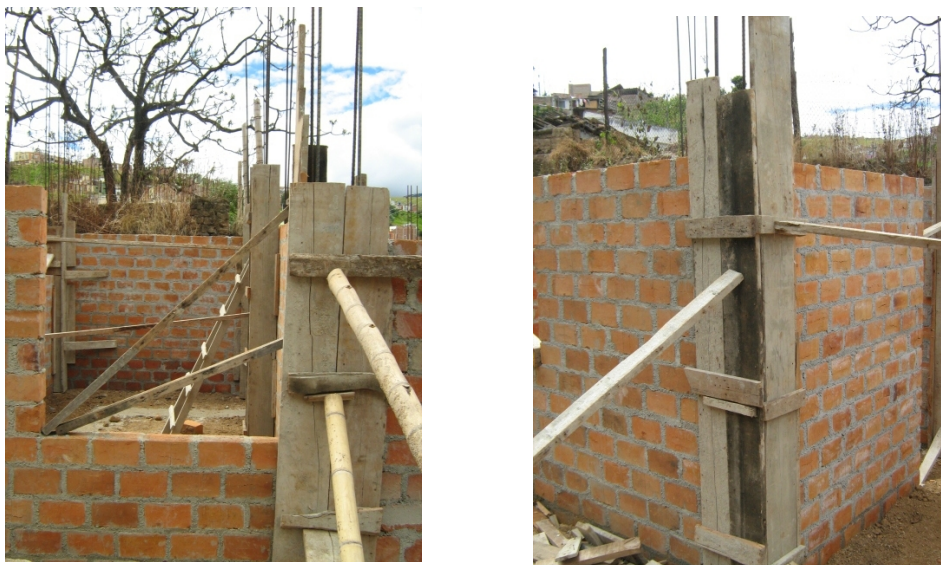
Foto 35. Encofrado de columnas
