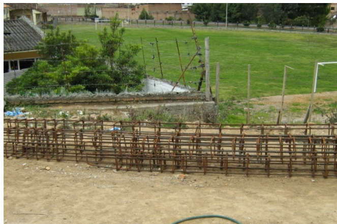
Foto 29. Armadura de refuerzo
