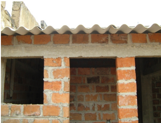
Foto 45. Colocación teja de asbesto cemento
