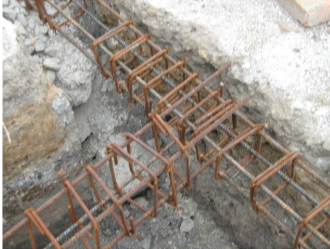
Foto 32. Detalle vigas de cimentación
