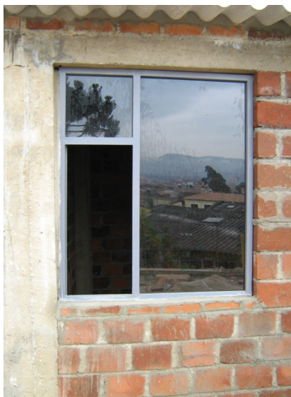
Foto 42. Colocación de puertas y ventanas
