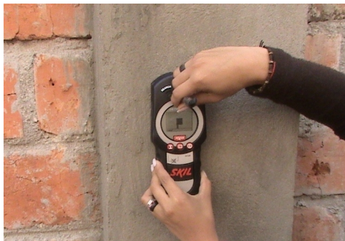
Foto 15. Localización del refuerzo mediante detector de metales
