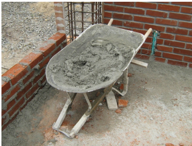
Foto 39. Mortero de pega
