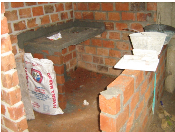
Foto 43. Construcción mesón de cocina
