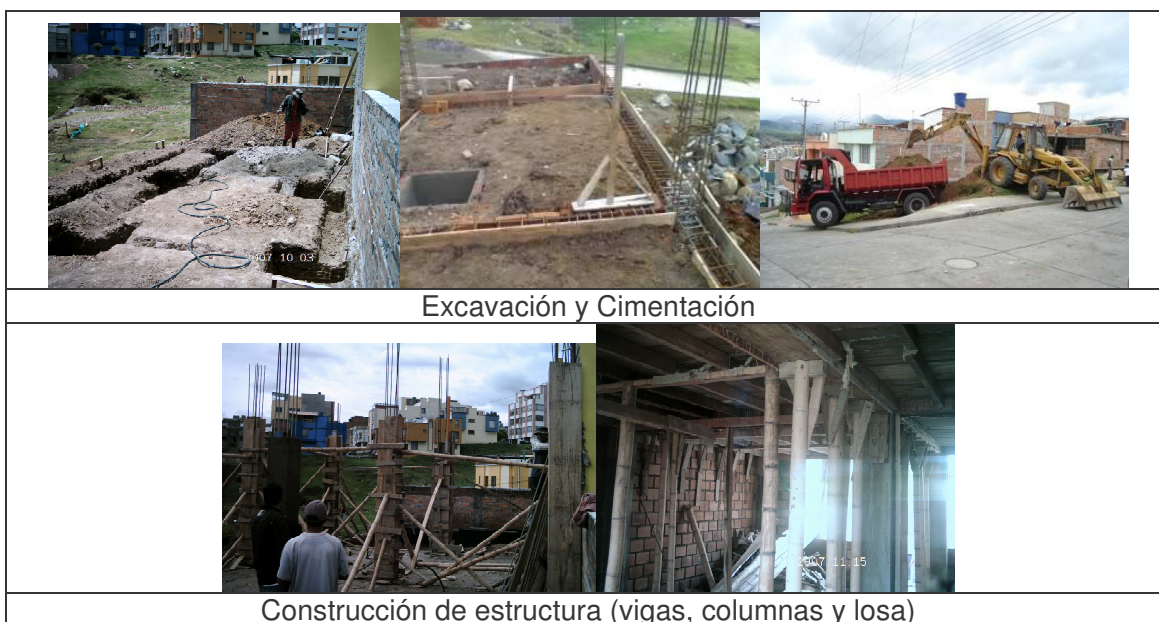
Figura 17. Apoyo técnico en construcciones de viviendas en el barrio Quintas de San Pedro.
