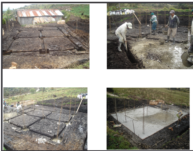
Figura 13. Localización, replanteo y excavación para cimentación e instalaciones sanitarias, fundición de solados, zapatas y placa en concreto para piso.
