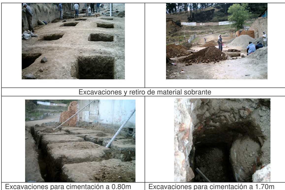
Figura 5. Excavaciones para cimentación urbanización San Gabriel.
