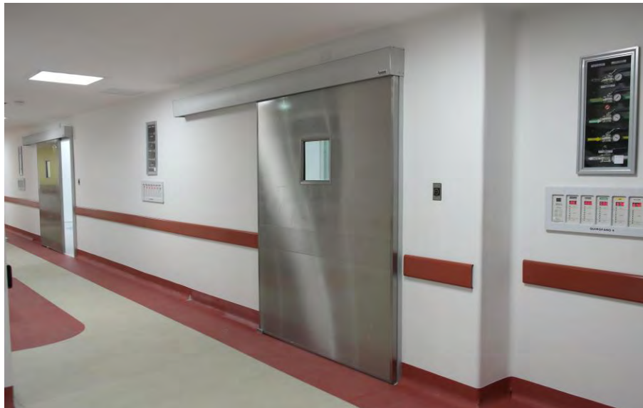
Figura 33. Puertas automáticas deslizables al tacto
