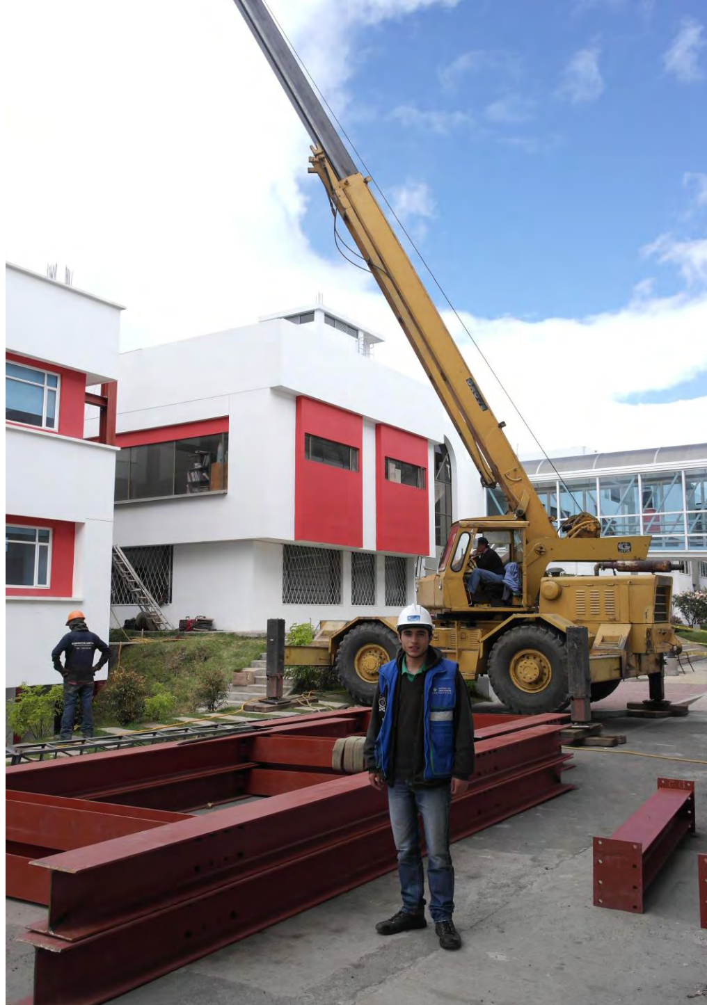
Figura 22. Izado de Columnas y vigas de ascensor con Grúa P Y H.
