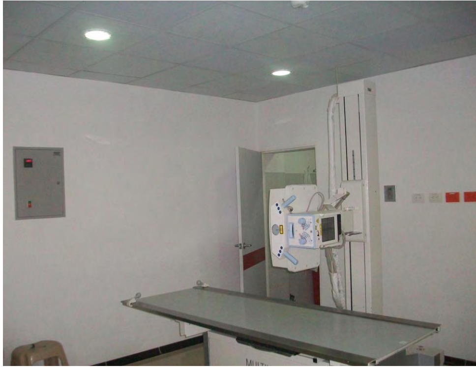
Figura 5. Muros plomados terminados en rayos X.
