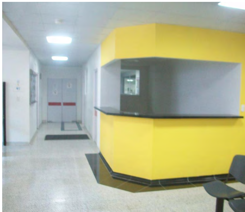
Figura 46. Pintura epóxica y protector contra impactos
