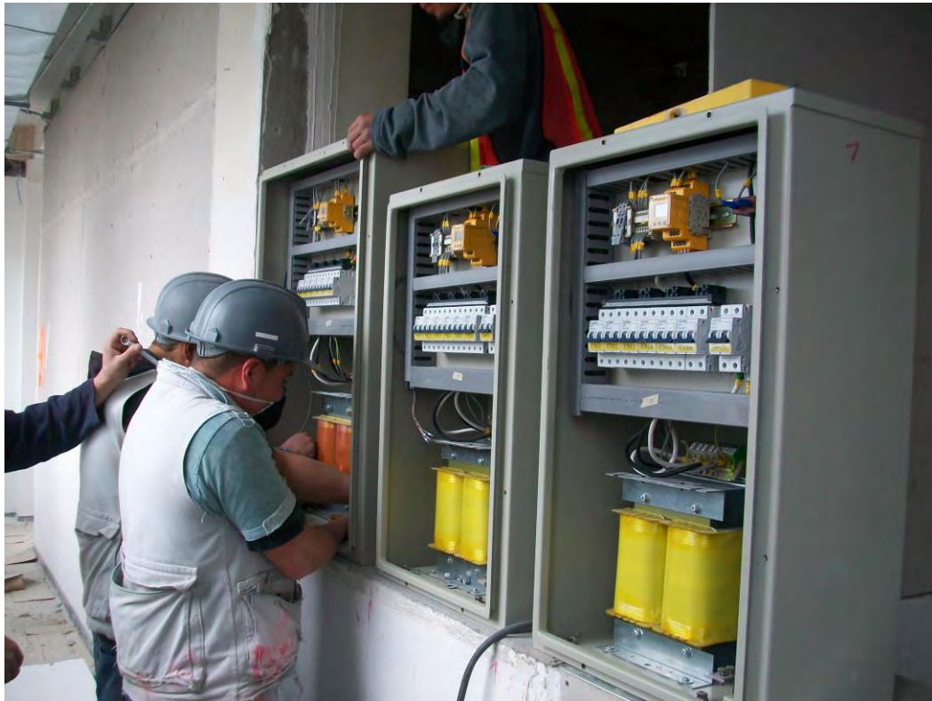
Figura 36. Instalación de tableros de aislamiento.
