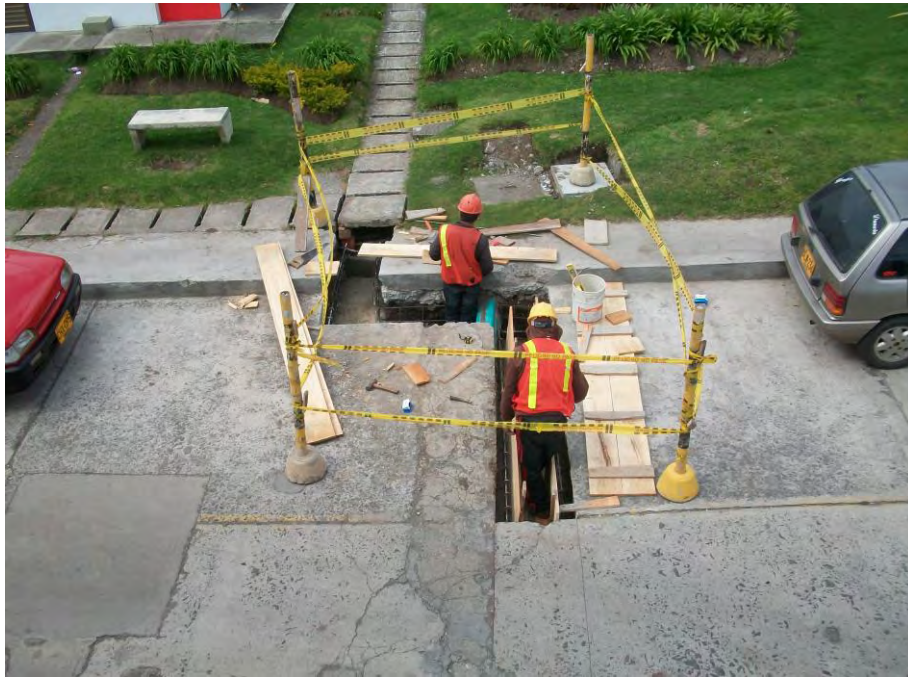
Figura 6. Fase final de cárcamo en concreto reforzado.
