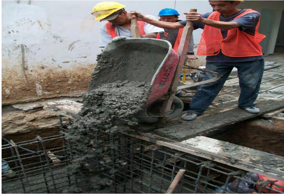
Figura 9. Fundición de foso del ascensor.
