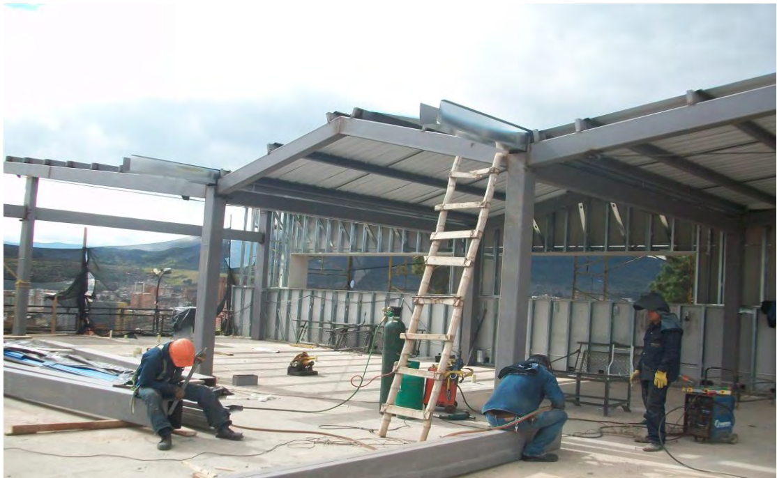
Figura 16. Primer eje de cuatro de ampliación con estructuras metálicas.
