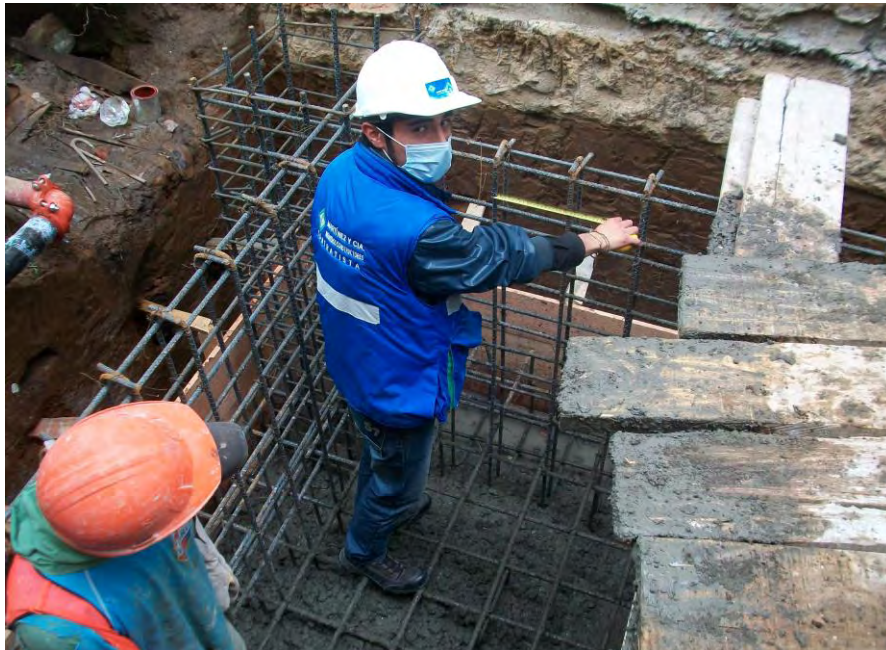
Figura 8. Comprobando la separación entre barras según planos de diseño.
