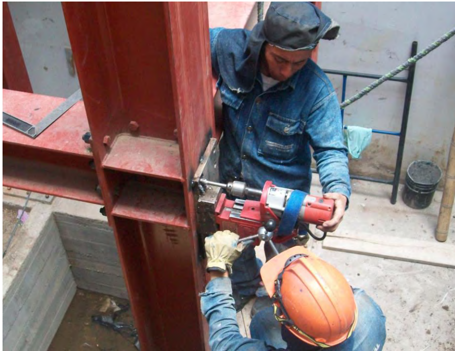
Figura 20. Estructura del ascensor soldada y pernada.
