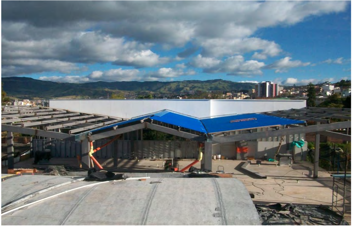
Figura 17. Instalación de teja termoacústica en cubierta de cuatro aguas.
