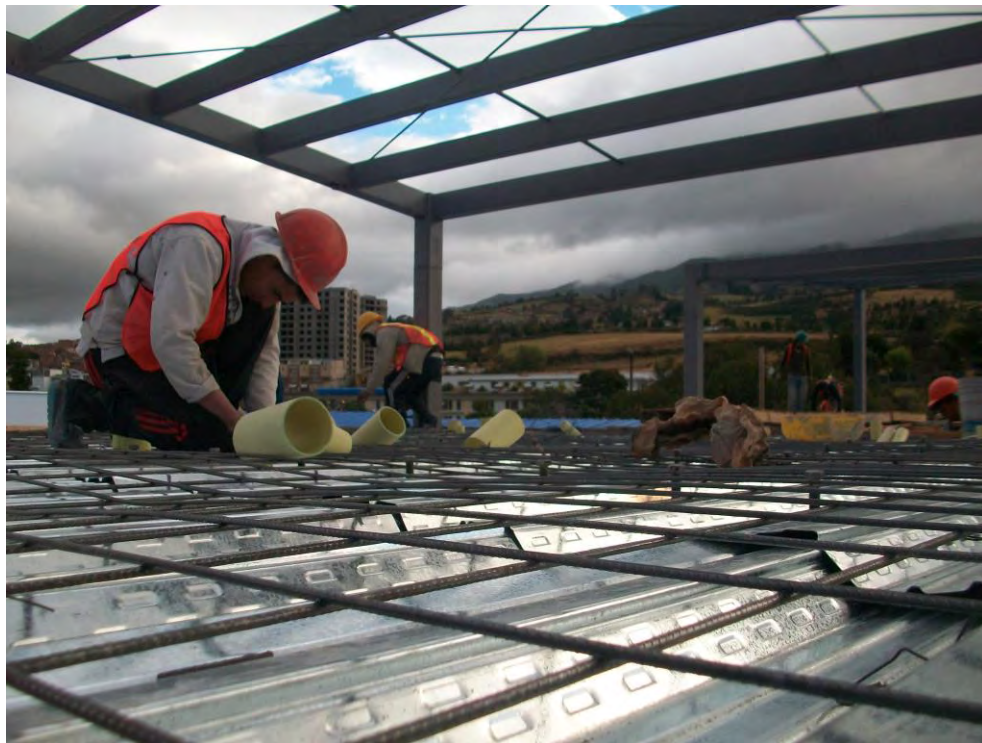
Figura 25. Cuarto de máquina-losa cubiertas- viguetas contorno.
