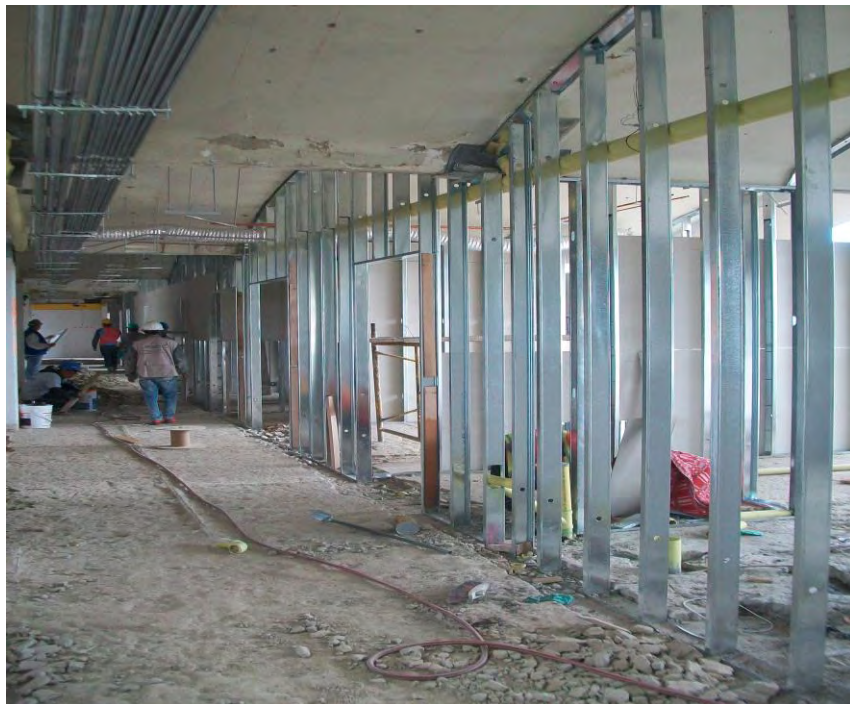
Figura 44. Muros internos de simple estructura ancho 11 cms
