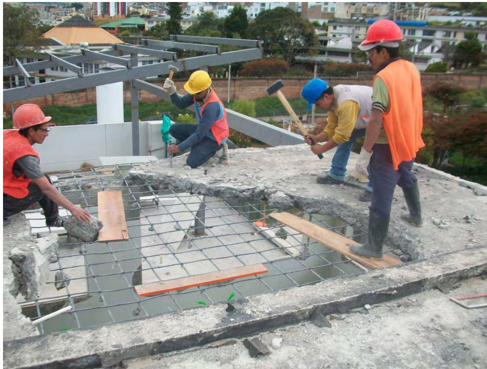
Figura 14. Demolición de losa maciza bidireccional para ampliación
