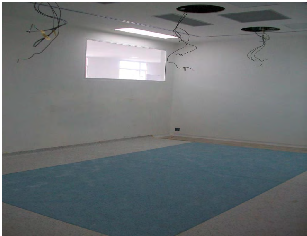
Figura 37. Instalación de piso conductivo en quirófanos.
