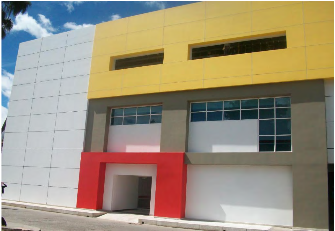
Figura 49. Finalización fachada principal de ampliación
