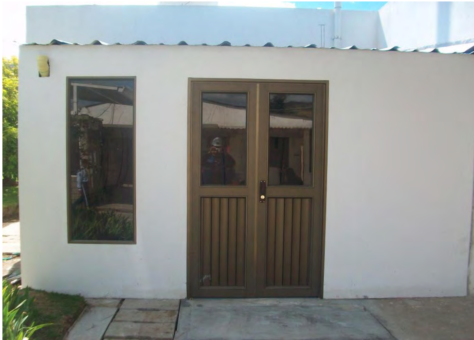
Figura 24. Cuarto de equipos de gases medicinales.
