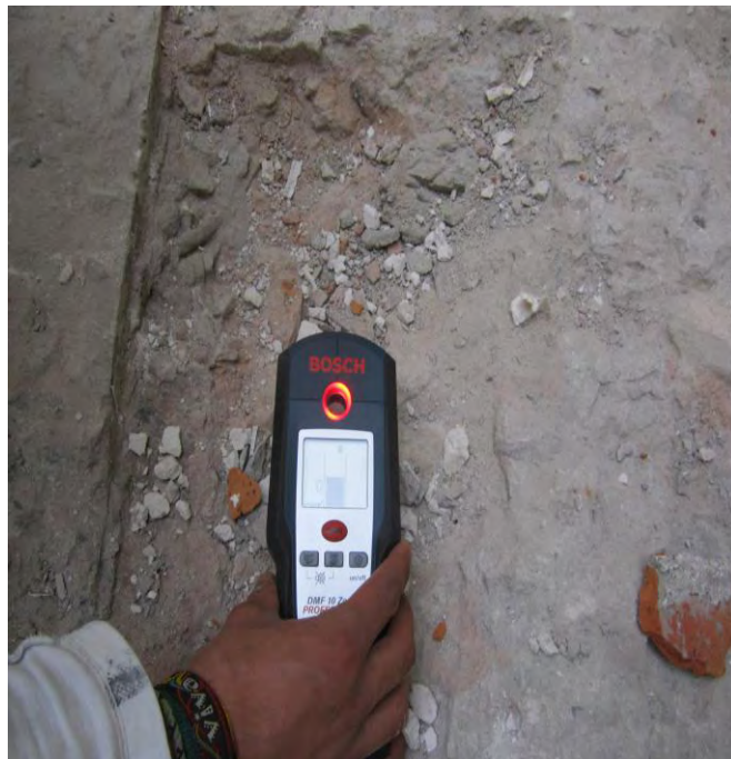
Figura 13. Uso de detector de acero, marca BOSCH (la alerta roja y pito indica que existen barras de acero en el elementos estructurales comprobando correcto recubrimiento y separación entre barras)
