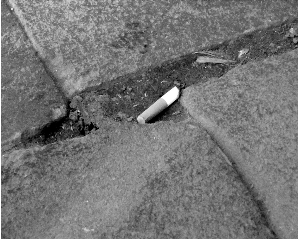
Foto 10: Mario Rodríguez, Grietas . San Juan de Pasto, 2008.
