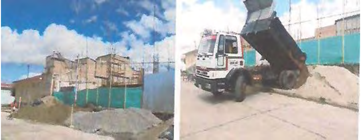
Imagen 1. Acopio de material fino y grueso
