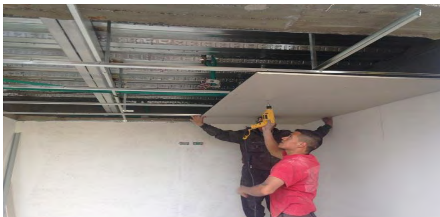
Imagen 20. Cielo raso en panel yeso
