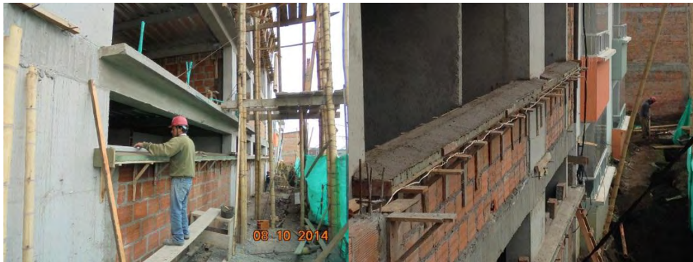
Imagen 16. Alfajías de concreto a la vista
