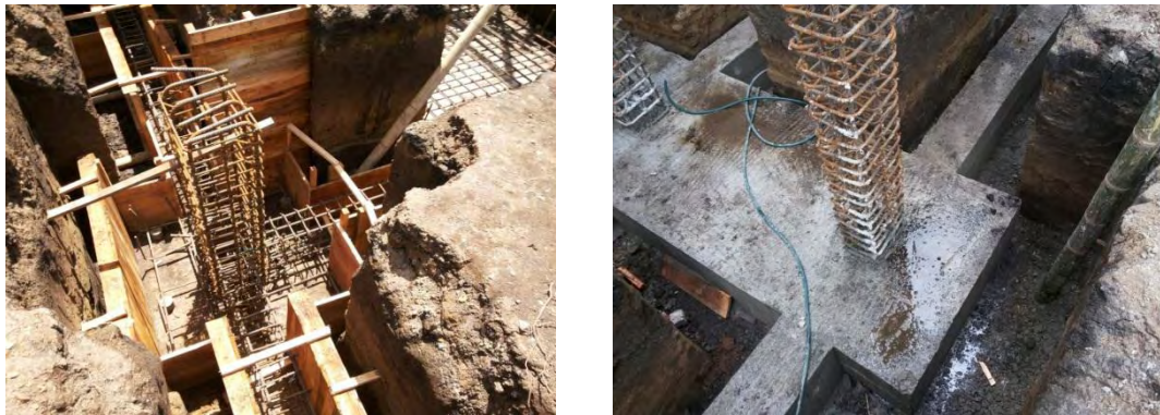
Imagen 3. Vigas, columnas de arranque
