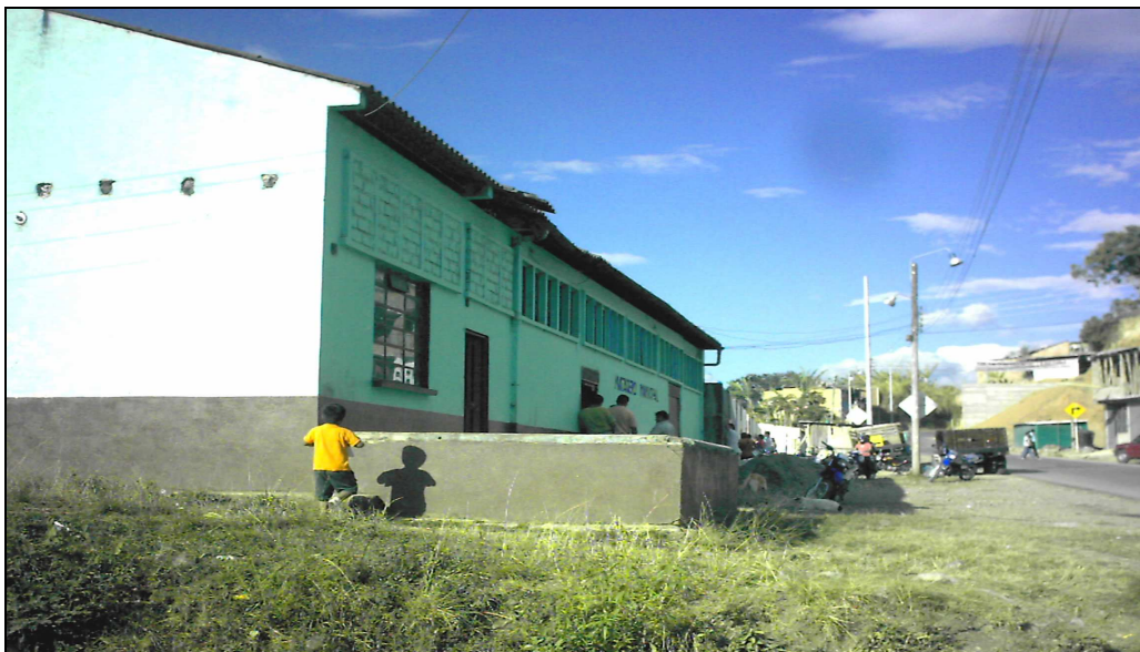
Figura 4. Matadero Municipal, dentro del perímetro urbano
