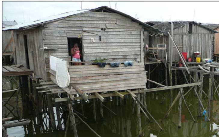
Figura 5. Vivienda de tipo palafítica, zona de bajamar
