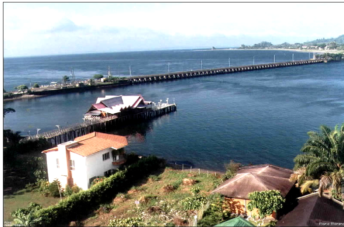
Figura 4. Parte de la panorámica del municipio de Tumaco
