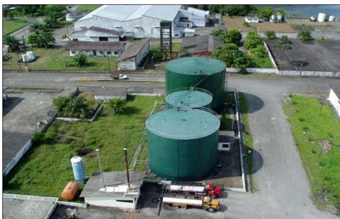
Figura 15. Panorámica del Puerto Marítimo de Tumaco
