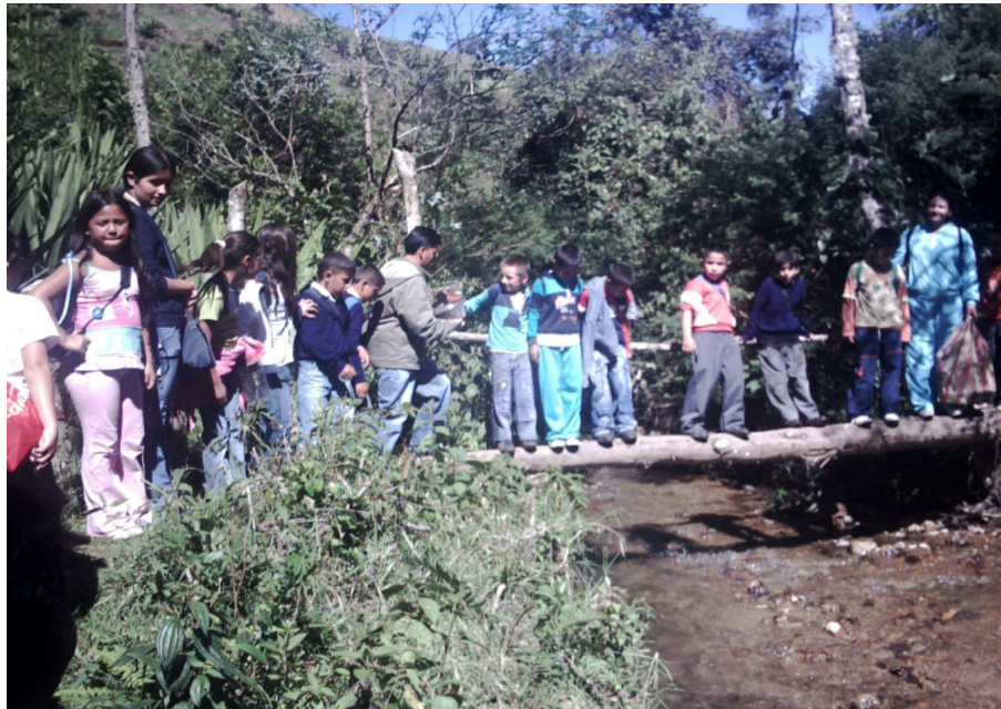
Figura 28. El puente está quebrado...
