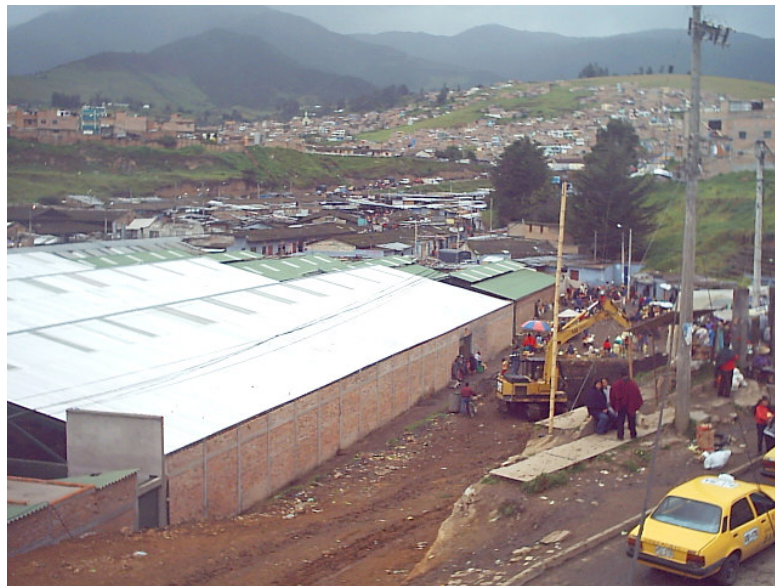
Foto No. 5. Retiro de Escombros
