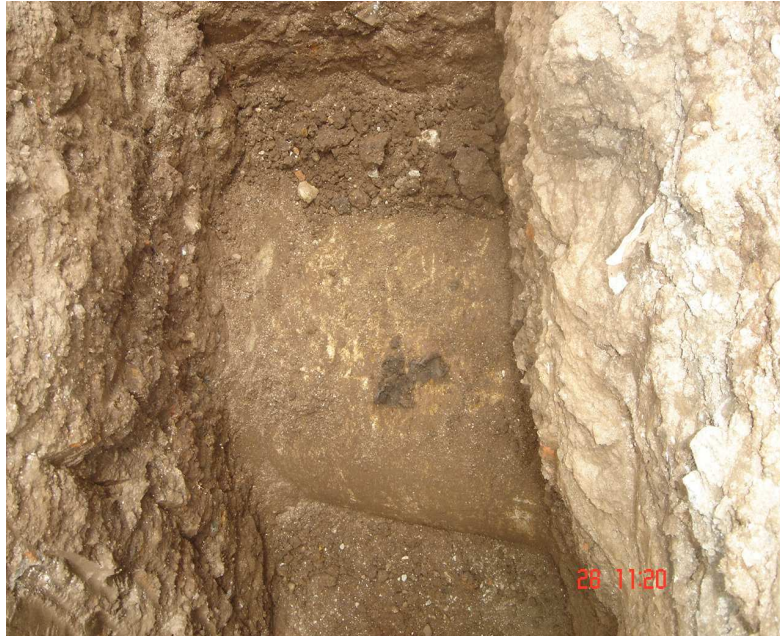
Foto No. 32 Tubería encontrada de 24"
