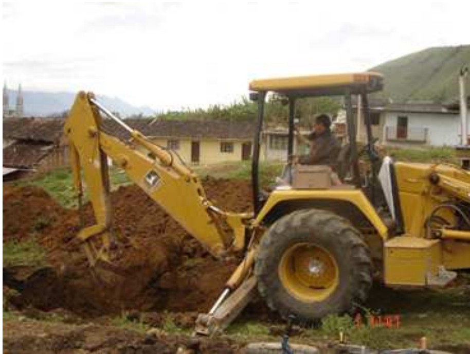
Foto No. 13 Excavación a máquina
