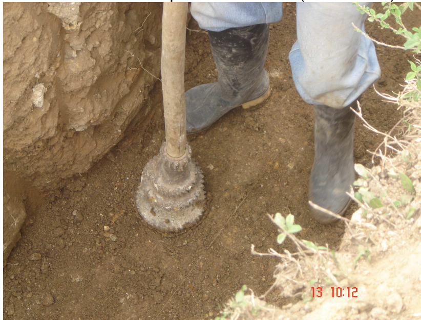
Foto No. 22 Apisonamiento manual
