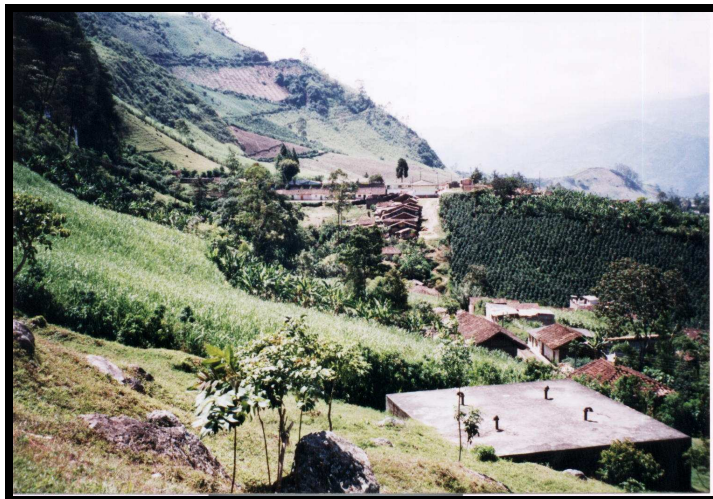
Foto No 10. Tanques de almacenamiento
