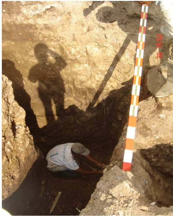
Foto No. 42 Alineación de la tubería
