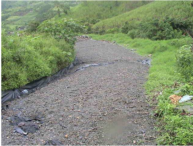
Foto No. 53 Impermeabilización del suelo
