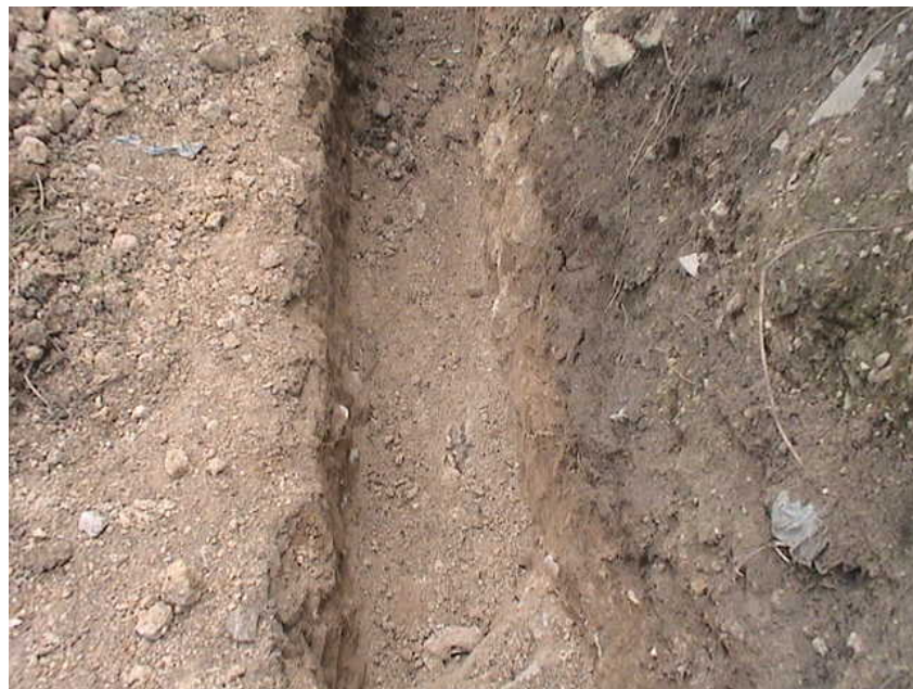
Foto No. 28 Relleno compactado
