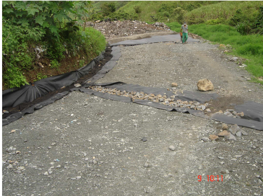
Foto No. 54 Adecuación terminada
