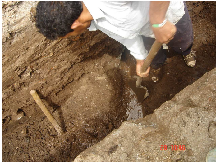
Foto No. 35 Excavación a mano
