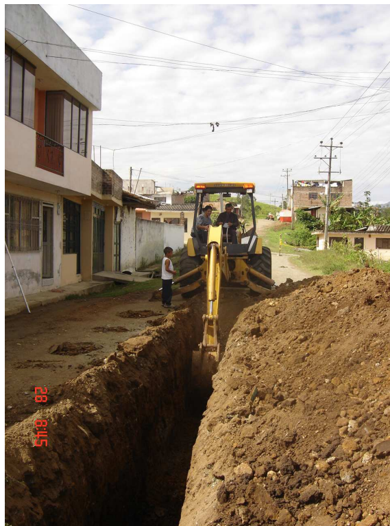
Foto No. 31 Excavación a maquina
