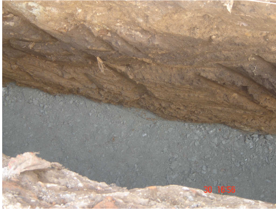
Foto No. 41 Nivelación y Encamado
