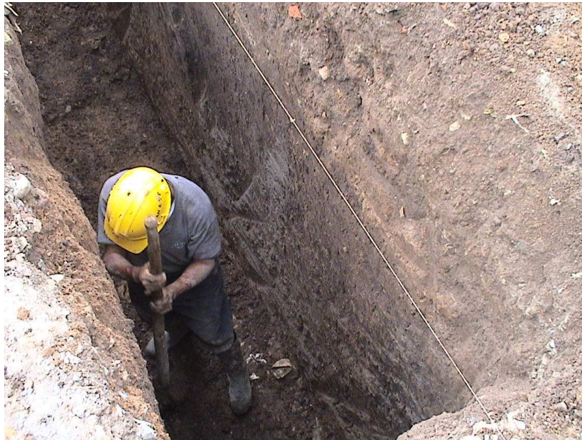
Foto No. 29 Excavación para canalización definitiva
