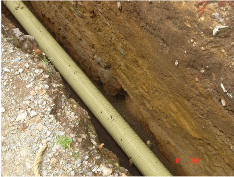
Foto No. 21 Instalación de tubería 8”
