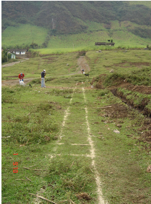
Foto No. 25 Trazado eje de tubería acueducto
