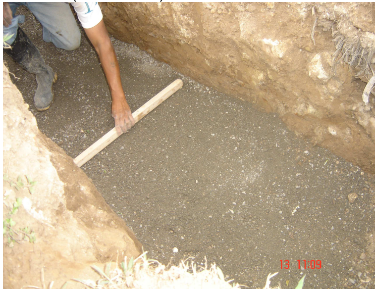
Foto No. 19 Nivelación del terreno
