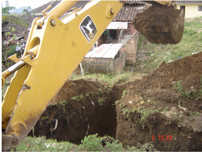
Foto No. 26 Excavación a máquina para acueducto
