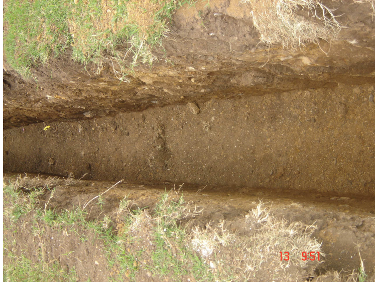
Foto No. 39 Nivelación de pisos
