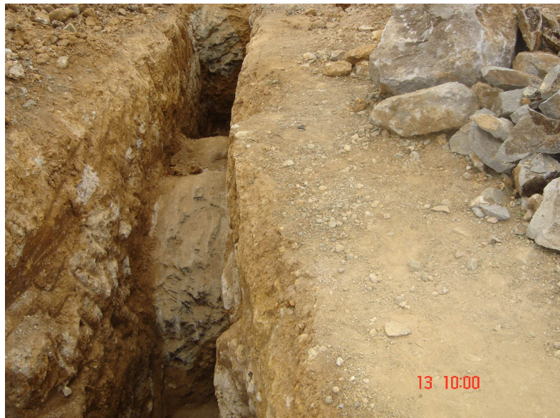
Foto No. 15 Cordón de roca
