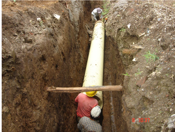
Foto No. 43 Tubería instalada de 20”
