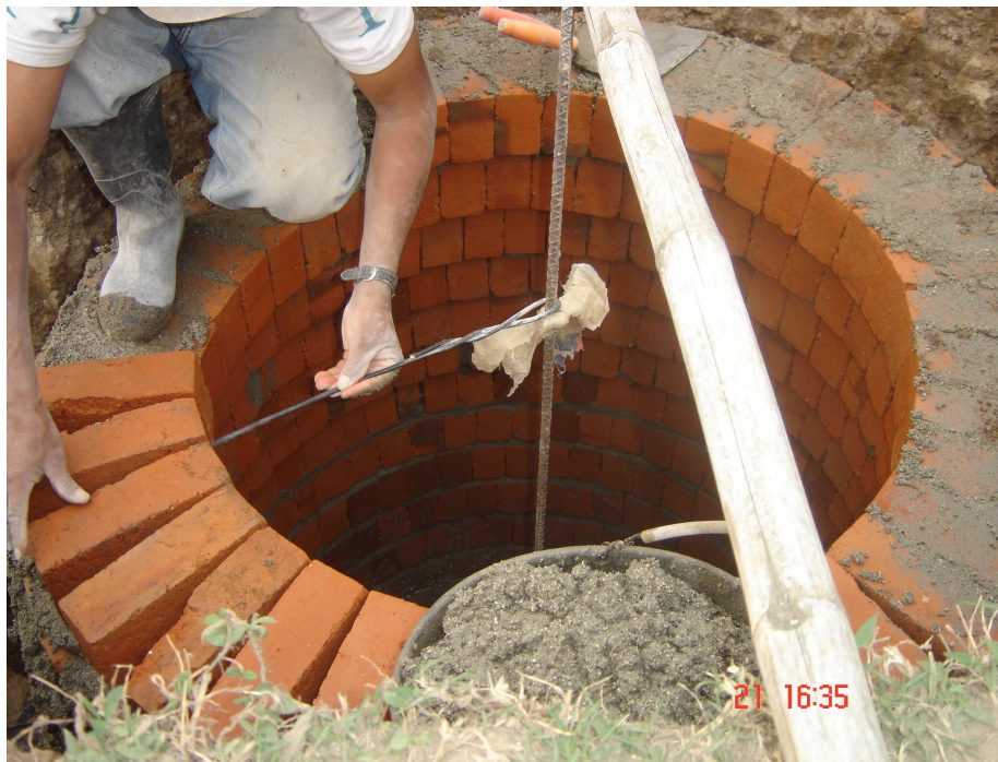
Foto No. 24 Cámaras de inspección
