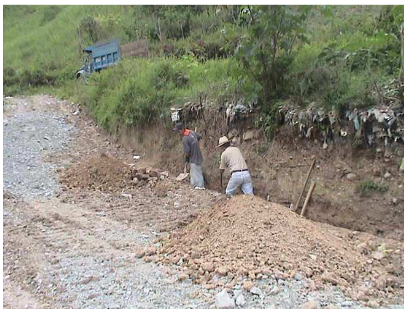
Foto No. 50 Excavación para filtros
