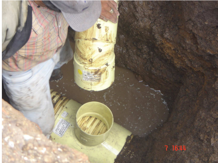
Foto No. 46 Acometidas domiciliarias
