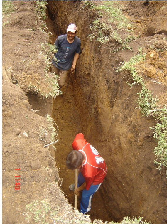
Foto No. 14 Excavación a mano
