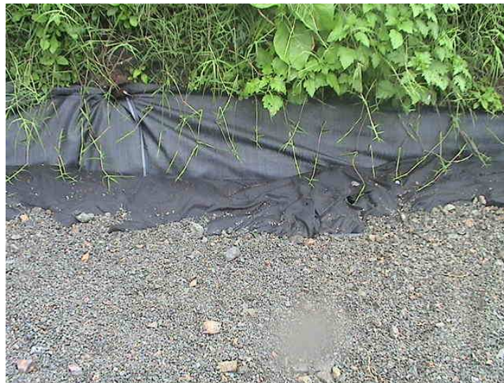
Foto No. 51 Construcción de filtros
