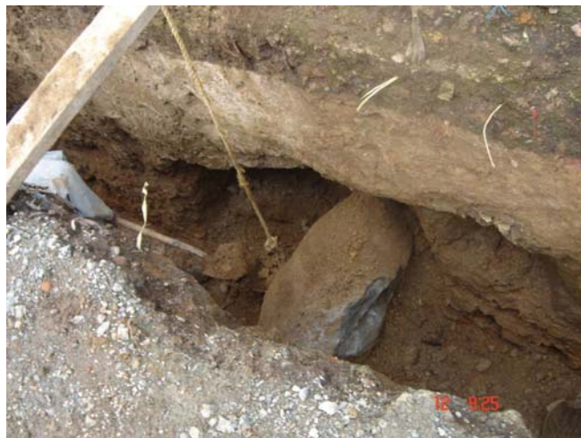
Figura 14. Excavación en roca
