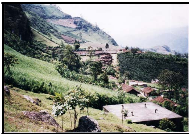
Figura 11. Tanques de almacenamiento
