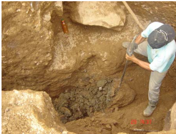
Figura 13. Excavación en conglomerado
