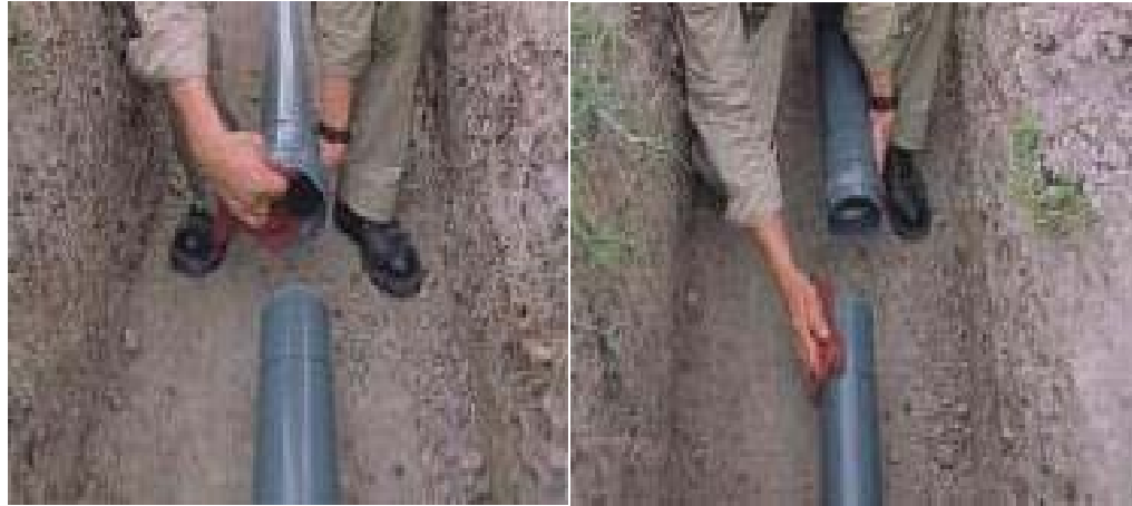
Figura 16. Preparación de la tubería
