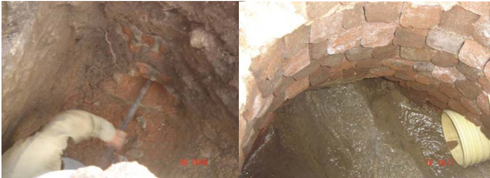
Figura 57. Conexión a cámara existente
