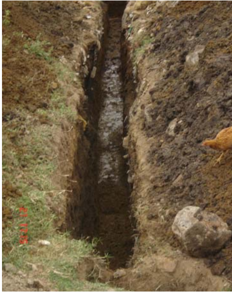
Figura 12. Excavación material común
