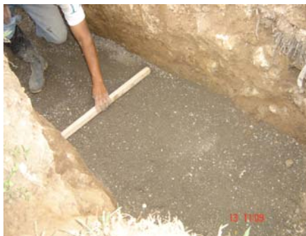
Figura 46. Nivelación del terreno
