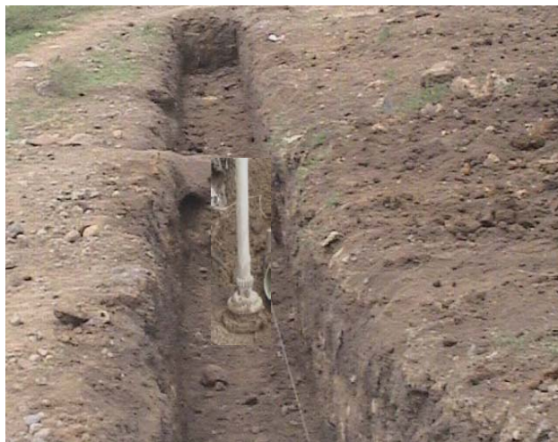
Figura 33. Relleno y compactación
