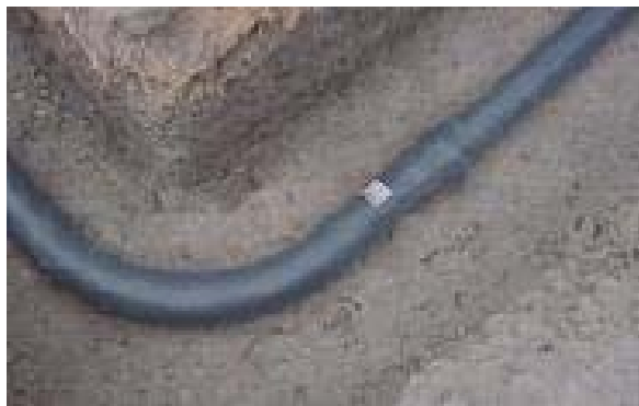
Figura 24. Instalación de codos
