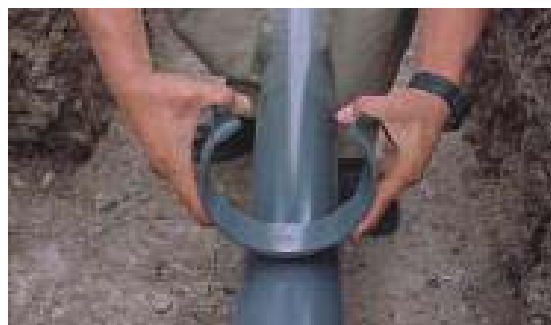
Figura 25. Instalación del collar
