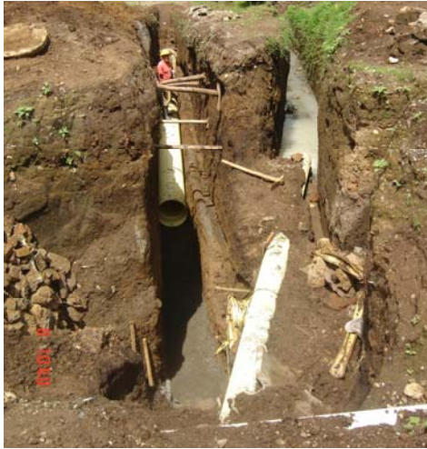
Figura 56. Instalación de tubería
