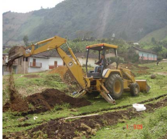
Figura 37. Excavación a máquina
