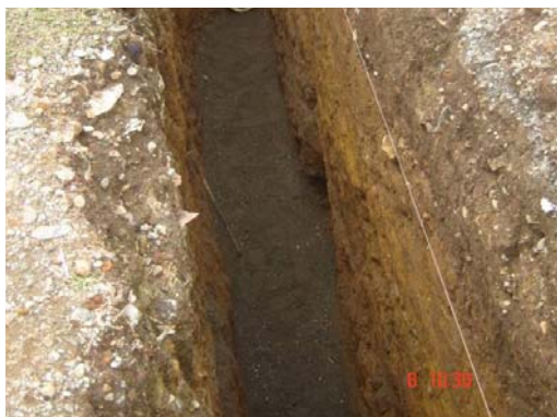
Figura 55. Adecuación de piso
