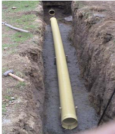
Figura 48. Instalación de tubería
