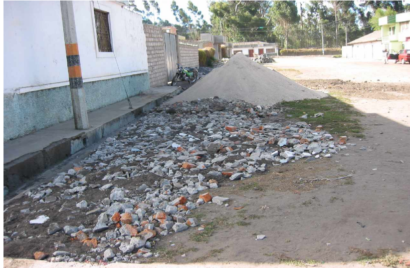
Figura 35 Inadecuada disposición de escombros
