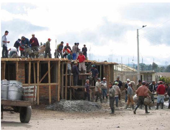
Figura 10. Construcción vivienda – minga comunitaria
