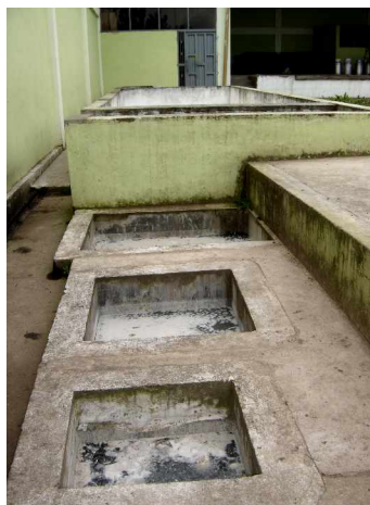
Figura 22. Planta de tratamiento residuos líquidos – Industria Lechera
