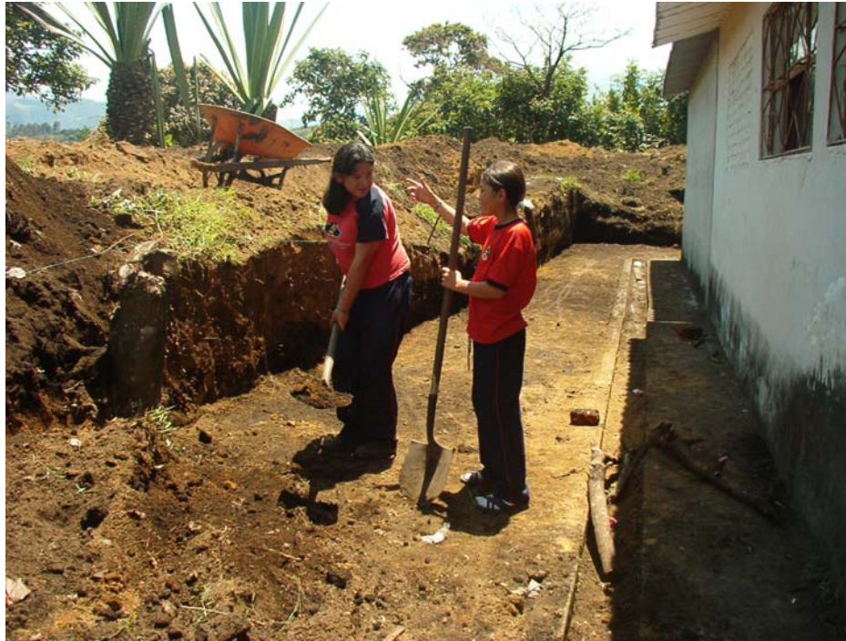
Adecuación de parcela sede La Caldera
