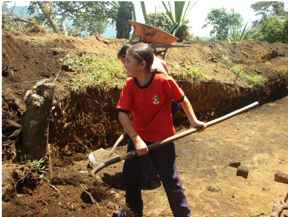
Adecuación de parcela sede La Caldera
