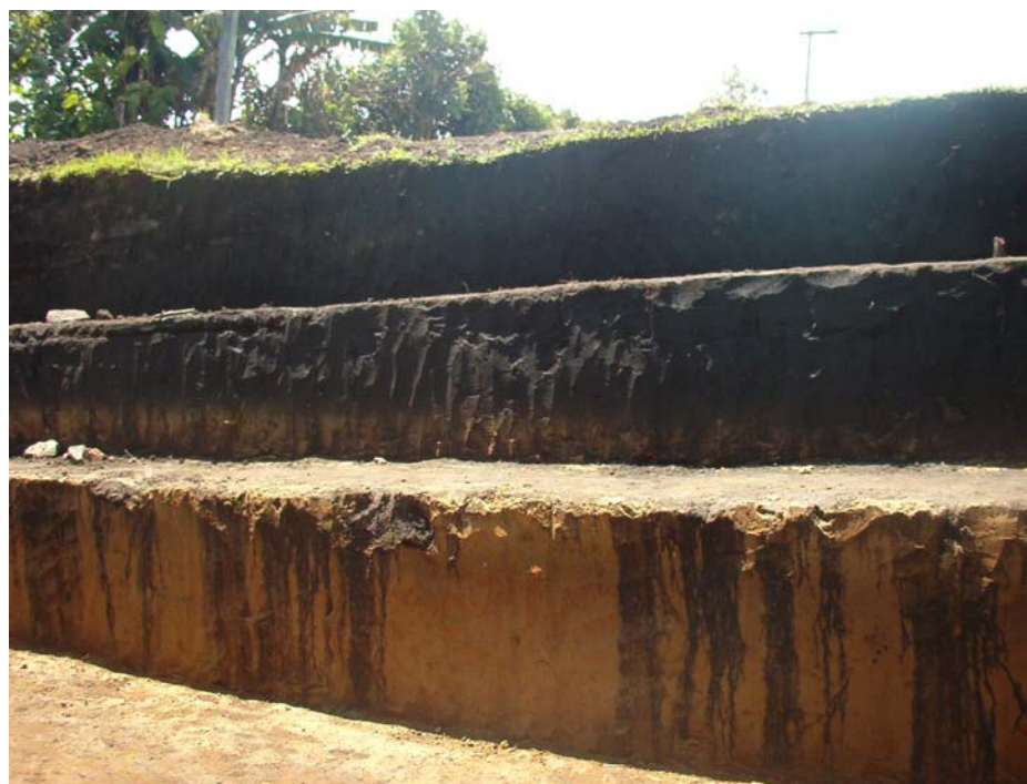
Adecuación zona verde – sede La Caldera
