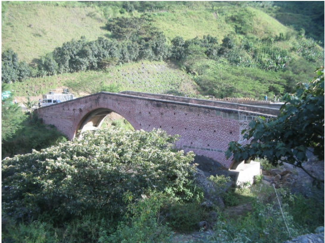
Figura 20. Puente sobre el río Juanambú.
