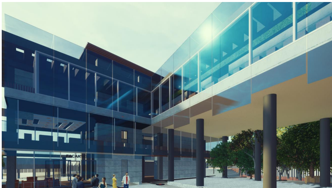
Figura 77. Vista desde patio fachada costado norte Fuente: Elaboración propia
