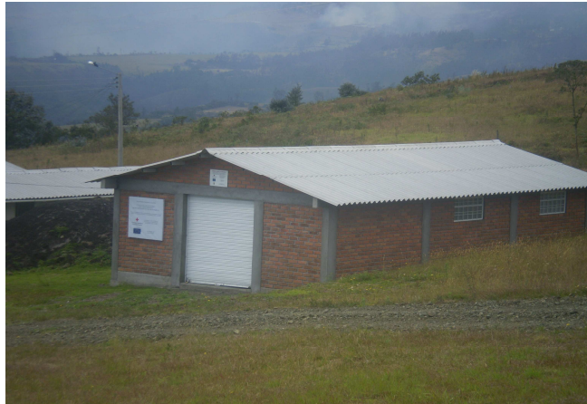
Foto 21. Bodega Albergue La Lomita
