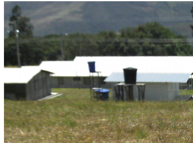
Foto 28. Tanques de abastecimiento de agua potable
