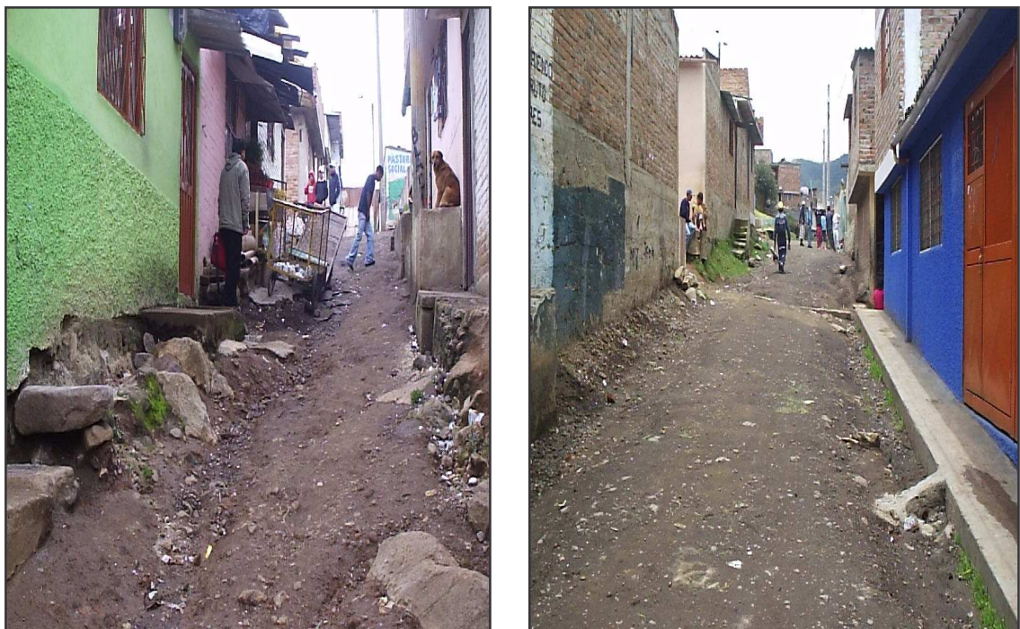
Figura 8. Fachadas de las viviendas y vías de acceso.
