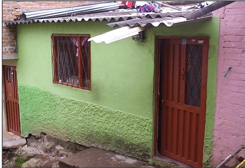
Figura 37. Fachada de la vivienda 2.
