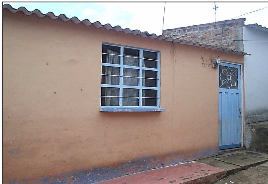
Figura 36. Fachada de la vivienda 1.
