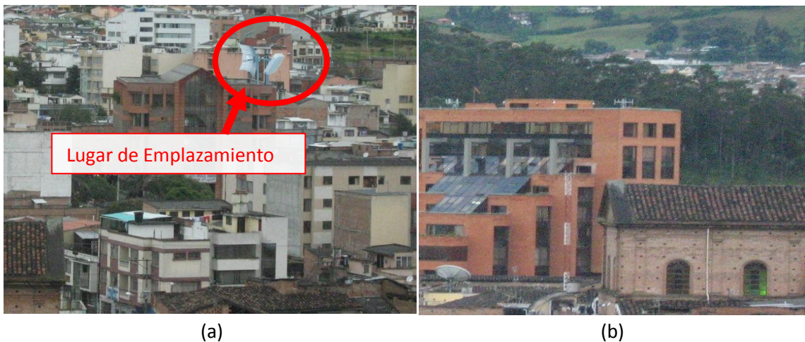
Figura 6.10. Levantamiento de sitio Centro Comercial Bomboná. (a) Lugar seleccionado para emplazamiento de equipos. (b) Verificación de línea de vista con Edificio Cámara de Comercio.
