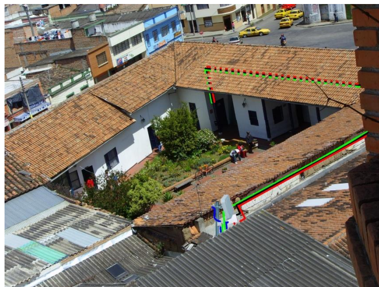
Figura 6.11 Levantamiento de sitio Casa de Justicia. Lugar de Emplazamiento del equipo de radio y recorrido del cableado. Foto tomada desde terraza Centro Comercial Bomboná.
